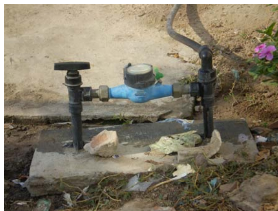
Foto 11.4 – Kit cavalete com hidrômetro (Padrão CAGECE/SISAR), a ser aproveitado
