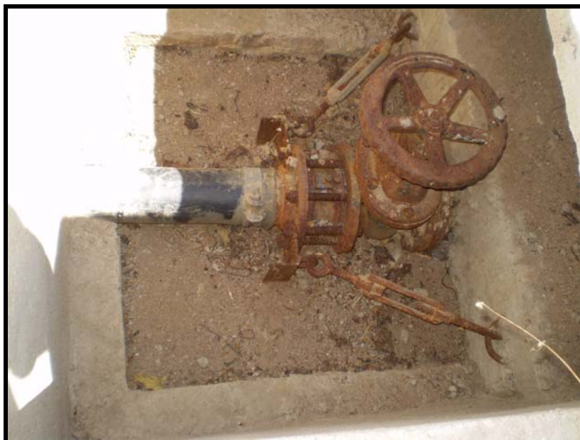
Foto 10.2 – Transição de PEAD para PVC
