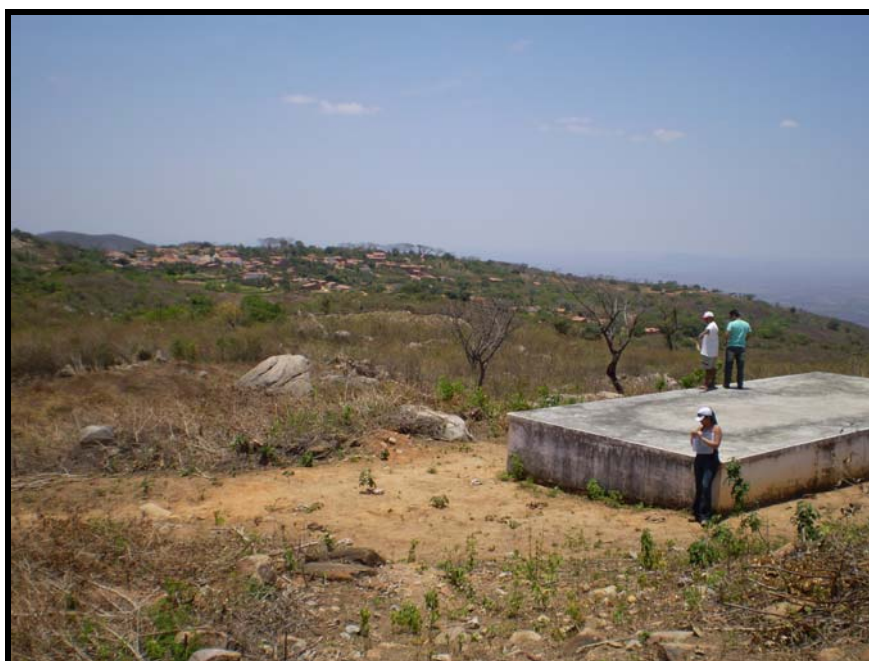
Foto 10.6 – Reservatório Semi-Enterrado
