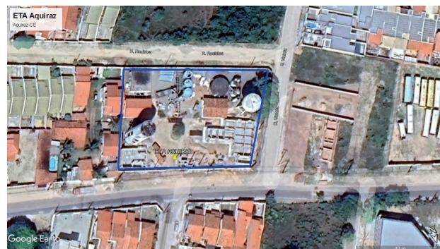
Fig. 1 - Imagem aérea da ETA Aquiraz. 1
