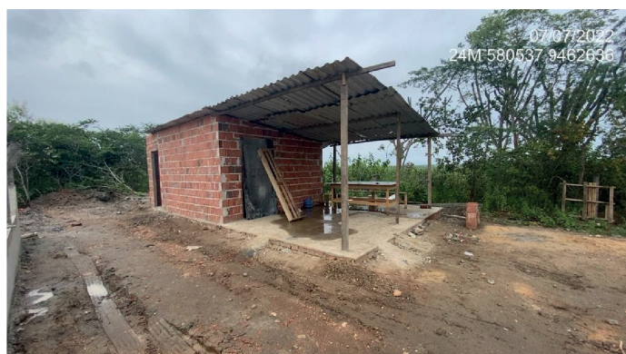
Fig. 3- Projeto piloto na comunidade de Capim Grosso no município de Russas-Ceará. 3
