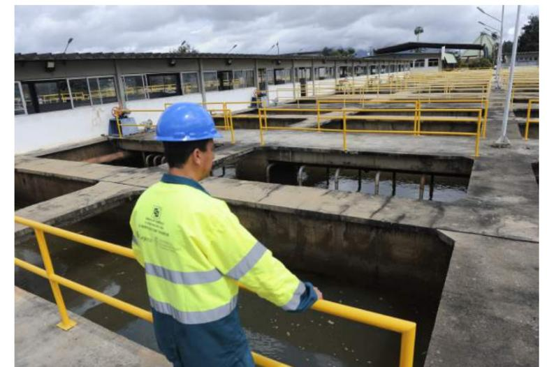
A ETA Gavião, principal estação de tratamento de água da Cagece, possui capacidade de tratamento equivalente a 10,0 m<sup>3</sup>/s. No processo produtivo, a água bruta passa pelas etapas de floculação, decantação, filtração, cloração, fluoretação e correção de pH. Em cada uma dessas etapas, são realizadas análises laboratoriais para avaliar a eficiência do processo e verificar o atendimento aos requisitos da legislação
