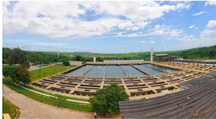
A ETA Jaburu localiza-se no município de Tianguá e tem capacidade de tratamento equivalente a 0,4 m<sup>3</sup>/s. O tratamento da água consiste em pré-cloração, coagulação, decantação, filtração, desinfecção e fluoretação. A reservação na ETA é composta por dois Reservatórios Apoiados (RAPs) de 2.500 m<sup>3</sup> e um Reservatório Elevado (REL) de 1.500 m<sup>3</sup>, com uma infraestrutura de abastecimento que se estende para diversas localidades e municípios da Serra da Ibiapaba.
