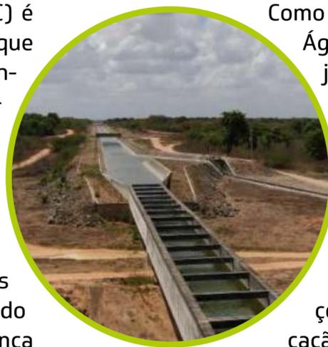
Como parte integrante do CAC, o Eixão das Águas é caracterizado por ser um conjunto de obras hídricas que realizam a transposição das águas do Açude Castanhão para a RMF, reforçando o abastecimento, em uma extensão de 255 km, incluindo o Complexo Industrial e Portuário do Pecém. No ano de 2024 foi assinada a ordem de serviço para o início das obras para a duplicação dos lotes 1 e 2 do Eixão das Águas, com previsão de conclusão em dois anos.
