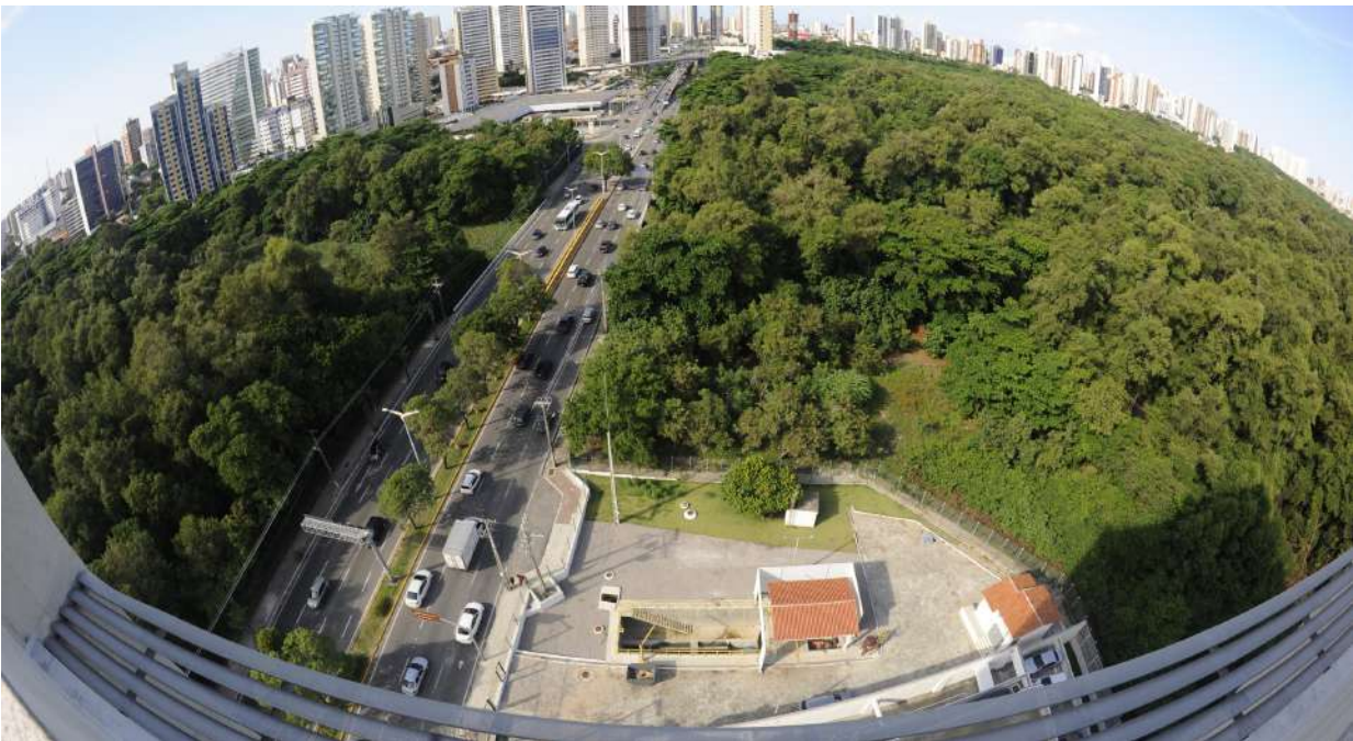
Estação Elevatória de esgoto Parque do Cocó
