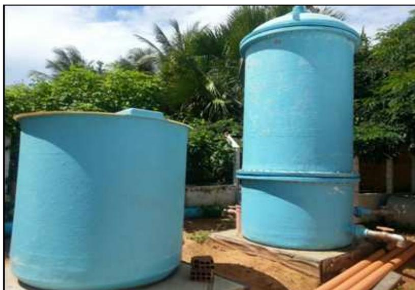
Figura 13 - Unidade de Filtração de Troca Iônica existente
