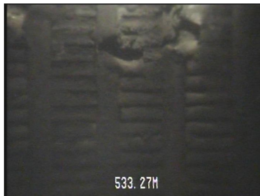
FOTOGRAMA 09 - Visada lateral de filtro colmatado e com rompimento aos 533,27 metros.
