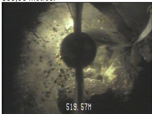
FOTOGRAMA 06 - Visada de fundo aos 519,57 metros, que mostra a redução de 10" para 6" com entulhamentos aos 520,00 metros.
