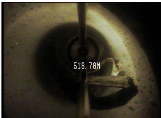
FOTOGRAMA 14 - Visada de fundo aos 518,78 m* mostrando cinta e segmento de madeira (?).
