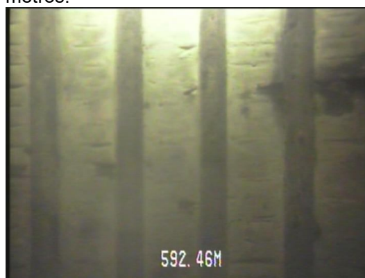
FOTOGRAMA 11 - Visada lateral de filtro colmatado aos 592,46 metros
