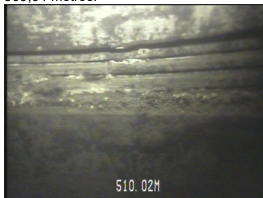
FOTOGRAMA 05 - Visada lateral da emenda do revestimento aos 510,02 metros.
