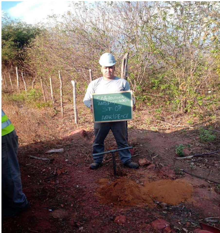
Instalação do furo ST-07
