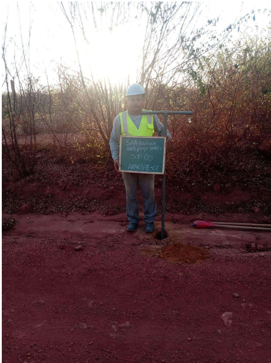
Instalação do furo ST-05
