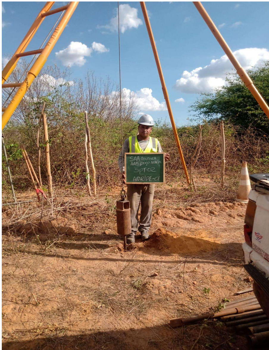
Instalação do furo SP-02
