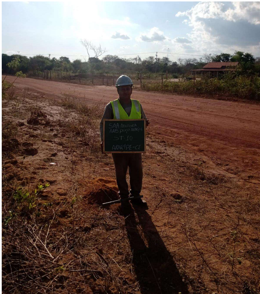
Instalação do furo ST-10
