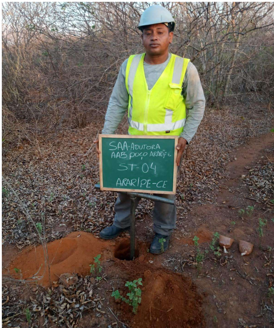
Instalação do furo ST-04
