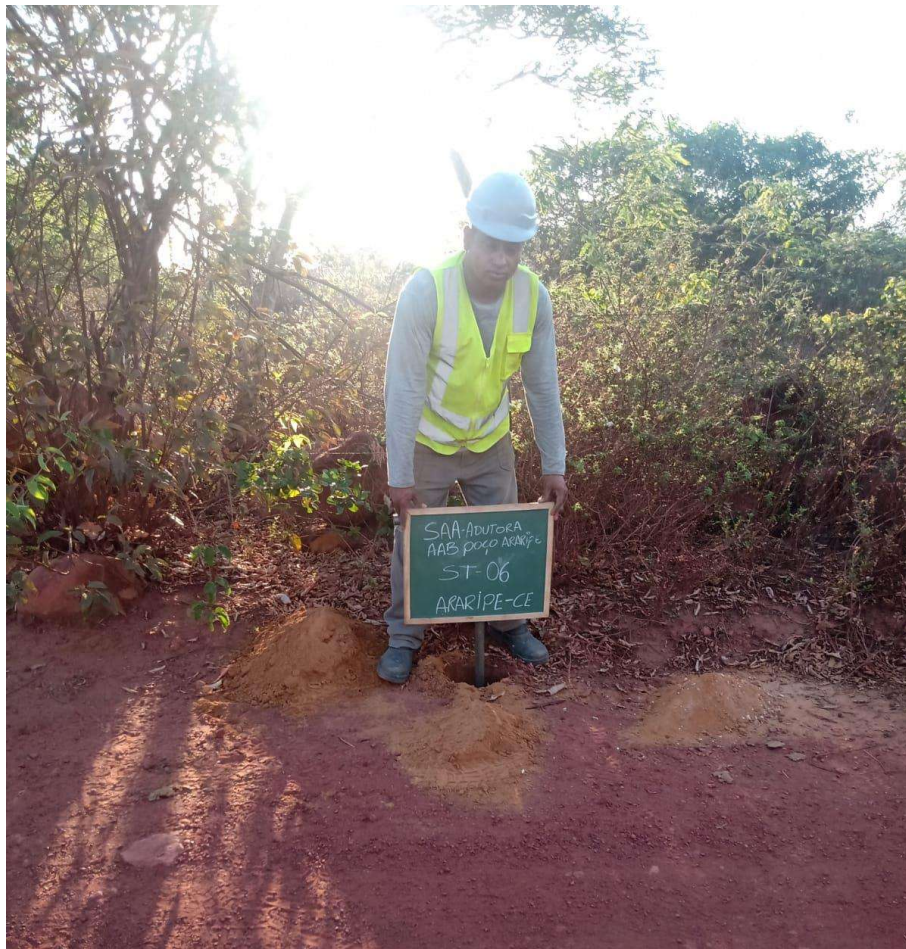
Instalação do furo ST-06
