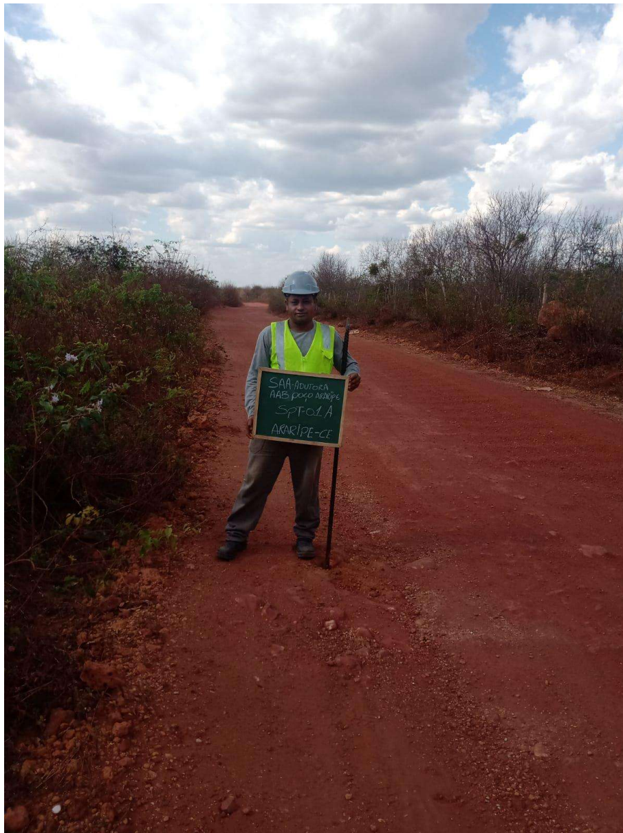
Instalação do furo SP-01 A
