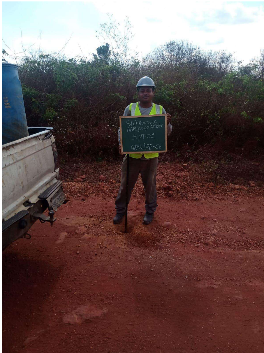
Instalação do furo SP-01
