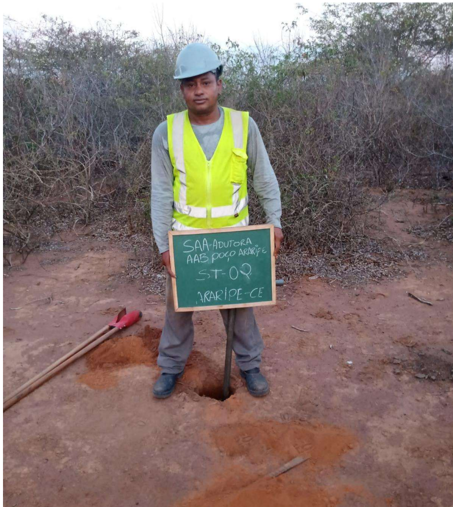
Instalação do furo ST-02
