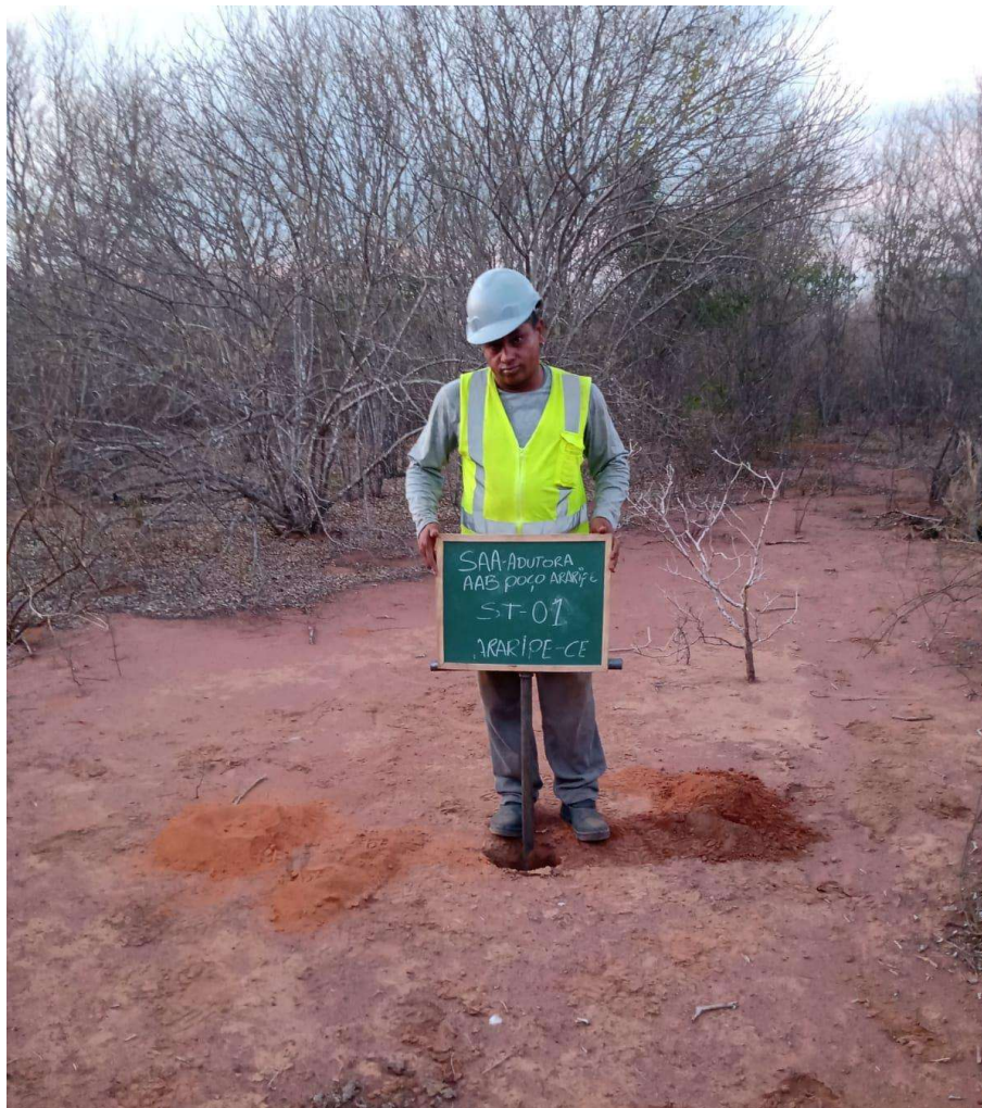
Instalação do furo ST-01
