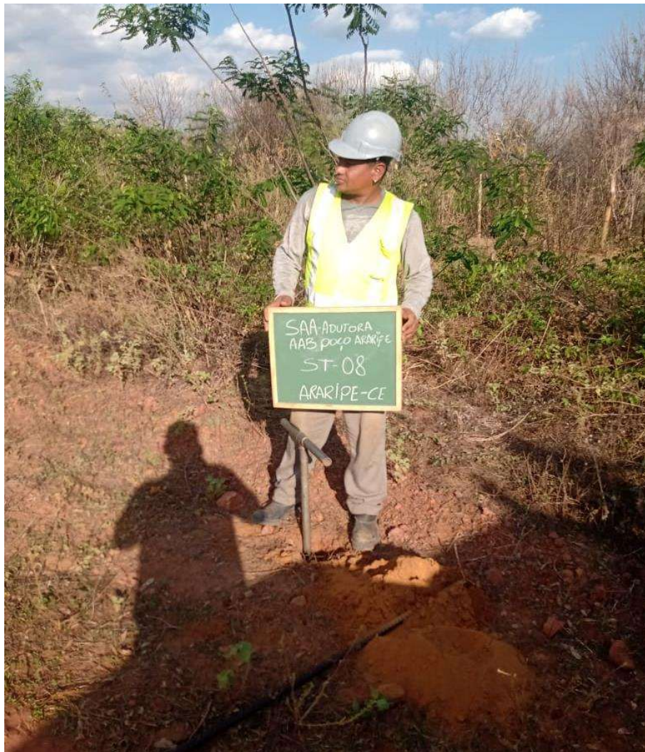
Instalação do furo ST-08
