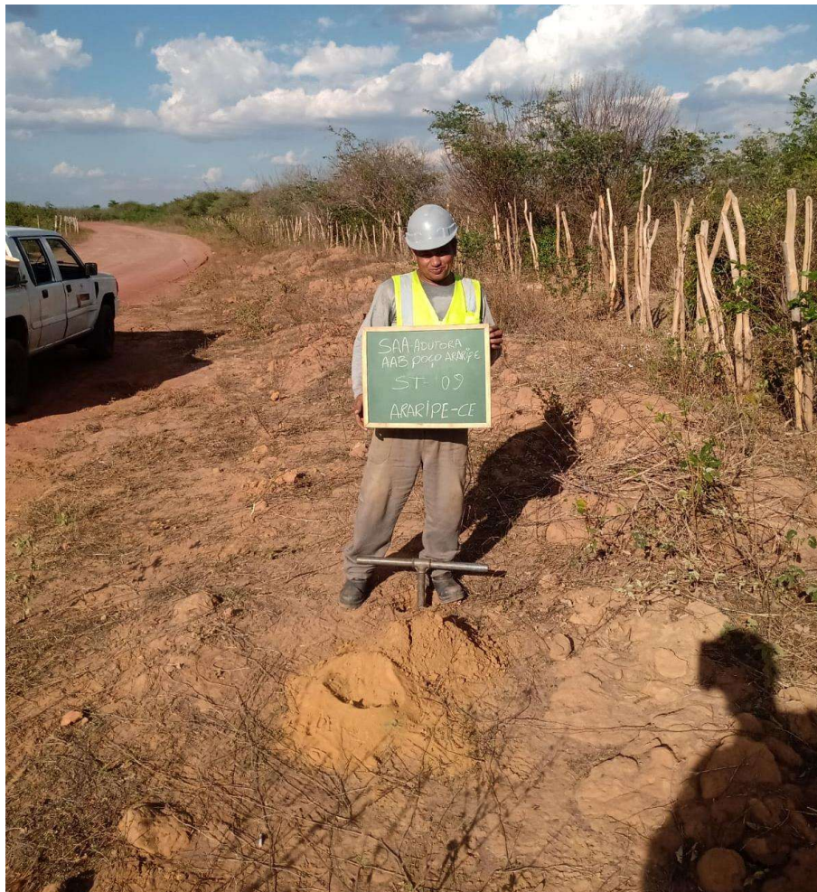
Instalação do furo ST-09
