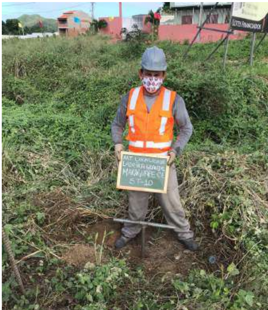
Instalação do furo ST-10
