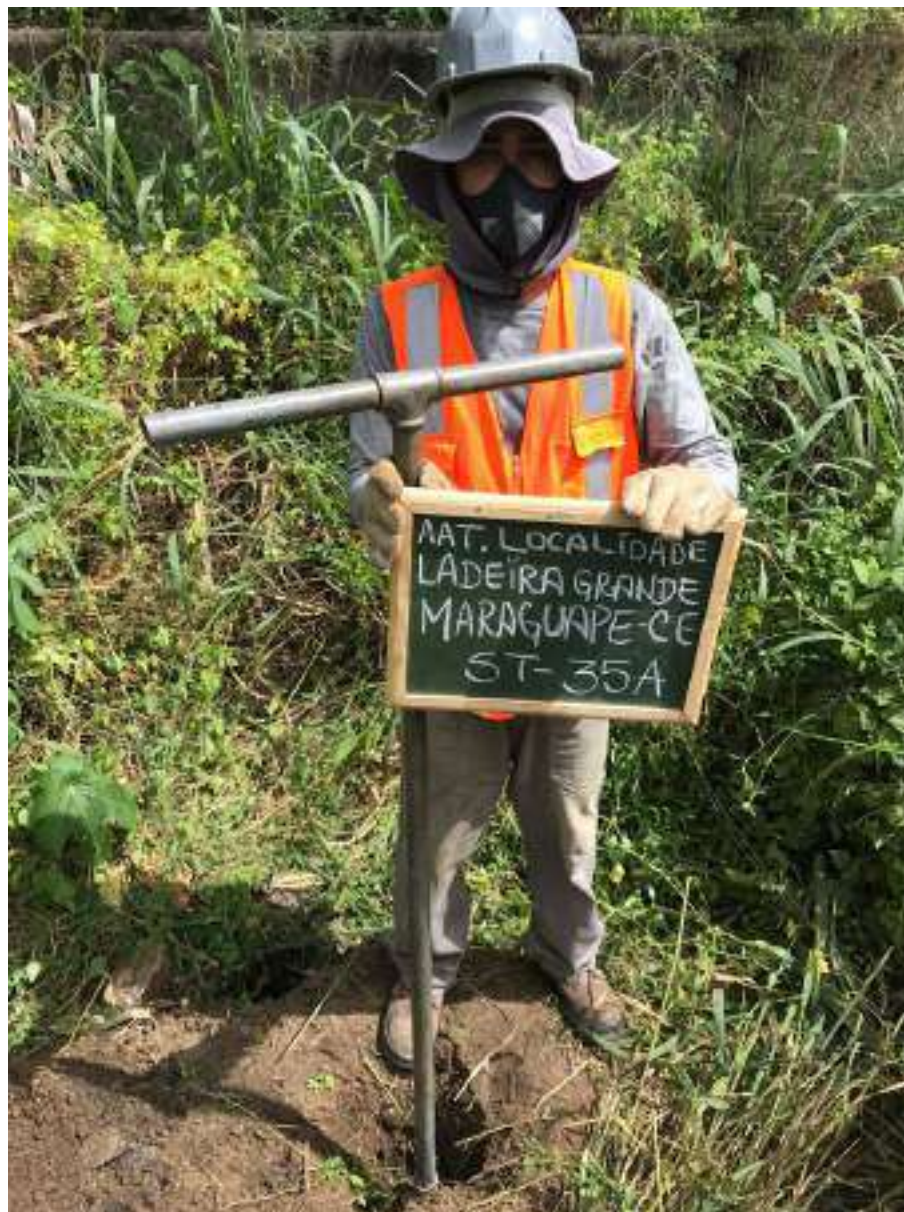
Instalação do furo ST-35 A
