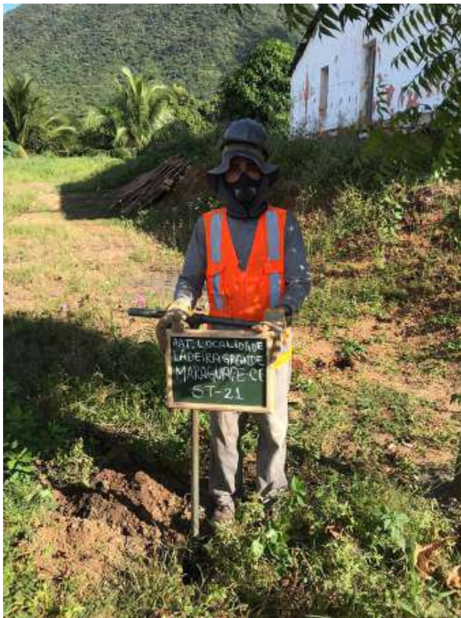
Instalação do furo ST-21
