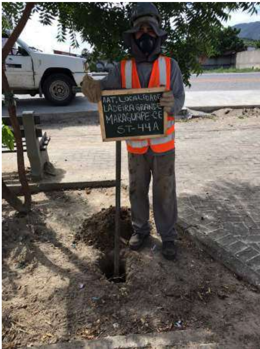
Instalação do furo ST-44 A
