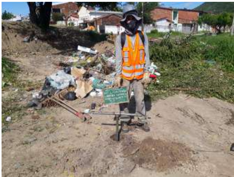
Instalação do furo ST-09
