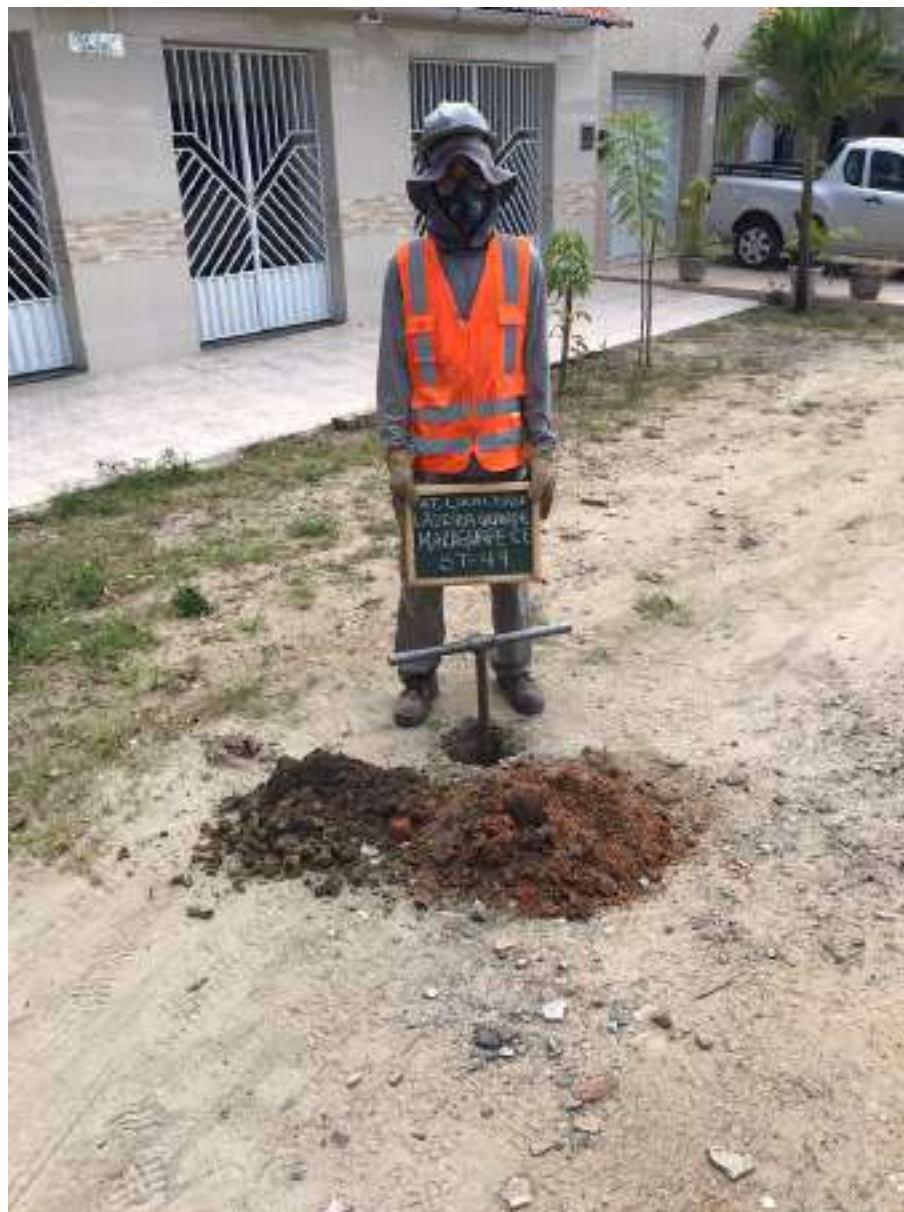
Instalação do furo ST-49
