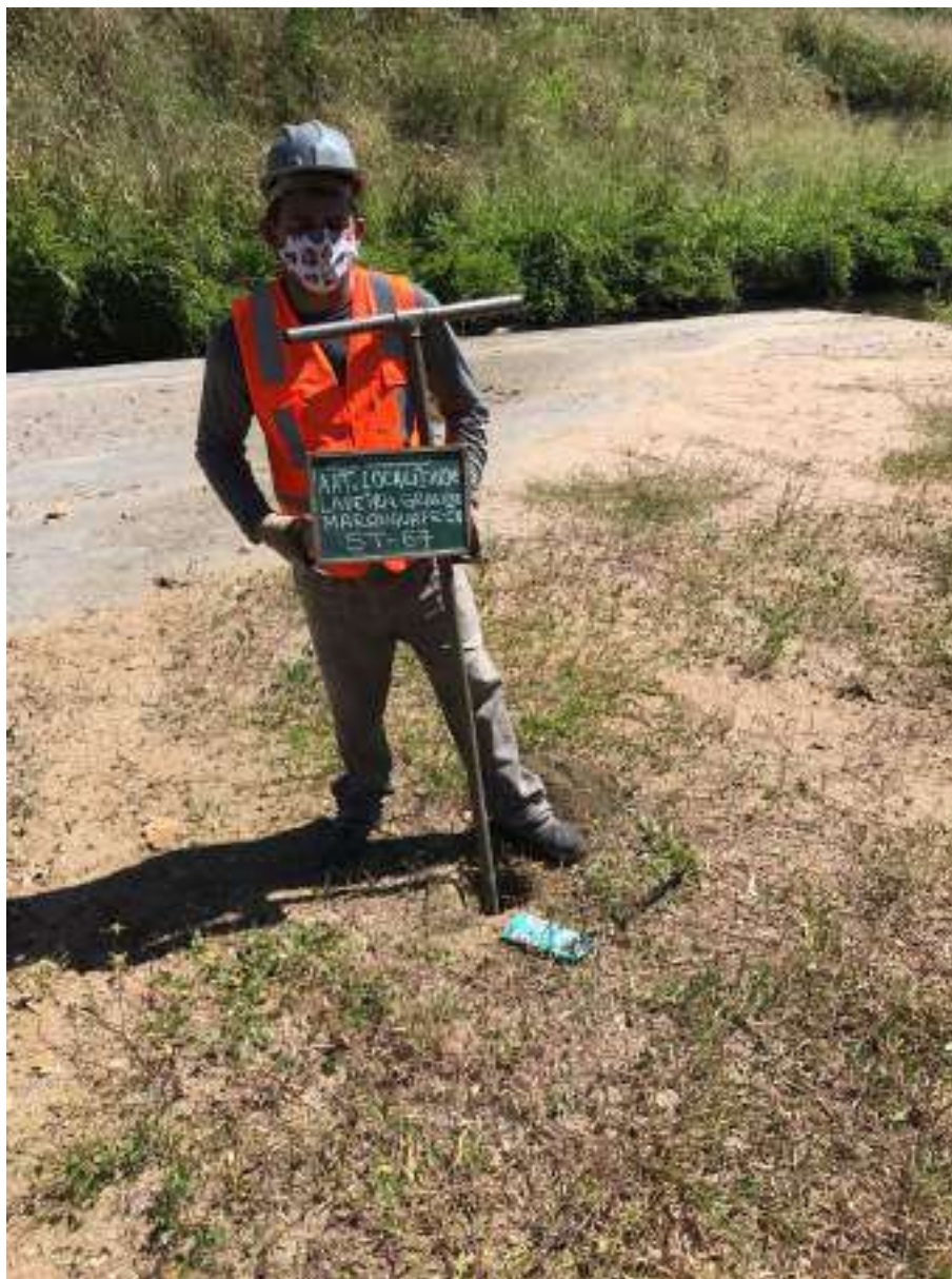
Instalação do furo ST-67
