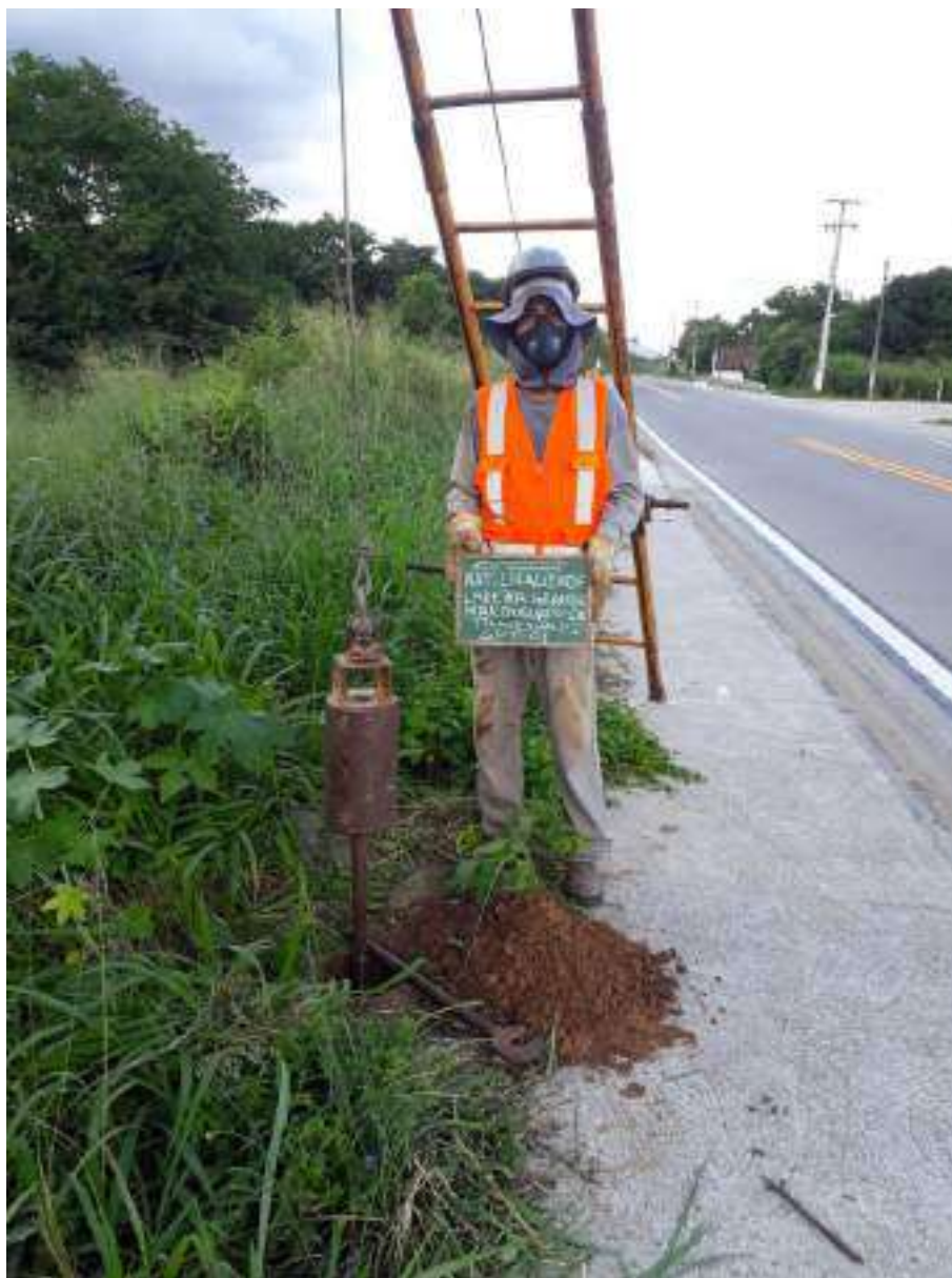
Instalação do furo SP-01
