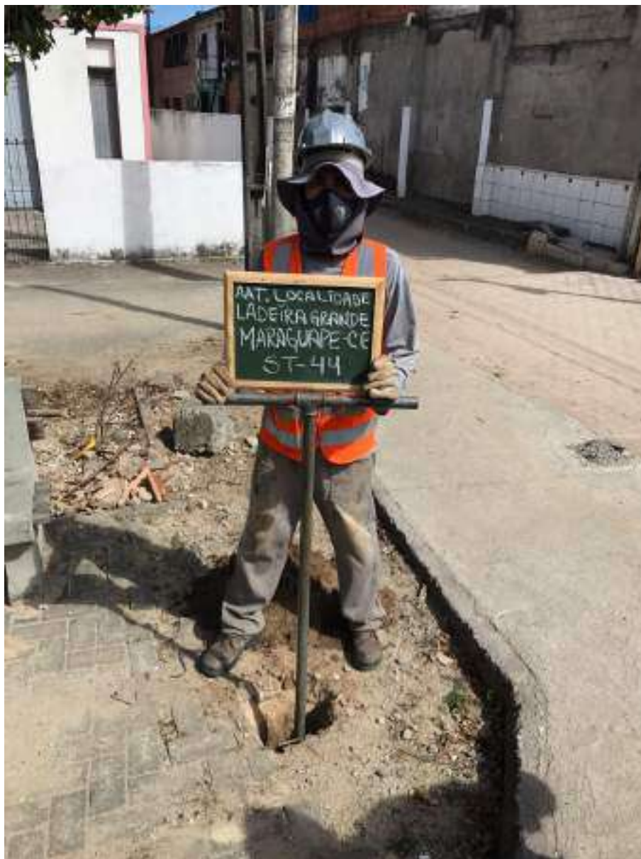
Instalação do furo ST-44
