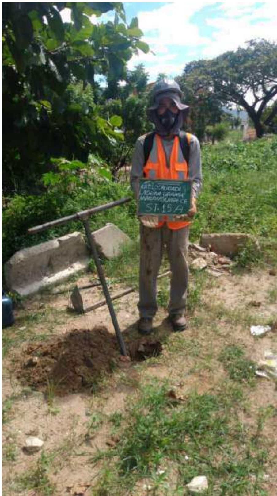
Instalação do furo ST-15 A
