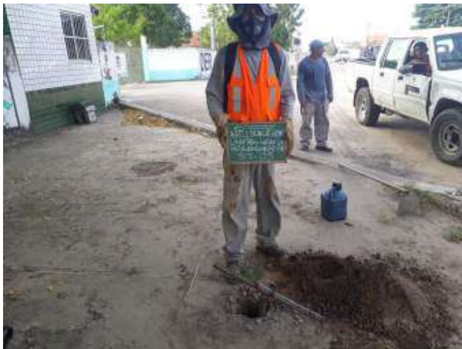
Instalação do furo ST-05
