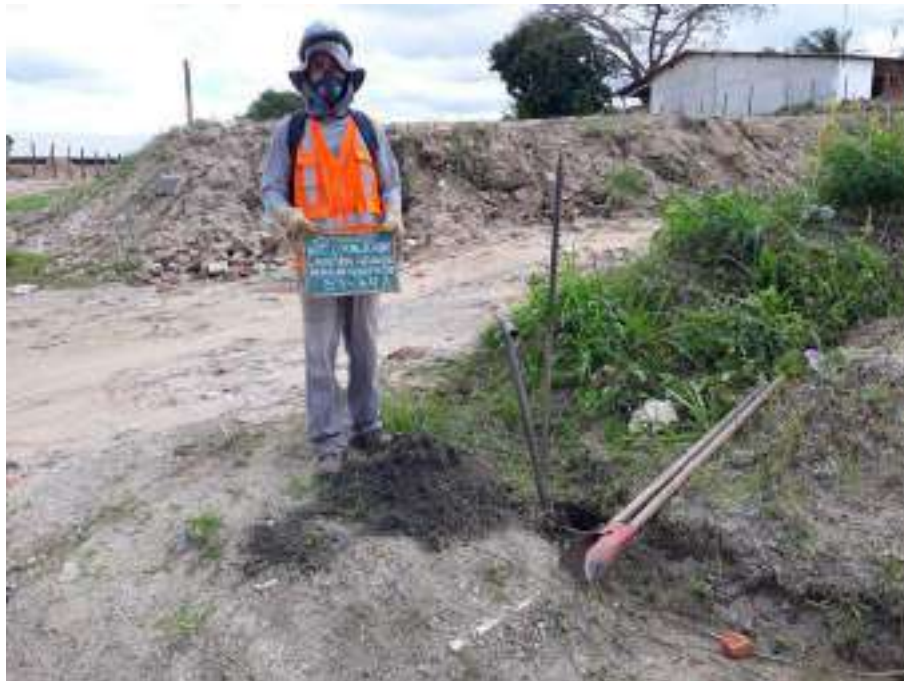
Instalação do furo ST-74 A
