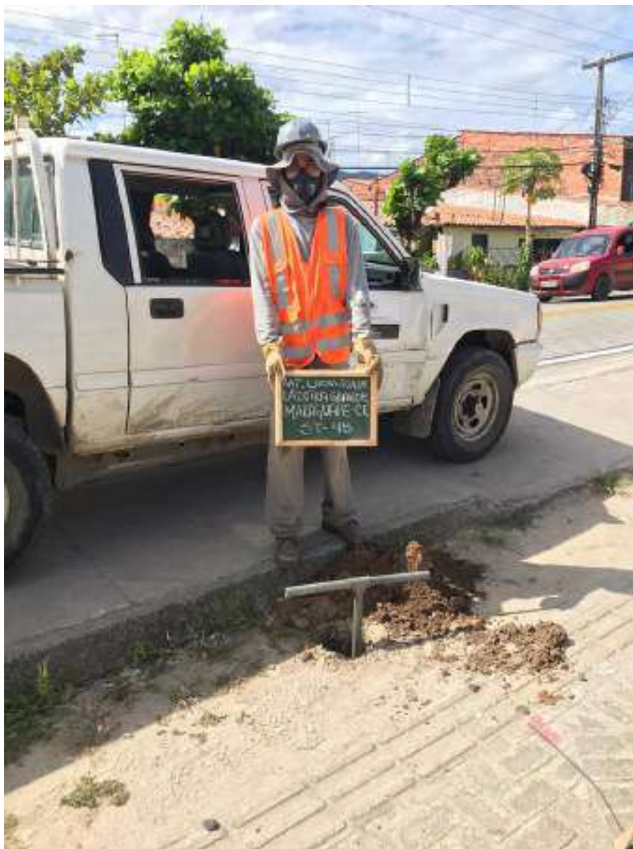
Instalação do furo ST-45
