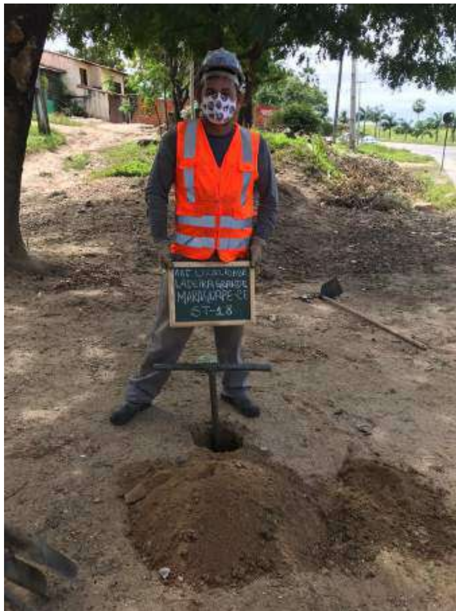
Instalação do furo ST-18
