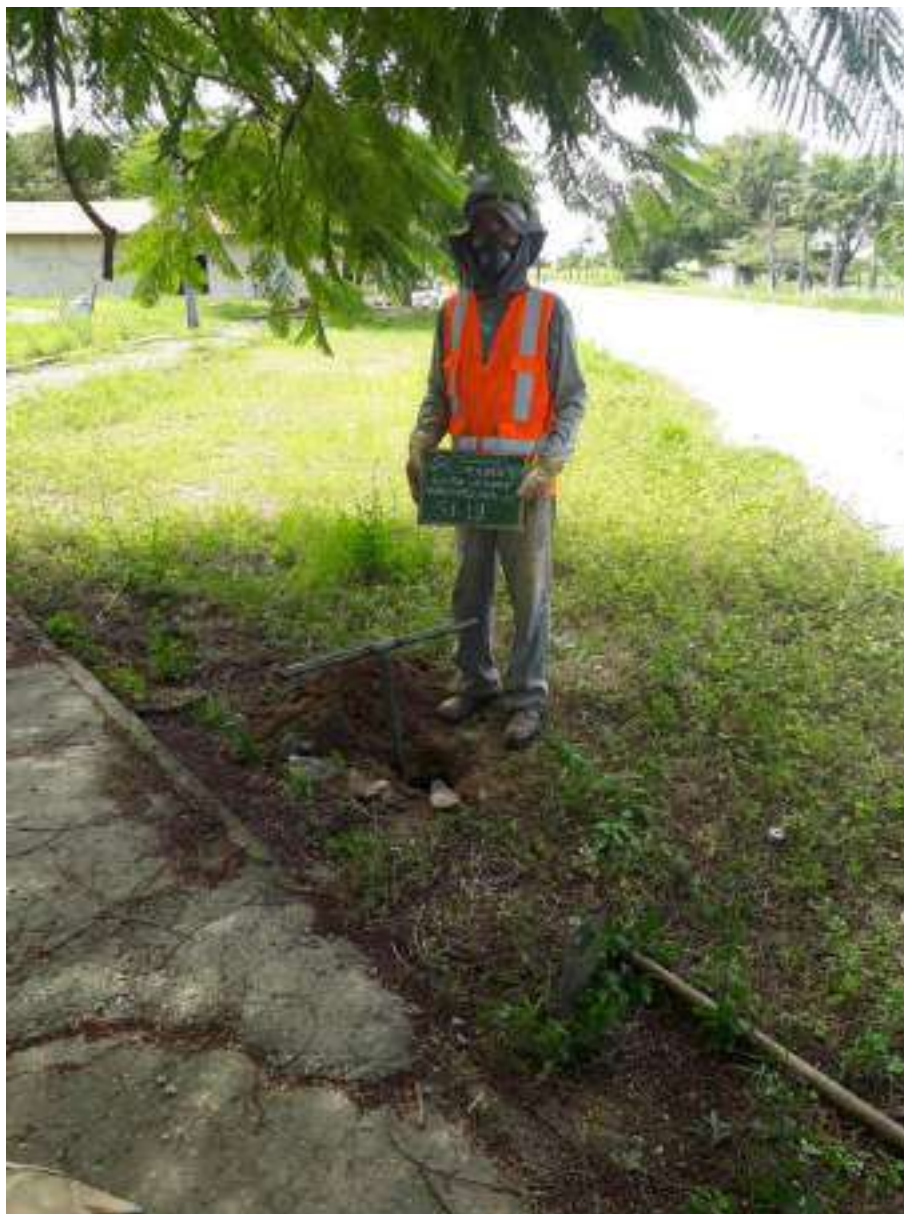
Instalação do furo ST-19
