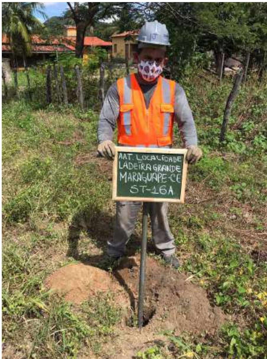
Instalação do furo ST-16 A
