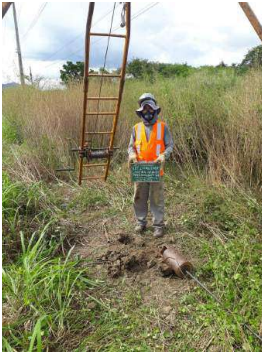
Instalação do furo SP-02
