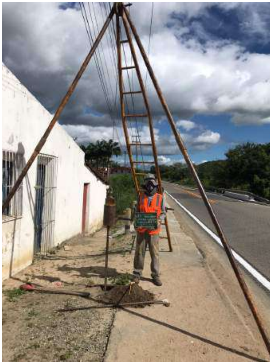
Instalação do furo SP-04
