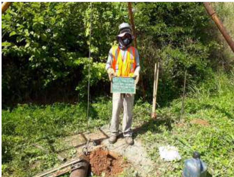
Instalação do furo SP-08
