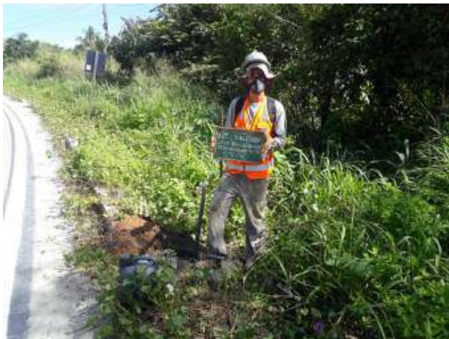
Instalação do furo ST-70
