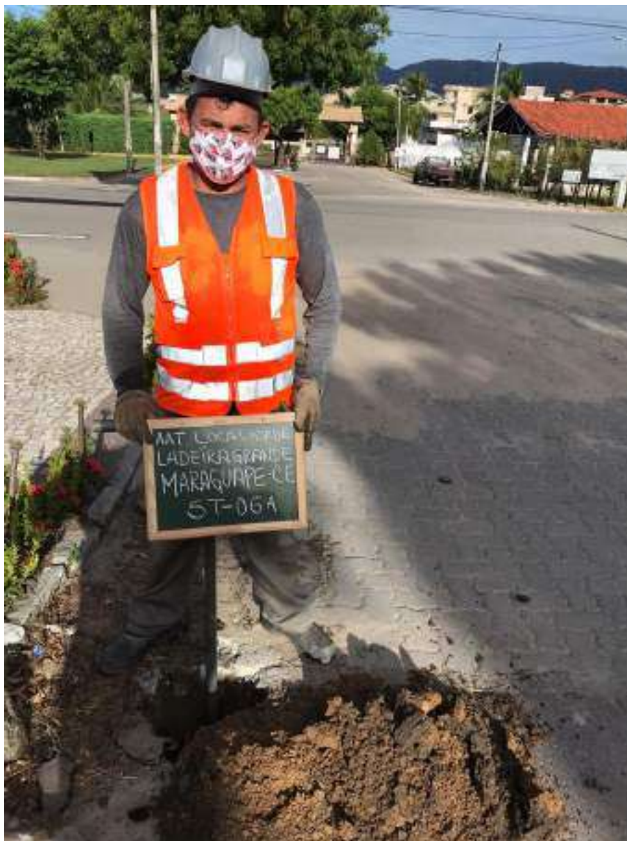
Instalação do furo ST-06 A
