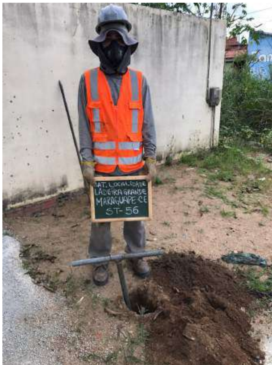
Instalação do furo ST-56
