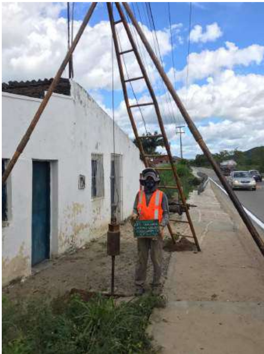
Instalação do furo SP-04 A
