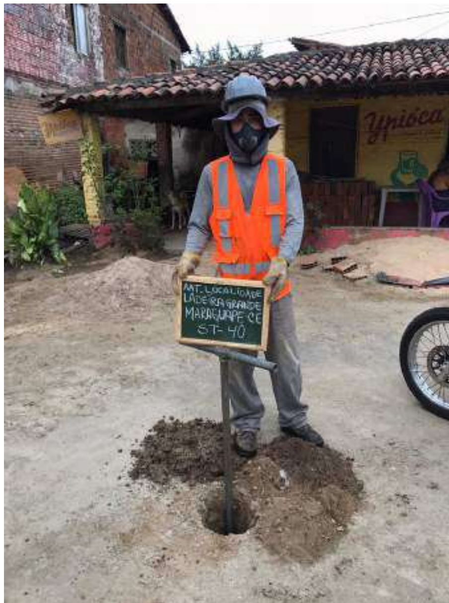
Instalação do furo ST-40
