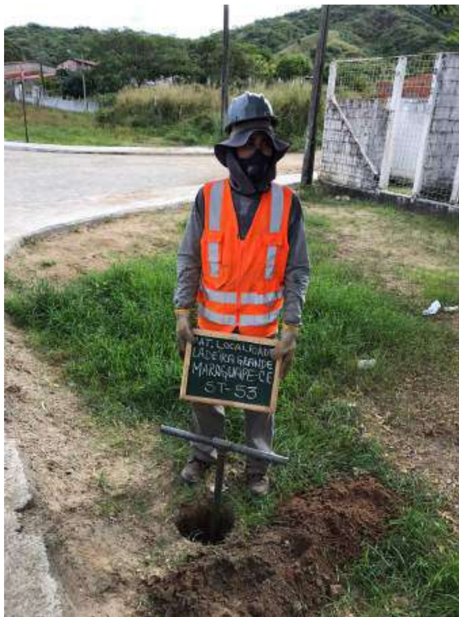
Instalação do furo ST-53
