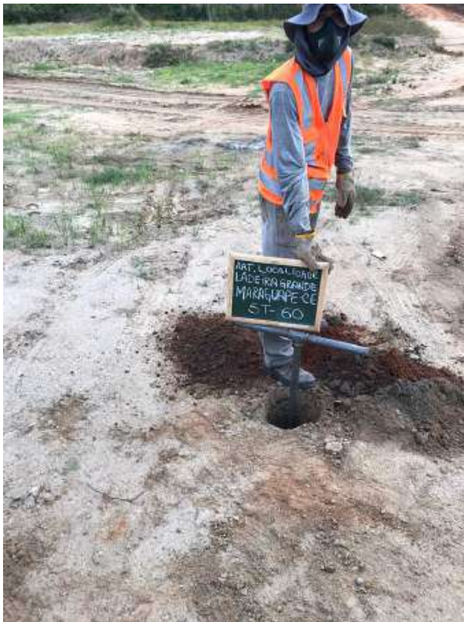
Instalação do furo ST-60
