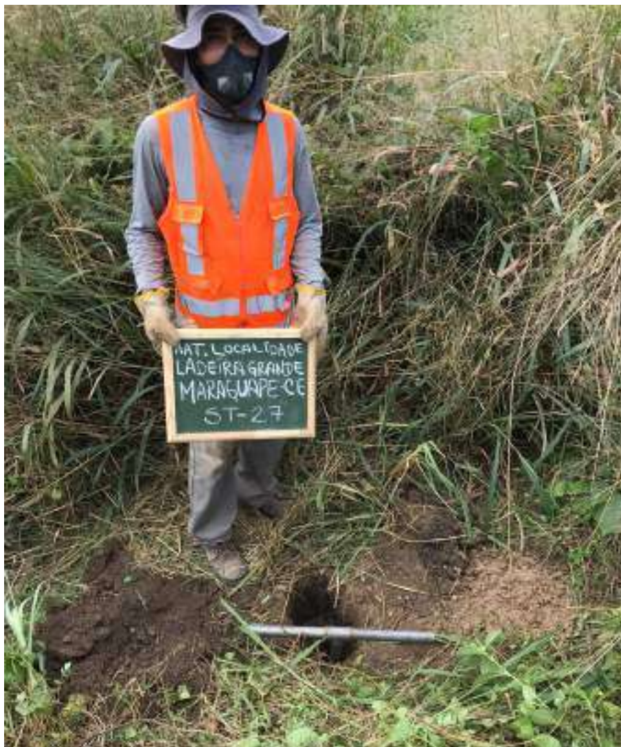
Instalação do furo ST-27
