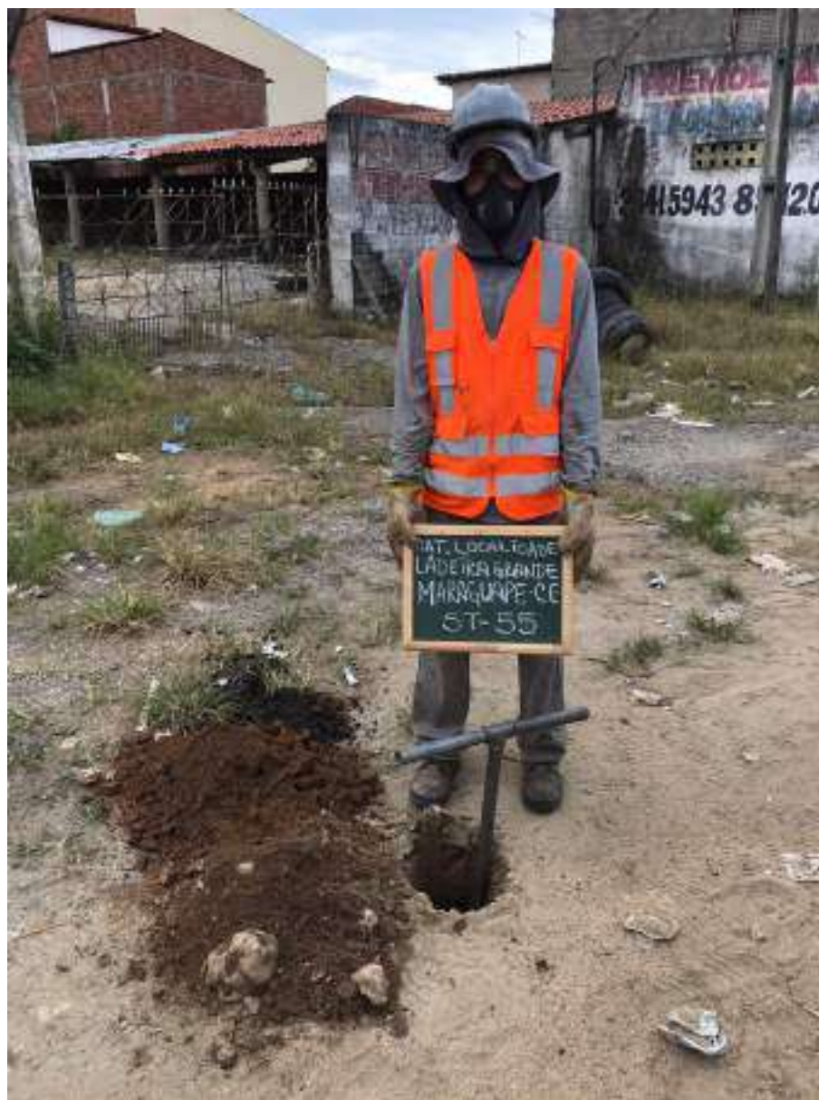
Instalação do furo ST-55
