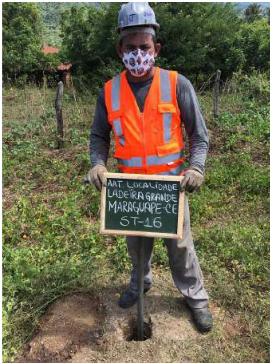
Instalação do furo ST-16
