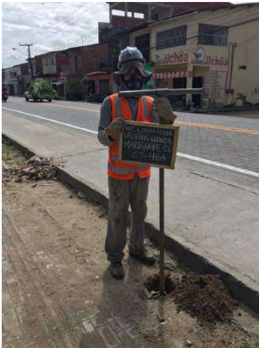
Instalação do furo ST-46 A
