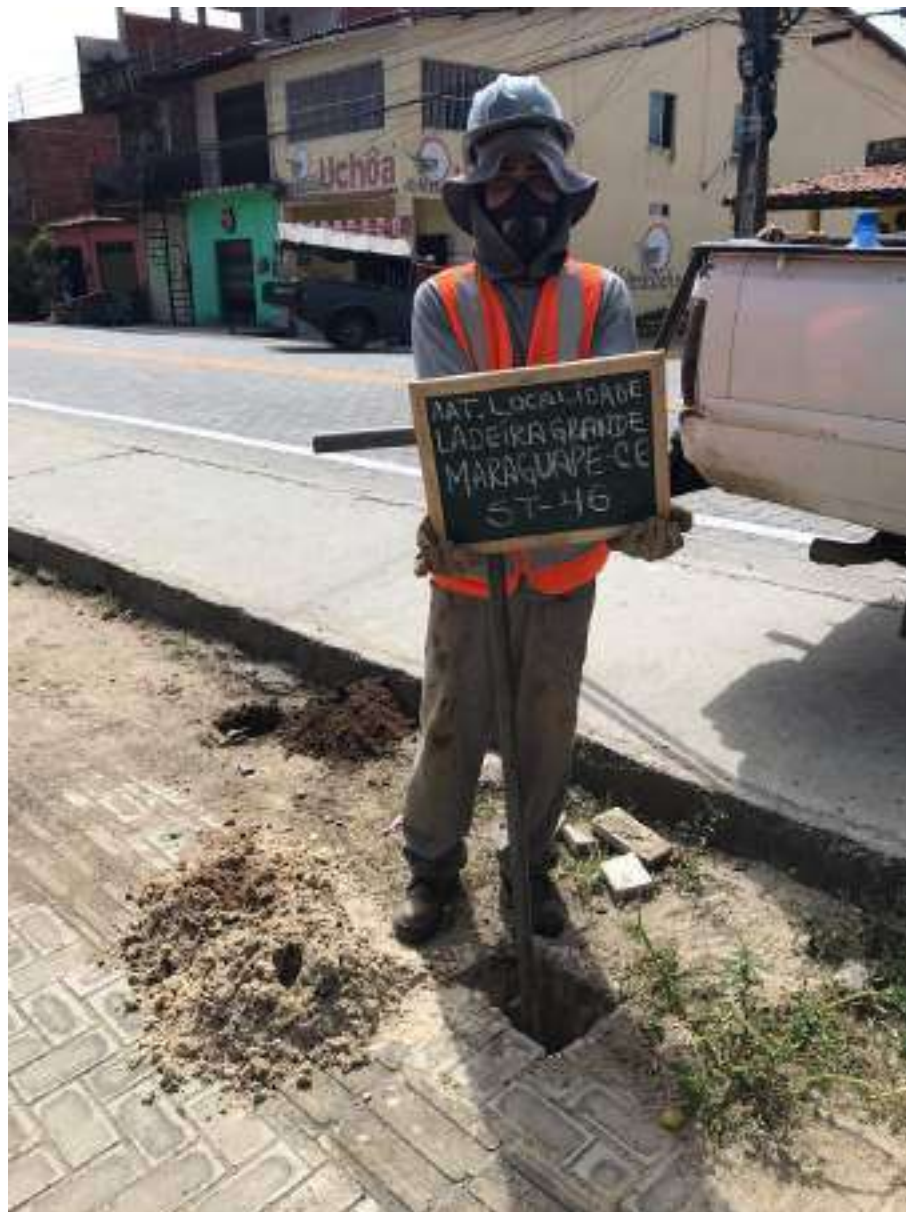
Instalação do furo ST-46
