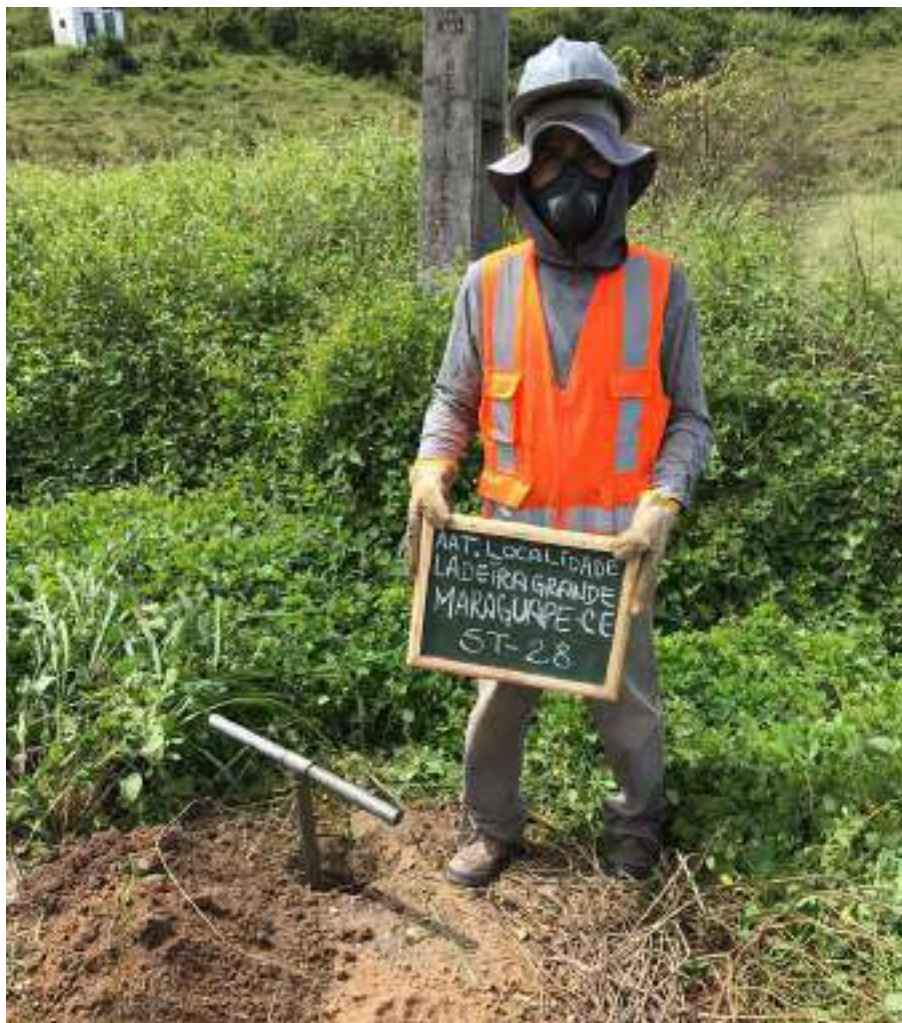
Instalação do furo ST-28
