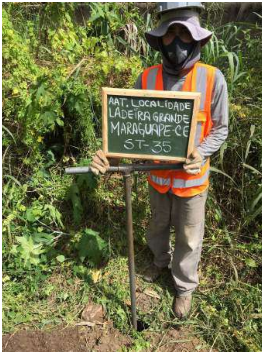
Instalação do furo ST-35
