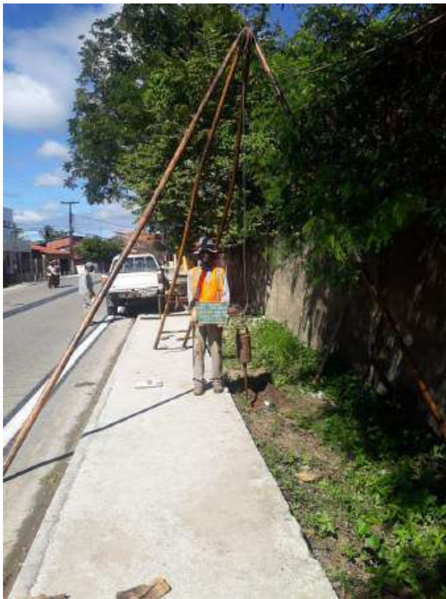
Instalação do furo SP-06
