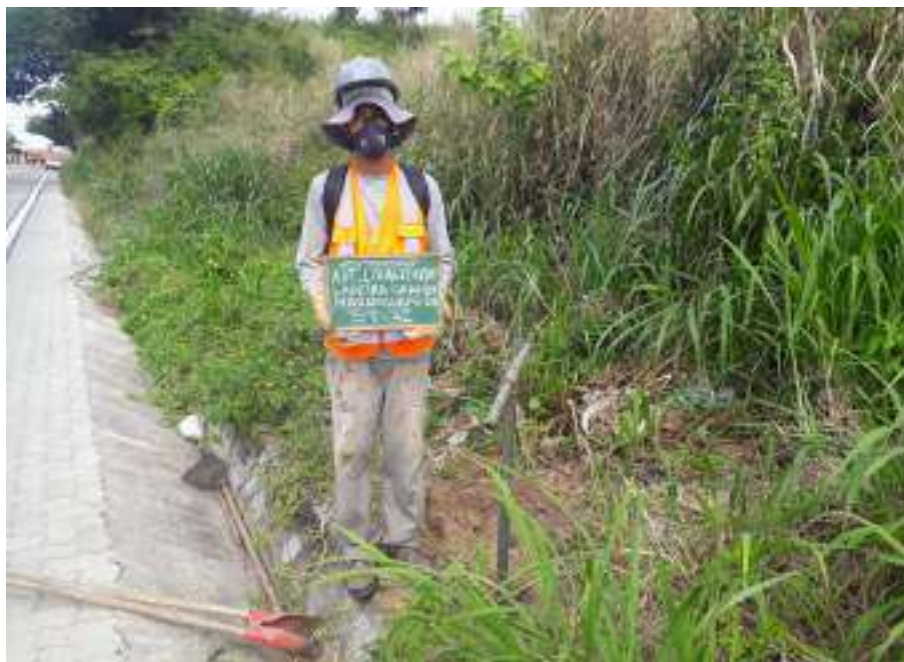
Instalação do furo ST-72
