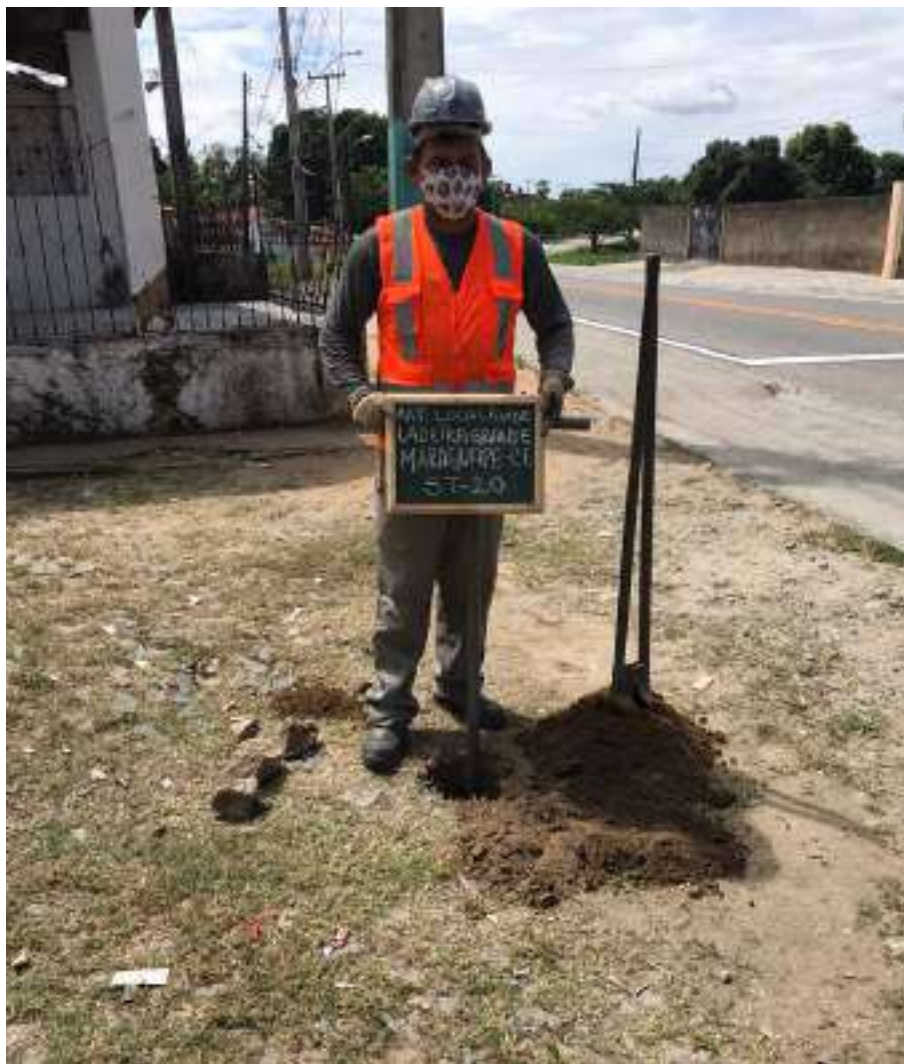
Instalação do furo ST-20
