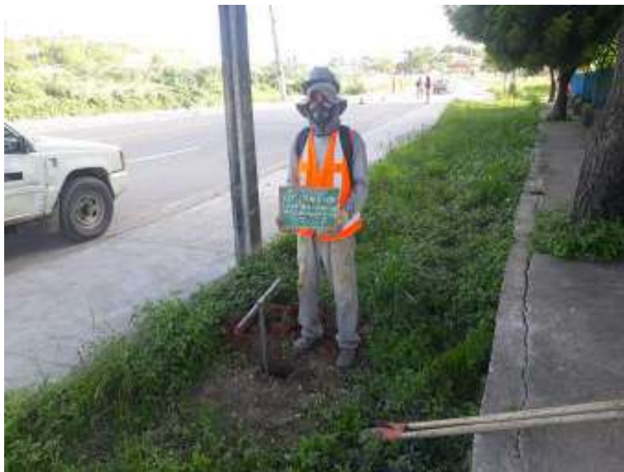
Instalação do furo ST-07
