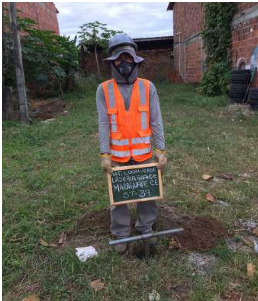
Instalação do furo ST-39
