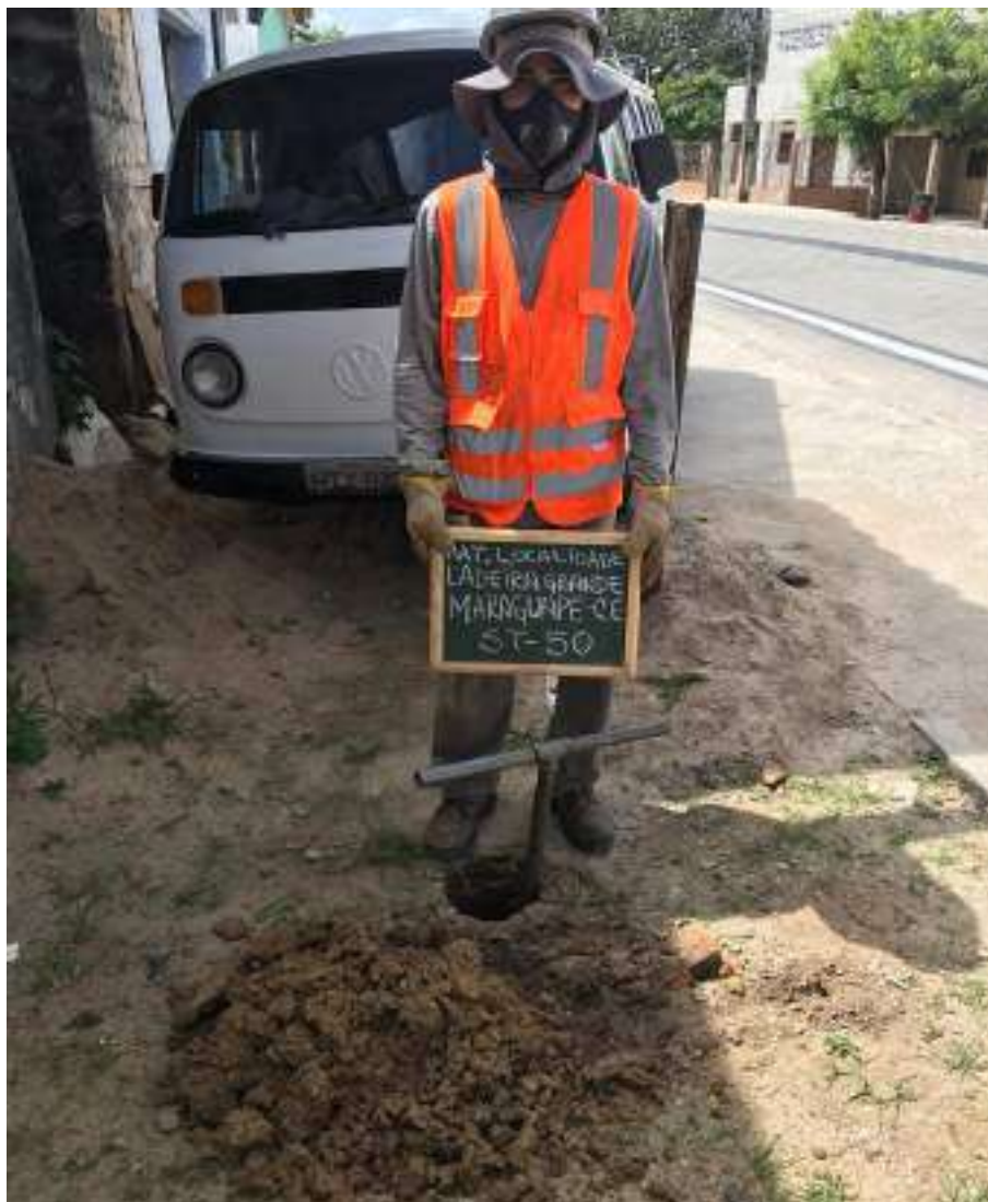
Instalação do furo ST-50
