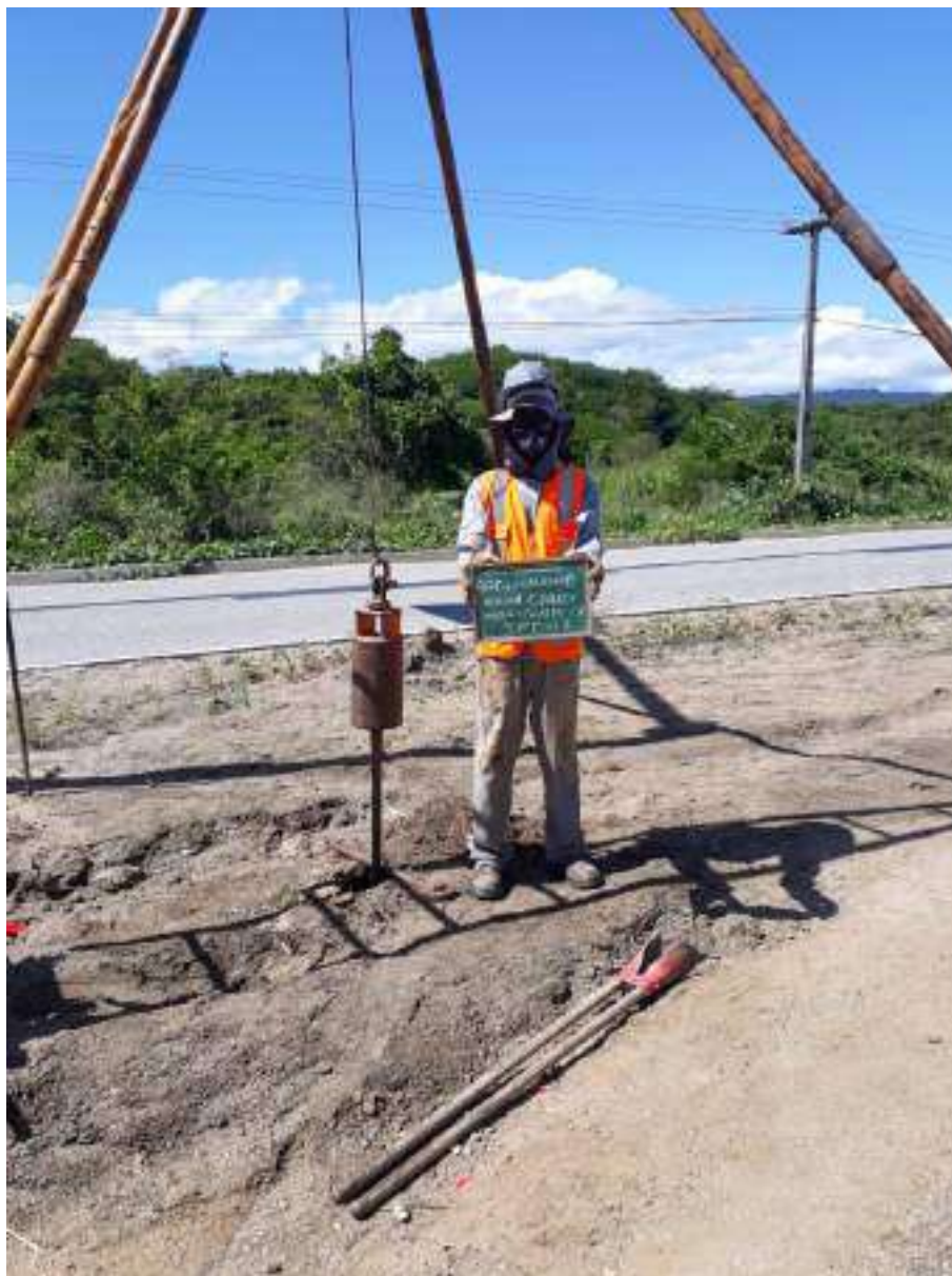
Instalação do furo SP-07
