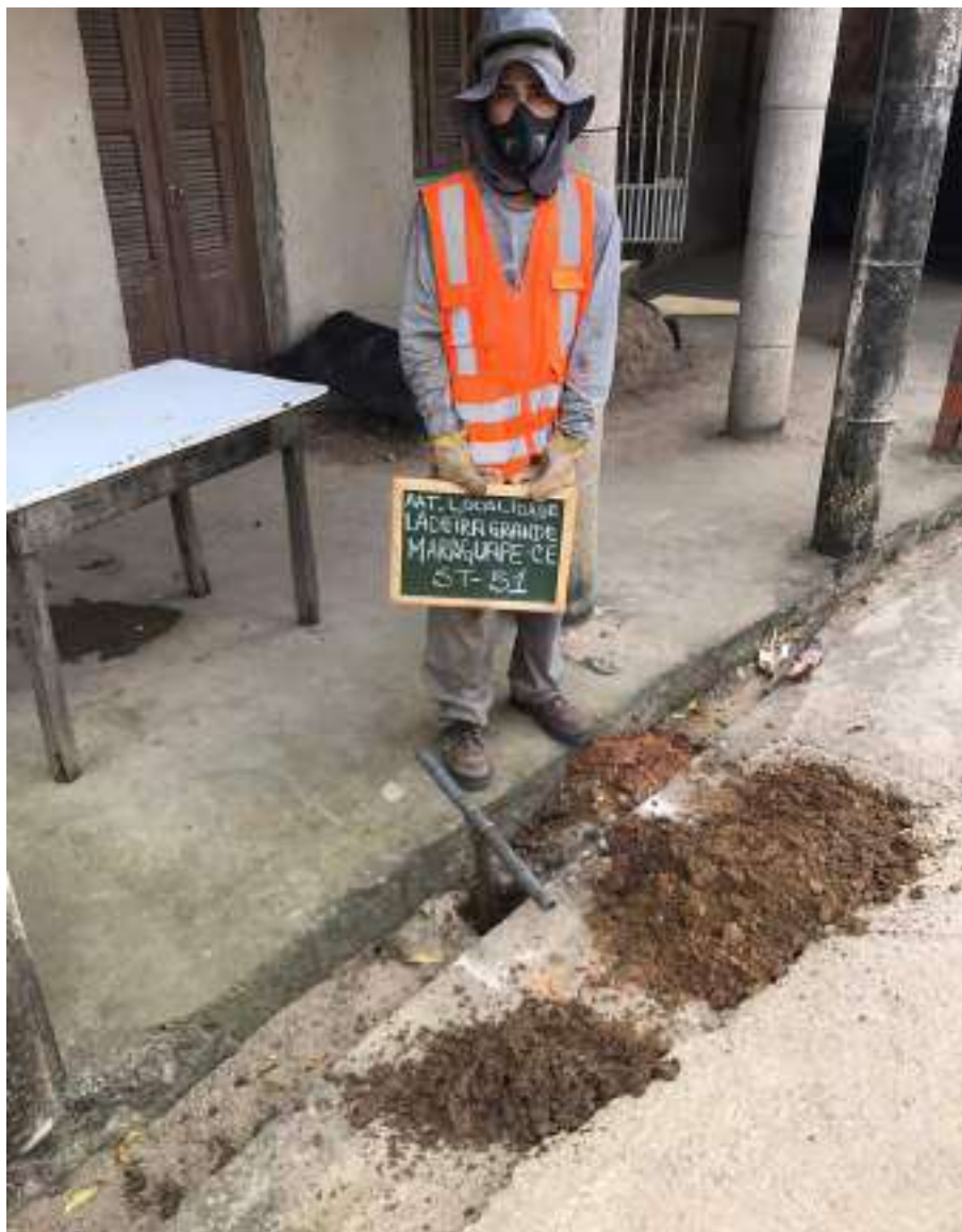
Instalação do furo ST-51
