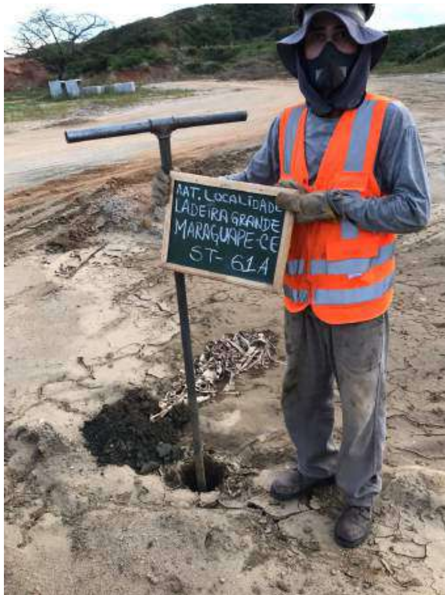
Instalação do furo ST-61 A
