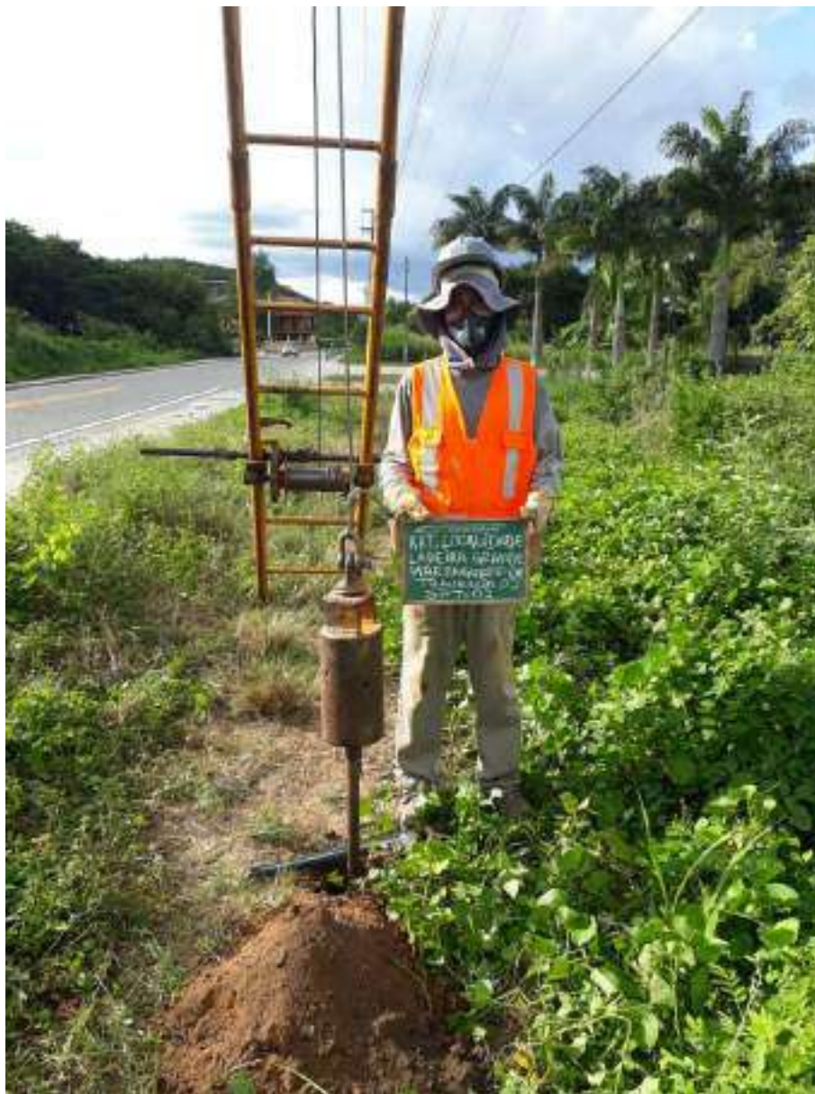
Instalação do furo SP-02
