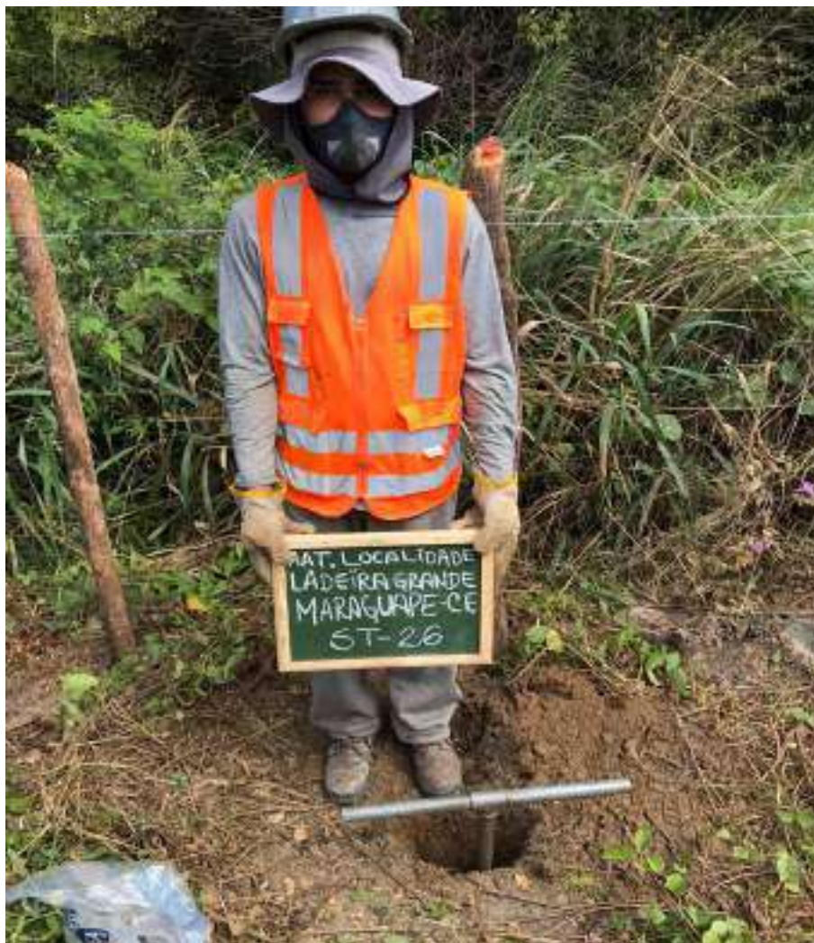
Instalação do furo ST-26
