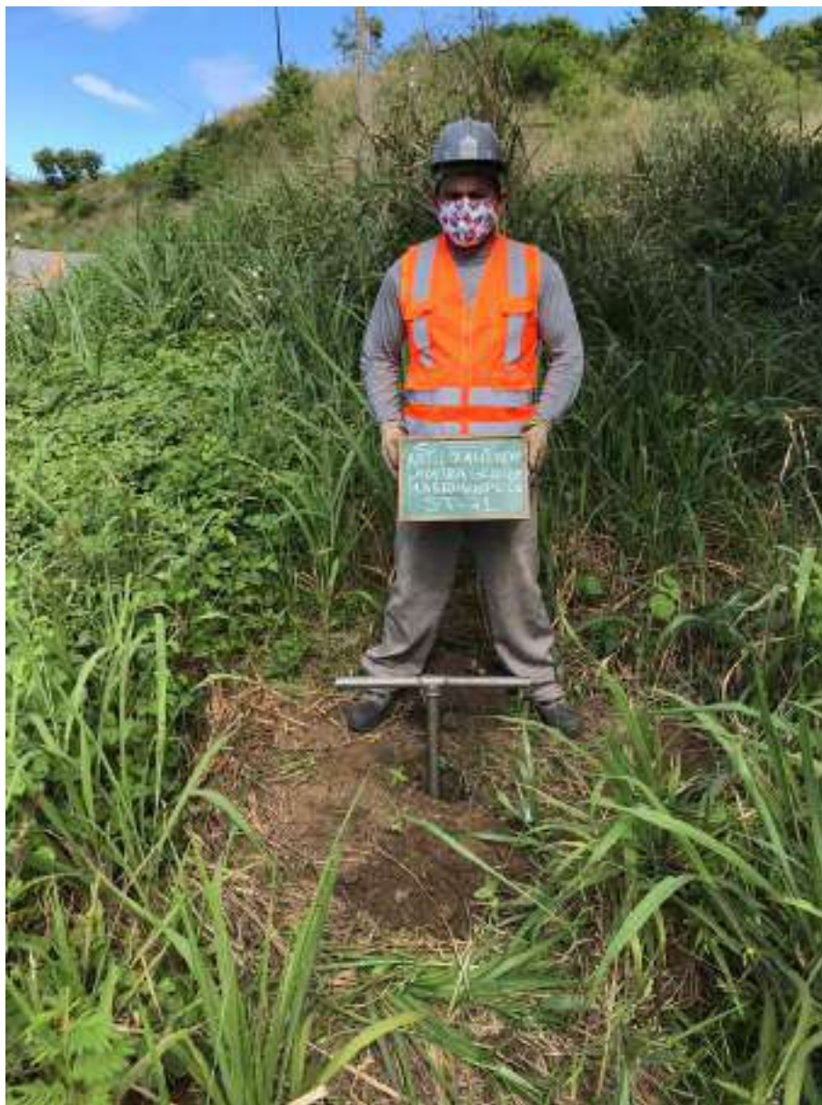
Instalação do furo ST-71
