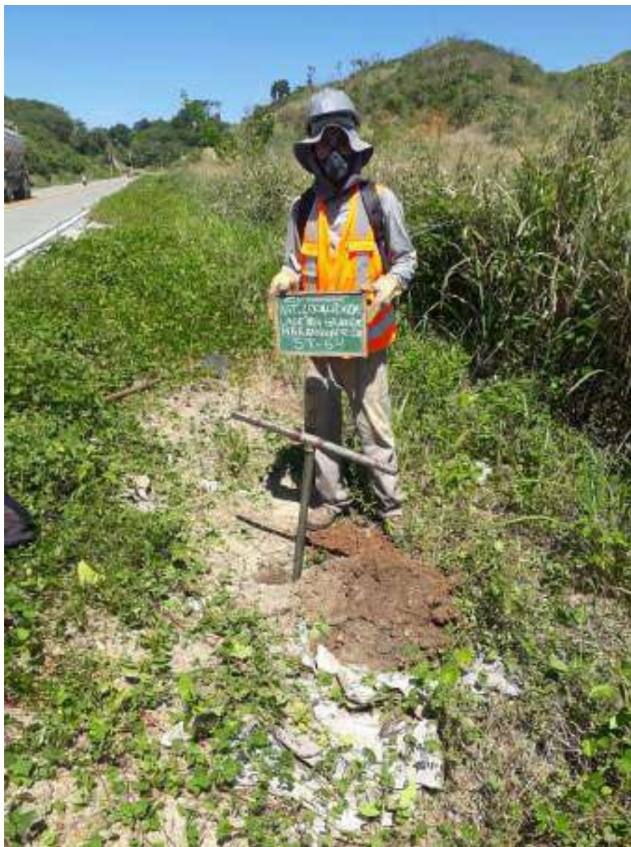
Instalação do furo ST-64
