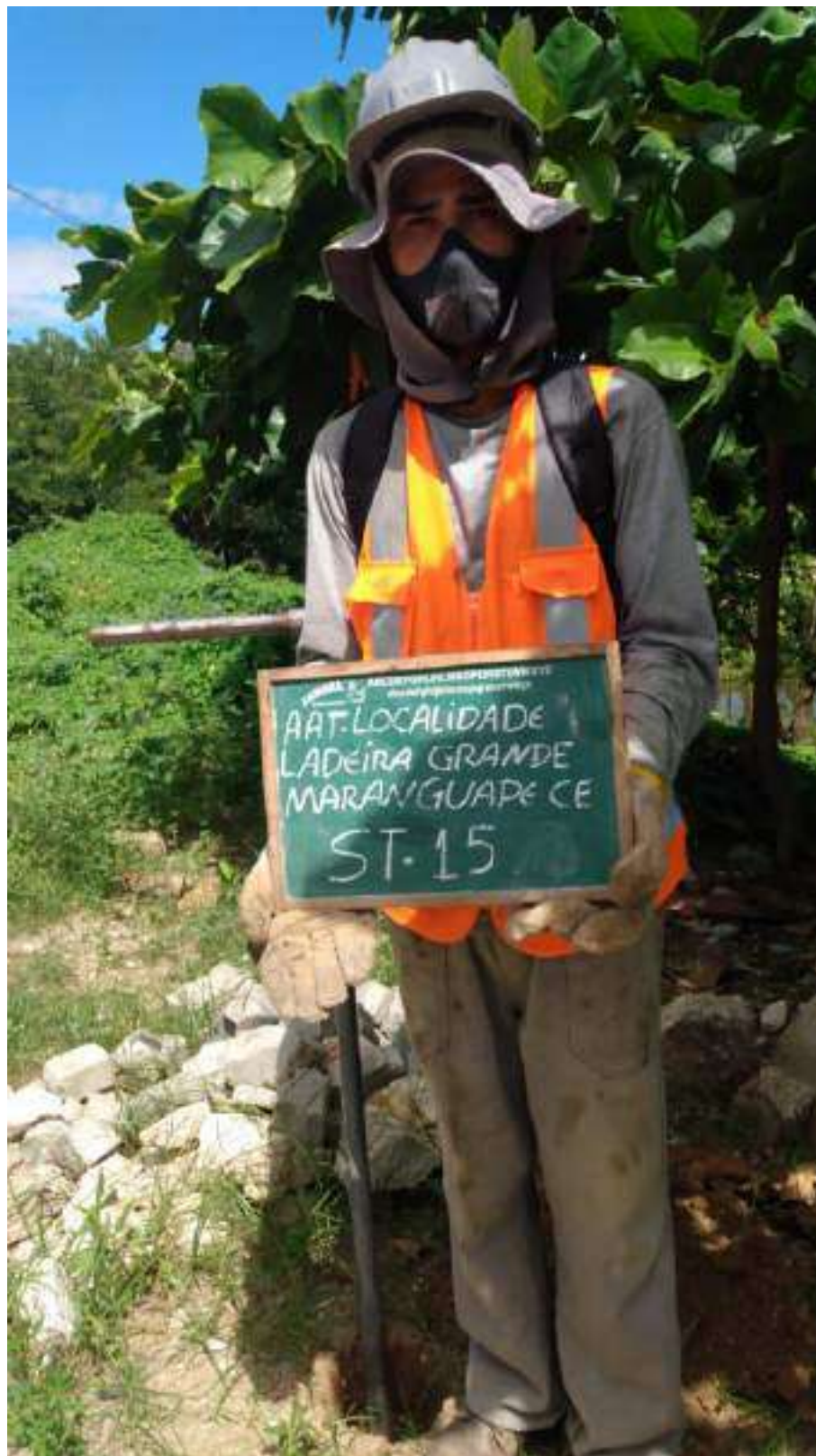
Instalação do furo ST-15
