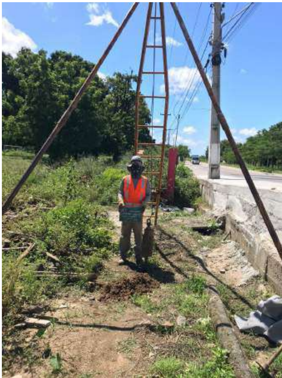
Instalação do furo SP-03
