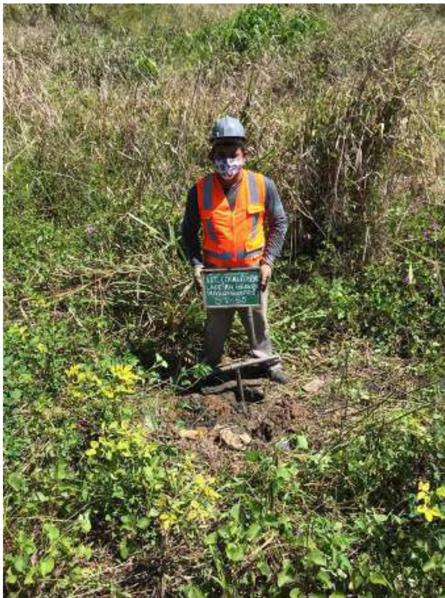
Instalação do furo ST-65
