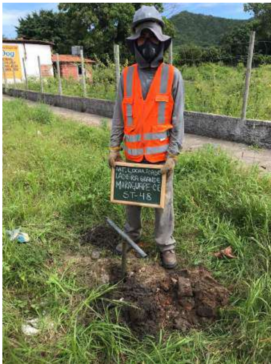
Instalação do furo ST-48
