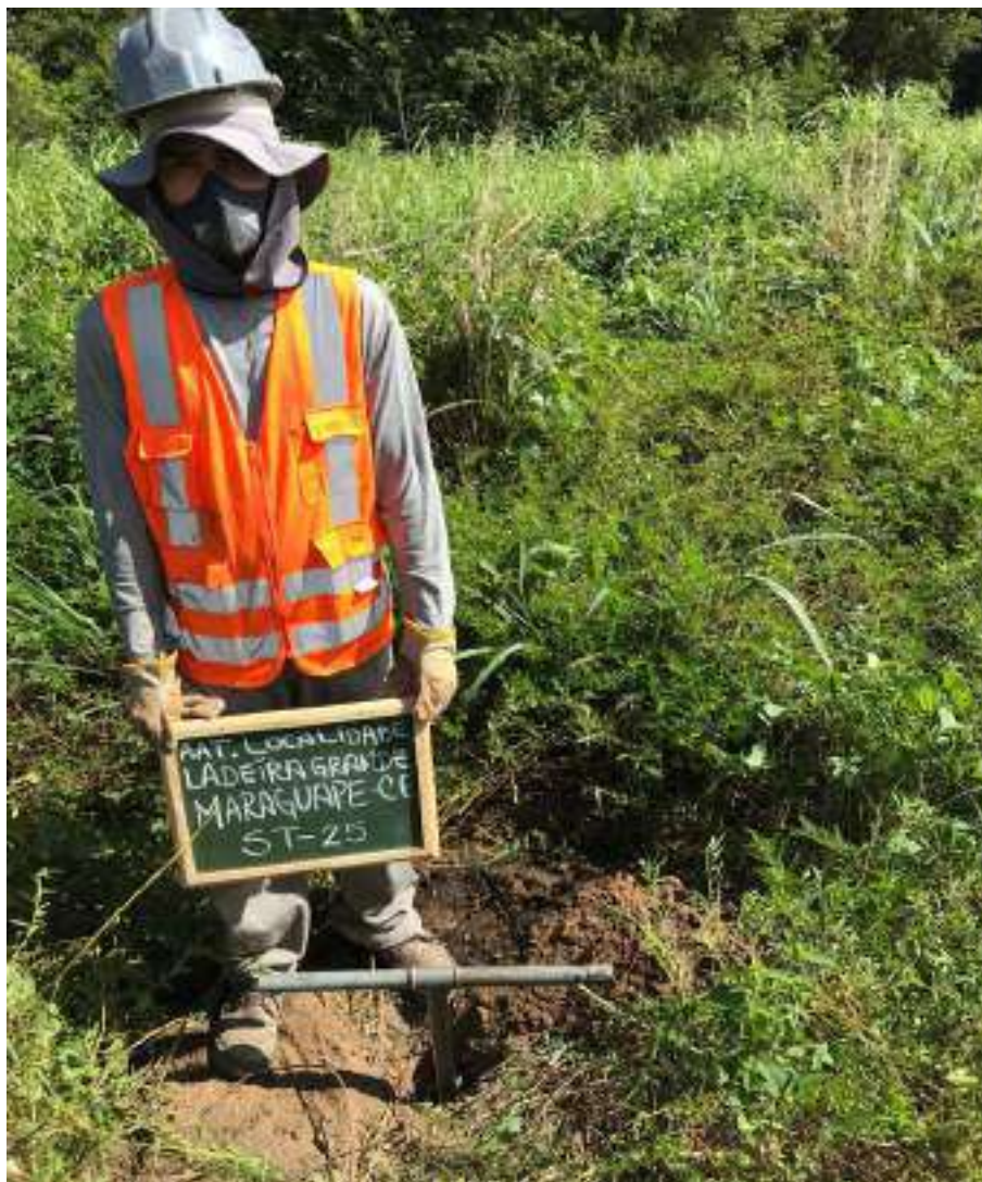
Instalação do furo ST-25
