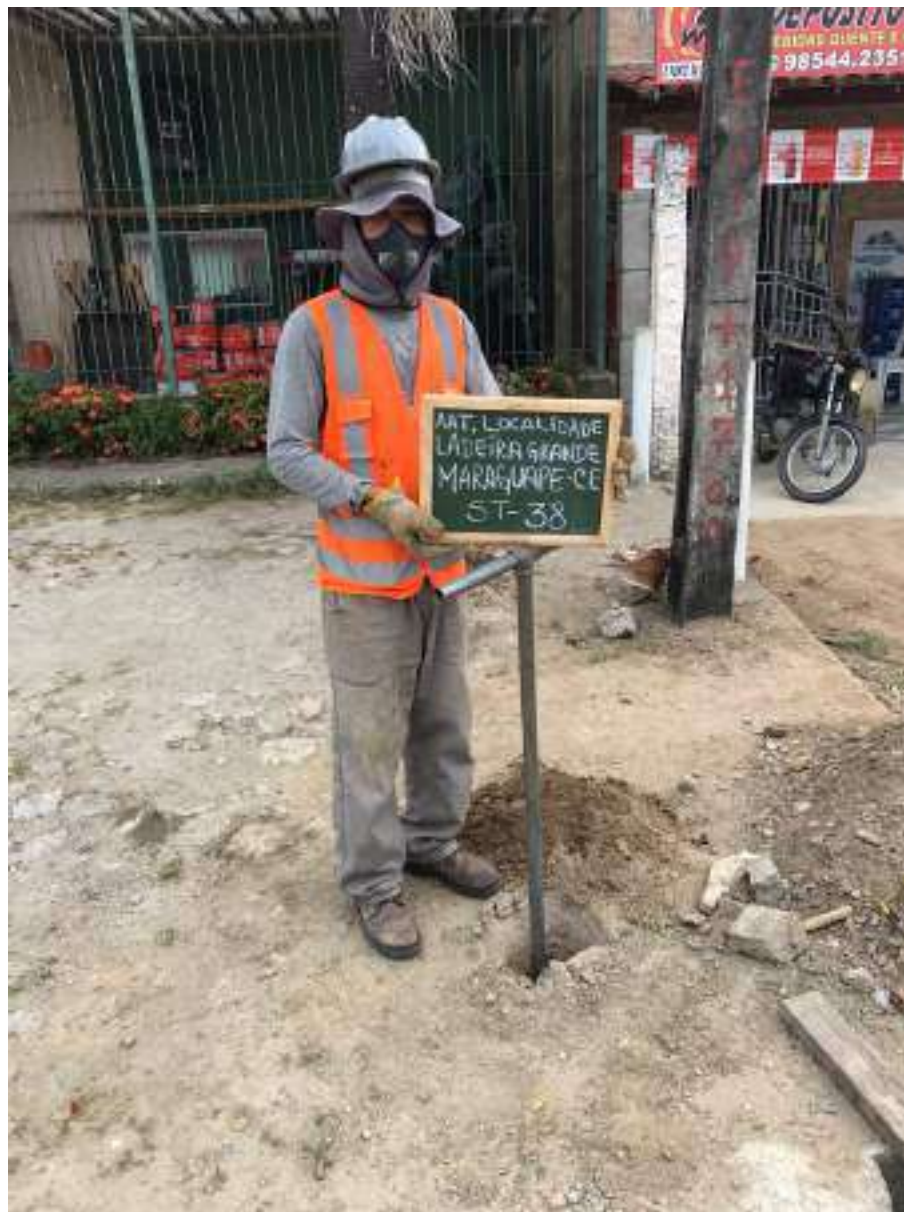
Instalação do furo ST-38
