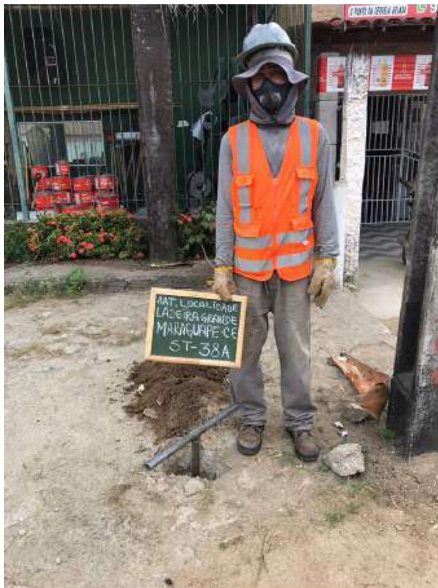
Instalação do furo ST-38 A
