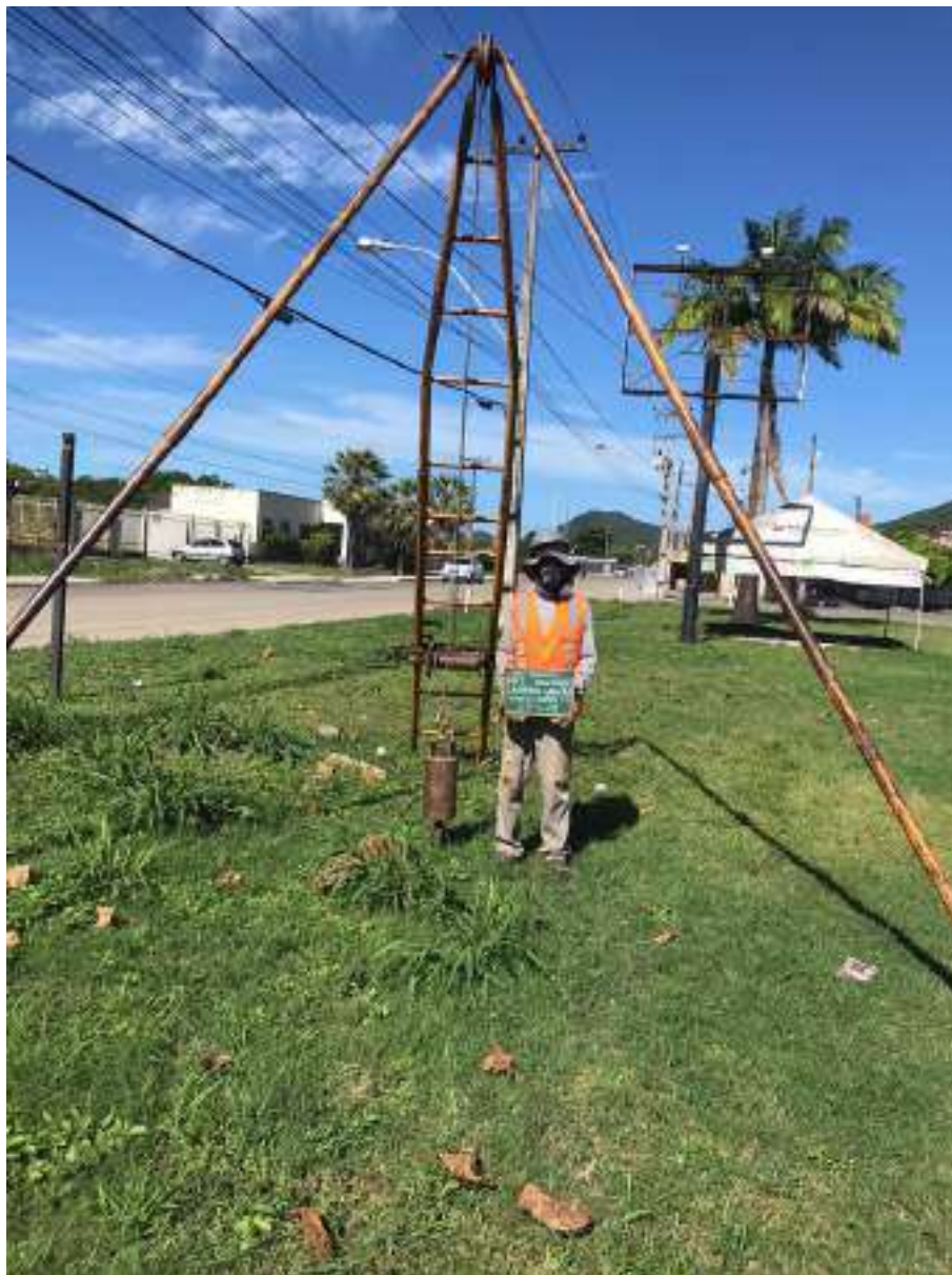
Instalação do furo SP-01
