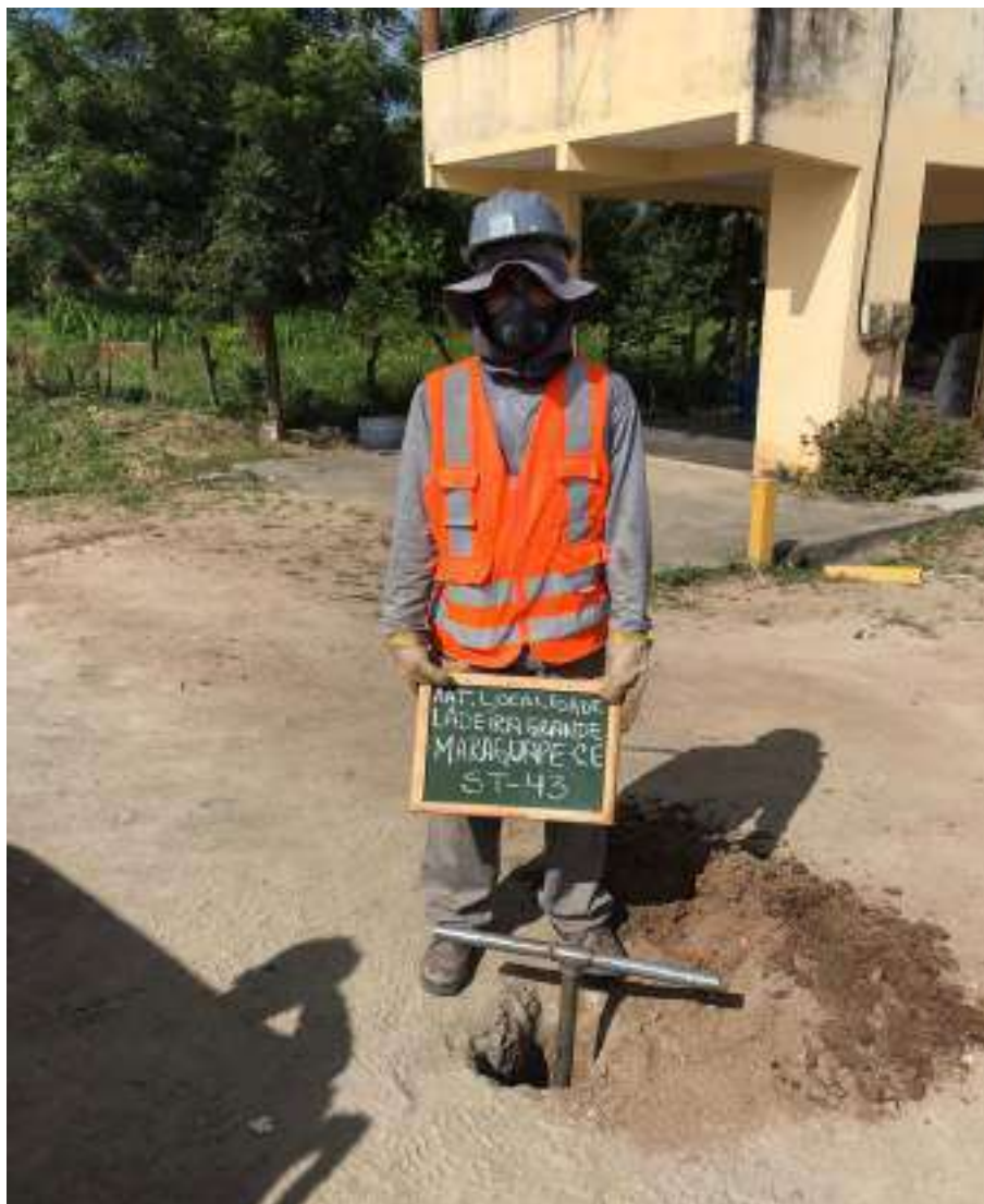
Instalação do furo ST-43
