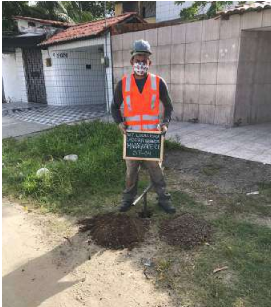
Instalação do furo ST-04
