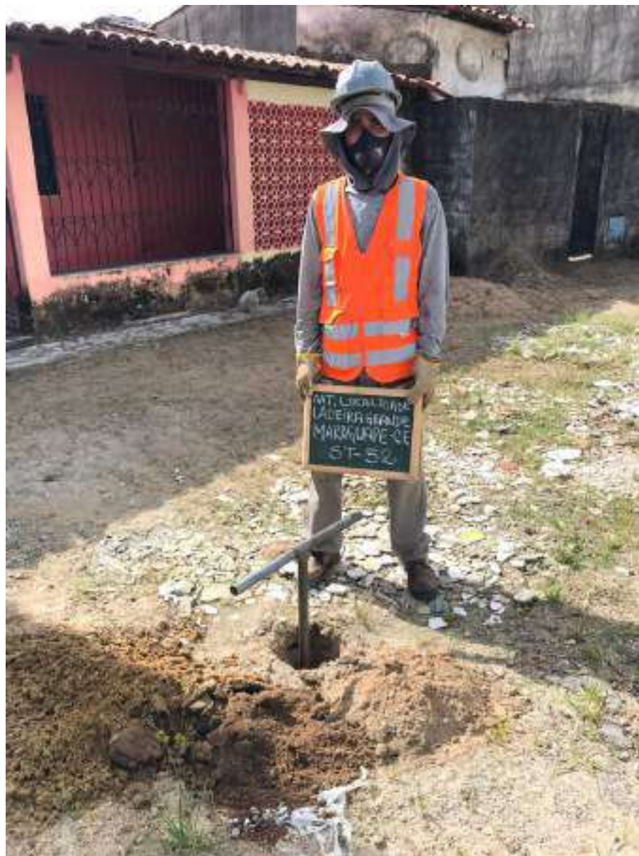
Instalação do furo ST-52
