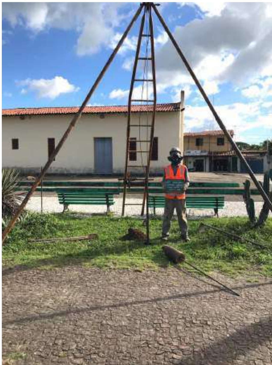
Instalação do furo SP-05
