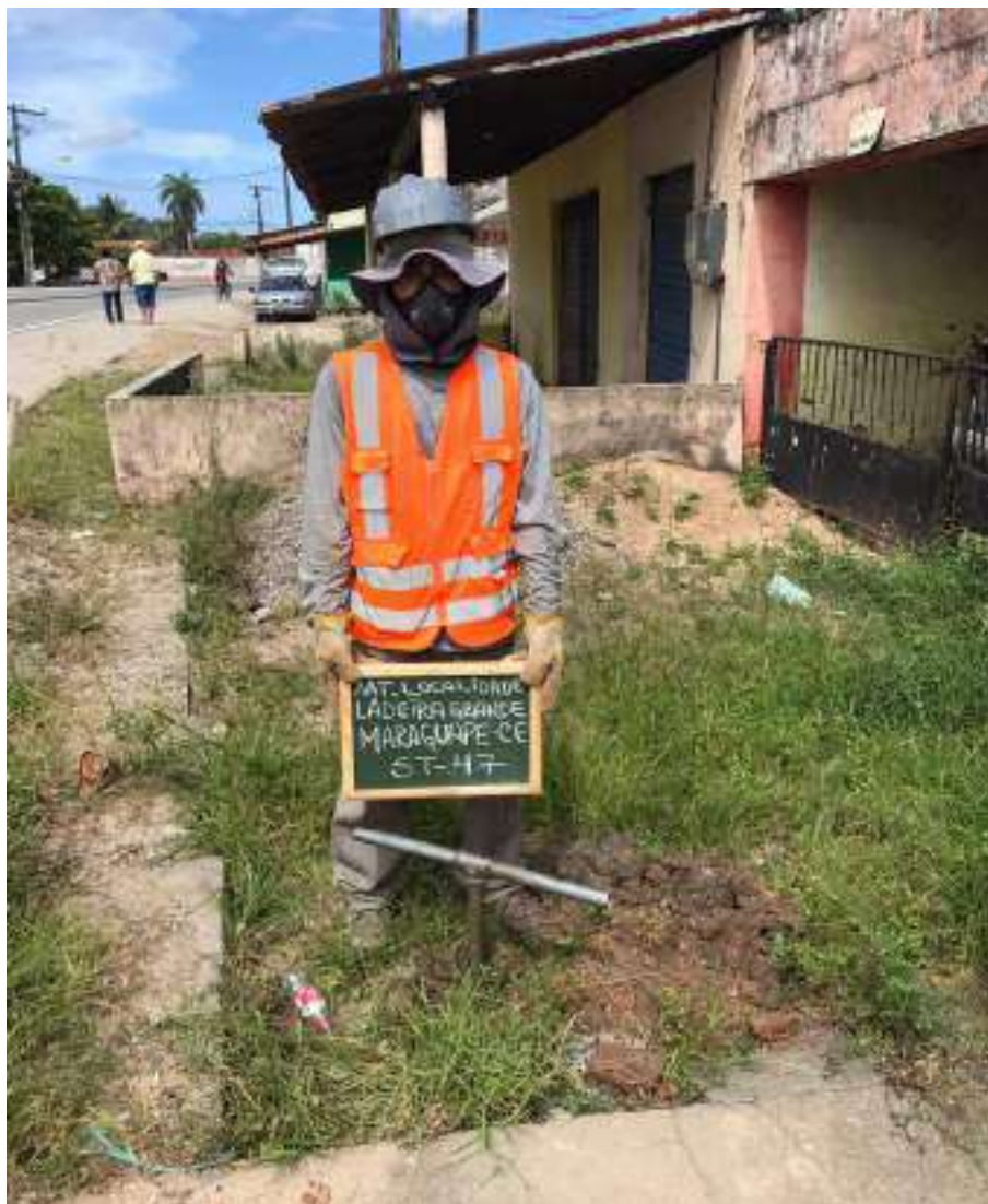
Instalação do furo ST-47
