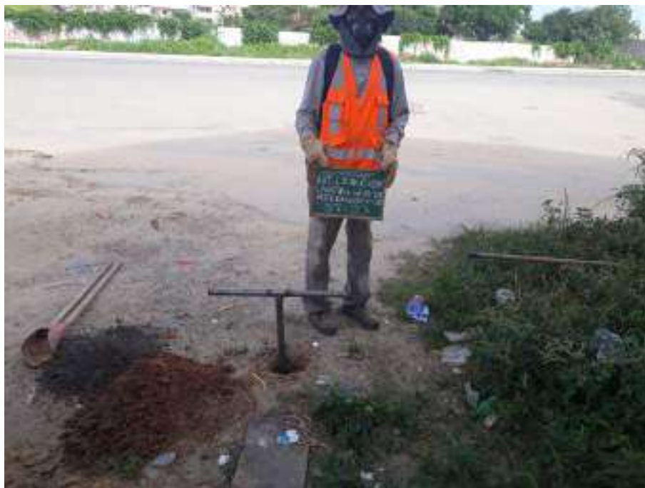
Instalação do furo ST-03
