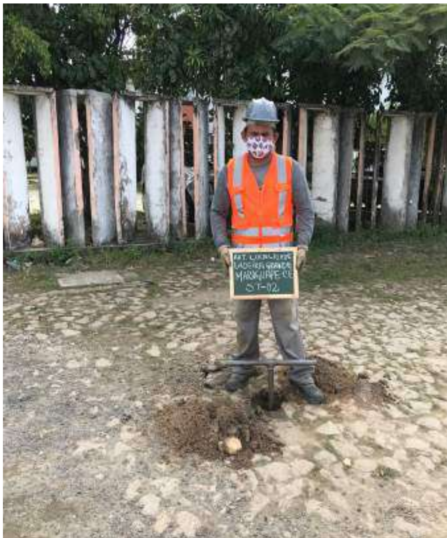
Instalação do furo ST-02
