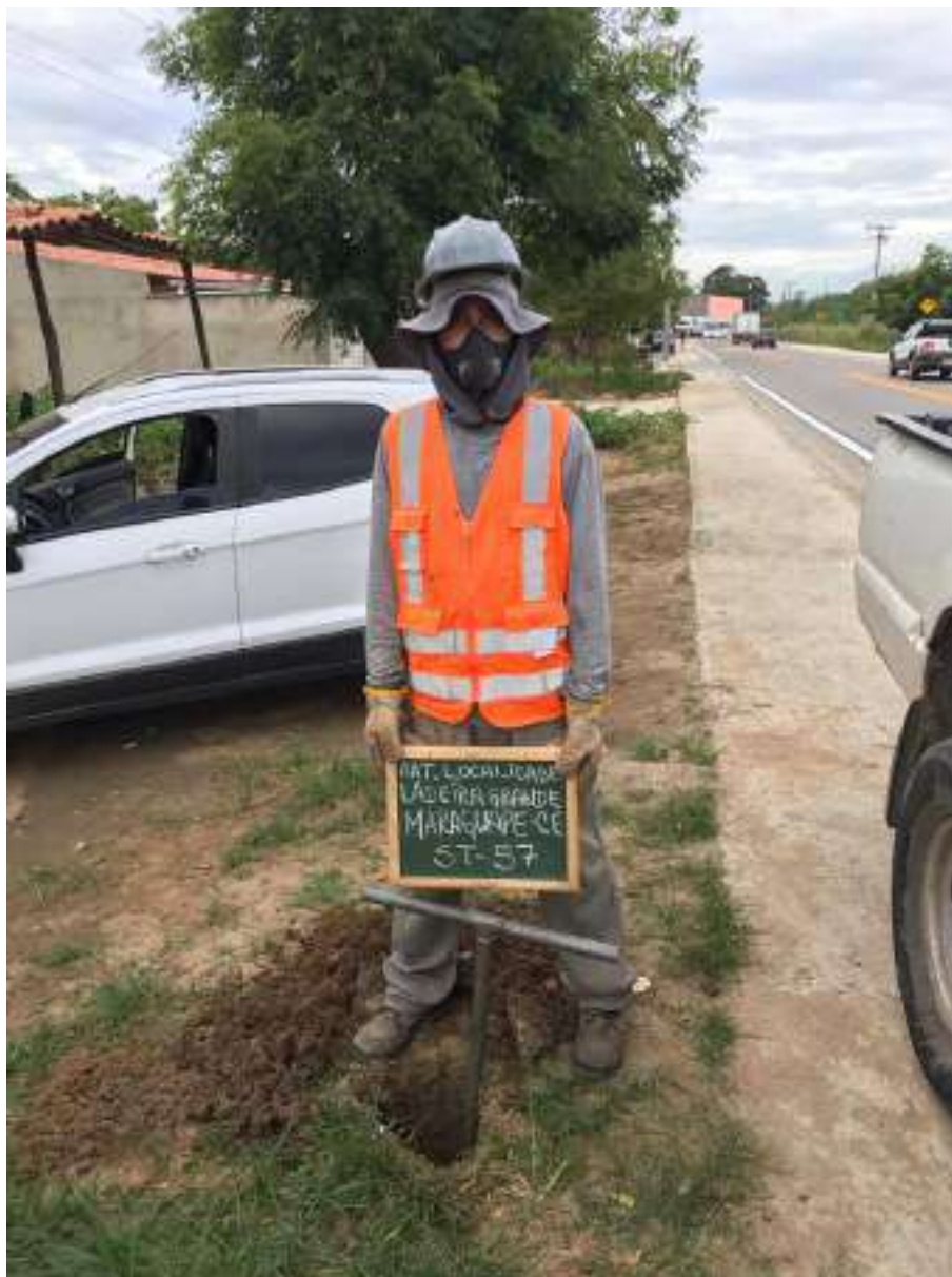
Instalação do furo ST-57
