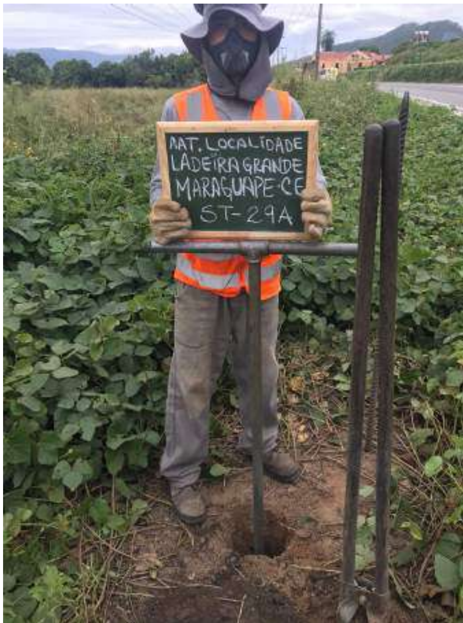
Instalação do furo ST-29 A
