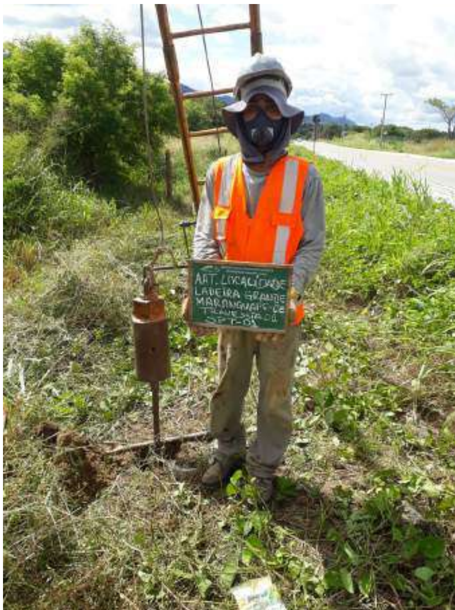
Instalação do furo SP-01
