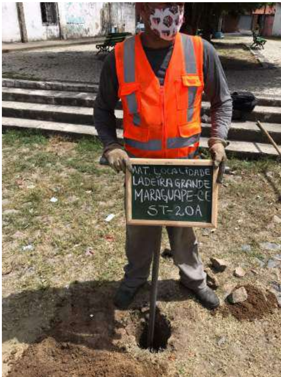
Instalação do furo ST-20 A
