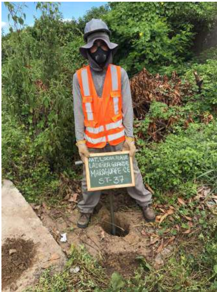
Instalação do furo ST-37
