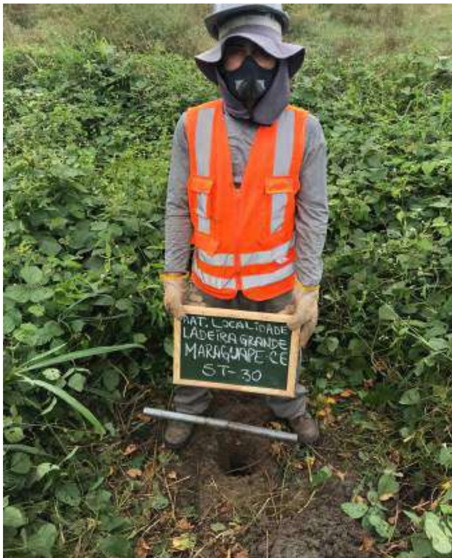
Instalação do furo ST-30
