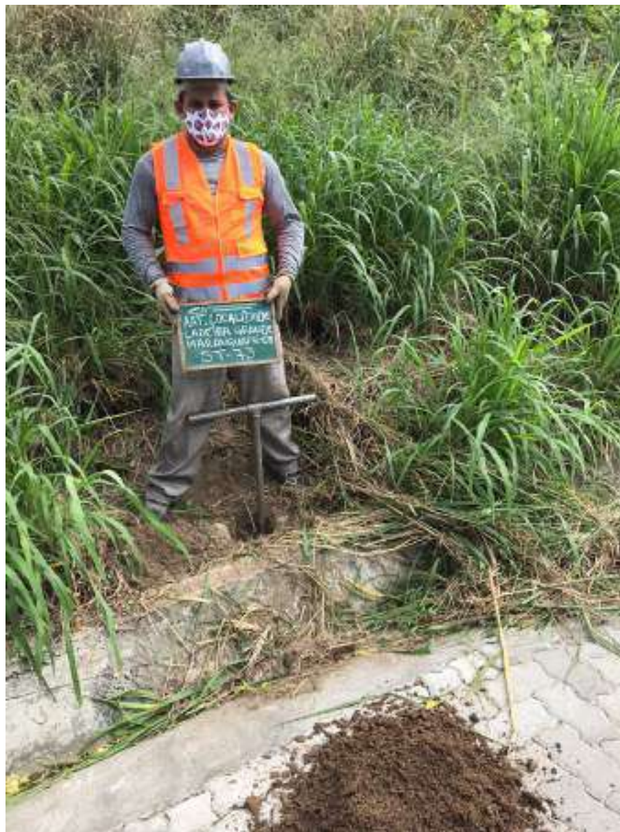
Instalação do furo ST-73
