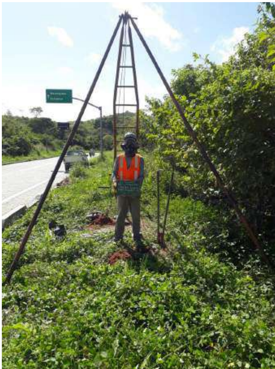
Instalação do furo SP-08 A
