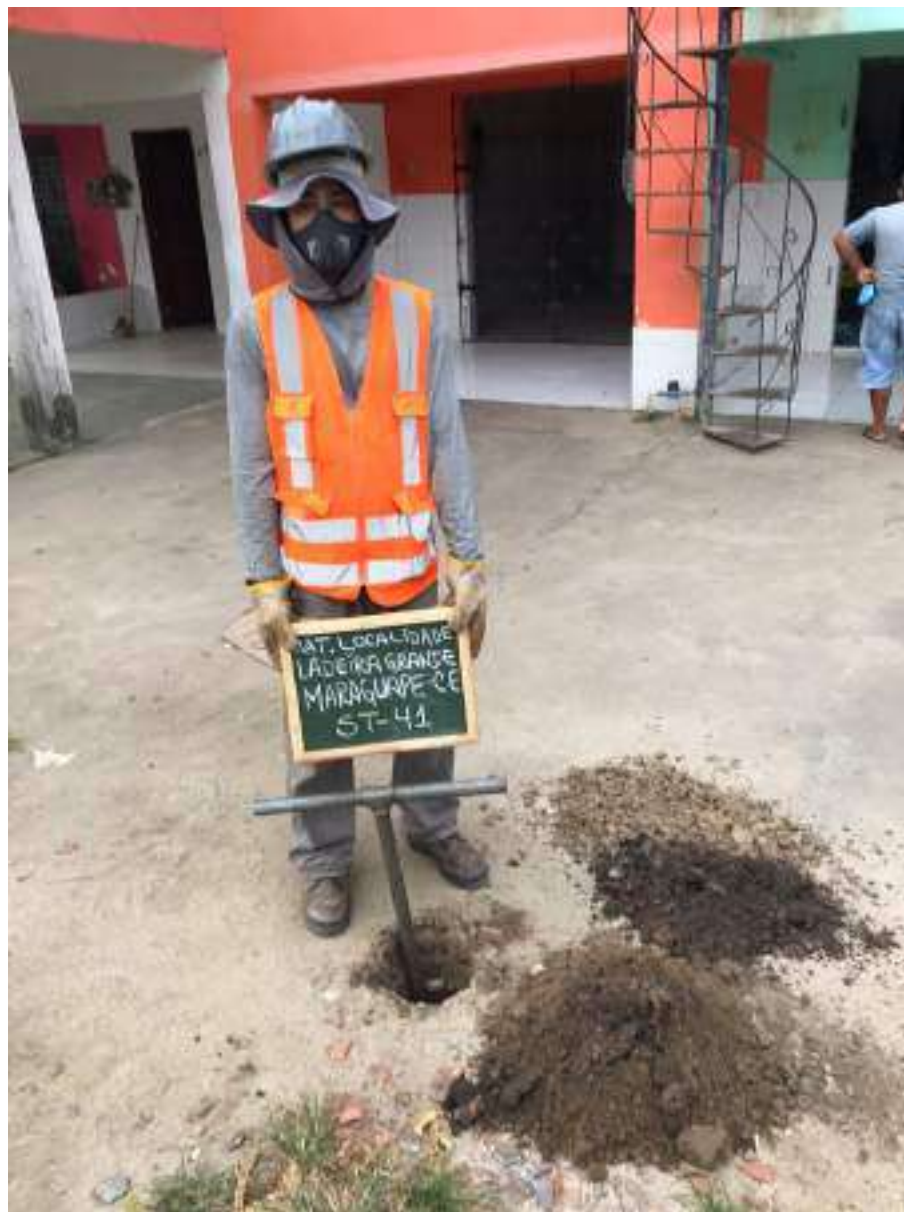
Instalação do furo ST-41
