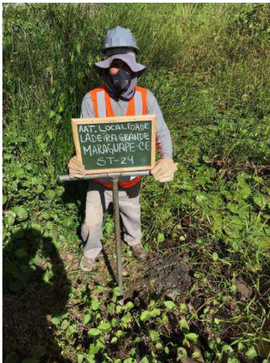
Instalação do furo ST-24
