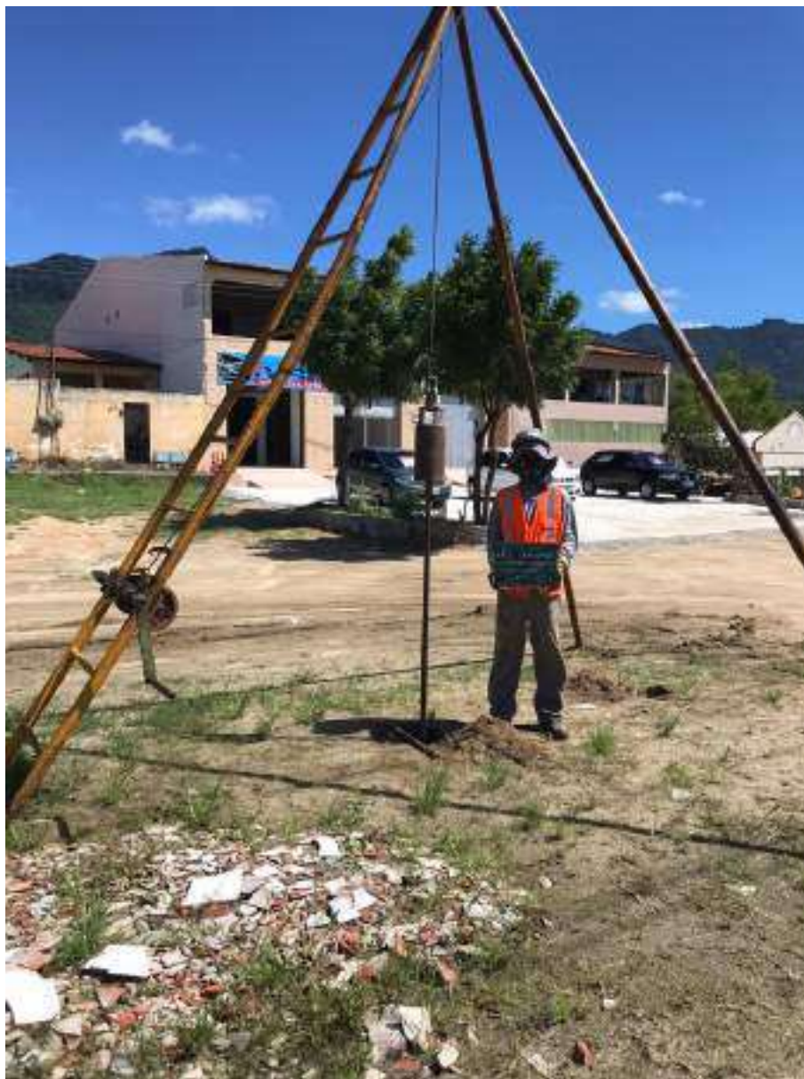
Instalação do furo SP-02 A
