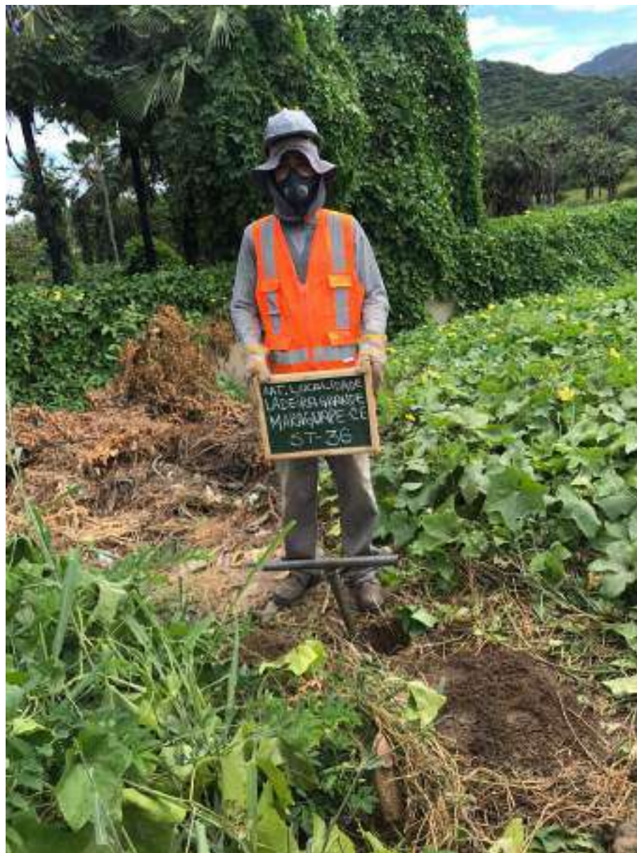
Instalação do furo ST-36
