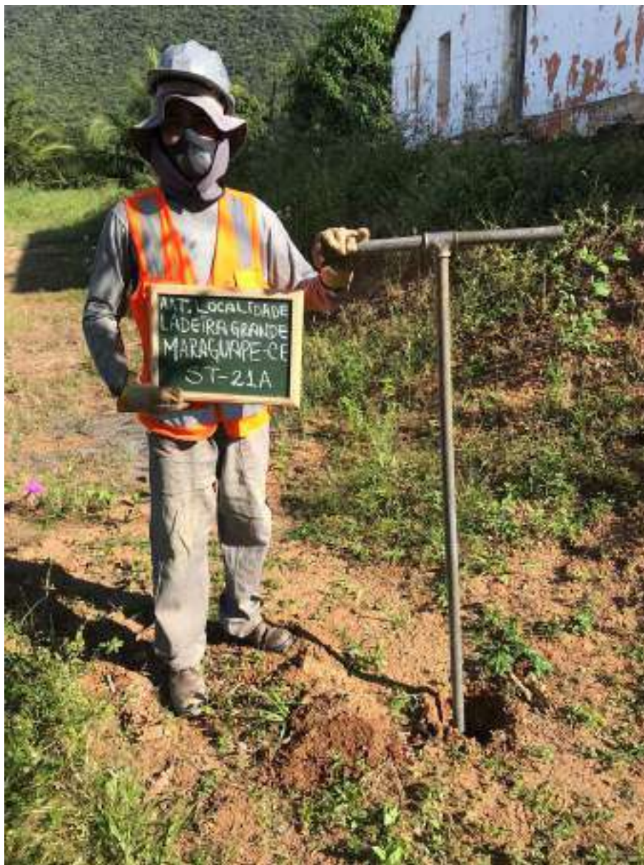
Instalação do furo ST-21 A
