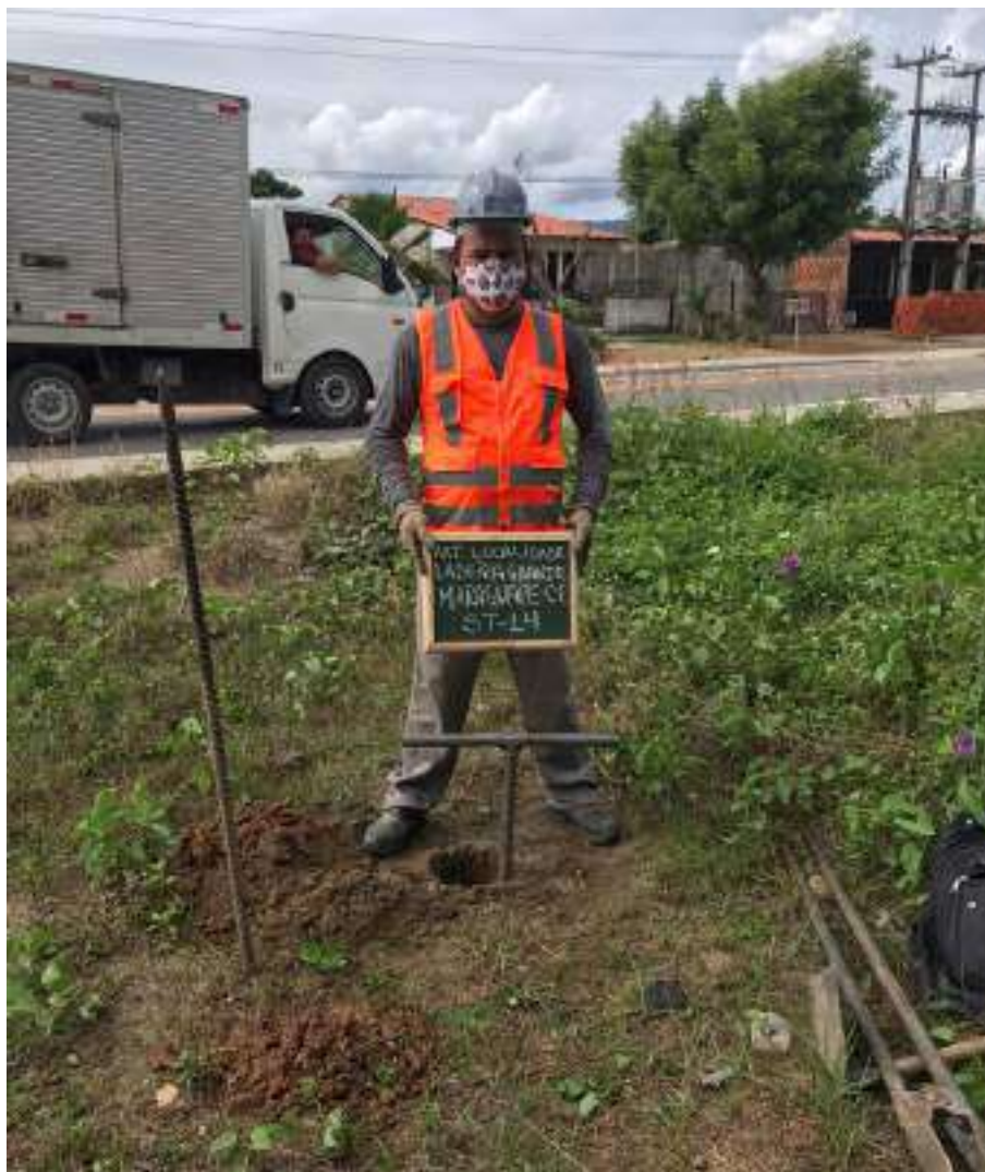
Instalação do furo ST-14
