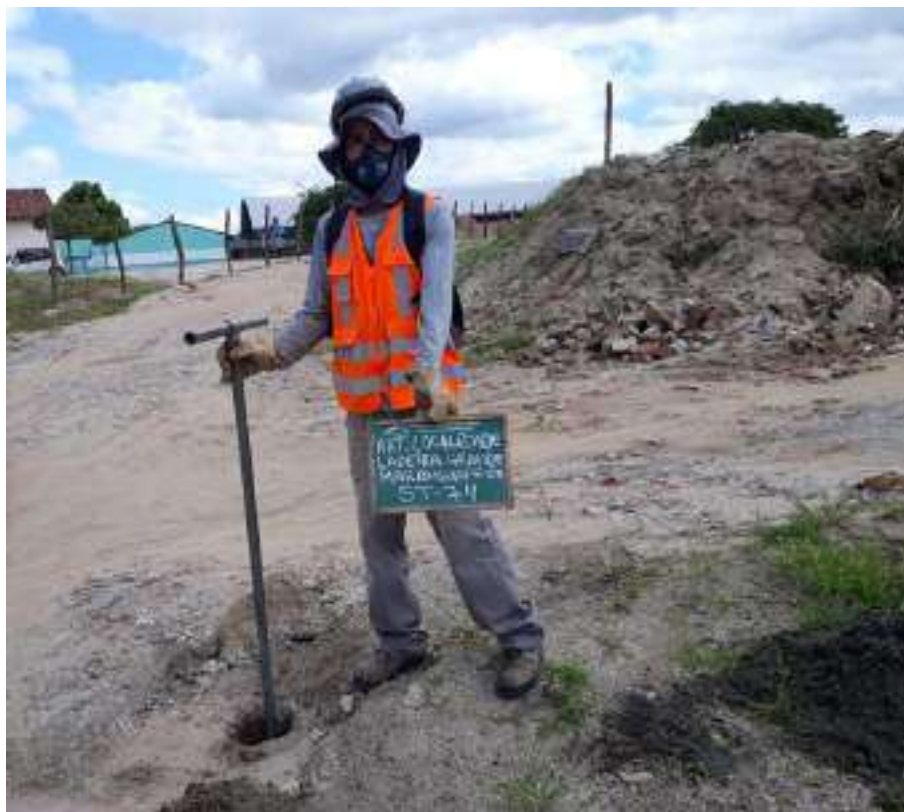
Instalação do furo ST-74
