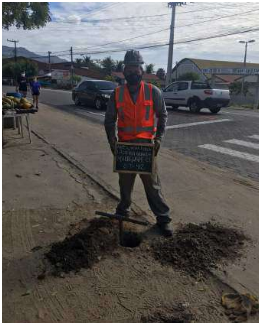
Instalação do furo ST-42
