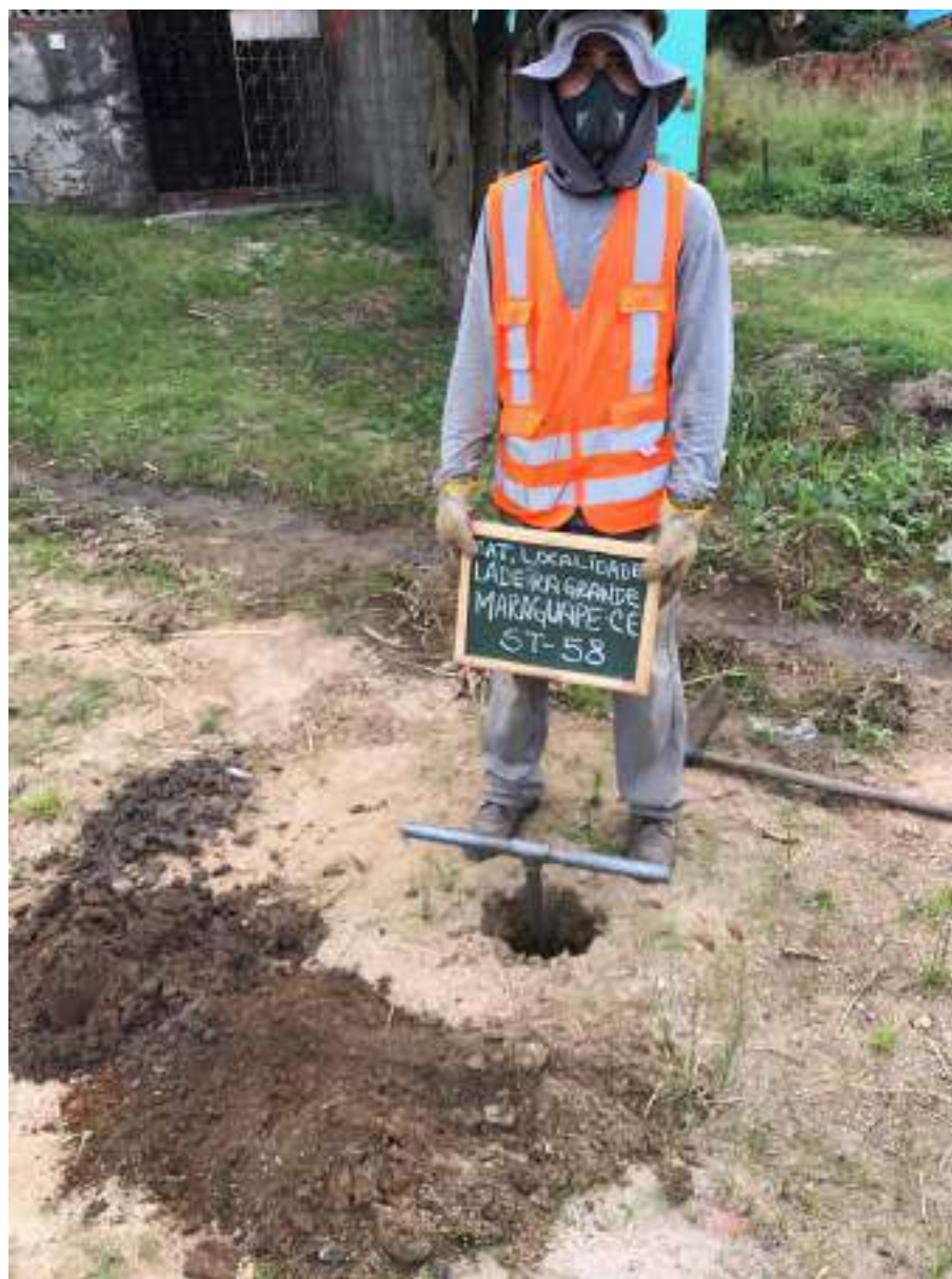
Instalação do furo ST-58
