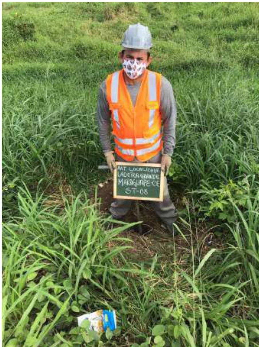
Instalação do furo ST-08
