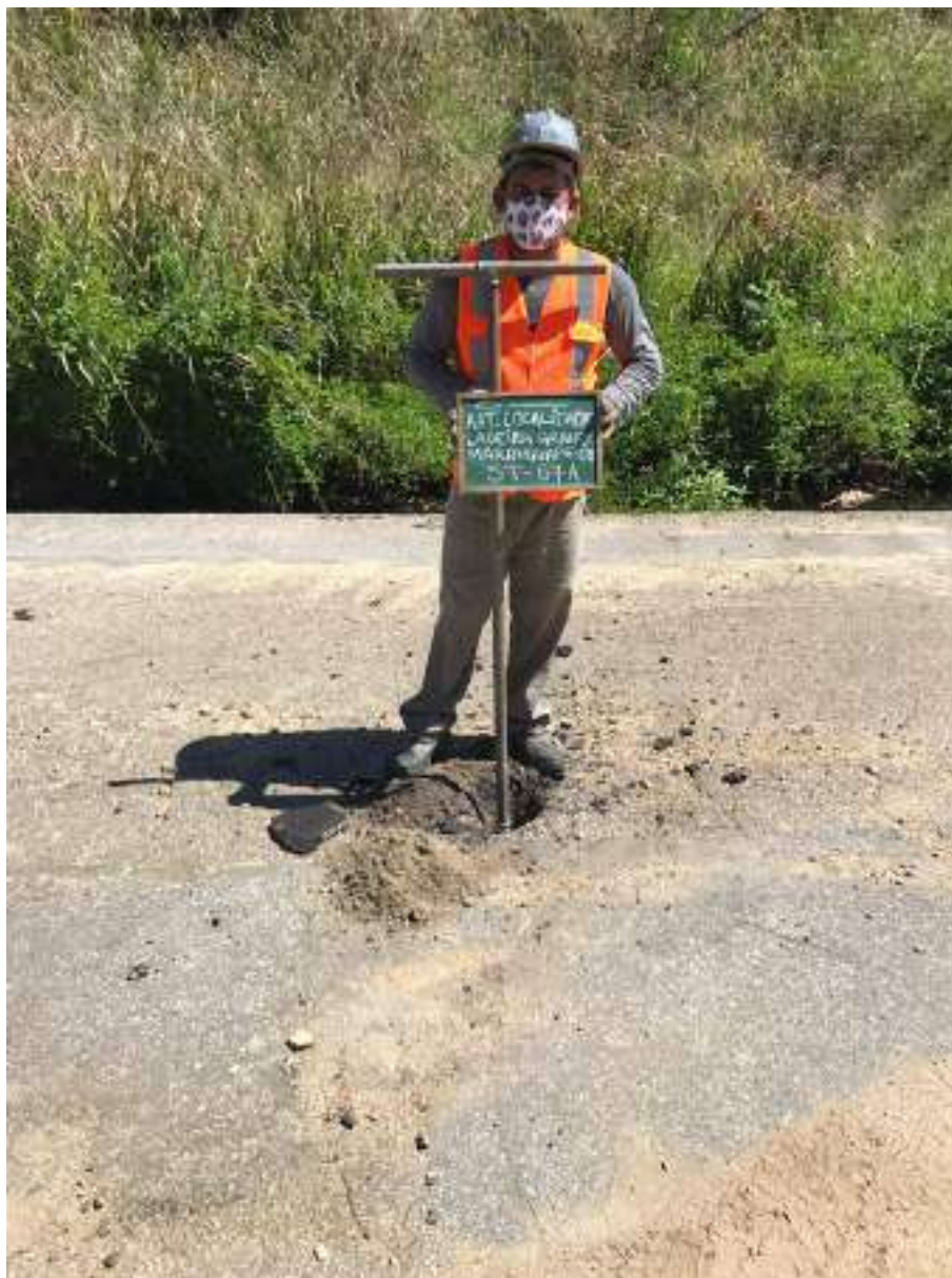
Instalação do furo ST-67 A
