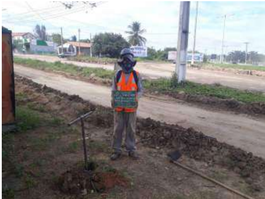
Instalação do furo ST-01
