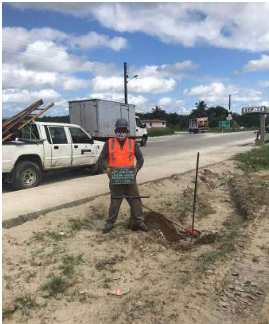
Instalação do furo ST-75
