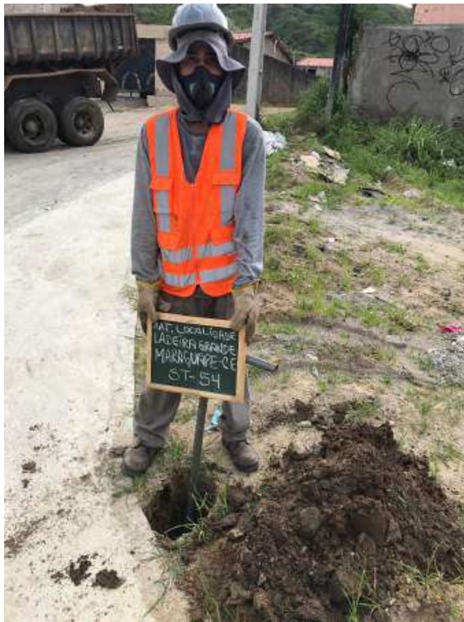
Instalação do furo ST-54
