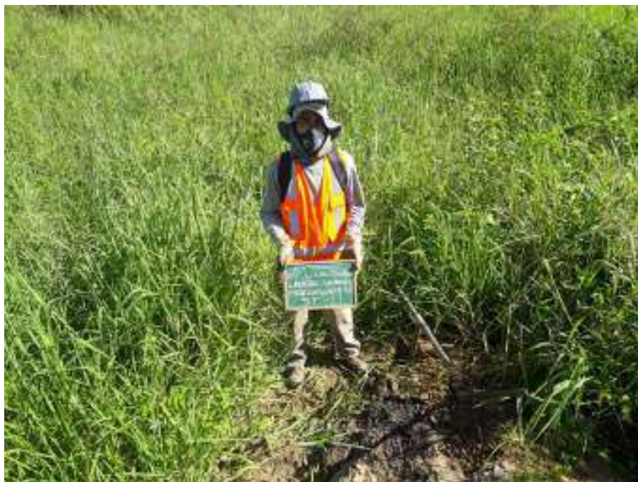
Instalação do furo ST-11
