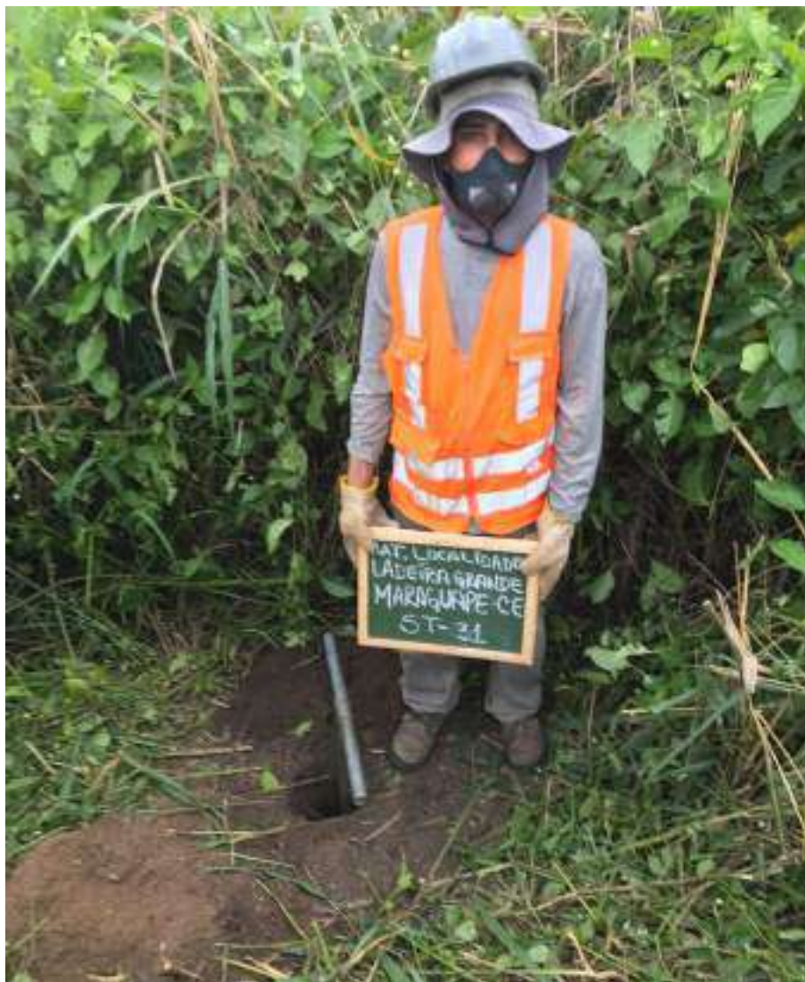
Instalação do furo ST-31
