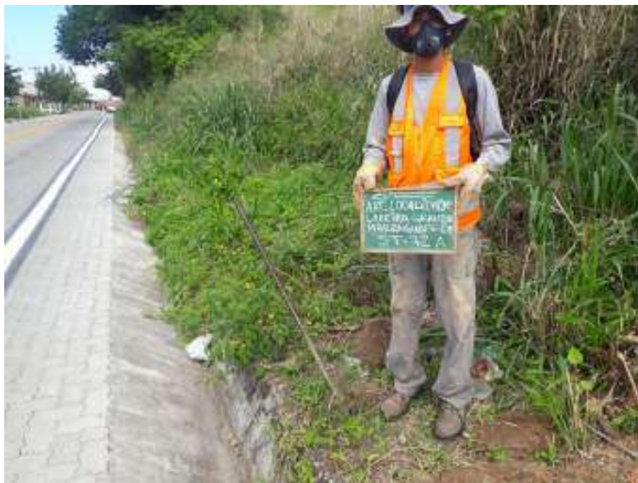
Instalação do furo ST-72 A
