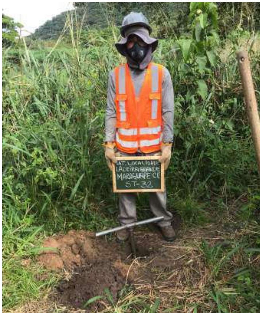
Instalação do furo ST-32
