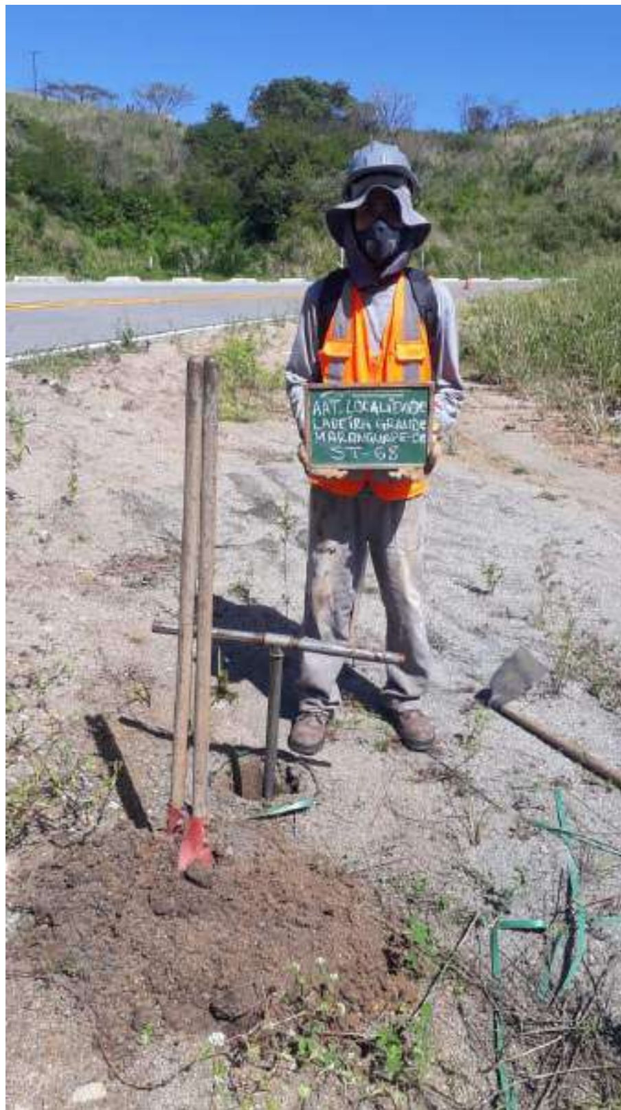
Instalação do furo ST-68
