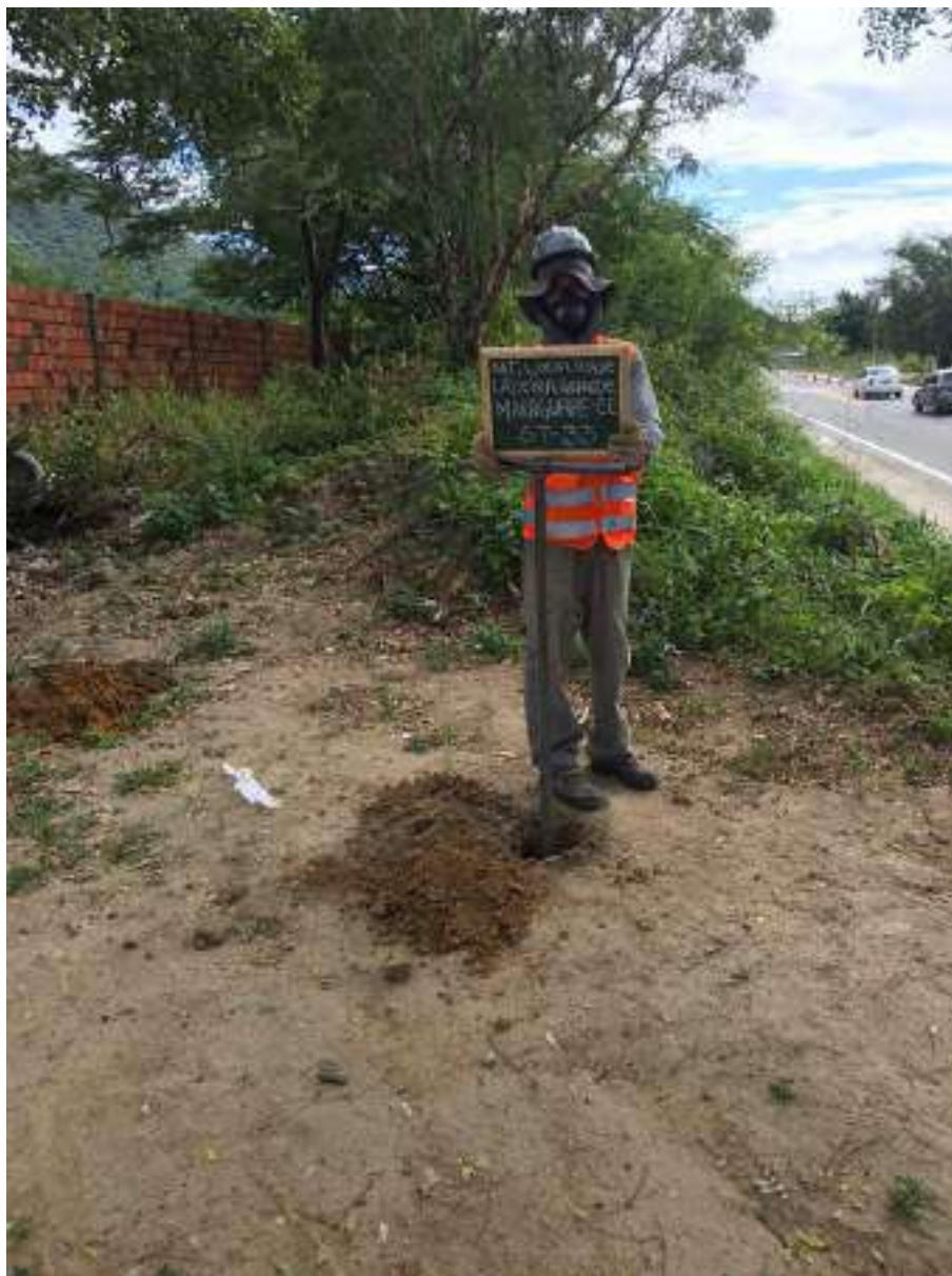
Instalação do furo ST-33
