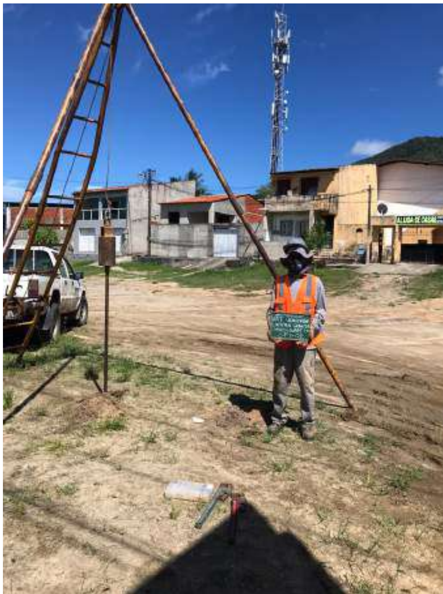
Instalação do furo SP-02
