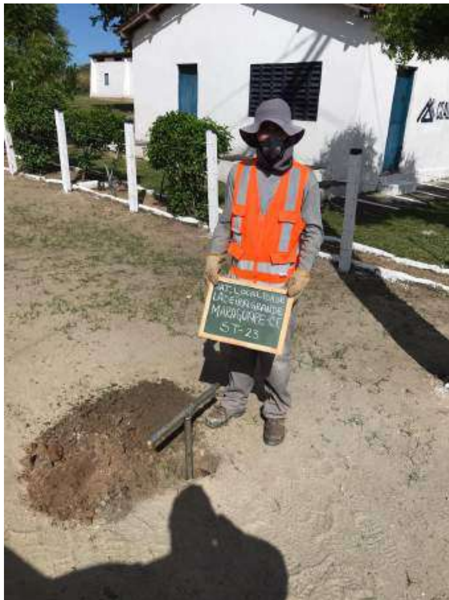
Instalação do furo ST-23
