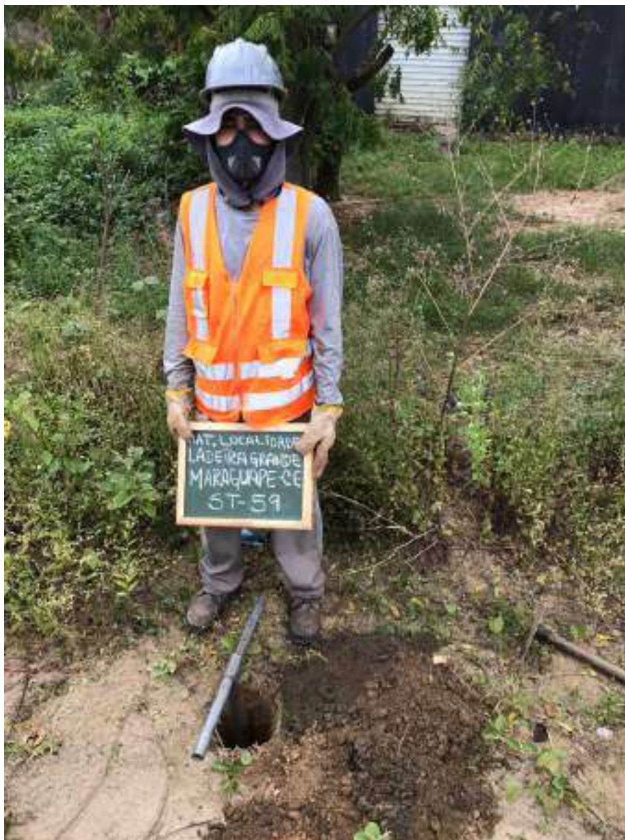
Instalação do furo ST-59
