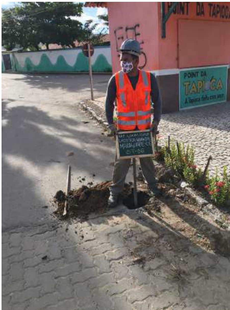
Instalação do furo ST-06
