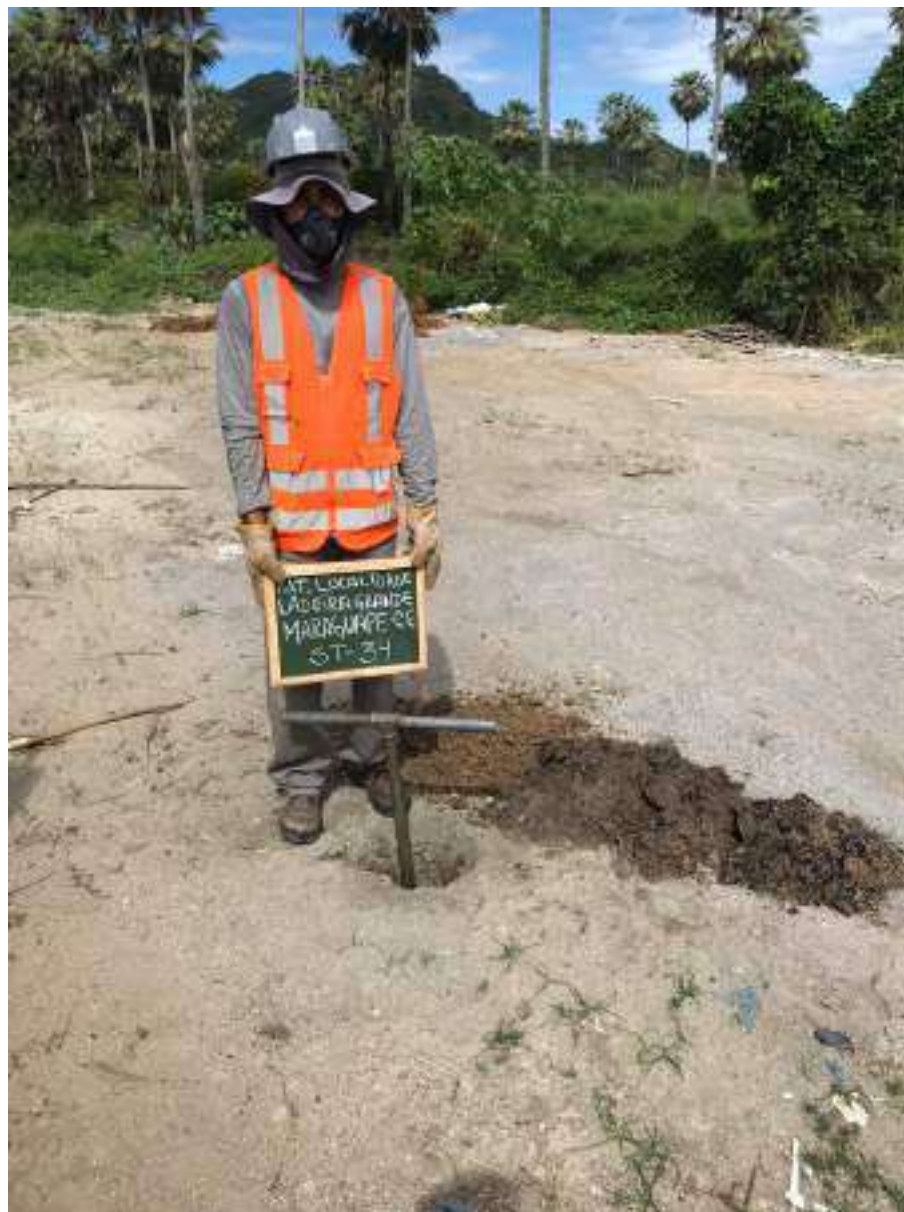
Instalação do furo ST-34
