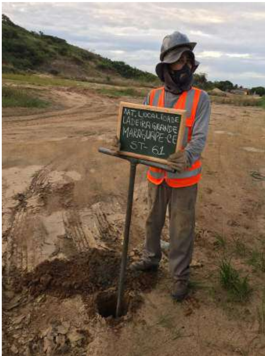
Instalação do furo ST-61
