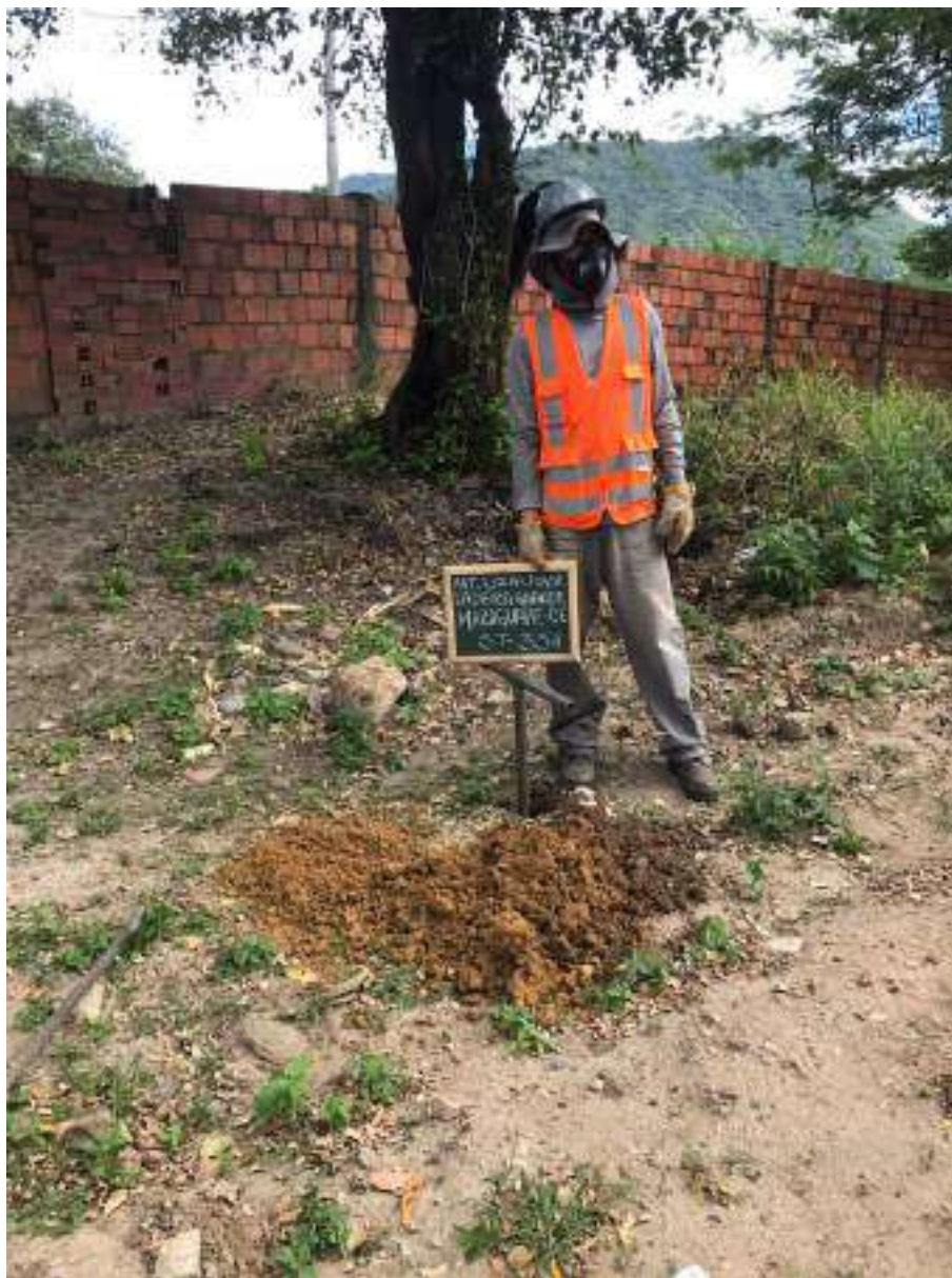
Instalação do furo ST-33 A
