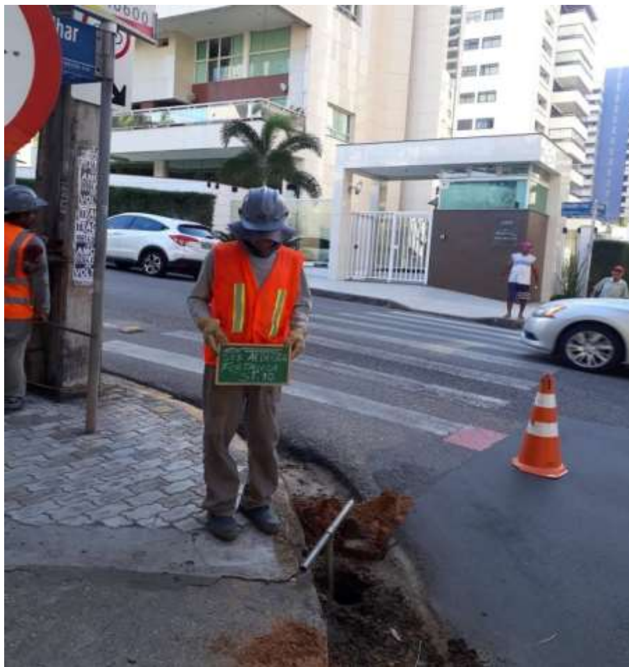
Instalação do furo ST-10
