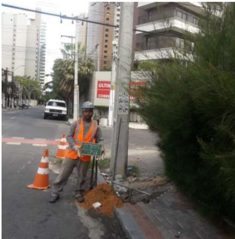
Instalação do furo ST-13
