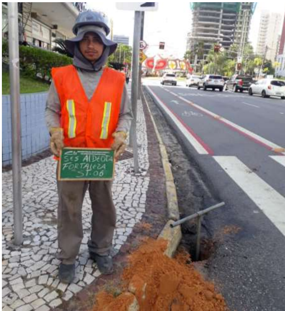
Instalação do furo ST-06
