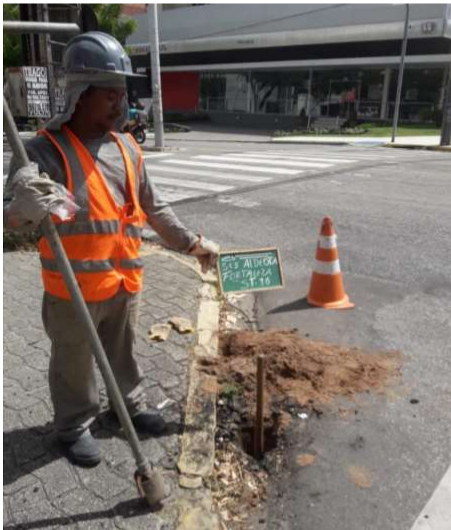
Instalação do furo ST-16
