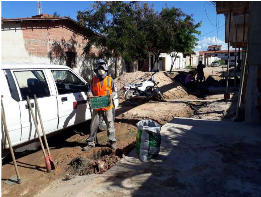
Instalação do furo ST-04
