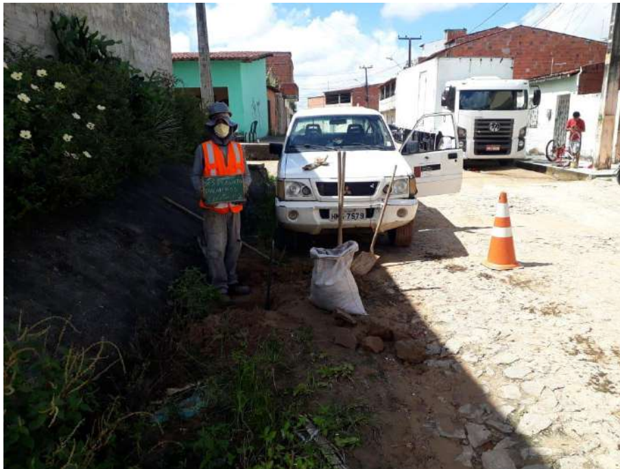
Instalação do furo ST-02
