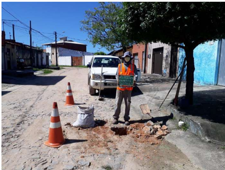
Instalação do furo ST-01 A
