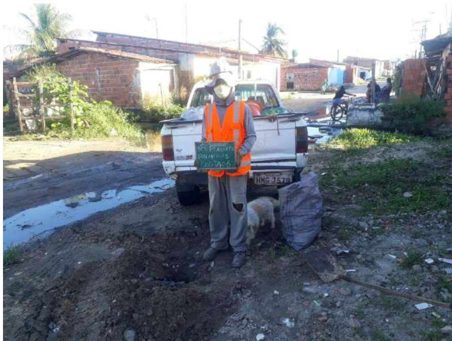
Instalação do furo ST-06
