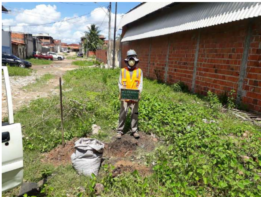
Instalação do furo ST-03
