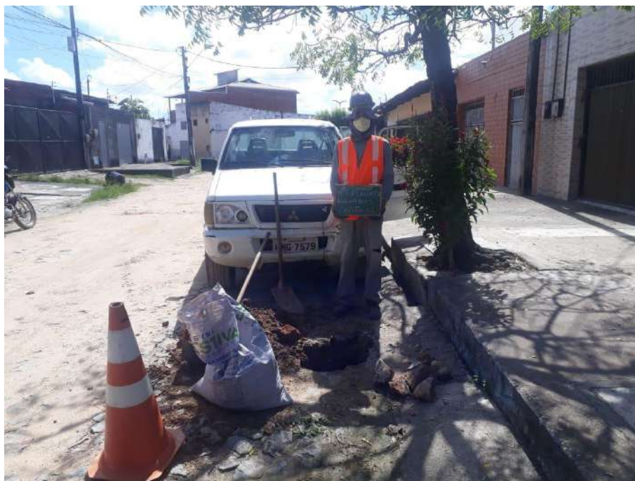
Instalação do furo ST-01
