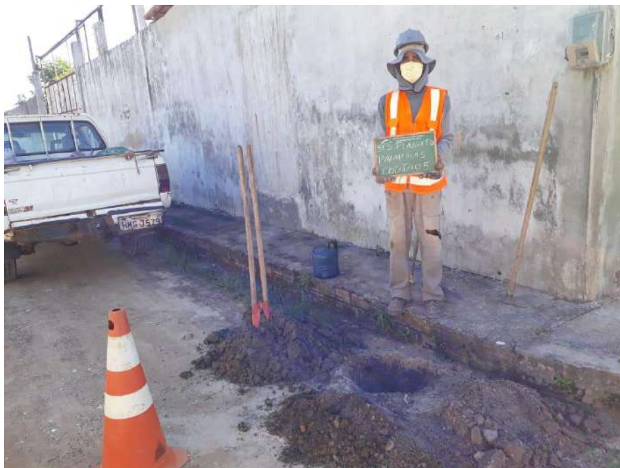
Instalação do furo ST-05
