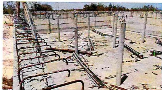
**Foto 11: Célula do reservatório 1 com diversas armaduras expostas devido às obras inacabadas**
