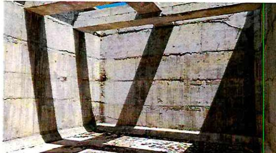
**Foto 07: Parte do decanto lamelar inacabado devido à paralisação das obras com diversas armaduras expostas**
