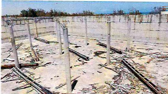
**Foto 12: Armadura oxidada do reservatório 1**
