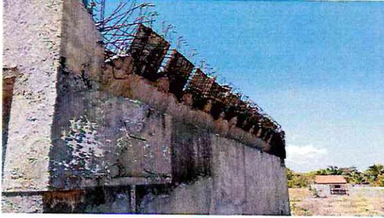
**Foto 08: Parte do decanto lamelar inacabado devido à paralisação das obras com diversas armaduras expostas**
