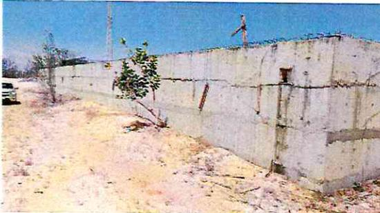
**Foto 10: Célula do reservatório 1 com diversas armaduras expostas devido às obras inacabadas**
