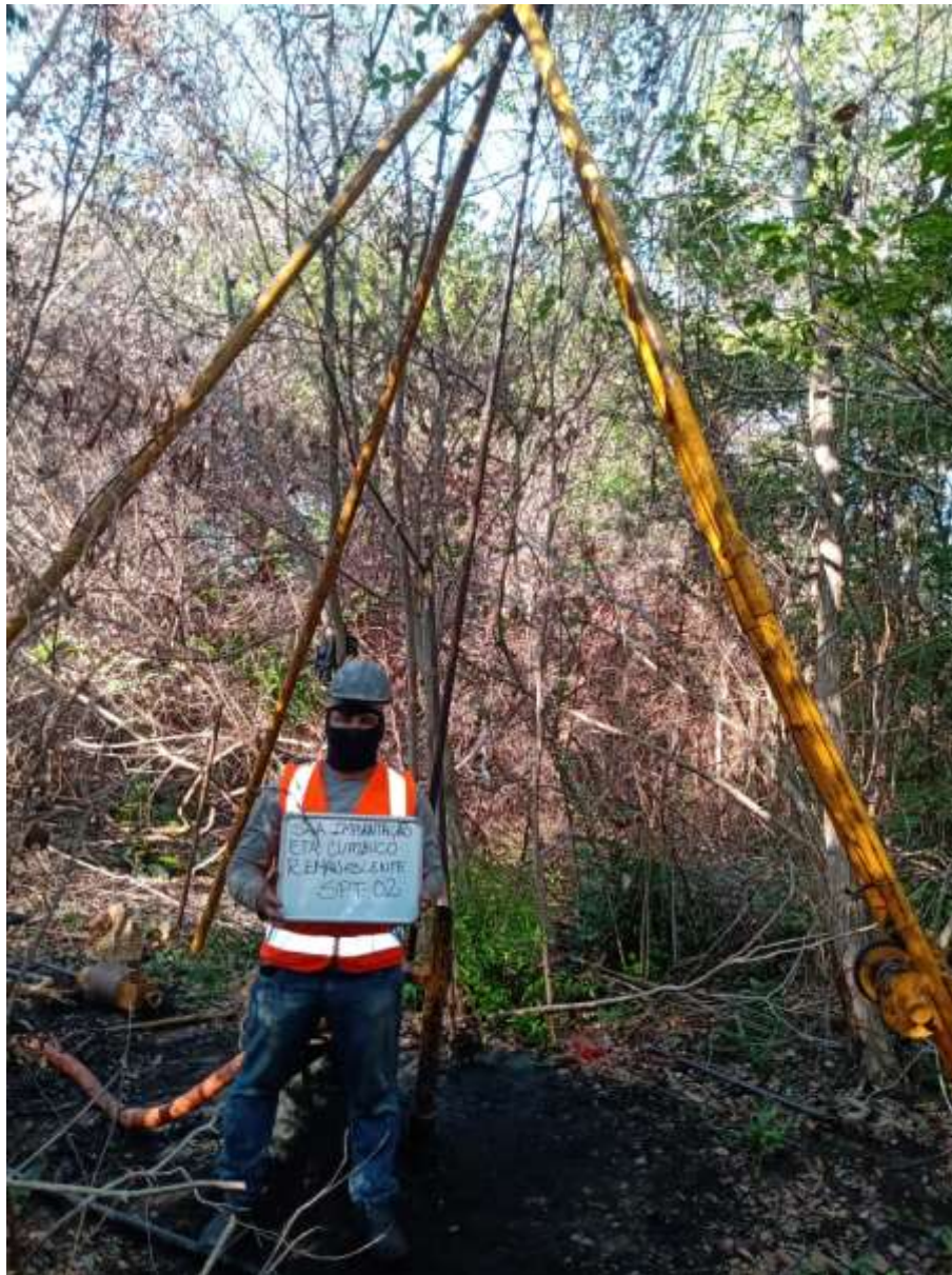
Instalação do furo SP-02
