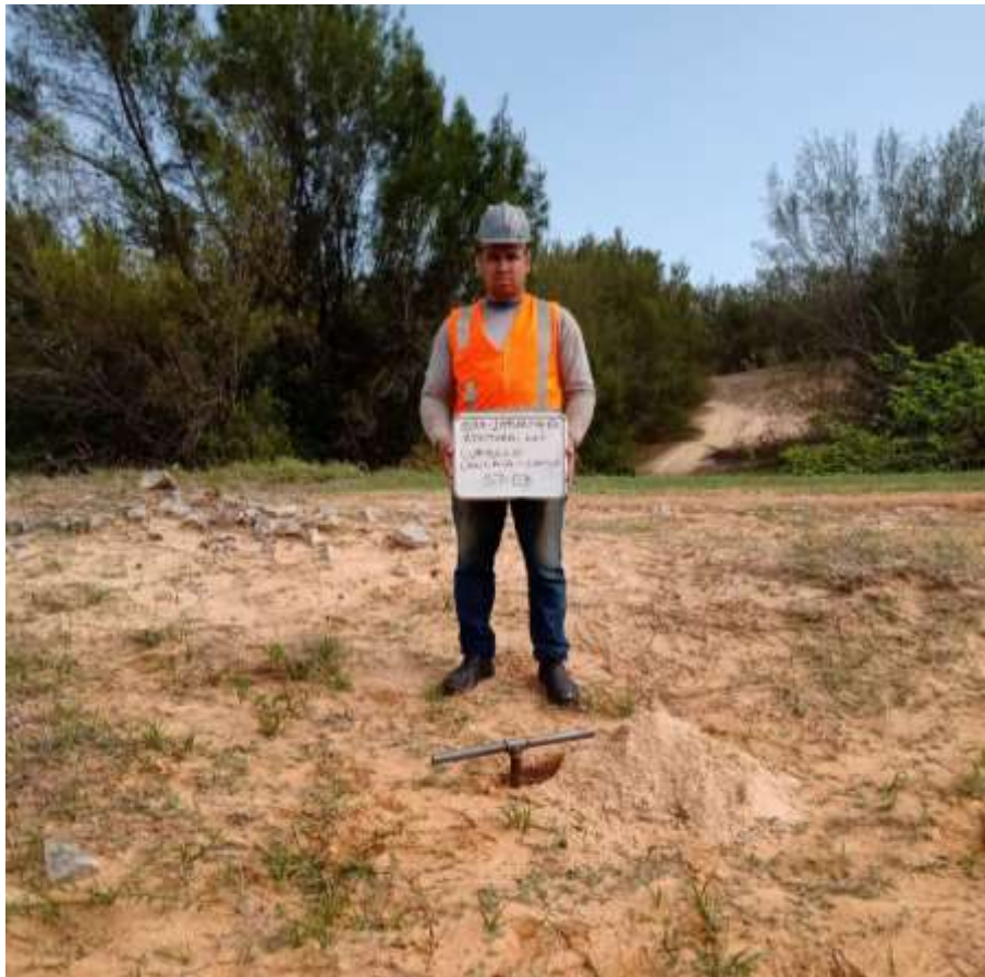
Instalação do furo ST-03
