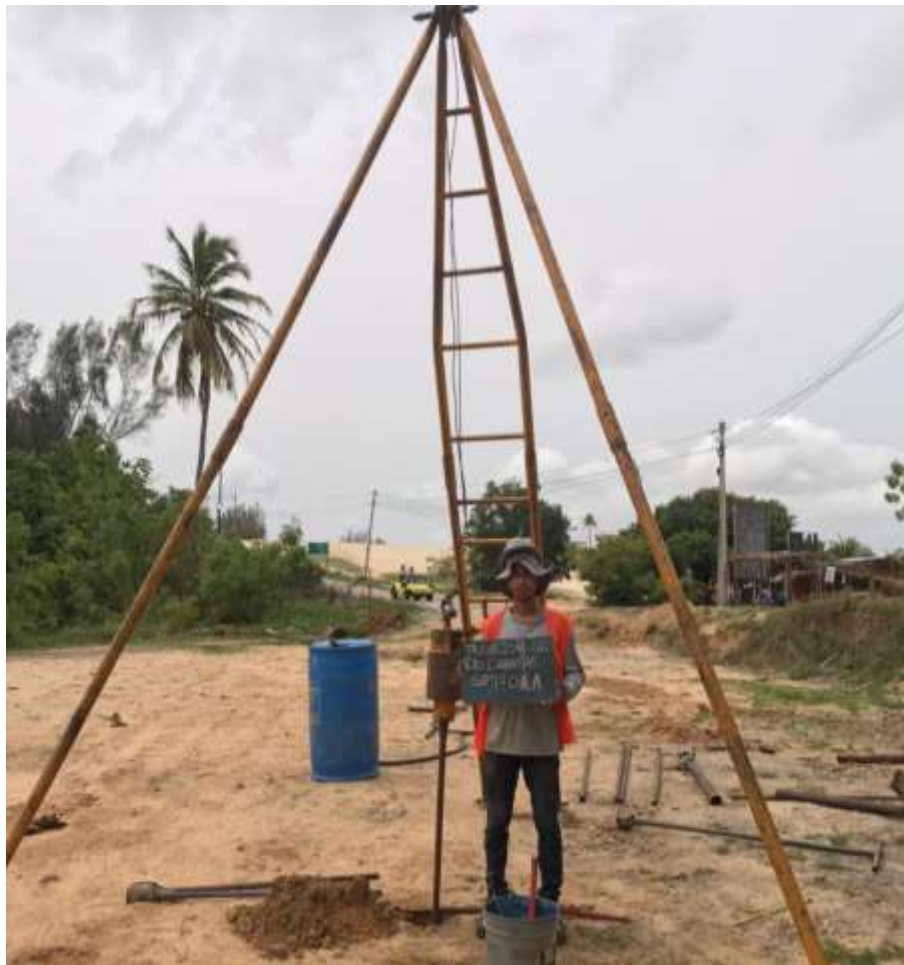
Instalação do furo SP-01 A
