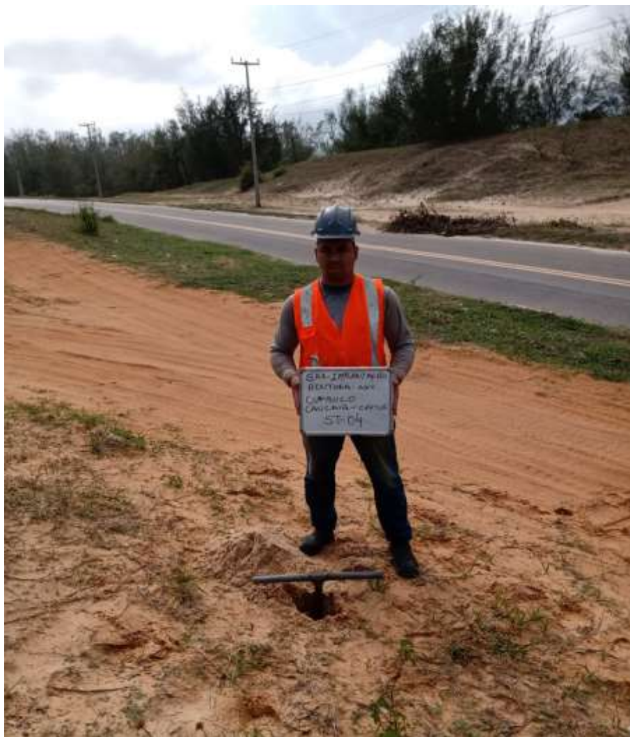
Instalação do furo ST-04
