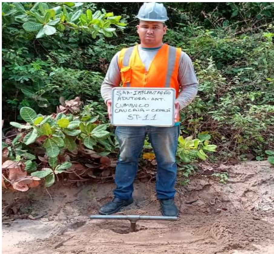
Instalação do furo ST-11
