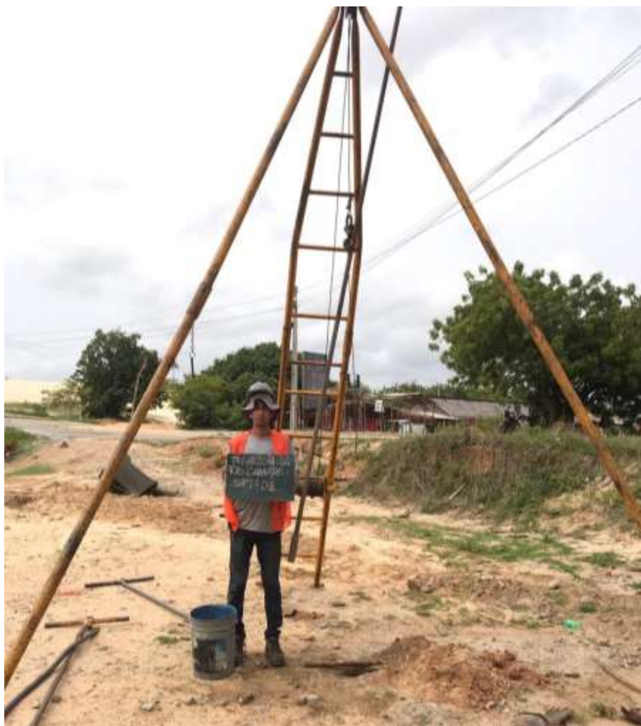
Instalação do furo SP-01
