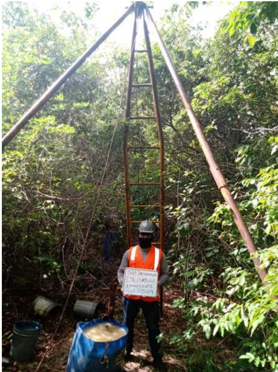
Instalação do furo SP-04
