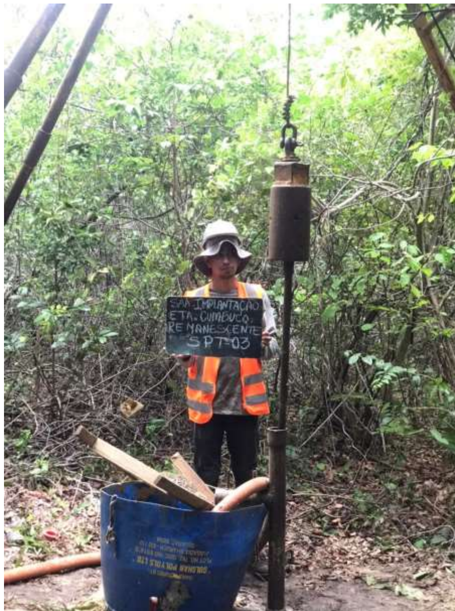
Instalação do furo SP-03
