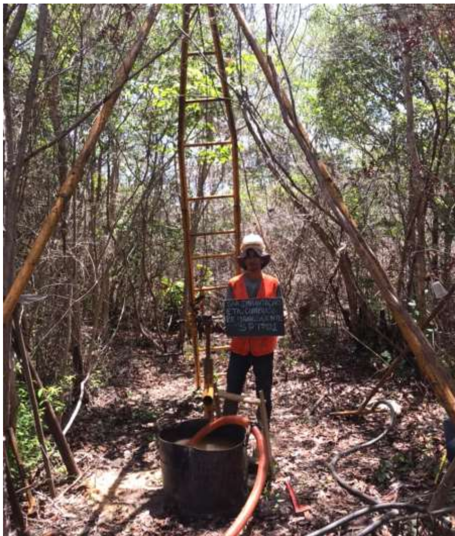
Instalação do furo SP-01
