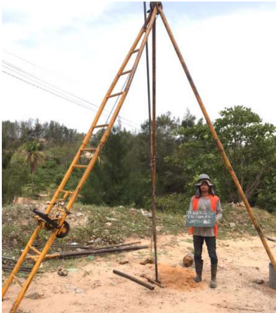
Instalação do furo SP-02
