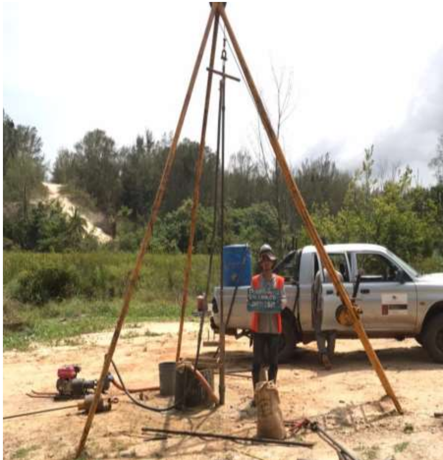
Instalação do furo SP-01 B
