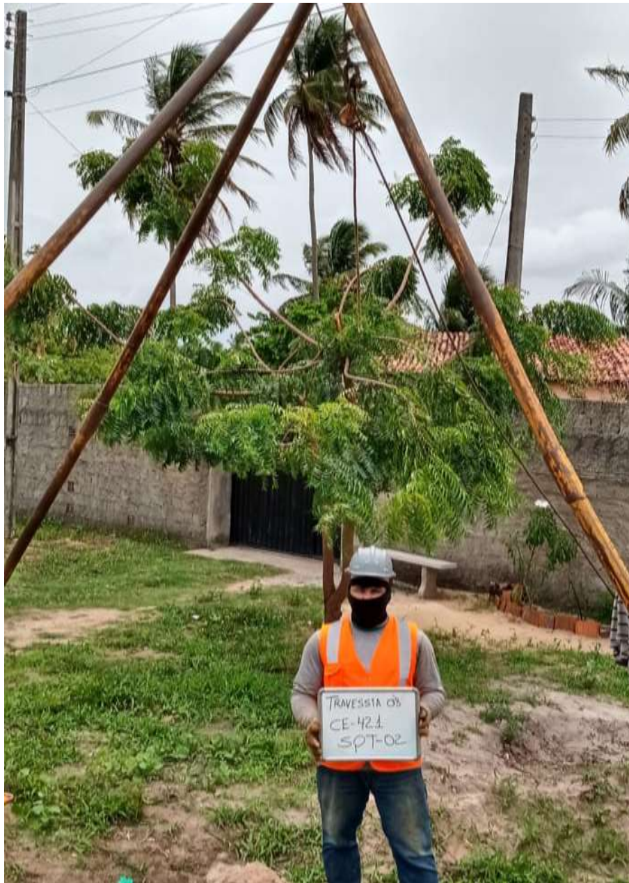
Instalação do furo SP-02
