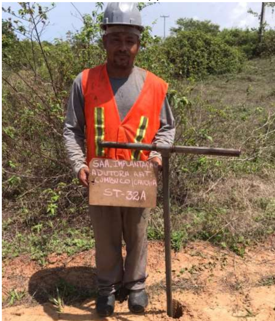
Instalação do furo ST-32 (A)
