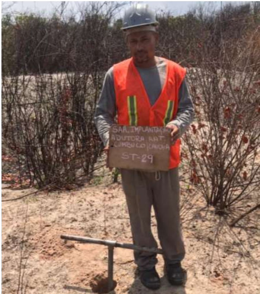
Instalação do furo ST-29
