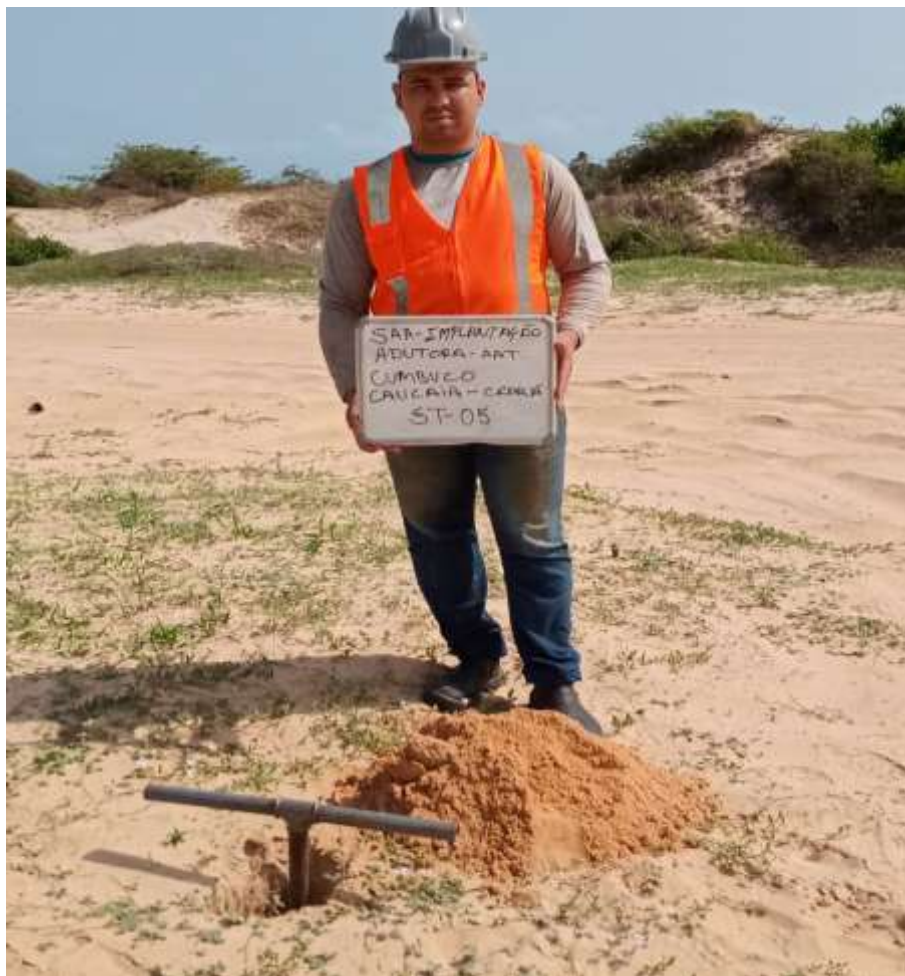
Instalação do furo ST-05
