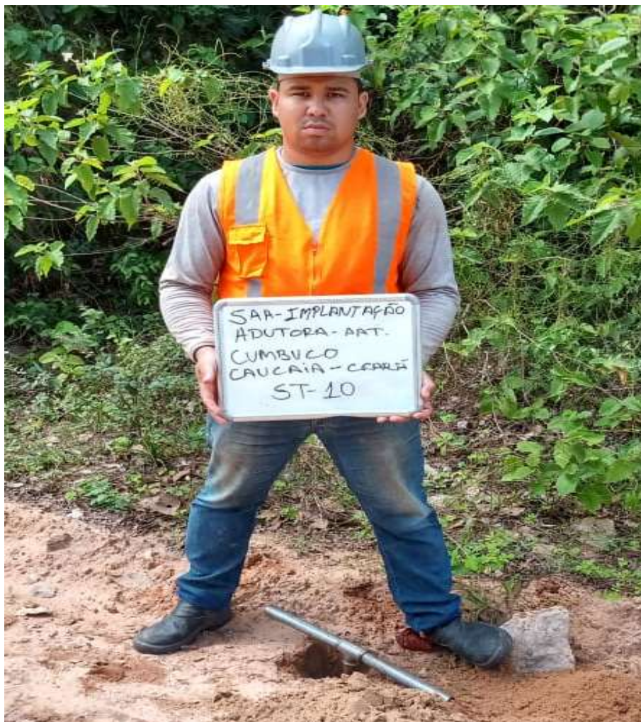
Instalação do furo ST-10
