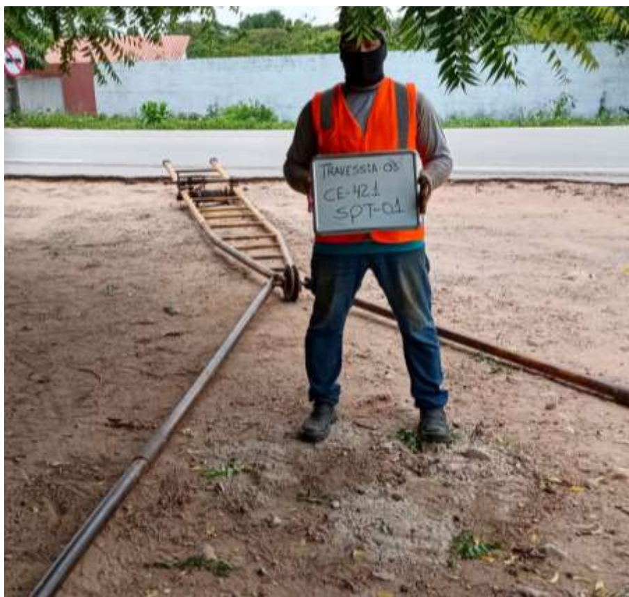
Instalação do furo SP-01
