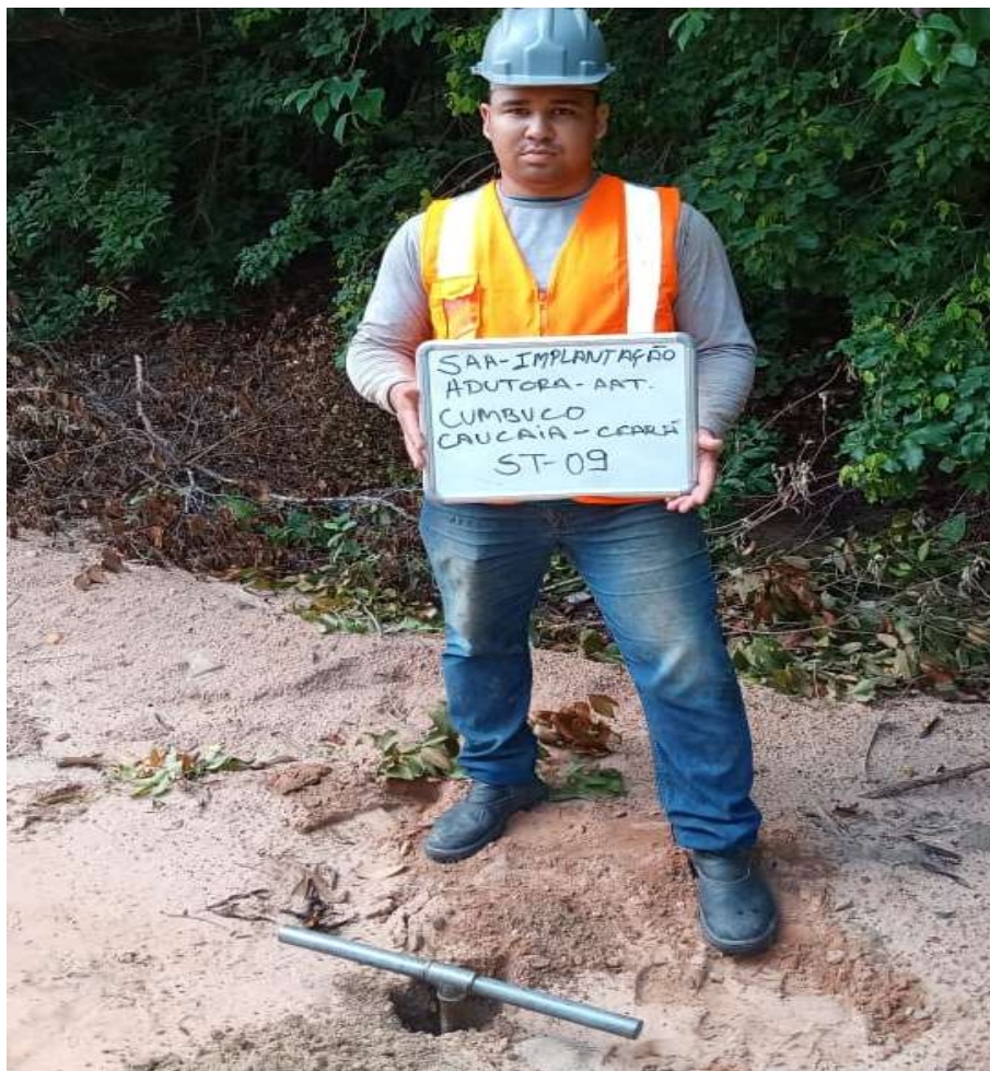
Instalação do furo ST-09
