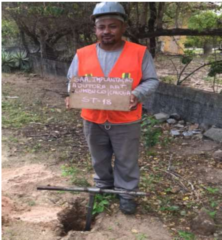
Instalação do furo ST-18
