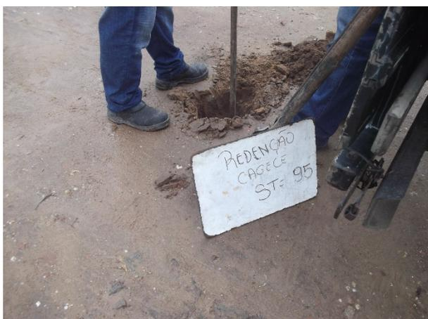
**Foto 09** - Identificação do furo de sondagem a trado ST-95.
