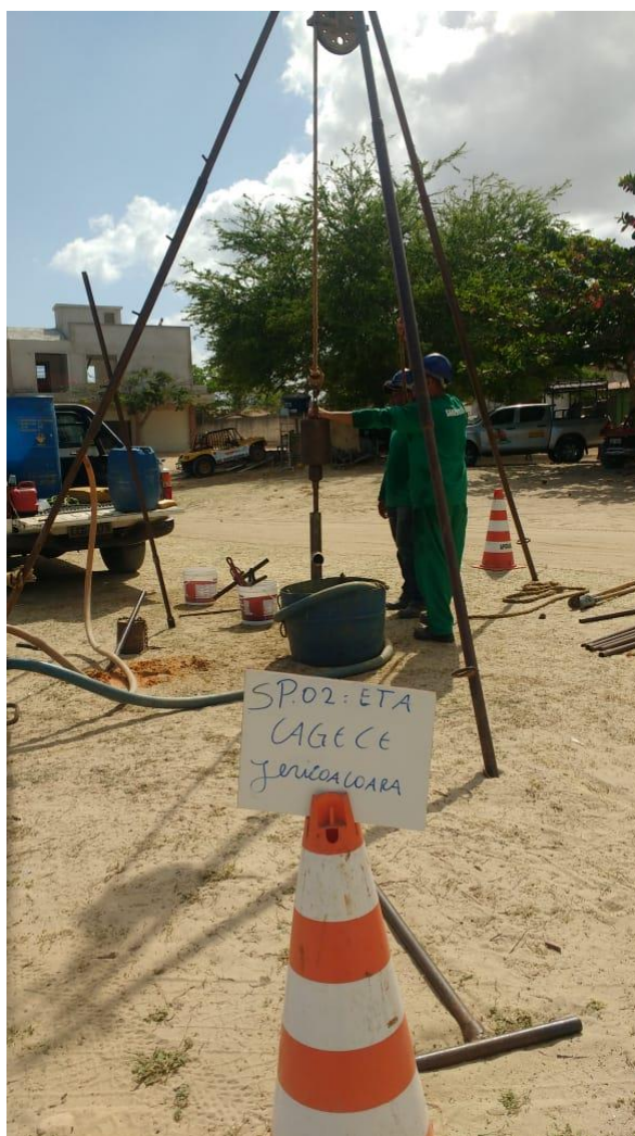
FOTO 05: Identificação da realização do furo SP-02 da ETA.
