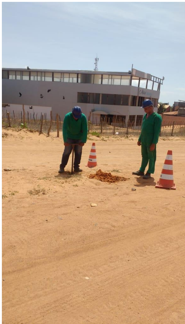
FOTO 01: Detalhe da realização do furo ST-03.
