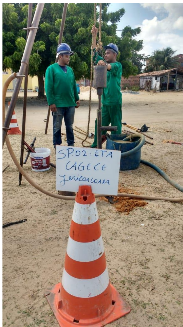
FOTO 06: Identificação da realização do furo SP-02 da ETA.
