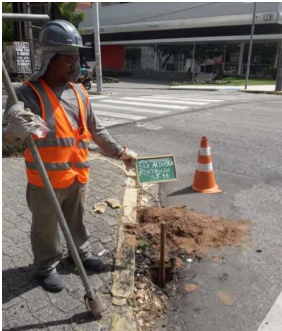
Instalação do furo ST-16
