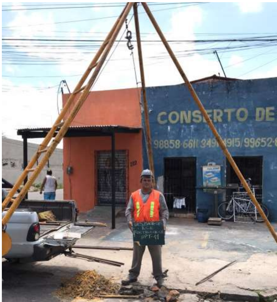
Instalação do furo SP-11
