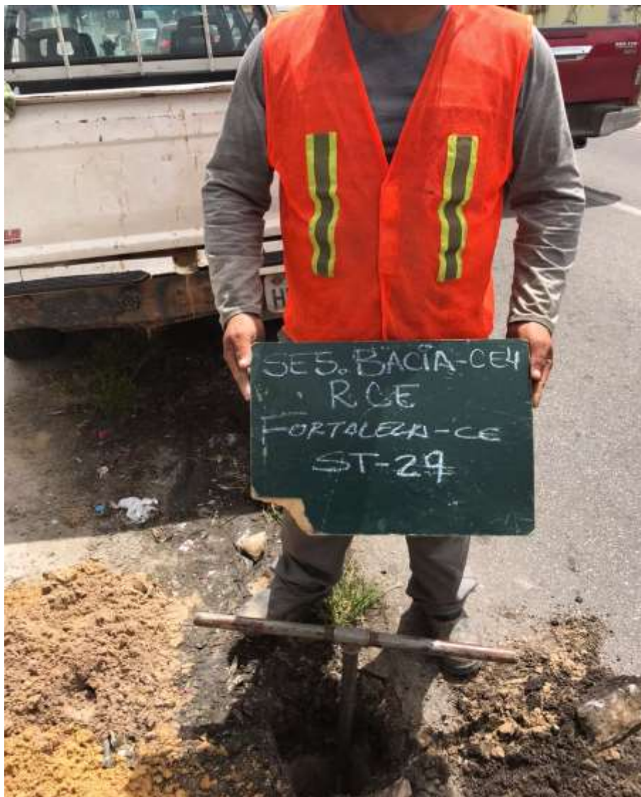
Instalação do furo ST-29
