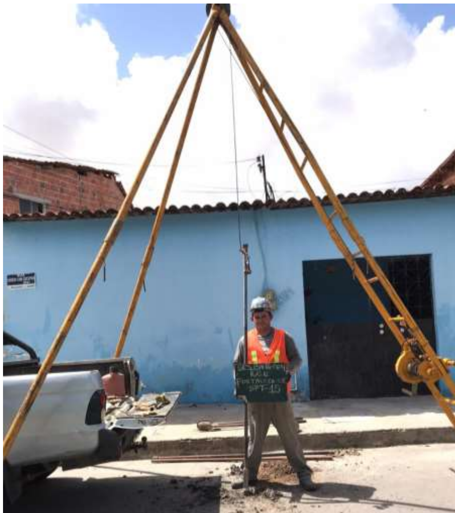
Instalação do furo SP-15
