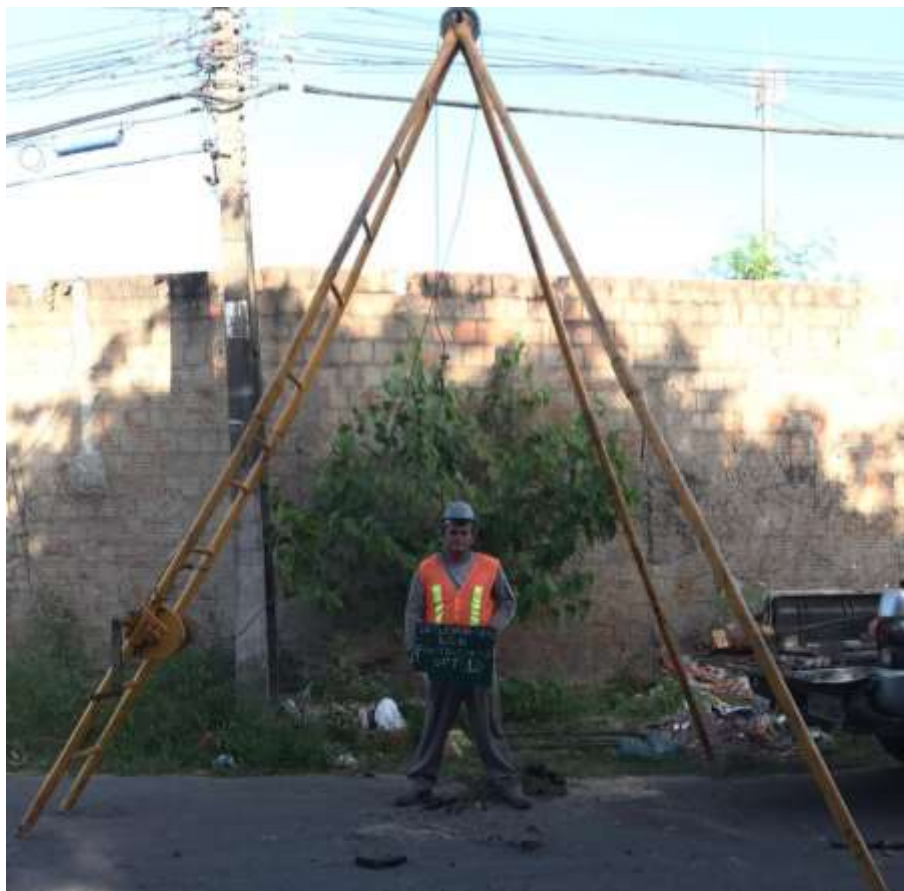
Instalação do furo SP-13
