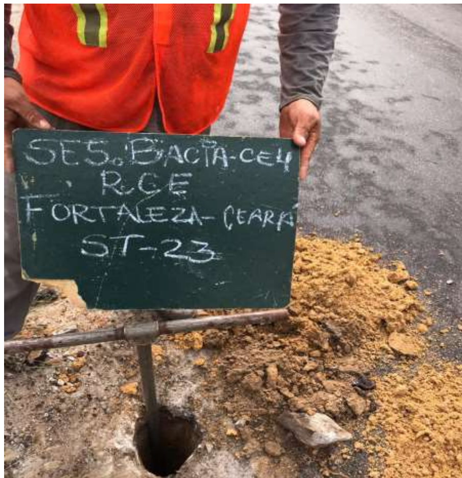
Instalação do furo ST-23
