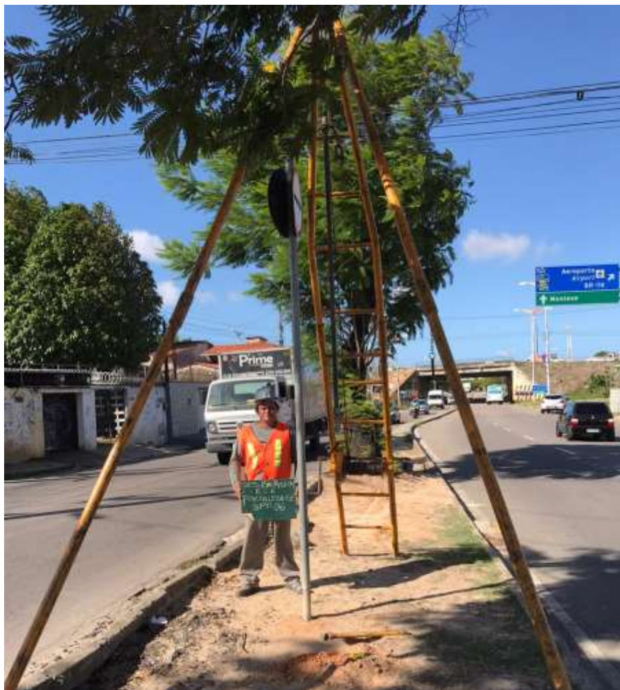
Instalação do furo SP-06
