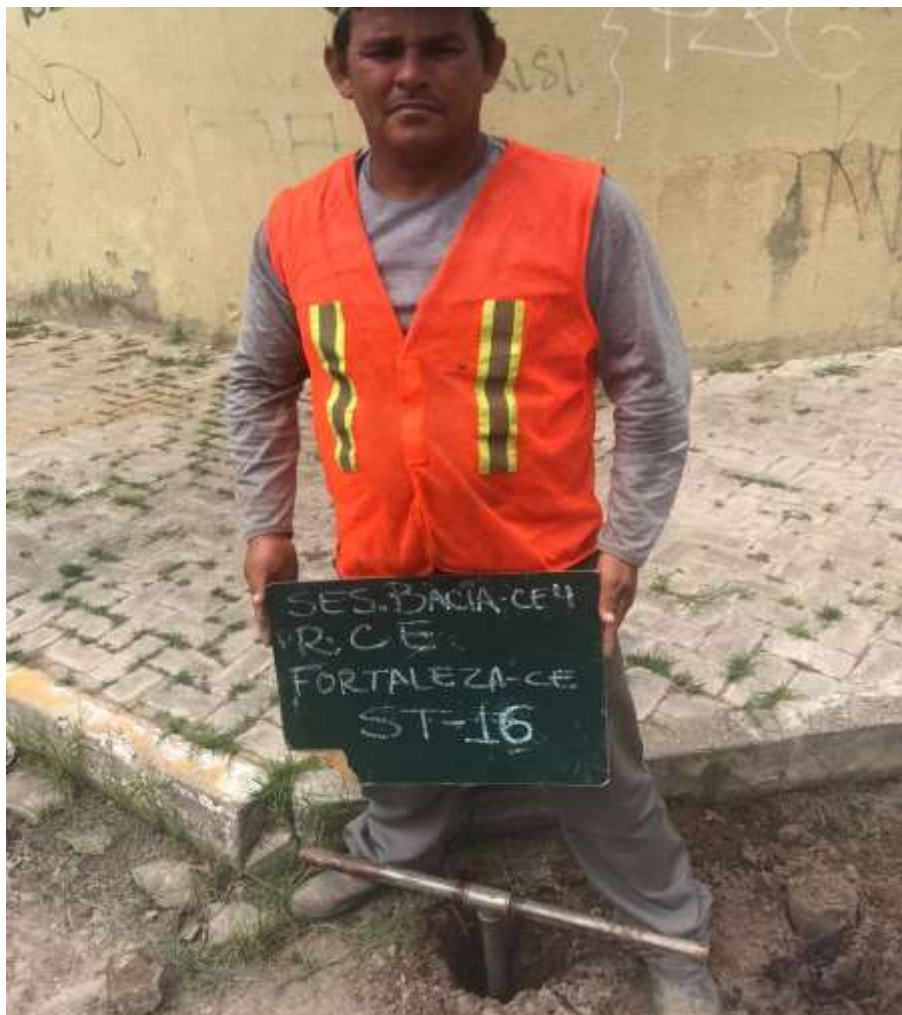
Instalação do furo ST-16
