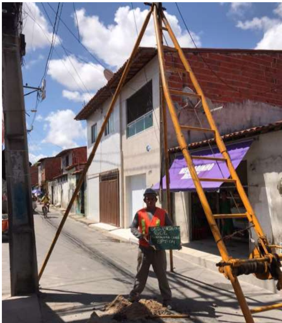
Instalação do furo SP-04
