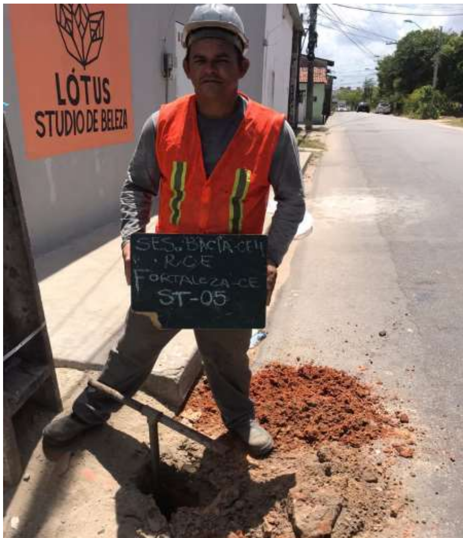
Instalação do furo ST-05
