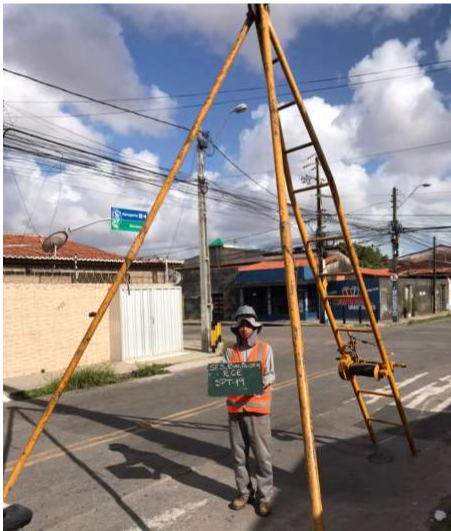
Instalação do furo SP-19
