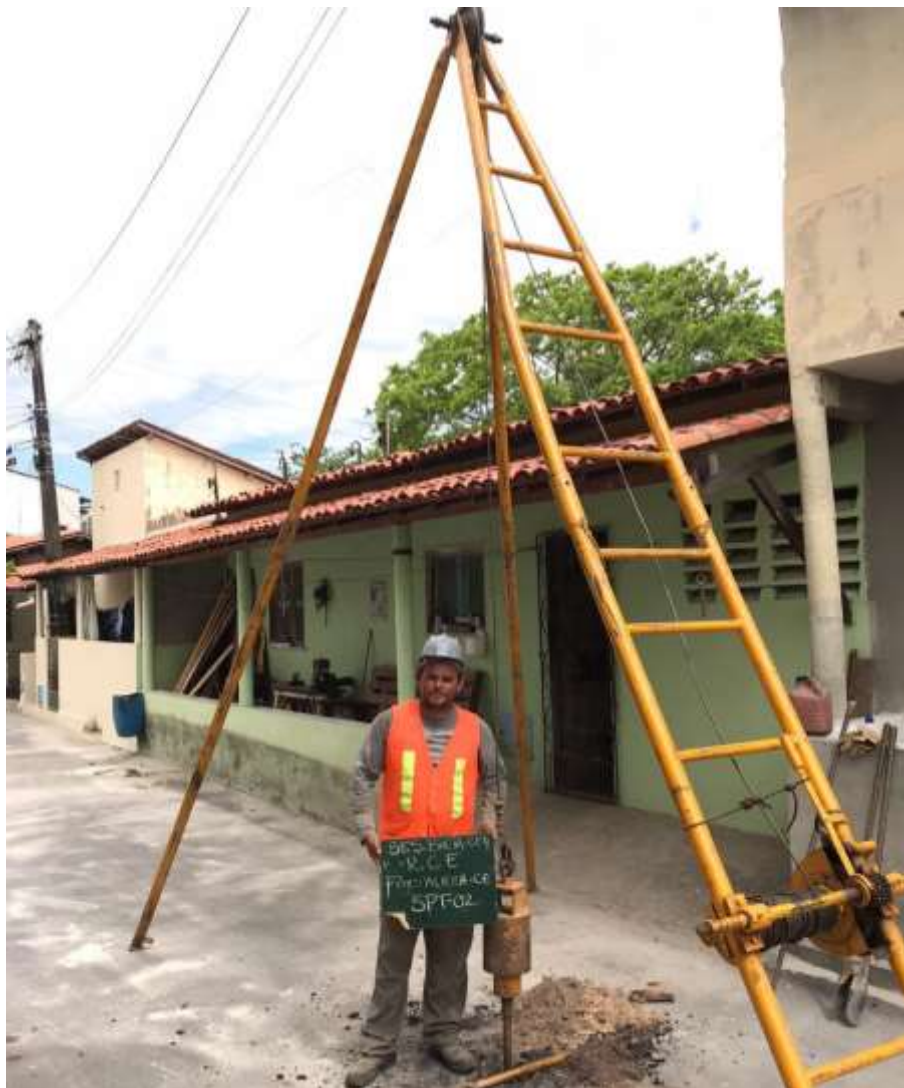
Instalação do furo SP-02
