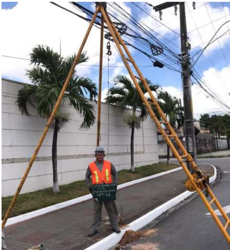
Instalação do furo SP-23
