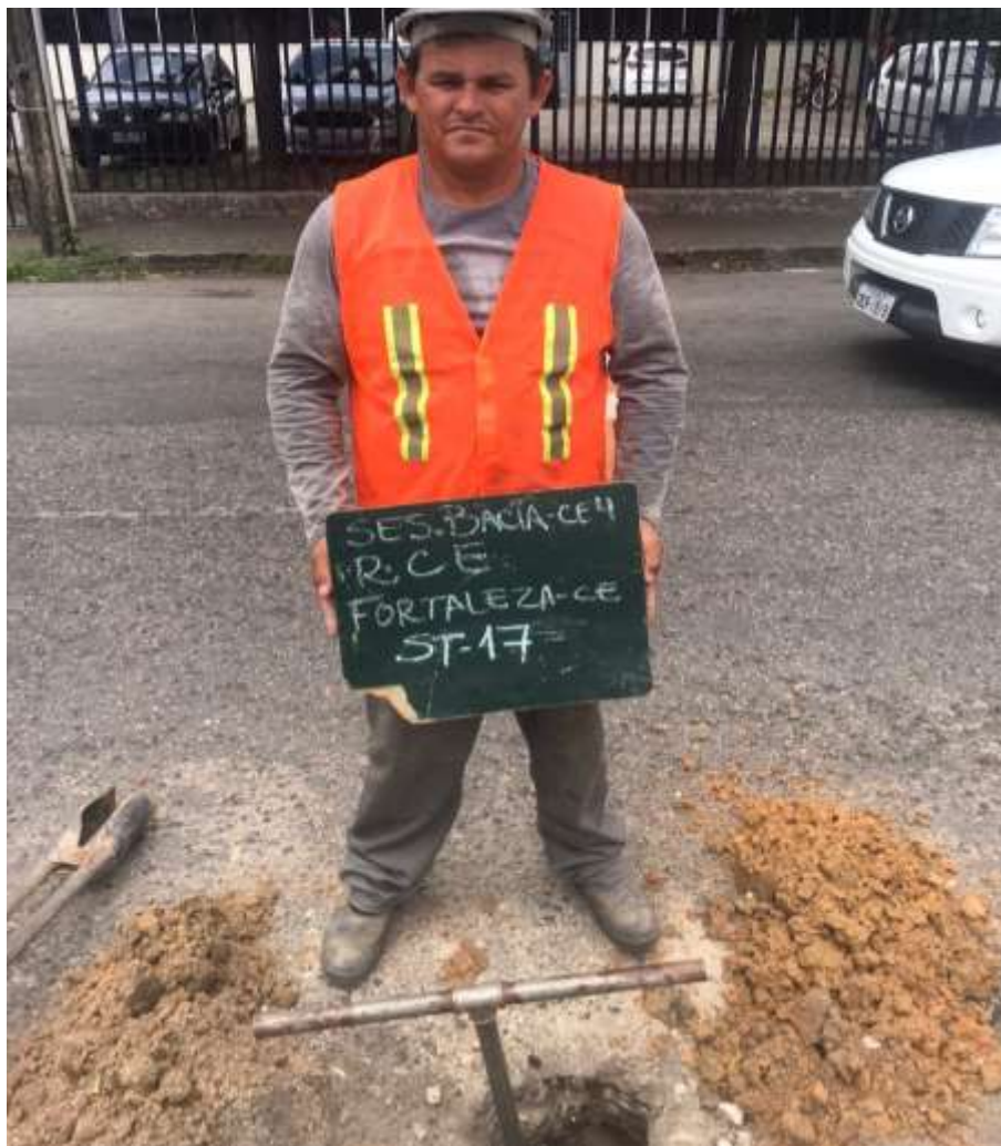
Instalação do furo ST-17
