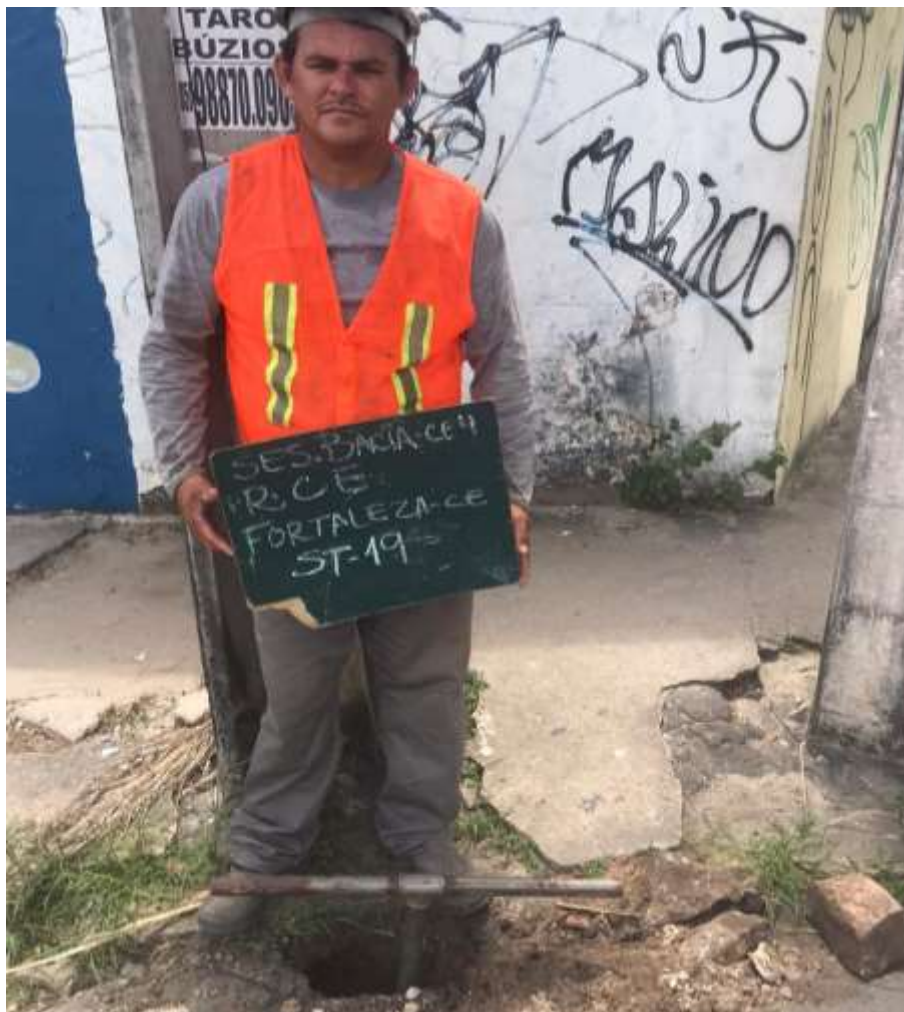
Instalação do furo ST-19
