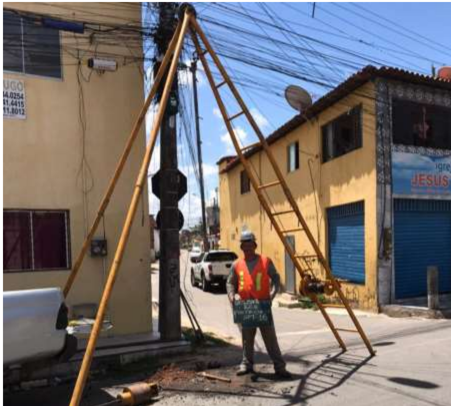
Instalação do furo SP-16
