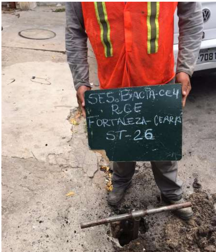
Instalação do furo ST-26
