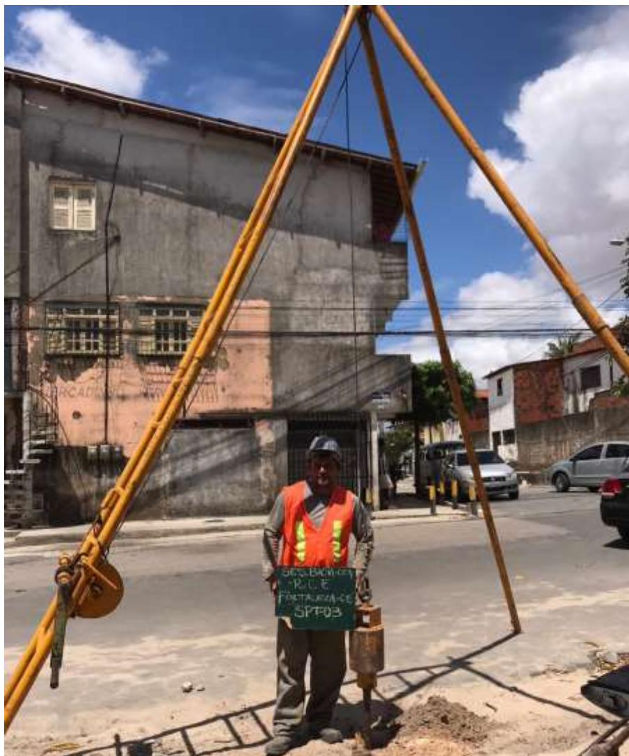
Instalação do furo SP-03
