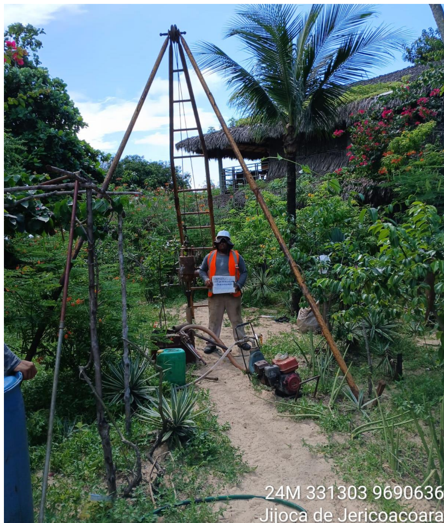
Instalação do furo SPT-01
