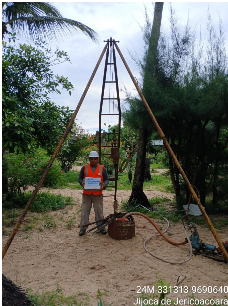
Instalação do furo SPT-02
