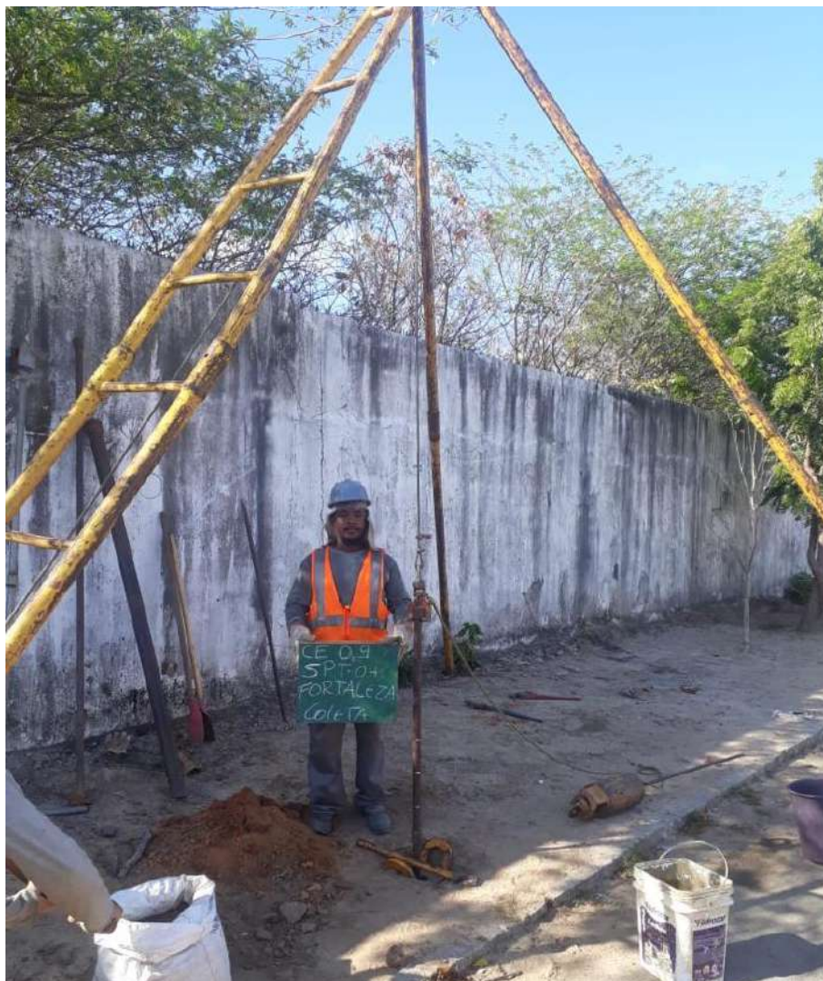
Instalação do furo SP-04
