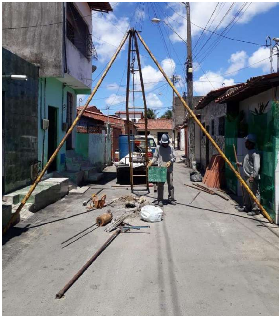
Instalação do furo SP-05
