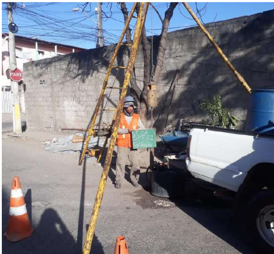
Instalação do furo SP-01
