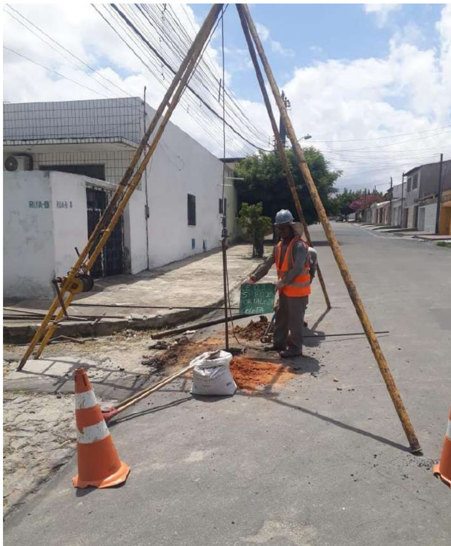
Instalação do furo SP-02
