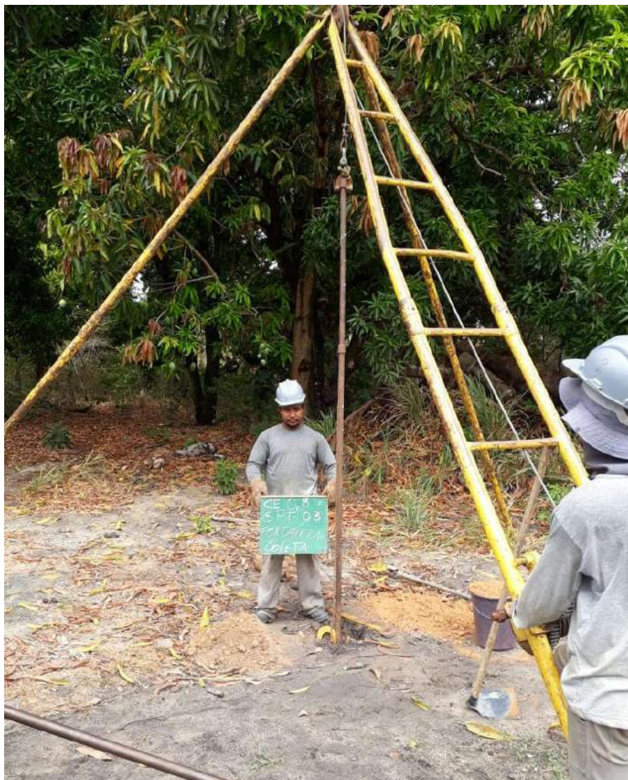
Instalação do furo SP-03
