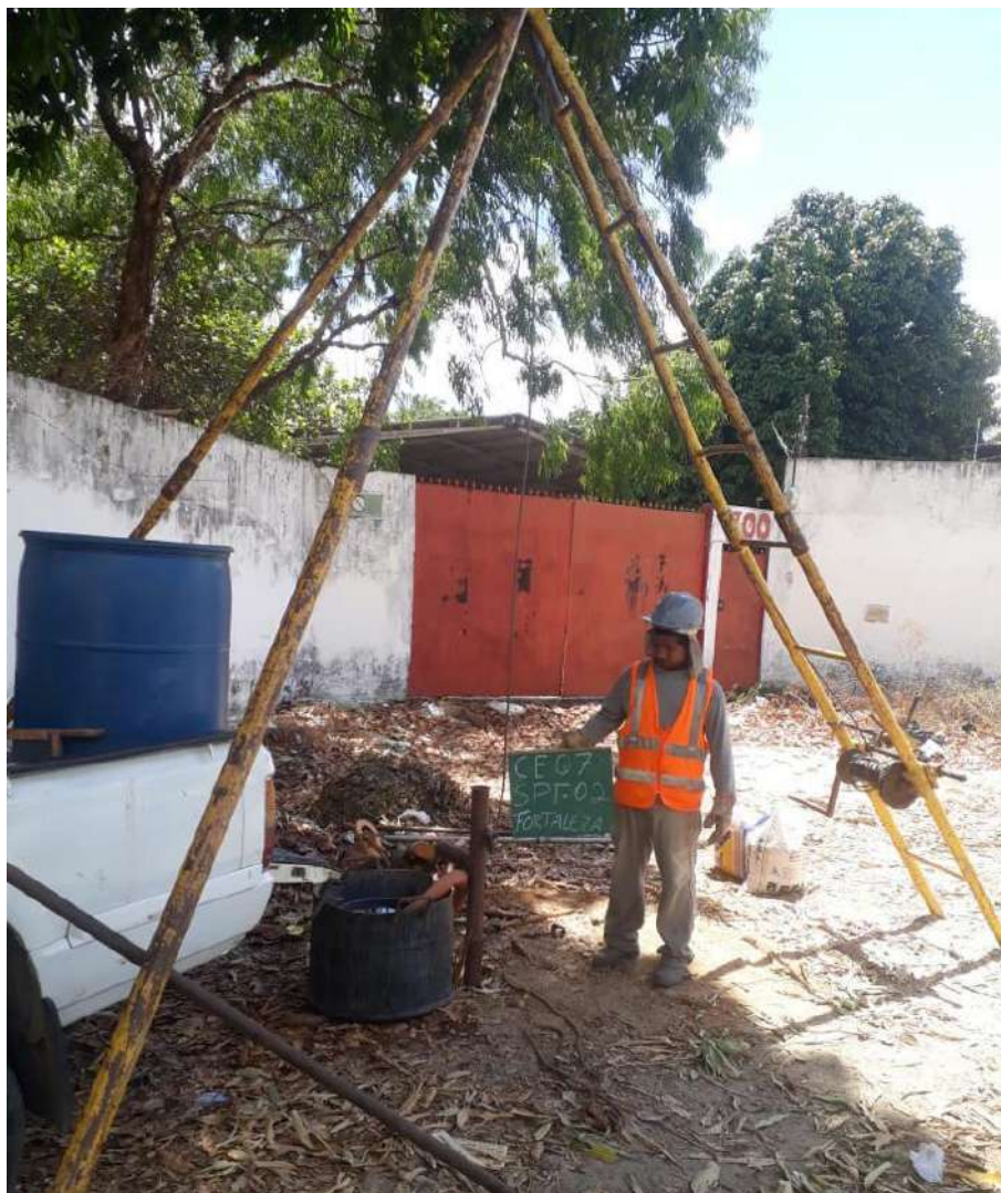
Instalação do furo SP-02
