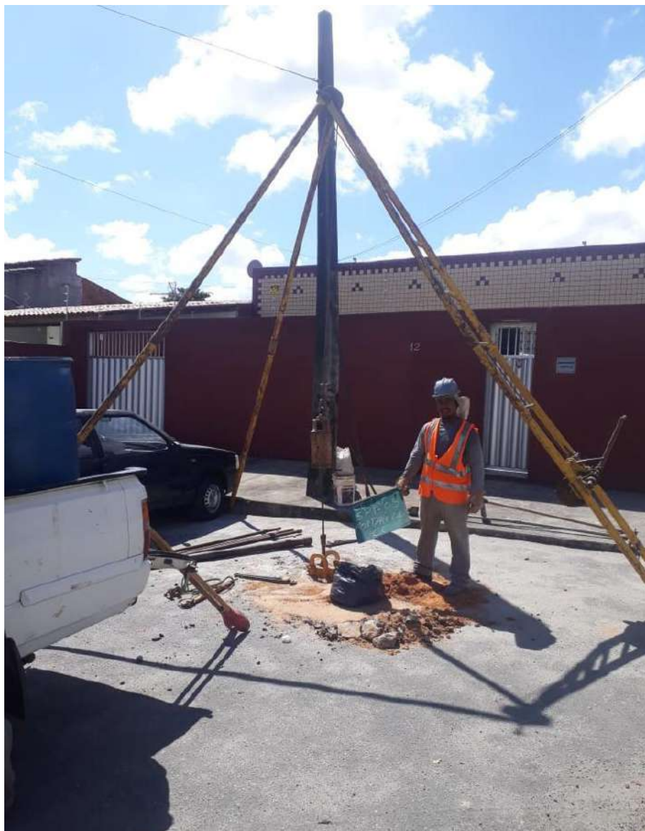
Instalação do furo SP-05
