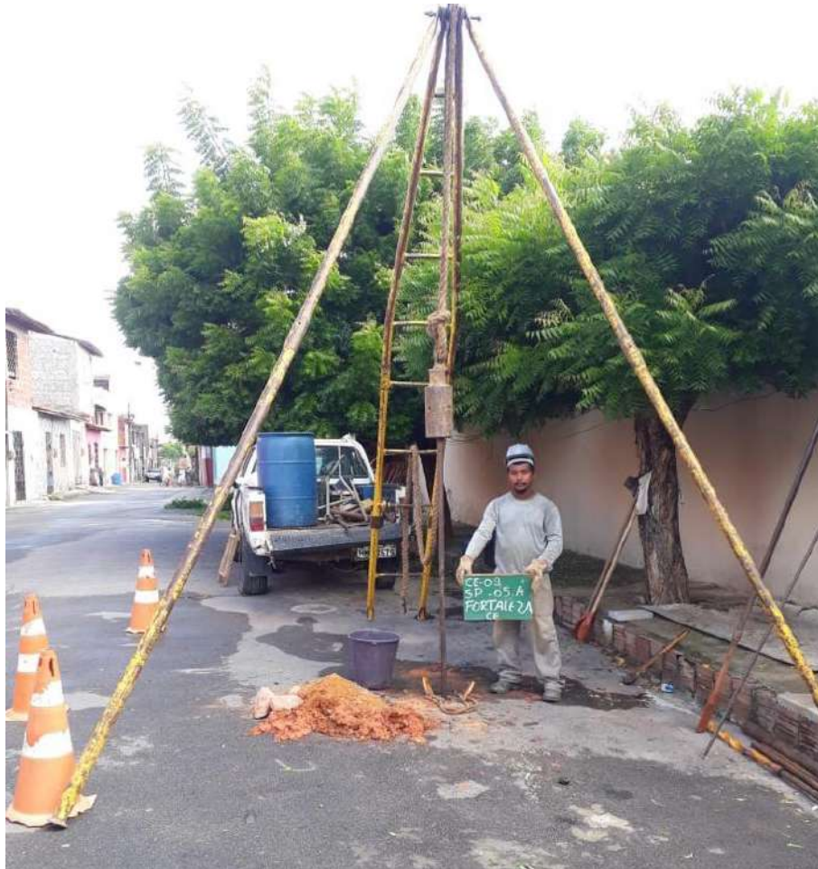
Instalação do furo SP-05 A
