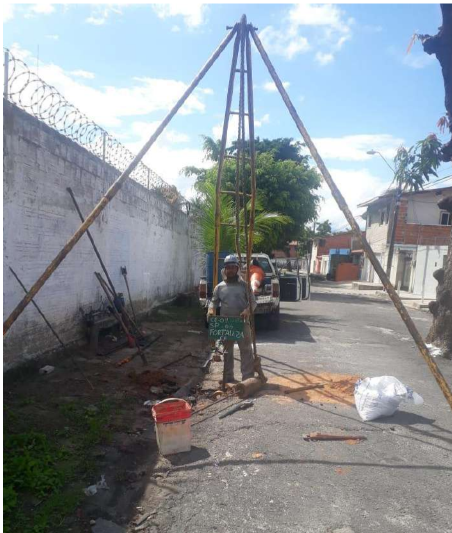
Instalação do furo SP-06
