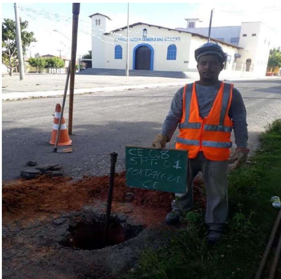
Instalação do furo SP-01
