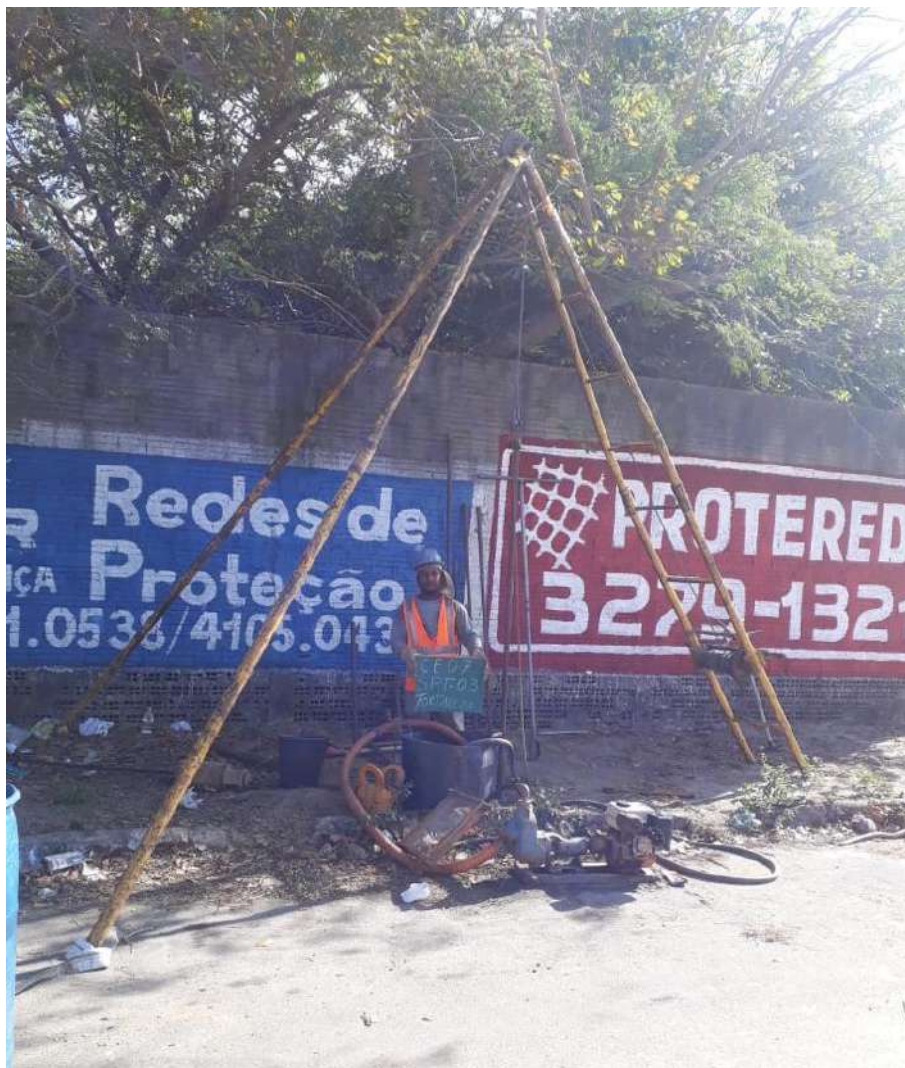
Instalação do furo SP-03
