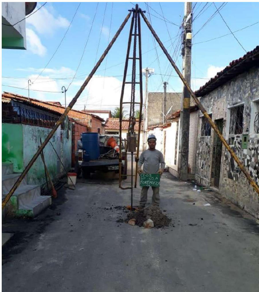
Instalação do furo SP-05 A
