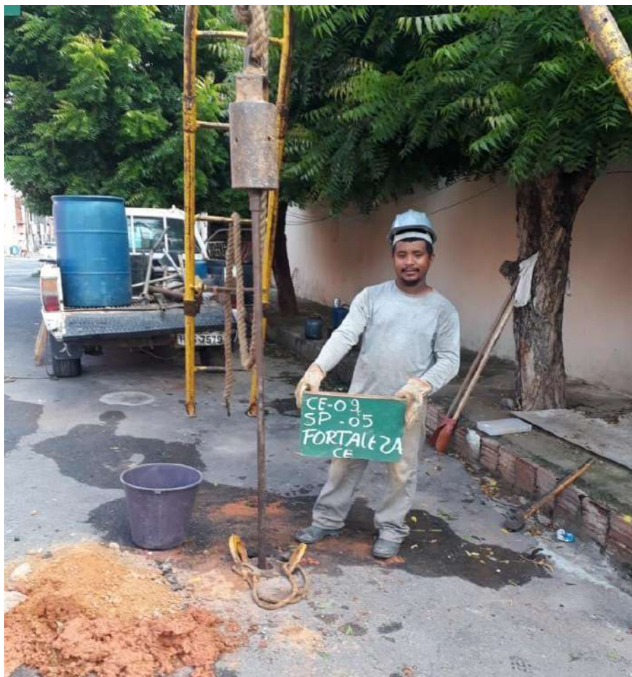
Instalação do furo SP-05
