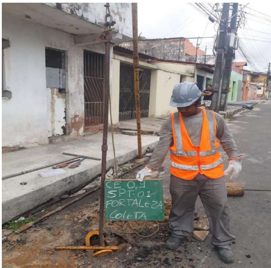
Instalação do furo SP-01
