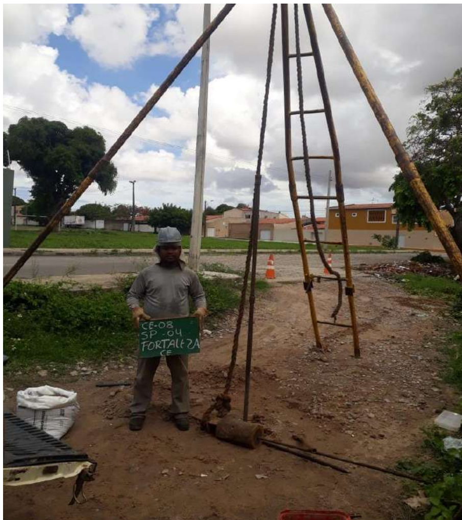
Instalação do furo SP-04
