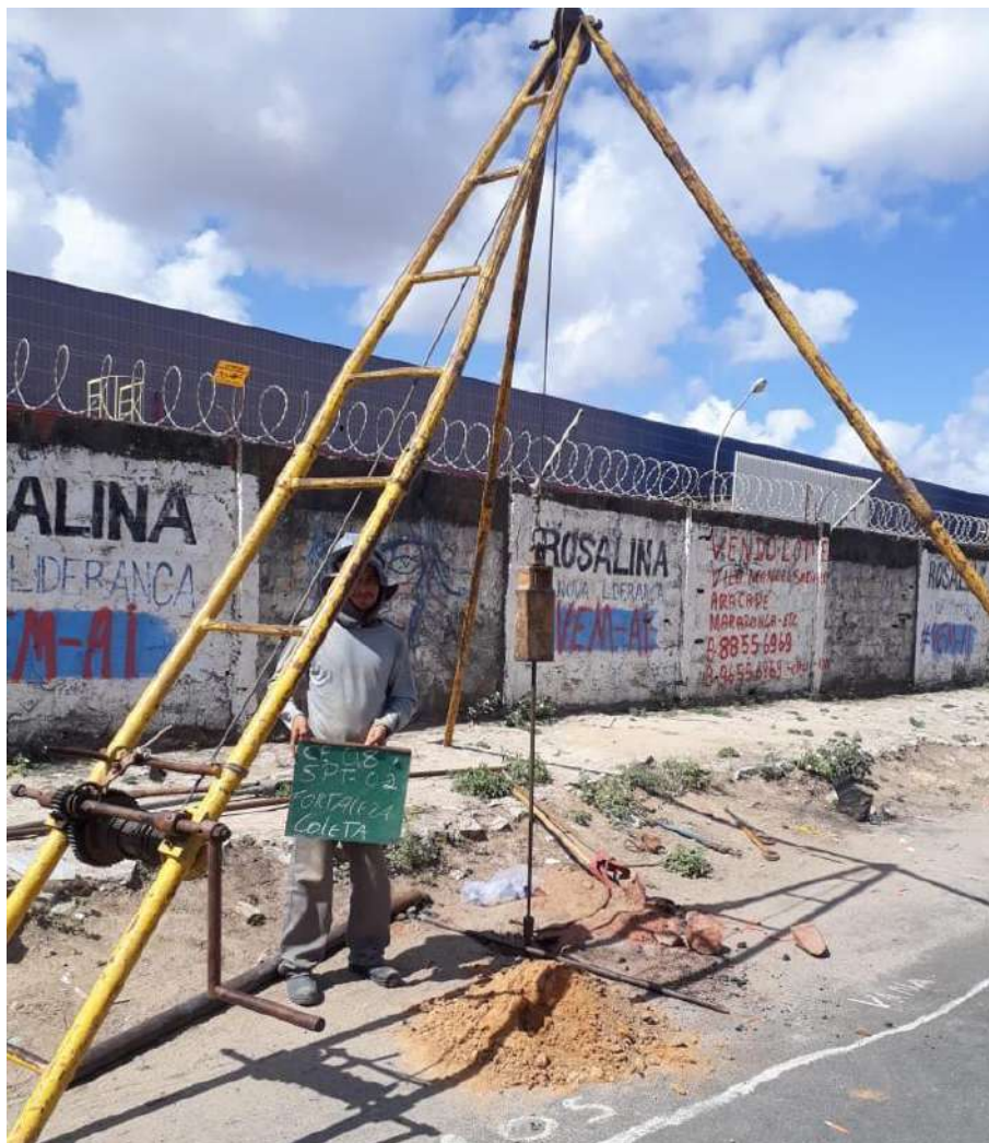
Instalação do furo SP-02
