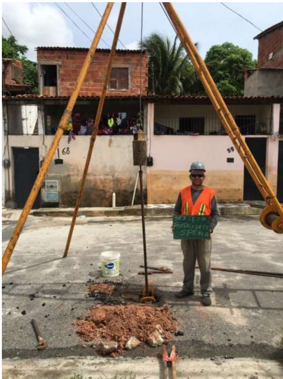
Instalação do furo SP-14 A
