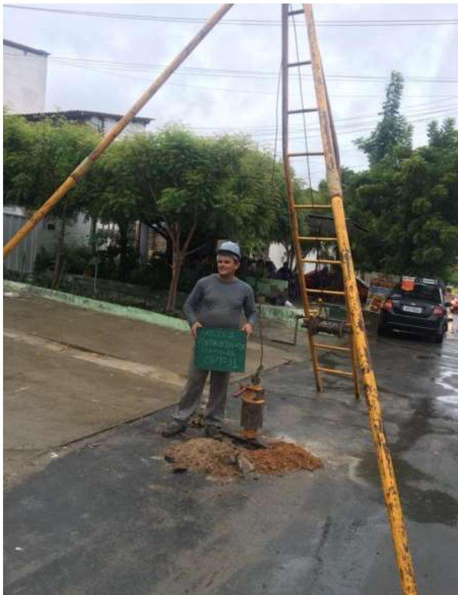
Instalação do furo SP-11
