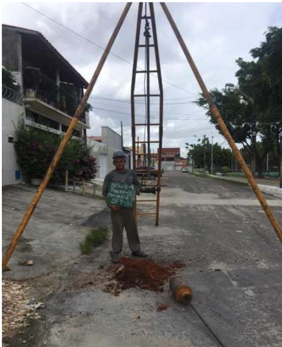
Instalação do furo SP-32
