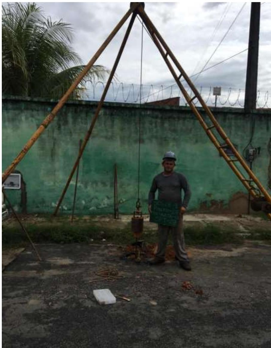
Instalação do furo SP-27
