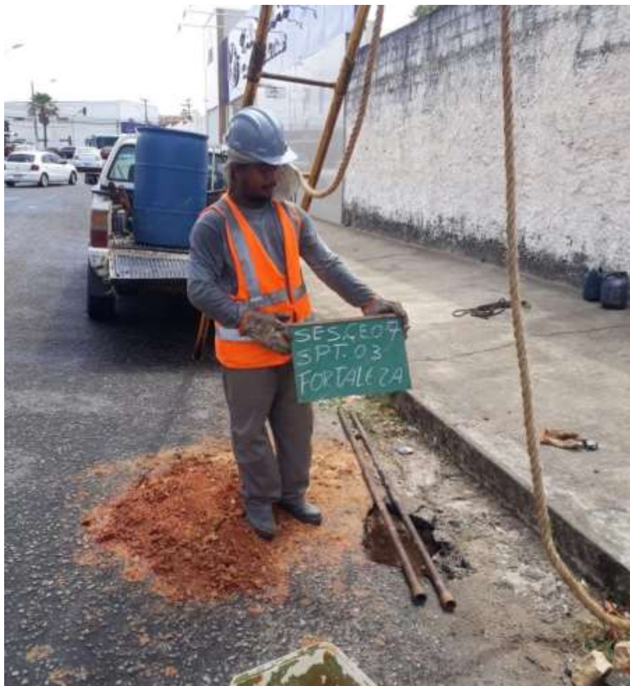
Instalação do furo SP-03
