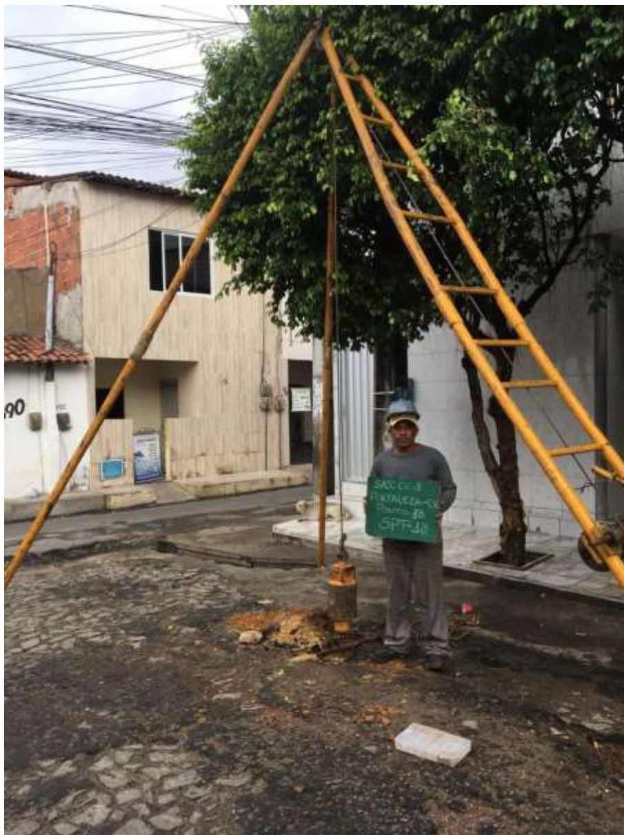
Instalação do furo SP-13
