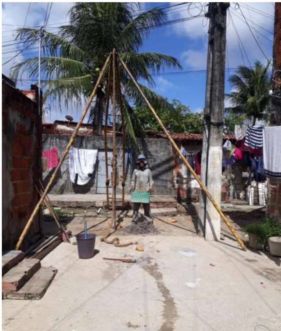
Instalação do furo SP-10
