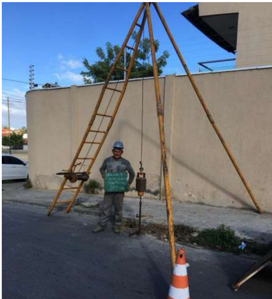
Instalação do furo SP-01
