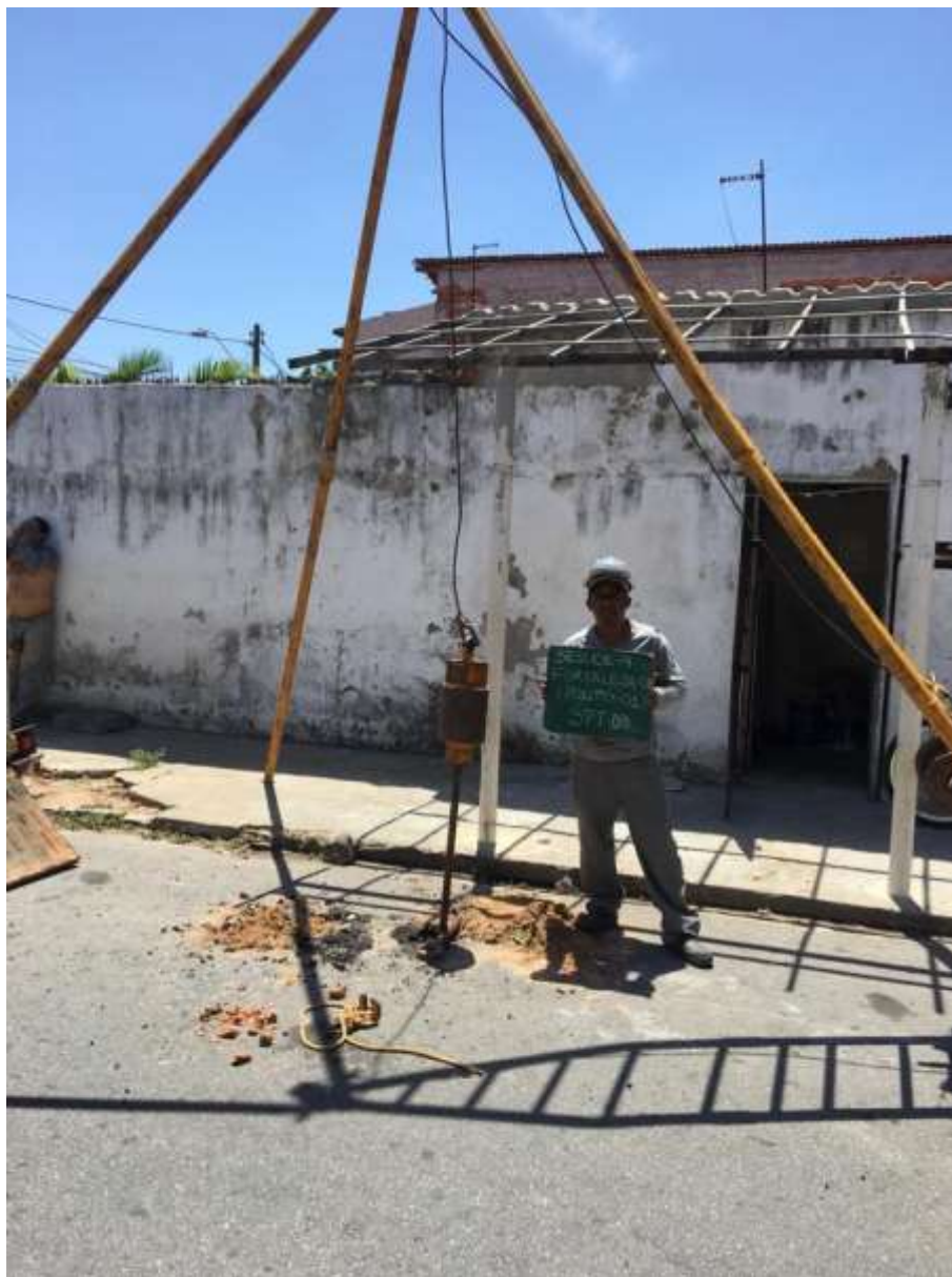
Instalação do furo SP-03
