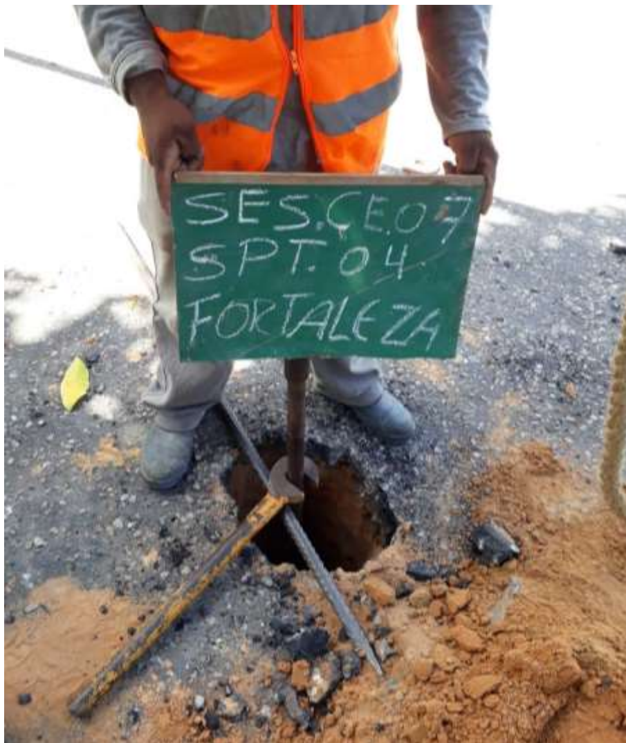
Instalação do furo SP-04
