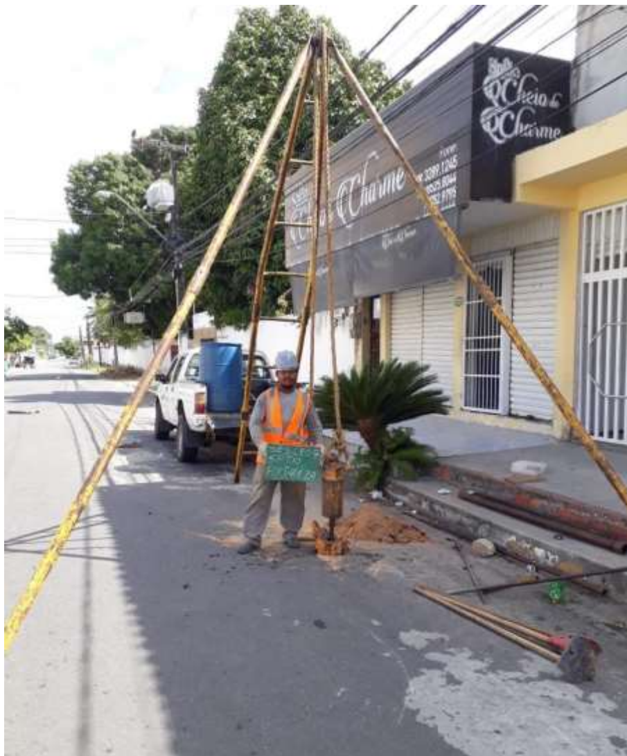
Instalação do furo SP-10
