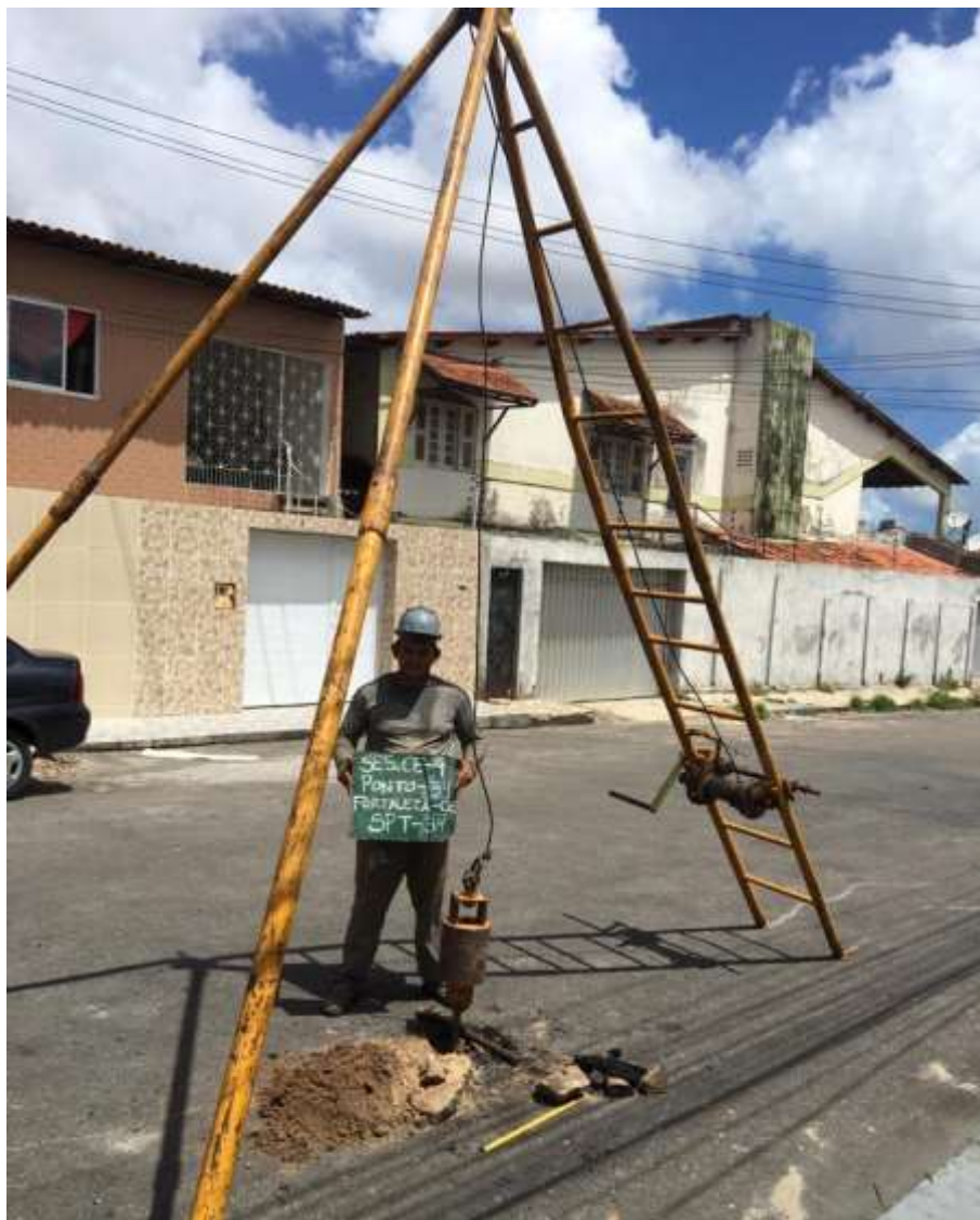
Instalação do furo SP-34
