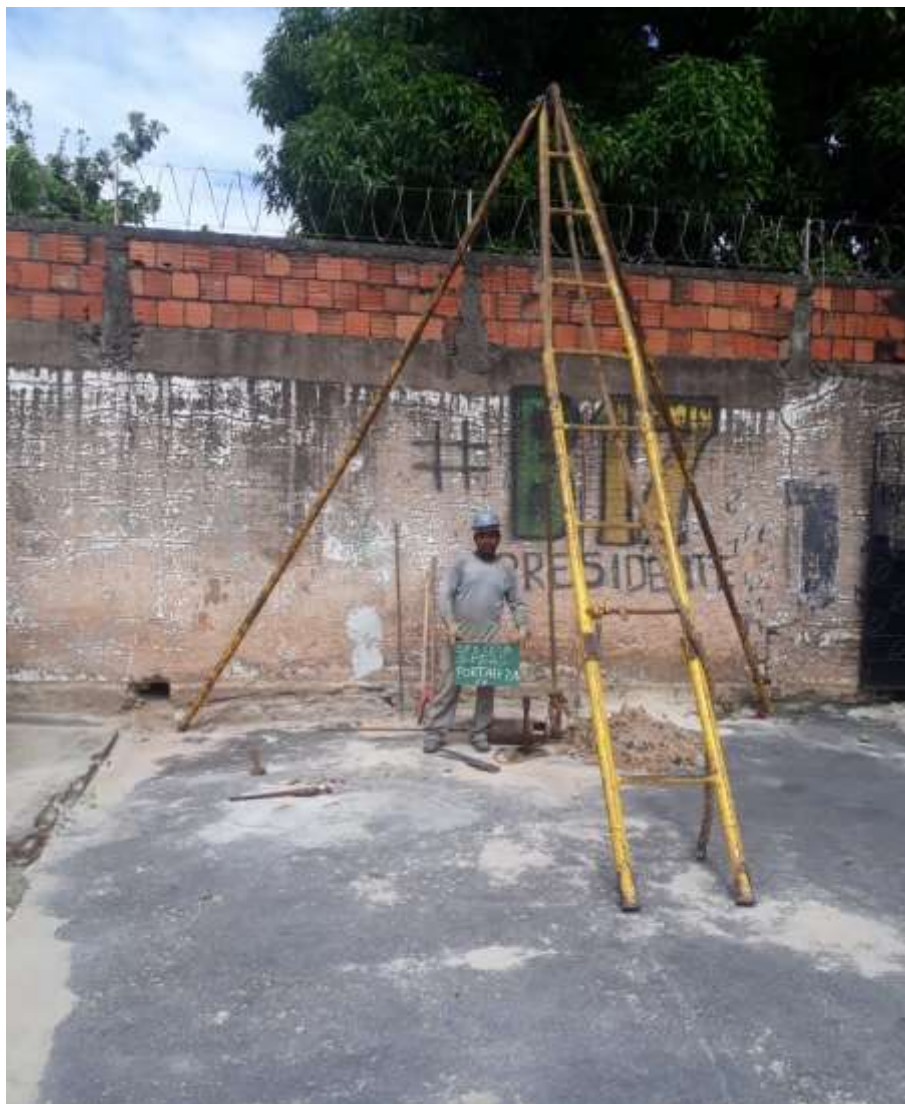
Instalação do furo SP-25
