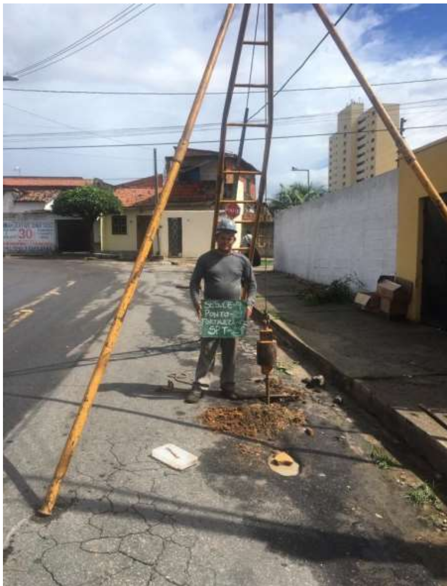
Instalação do furo SP-29
