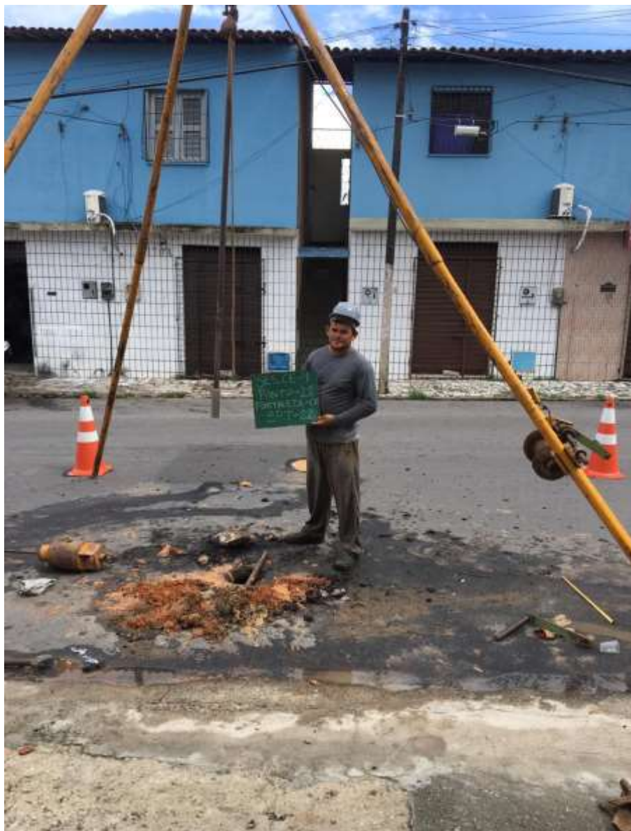
Instalação do furo SP-22
