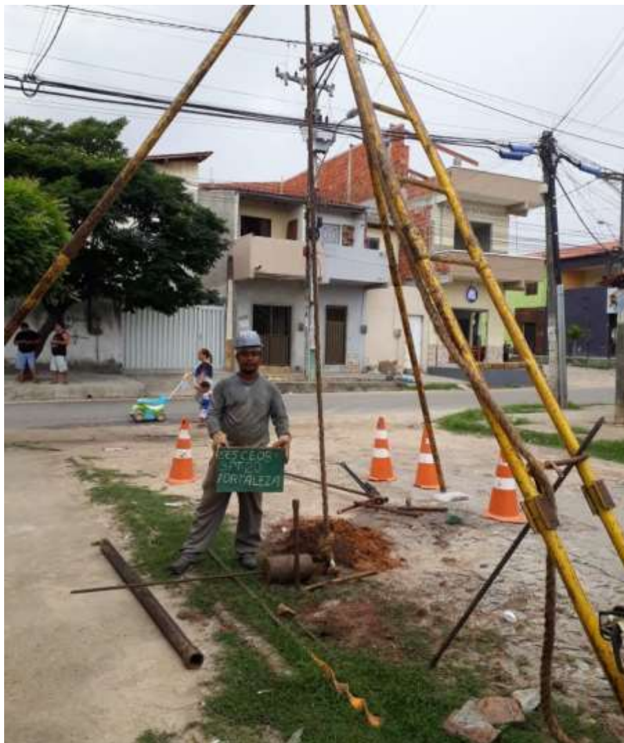
Instalação do furo SP-20
