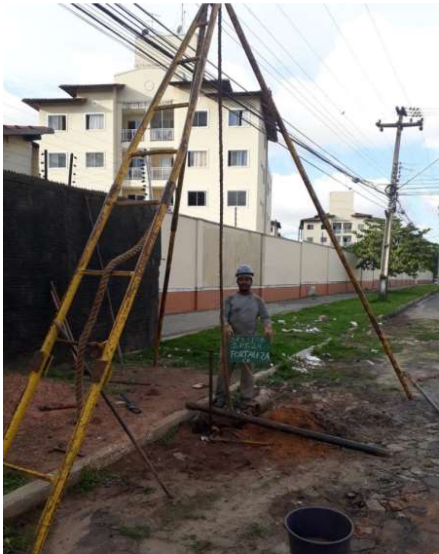
Instalação do furo SP-24
