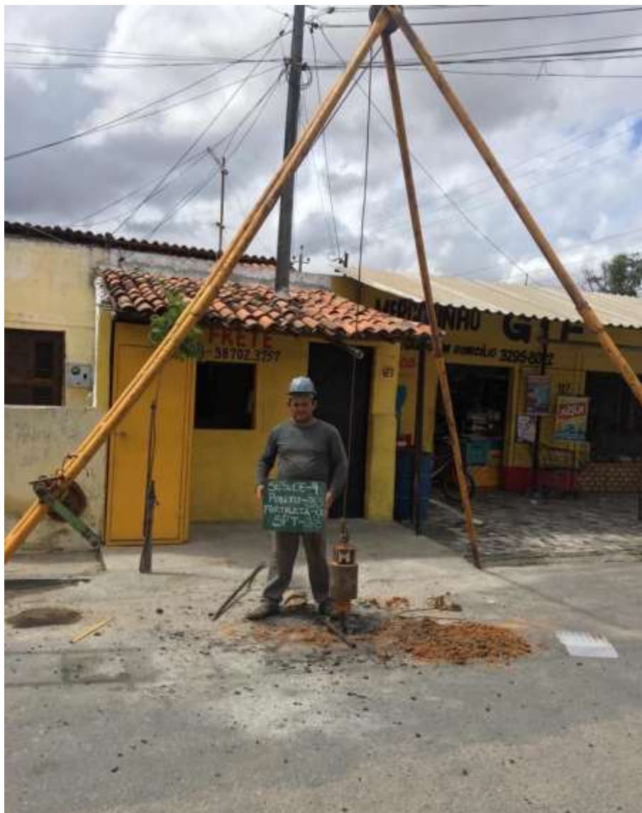
Instalação do furo SP-33
