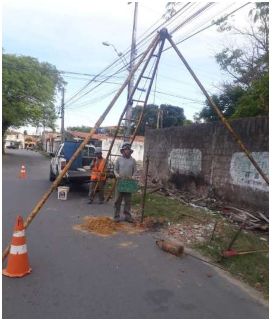
Instalação do furo SP-02
