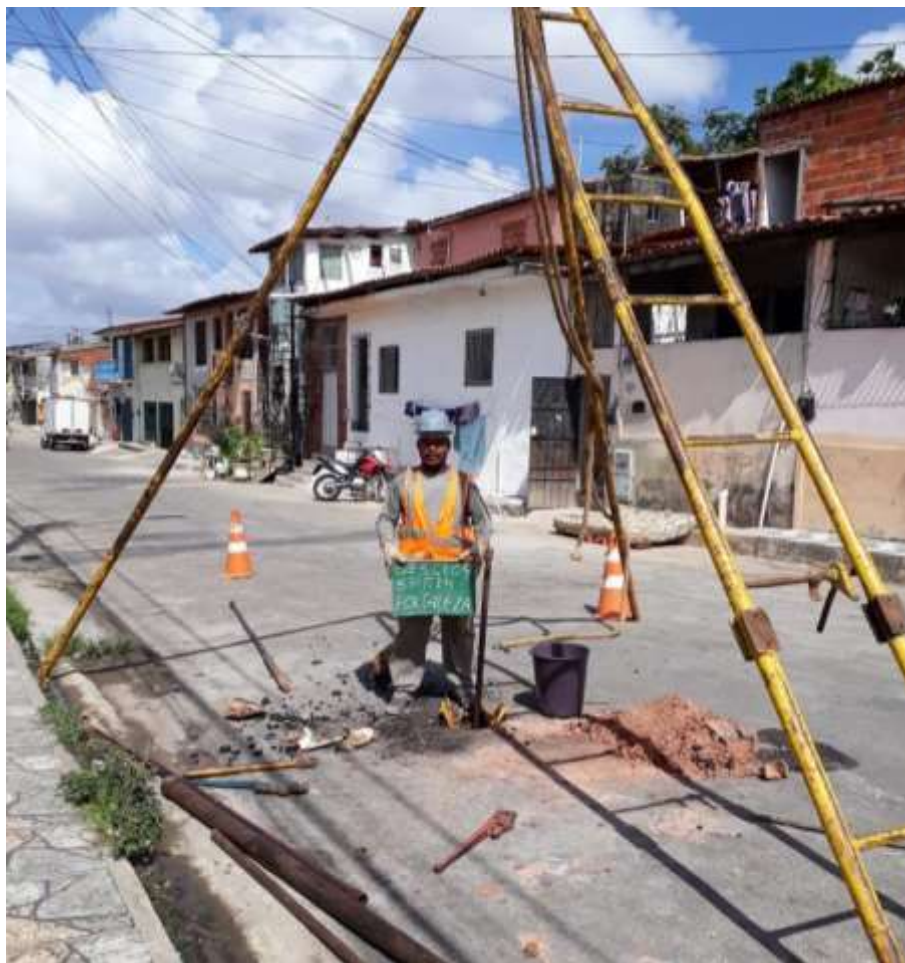
Instalação do furo SP-14
