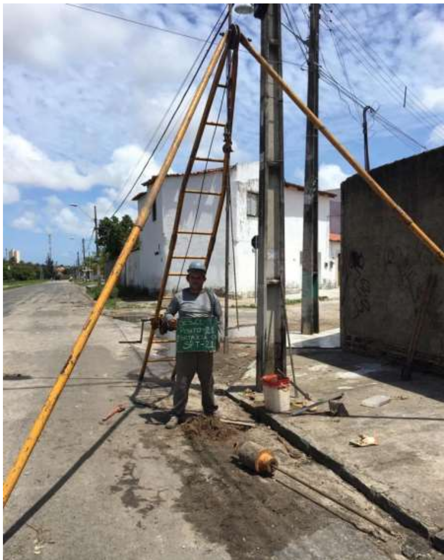
Instalação do furo SP-21
