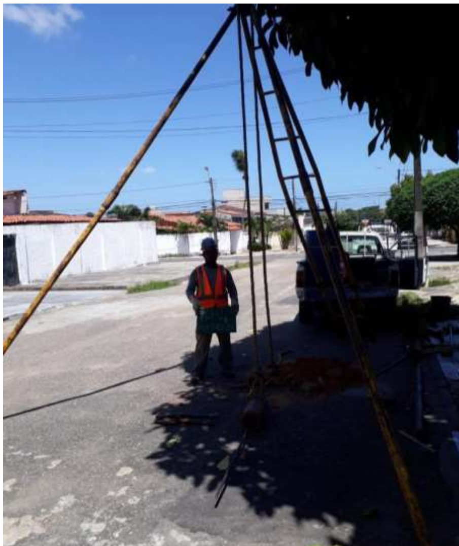
Instalação do furo SP-05
