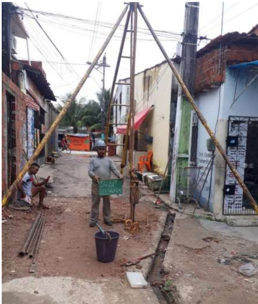
Instalação do furo SP-08
