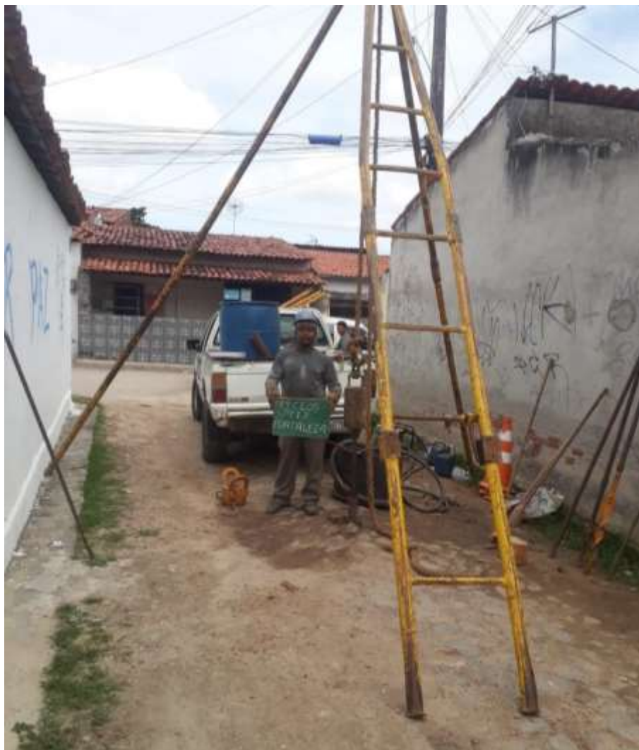
Instalação do furo SP-17
