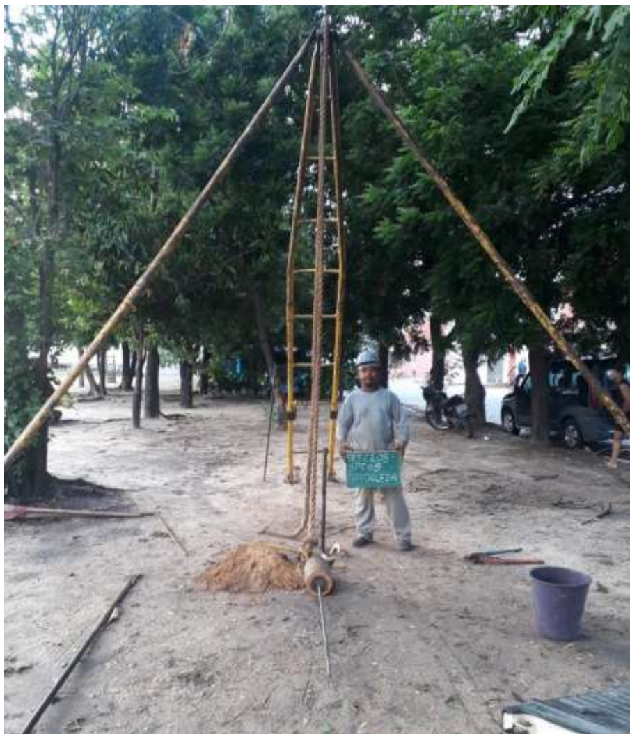
Instalação do furo SP-09
