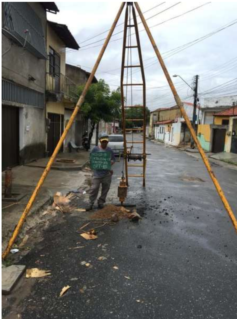
Instalação do furo SP-15
