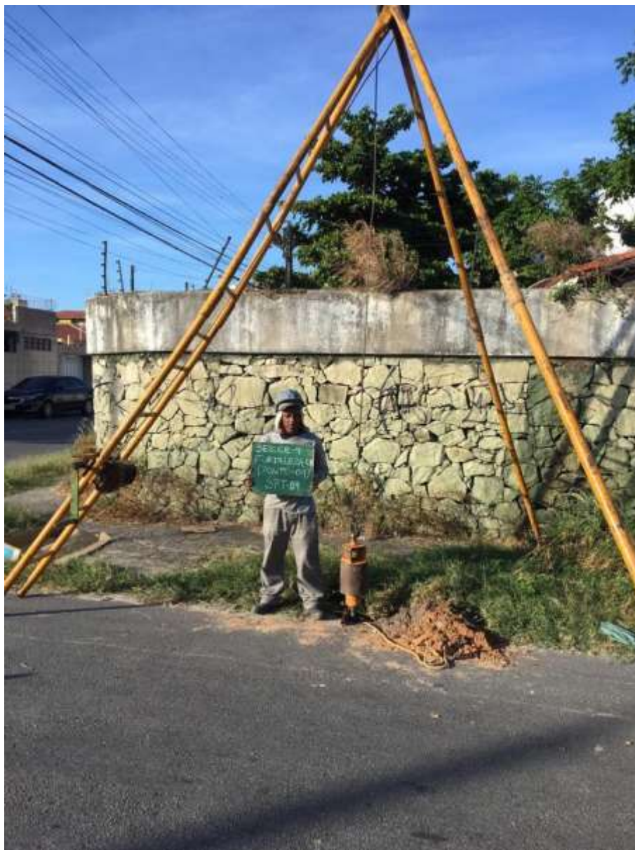
Instalação do furo SP-09
