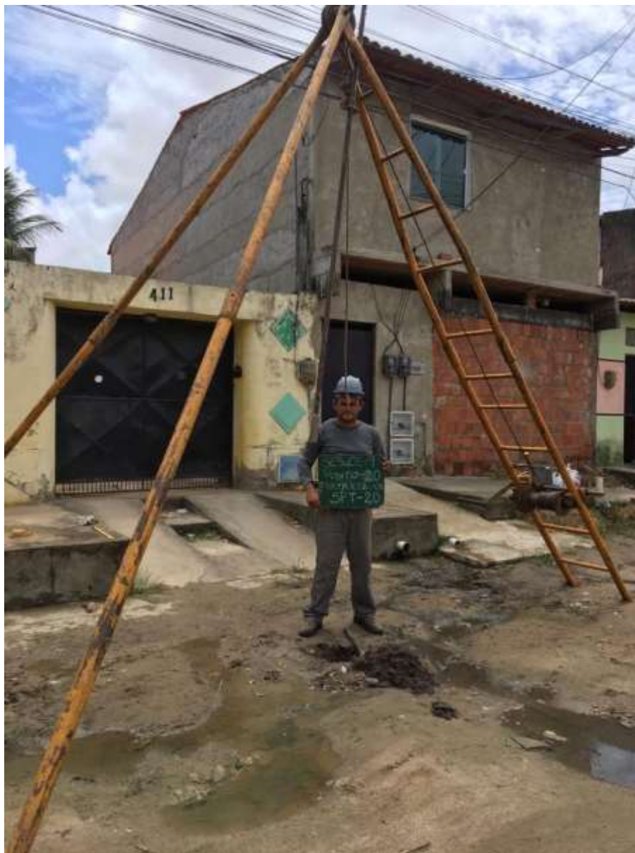
Instalação do furo SP-20
