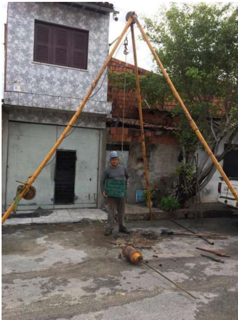
Instalação do furo SP-28
