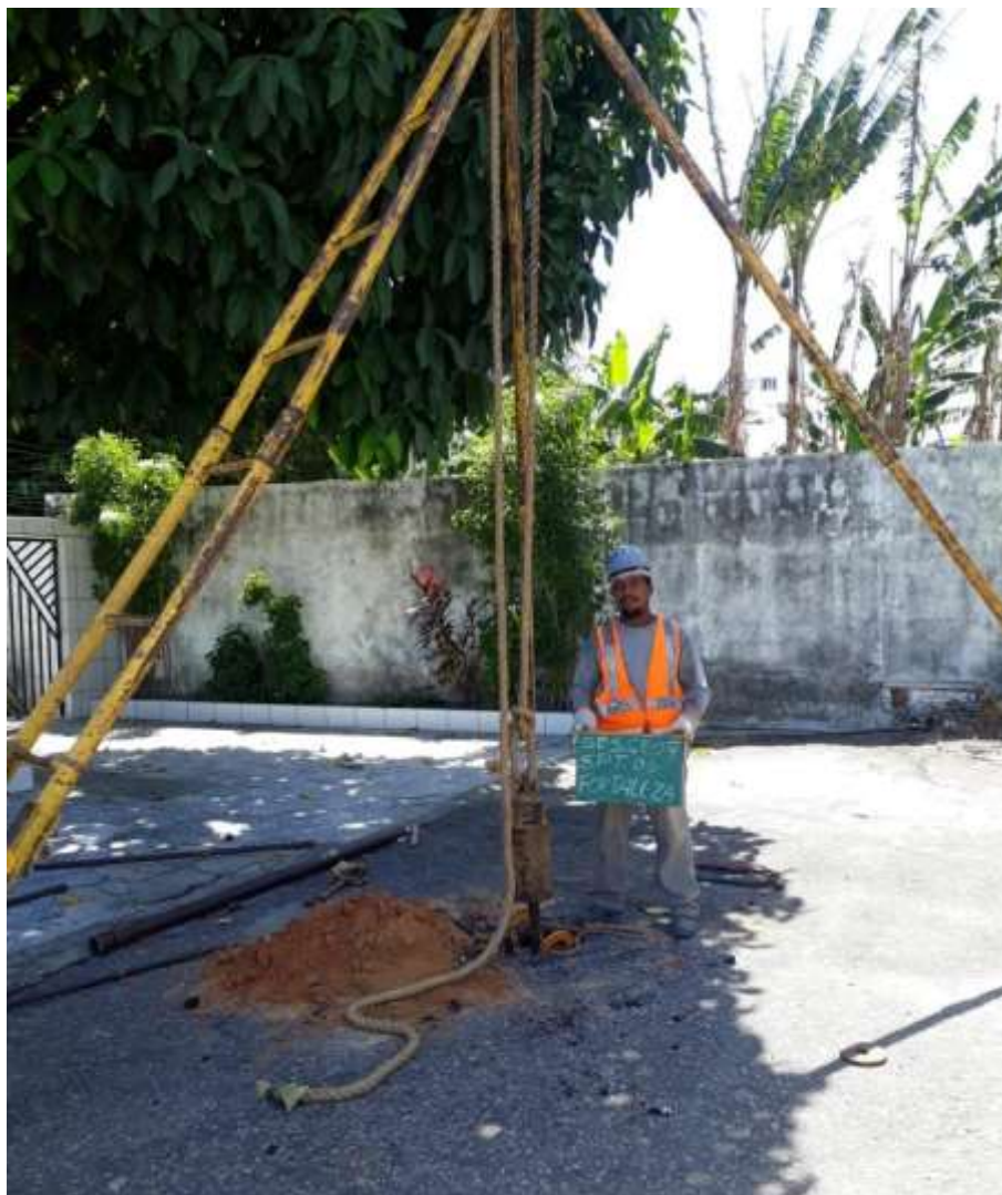
Instalação do furo SP-06
