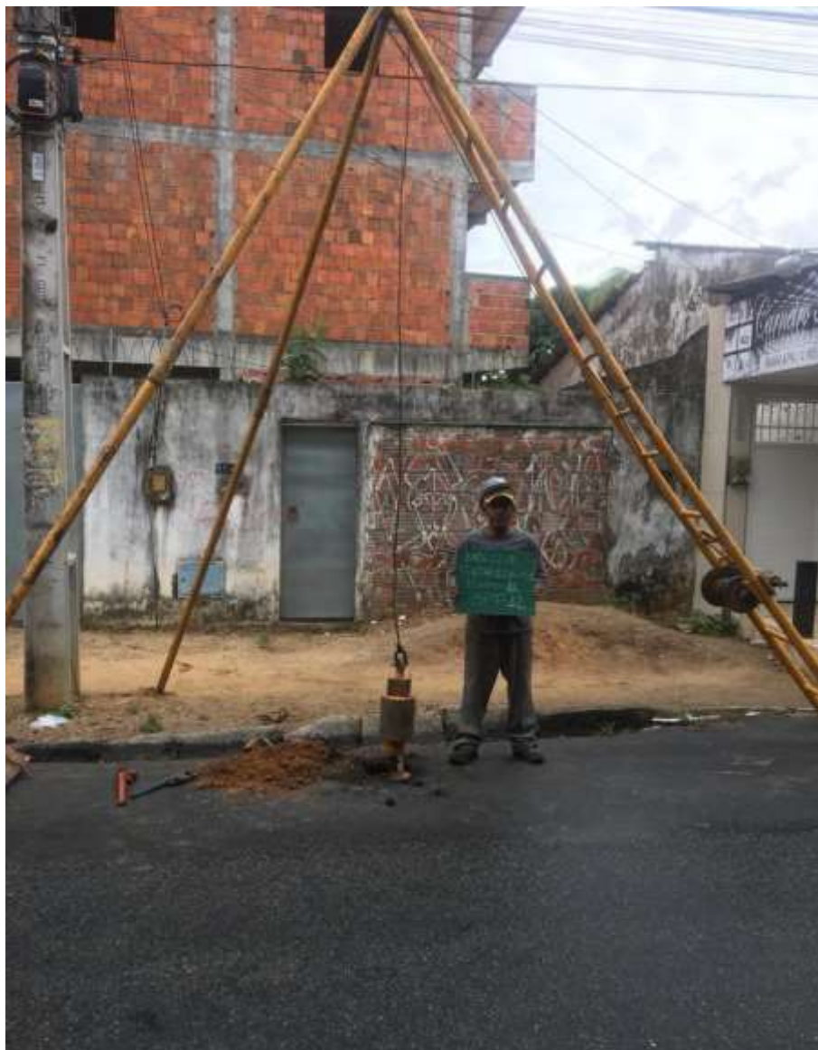
Instalação do furo SP-12
