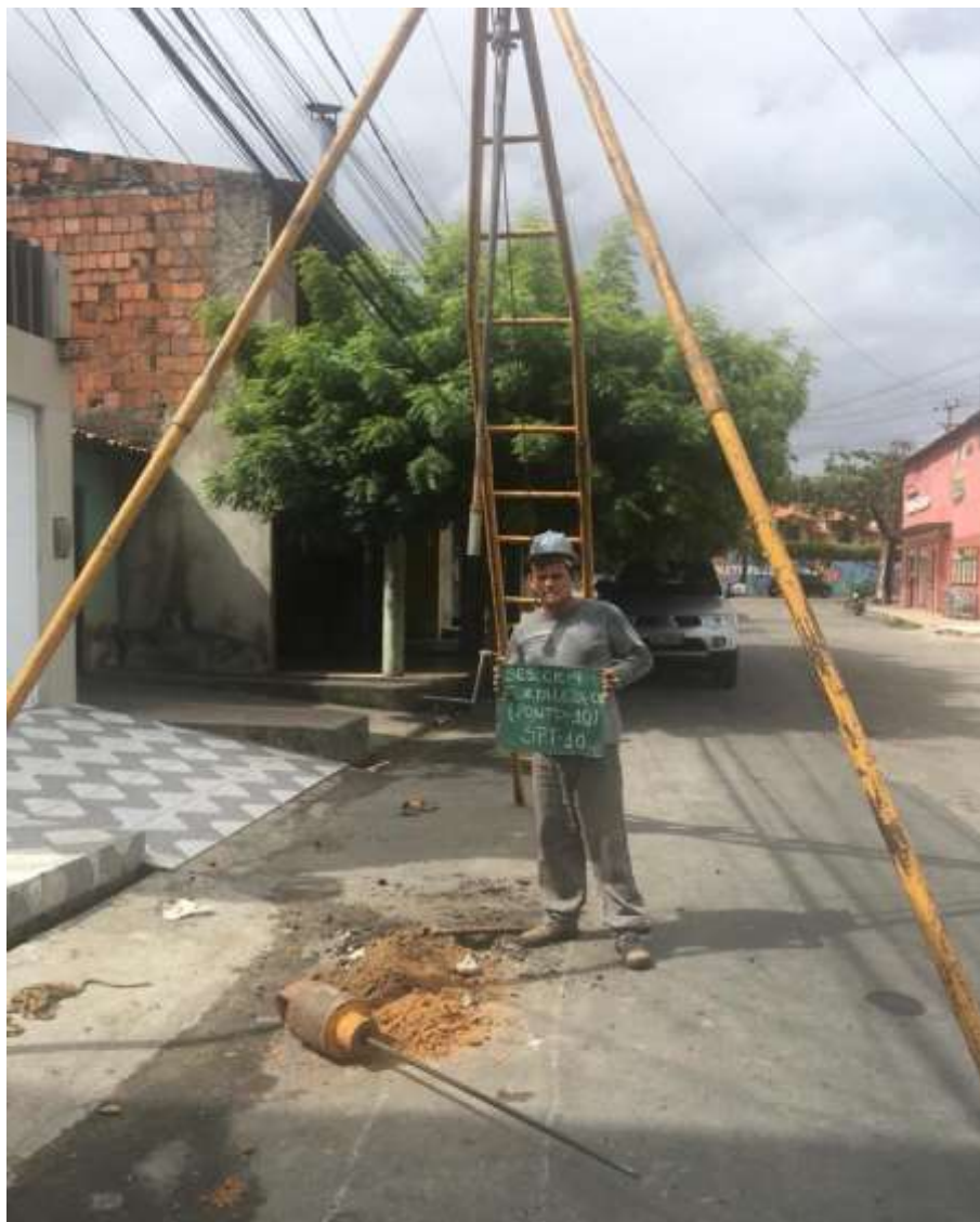
Instalação do furo SP-10
