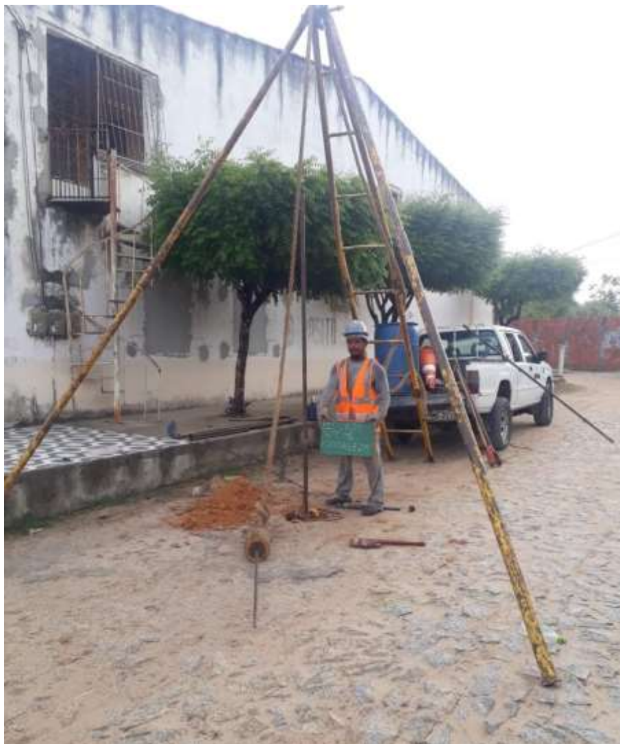
Instalação do furo SP-05
