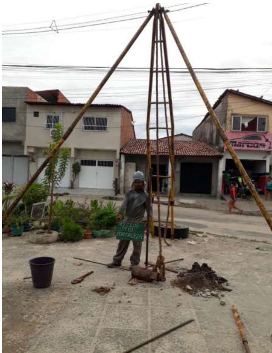
Instalação do furo SP-19
