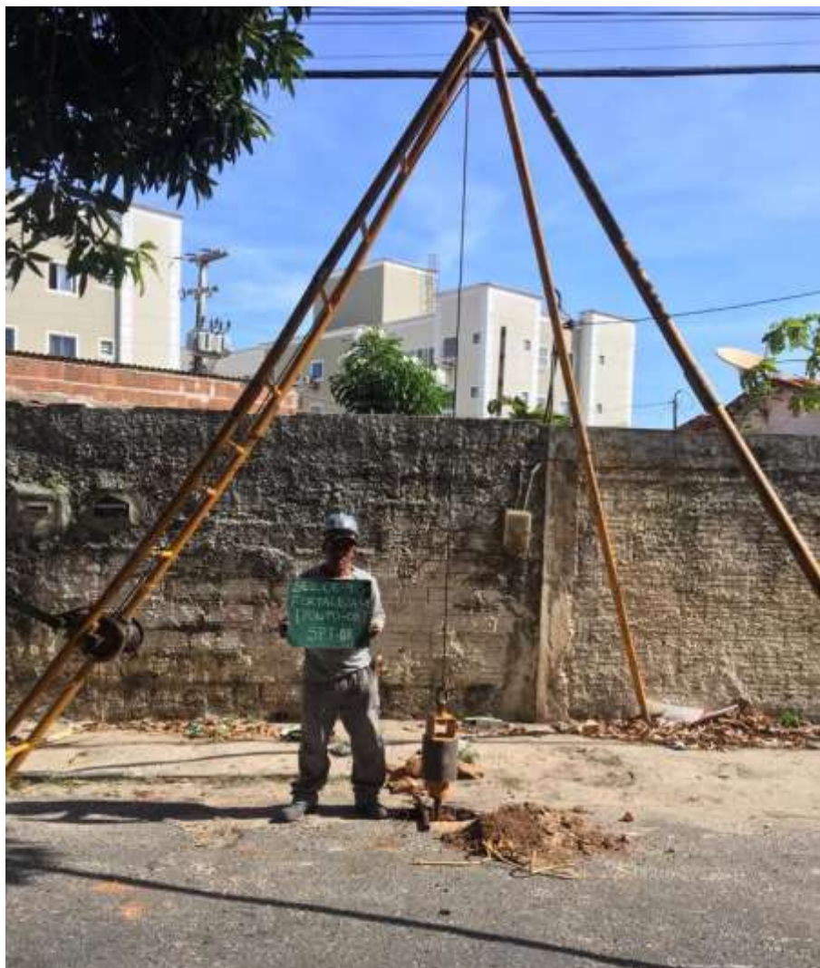
Instalação do furo SP-08
