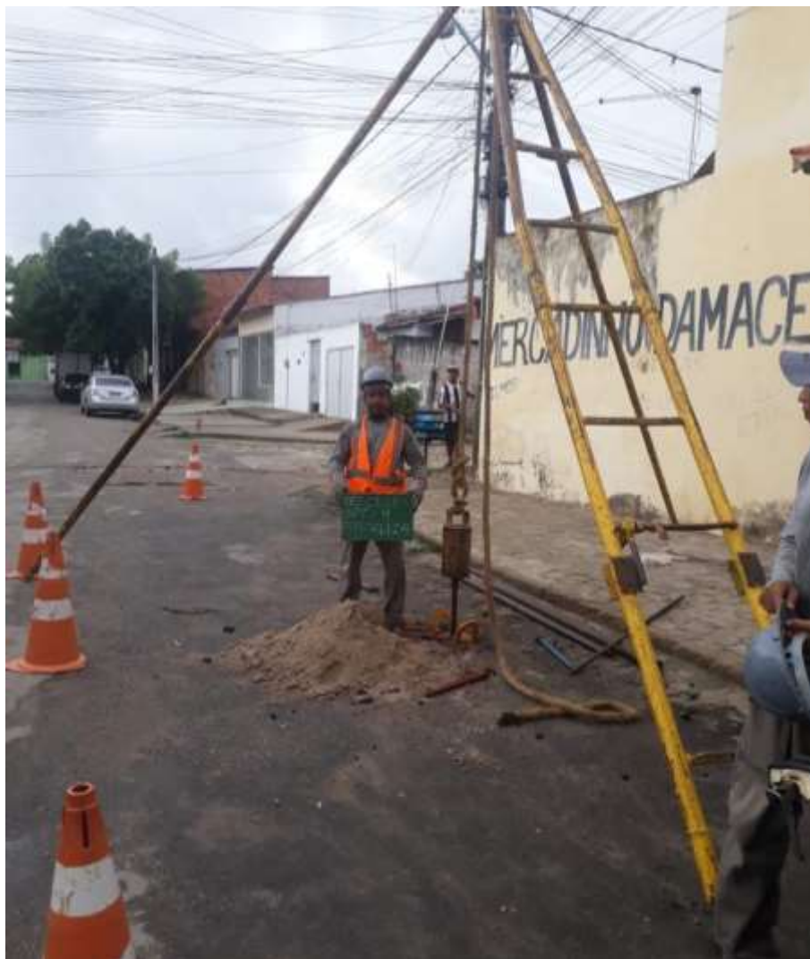
Instalação do furo SP-04
