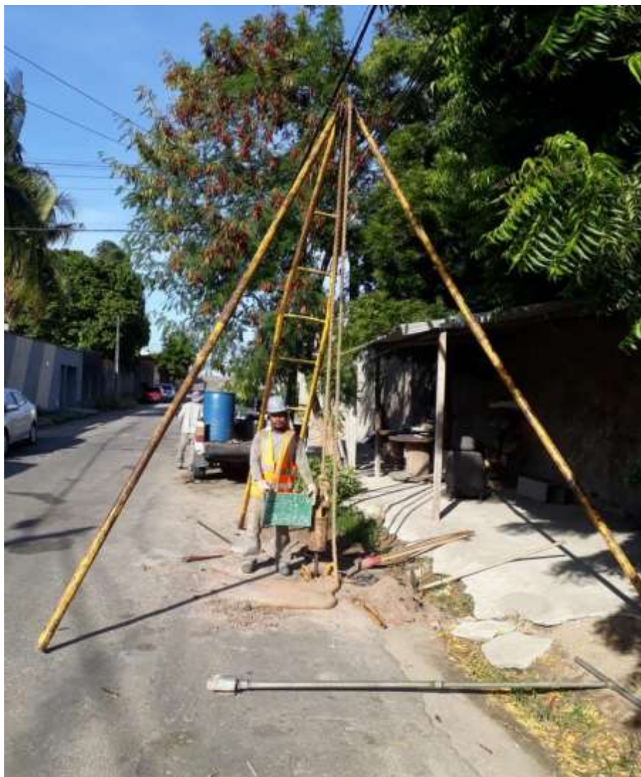
Instalação do furo SP-13
