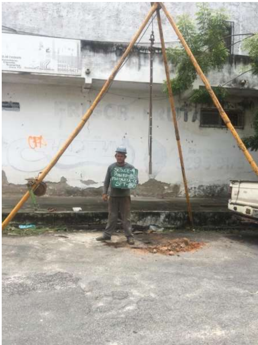
Instalação do furo SP-30
