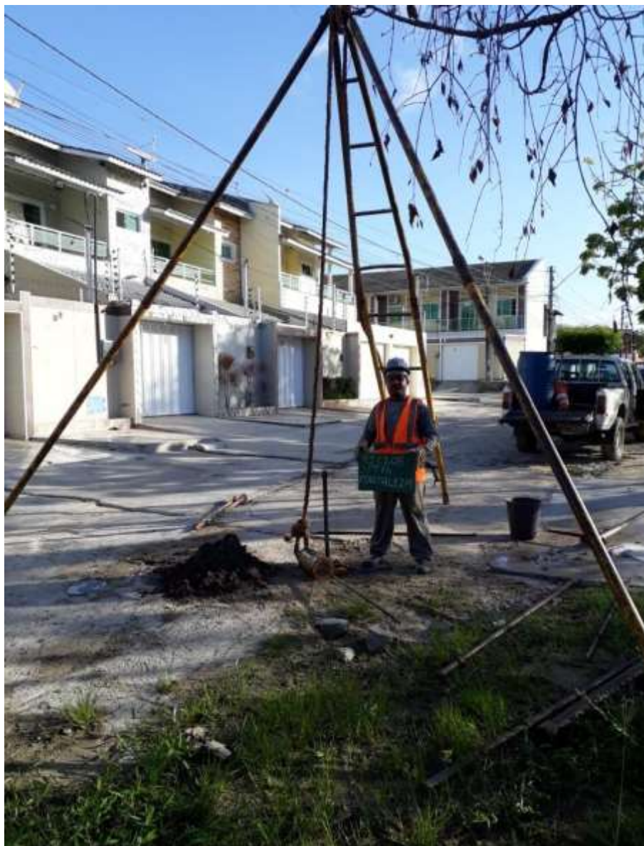
Instalação do furo SP-16
