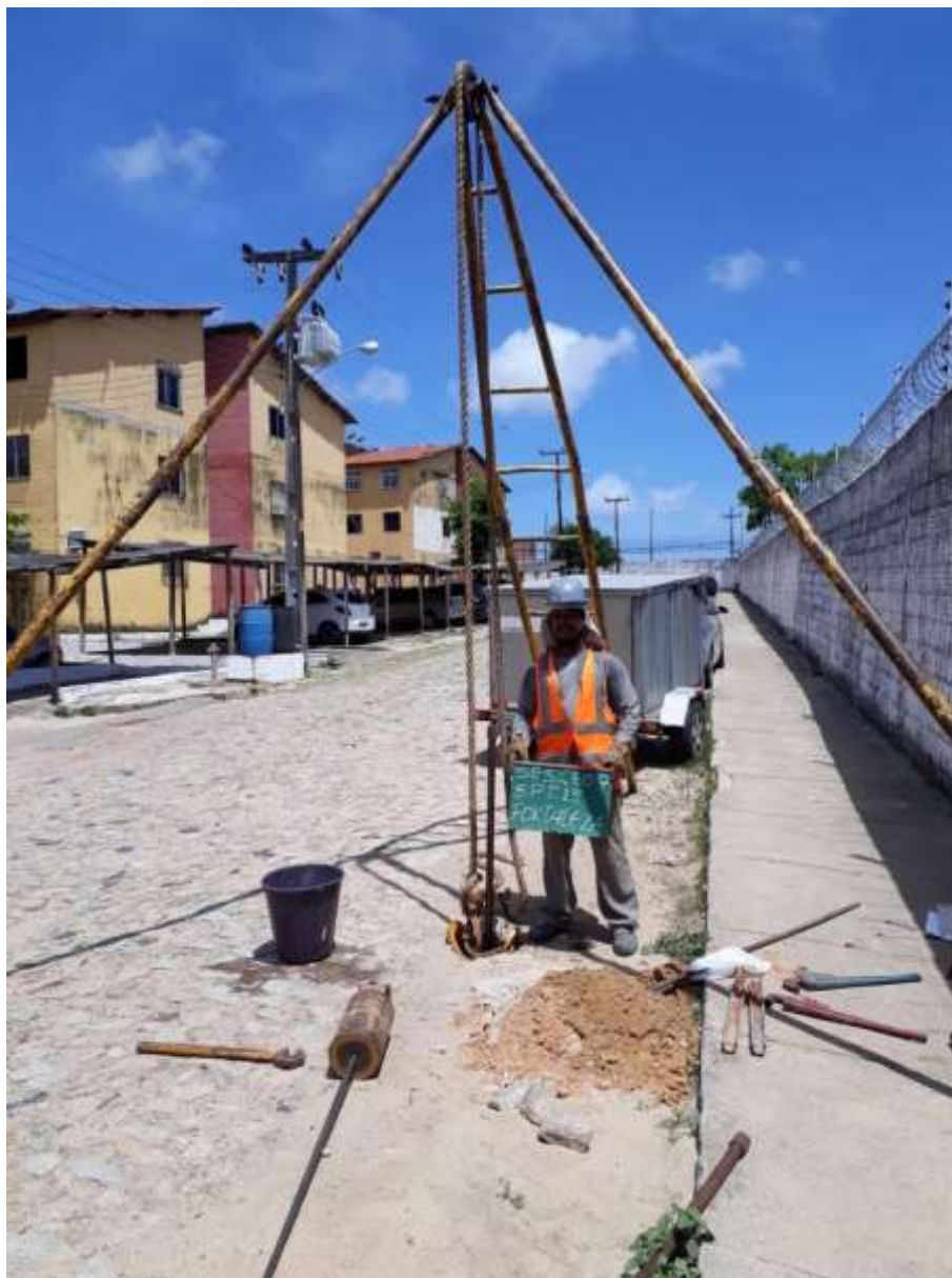
Instalação do furo SP-15
