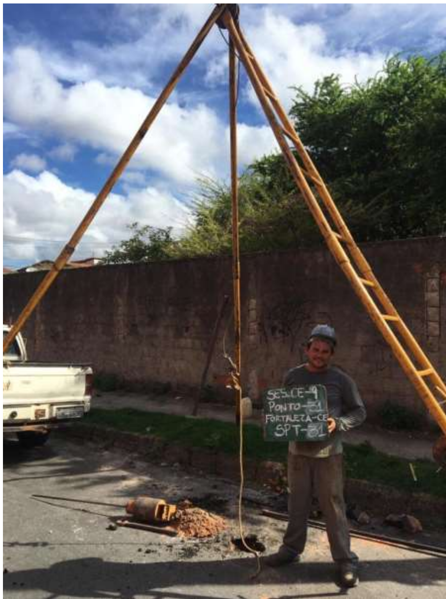
Instalação do furo SP-31
