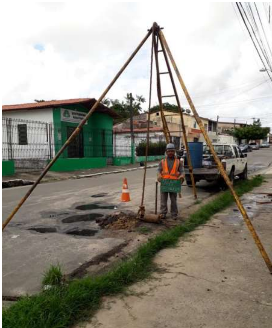
Instalação do furo SP-13
