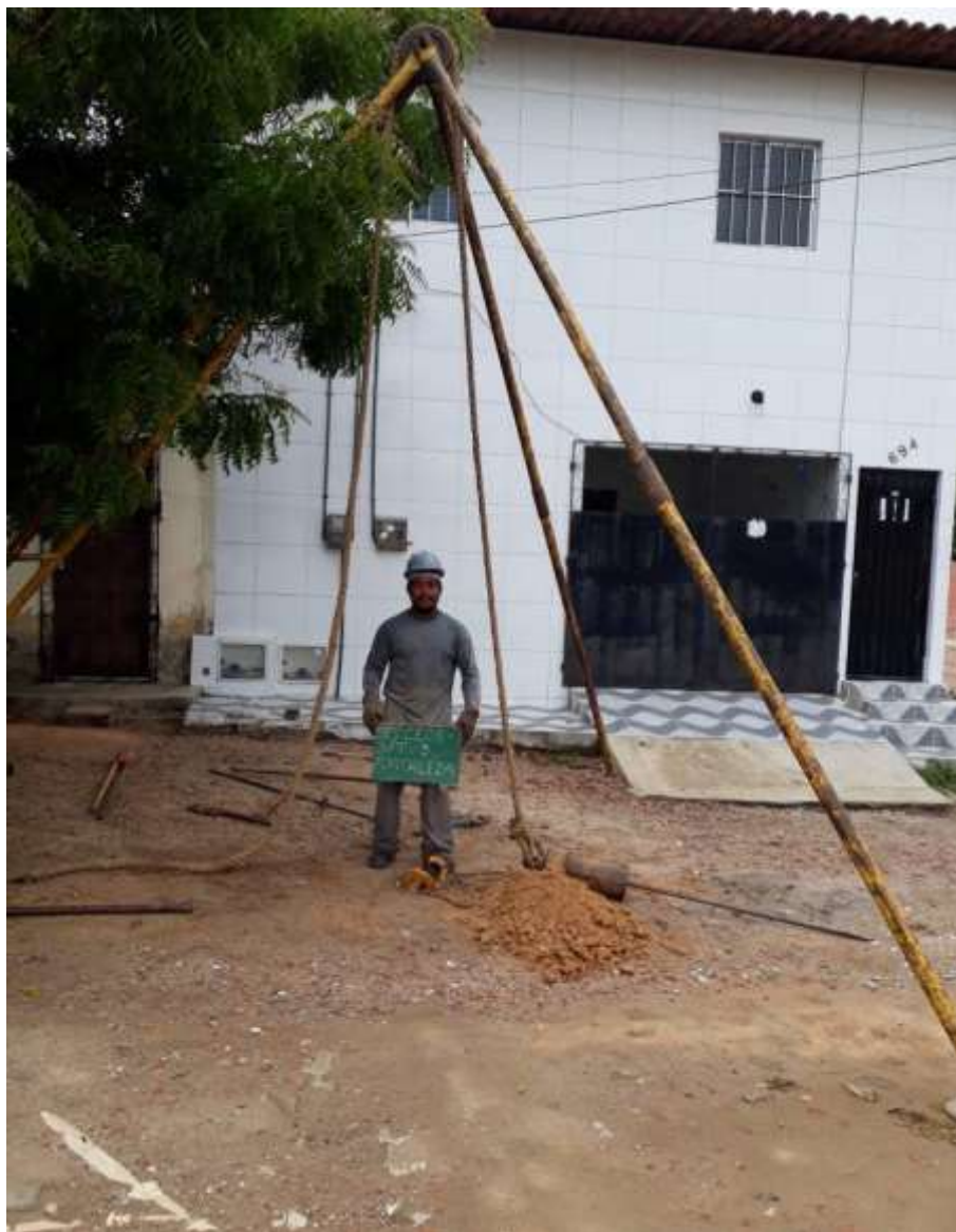
Instalação do furo SP-03
