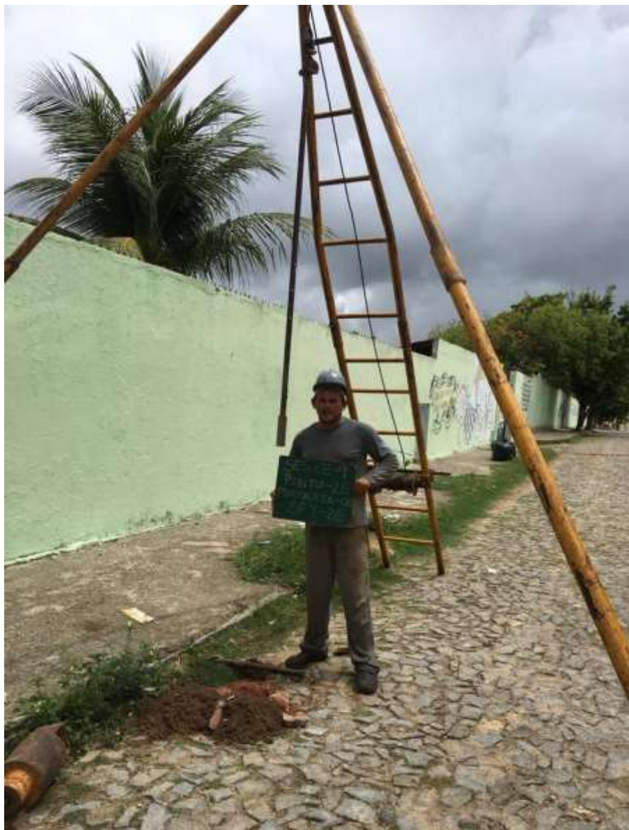
Instalação do furo SP-26
