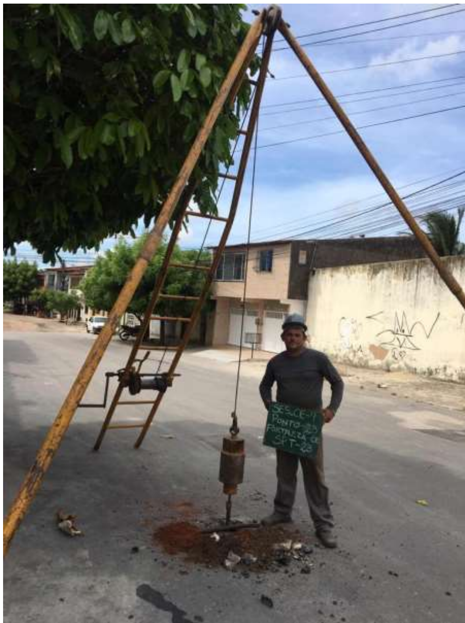
Instalação do furo SP-23
