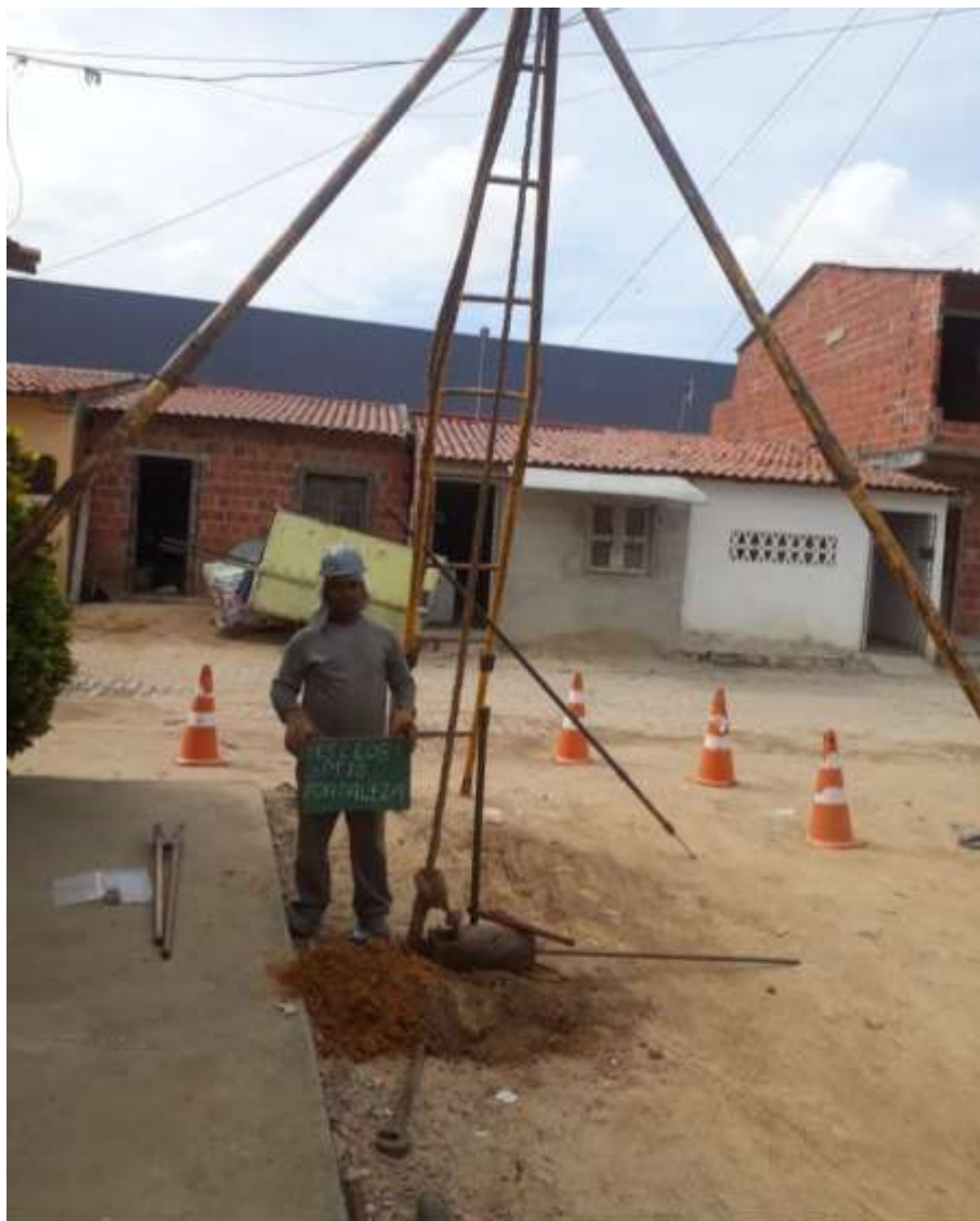
Instalação do furo SP-18
