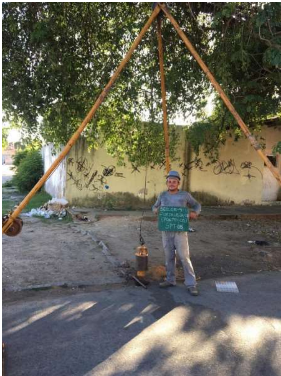
Instalação do furo SP-05
