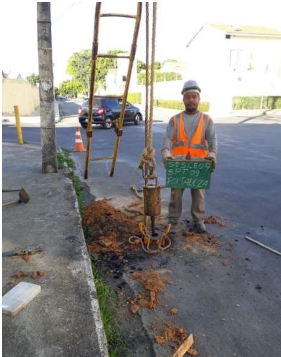
Instalação do furo SP-09
