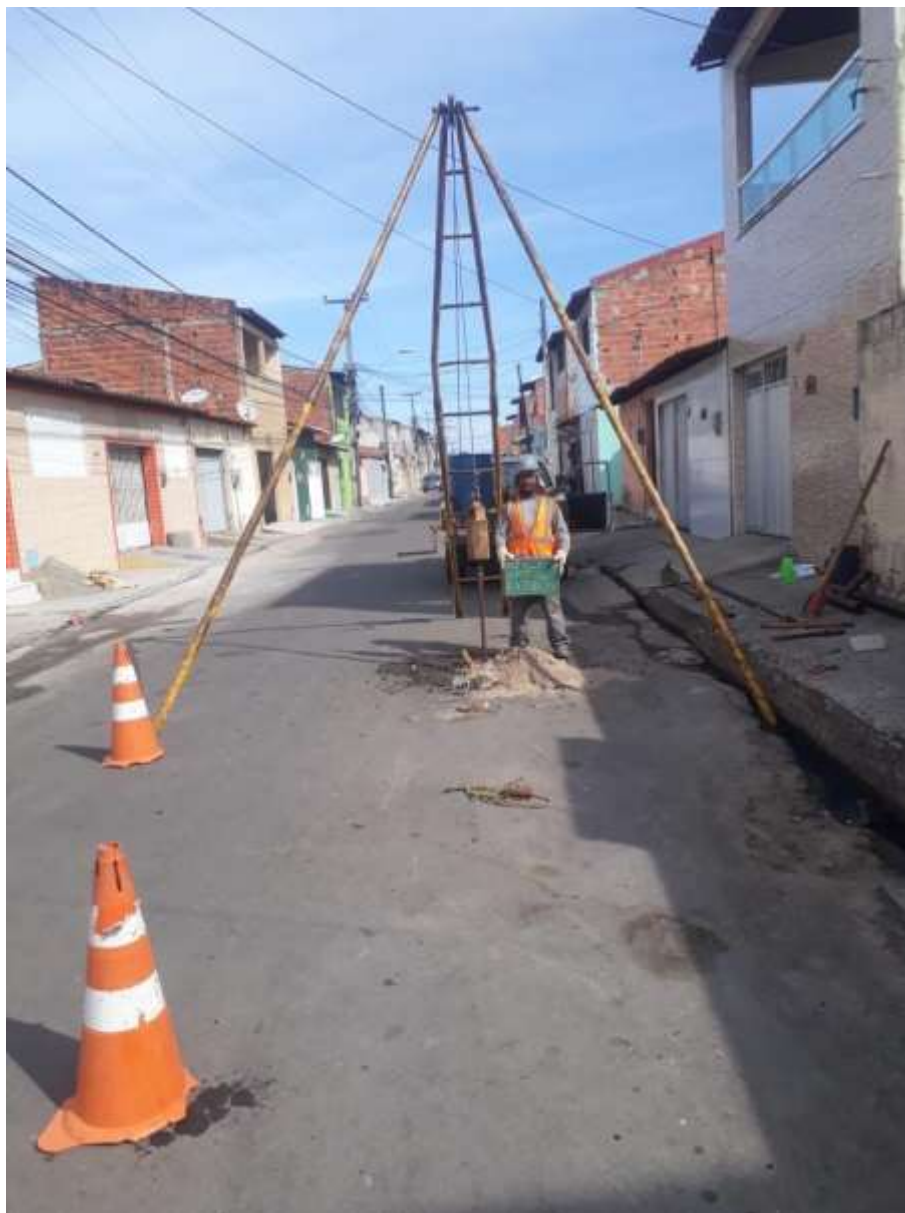
Instalação do furo SP-01
