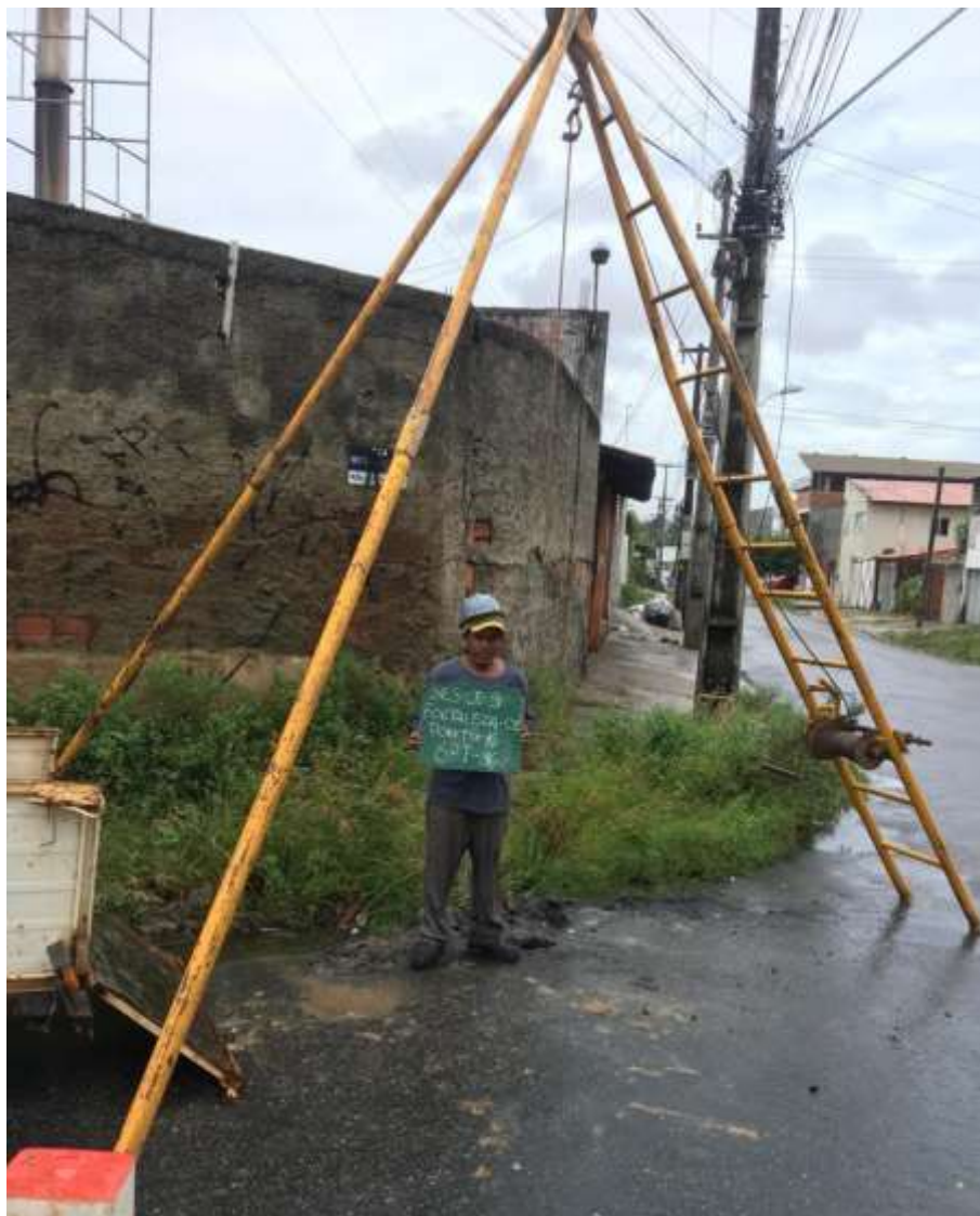
Instalação do furo SP-16
