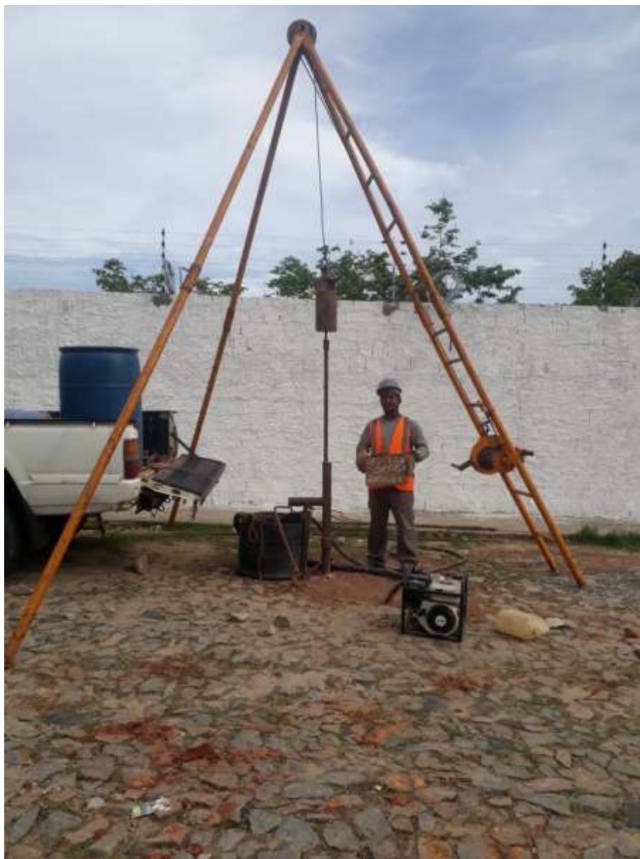
Instalação do furo SP-15 A
