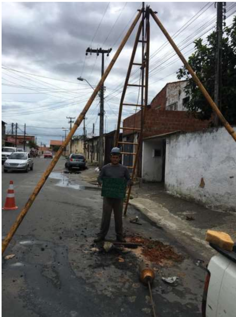
Instalação do furo SP-25
