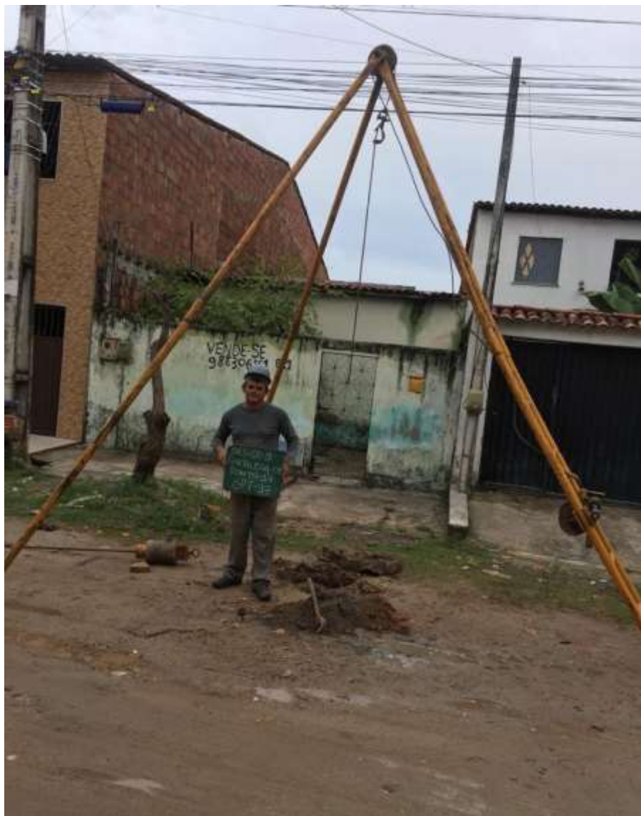
Instalação do furo SP-17
