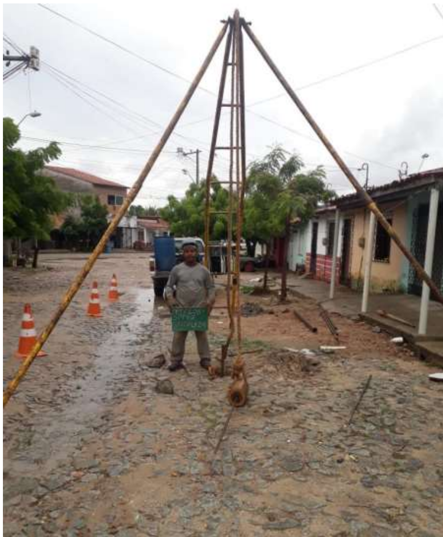
Instalação do furo SP-07
