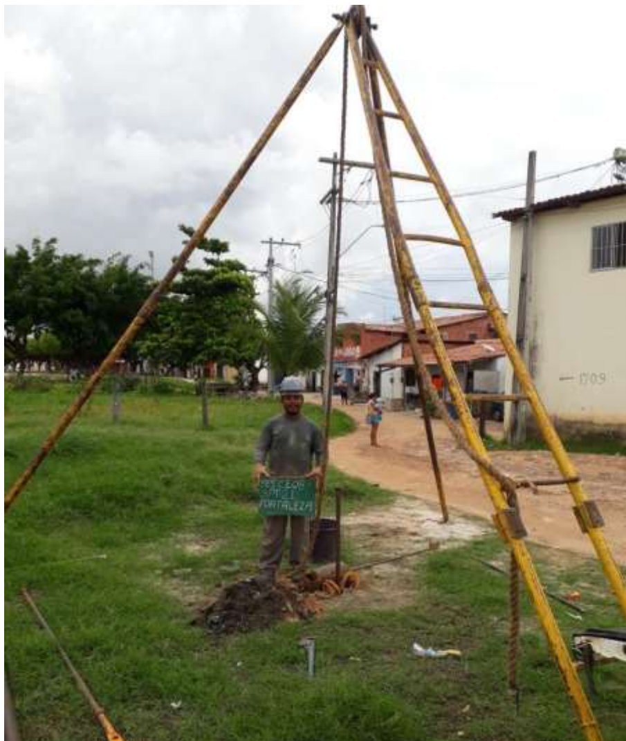
Instalação do furo SP-21
