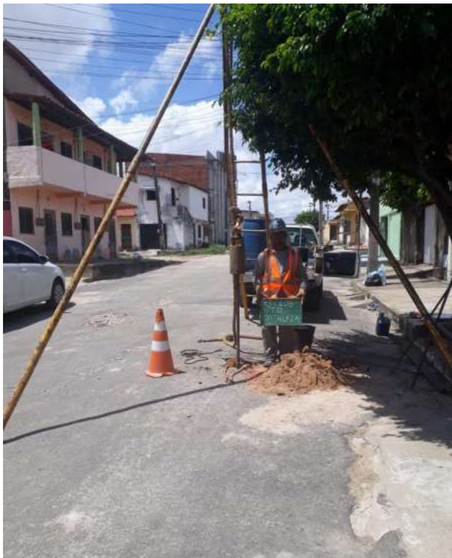
Instalação do furo SP-11
