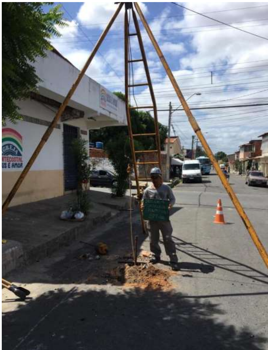
Instalação do furo SP-02
