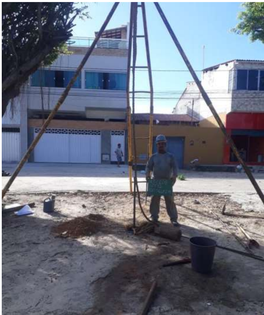
Instalação do furo SP-12
