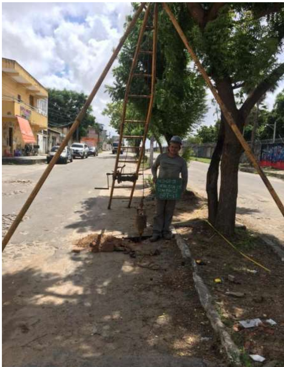
Instalação do furo SP-18
