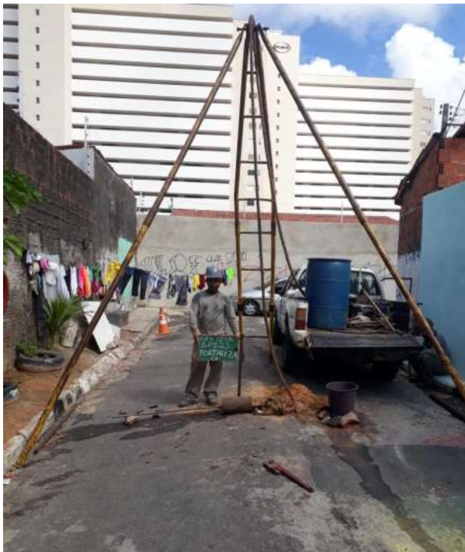
Instalação do furo SP-23
