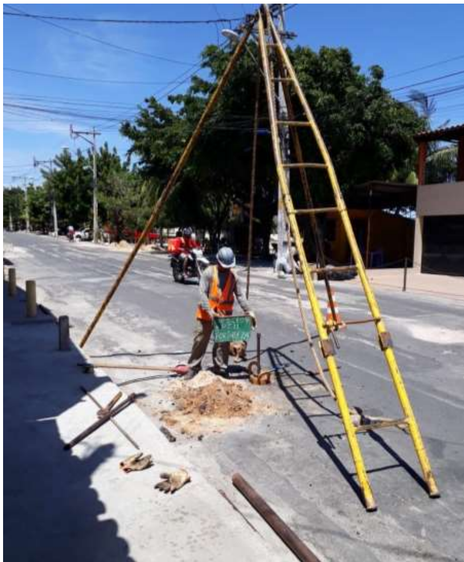
Instalação do furo SP-11
