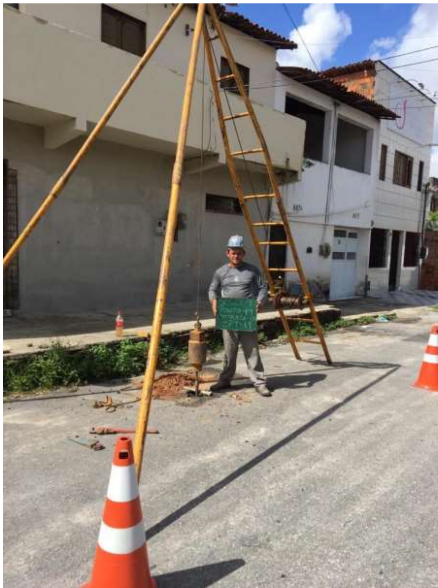
Instalação do furo SP-19
