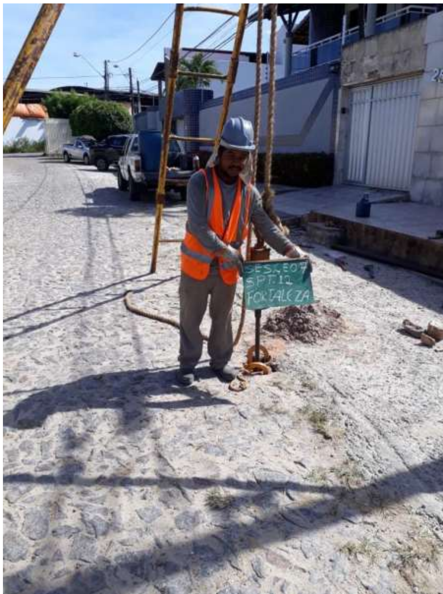
Instalação do furo SP-12
