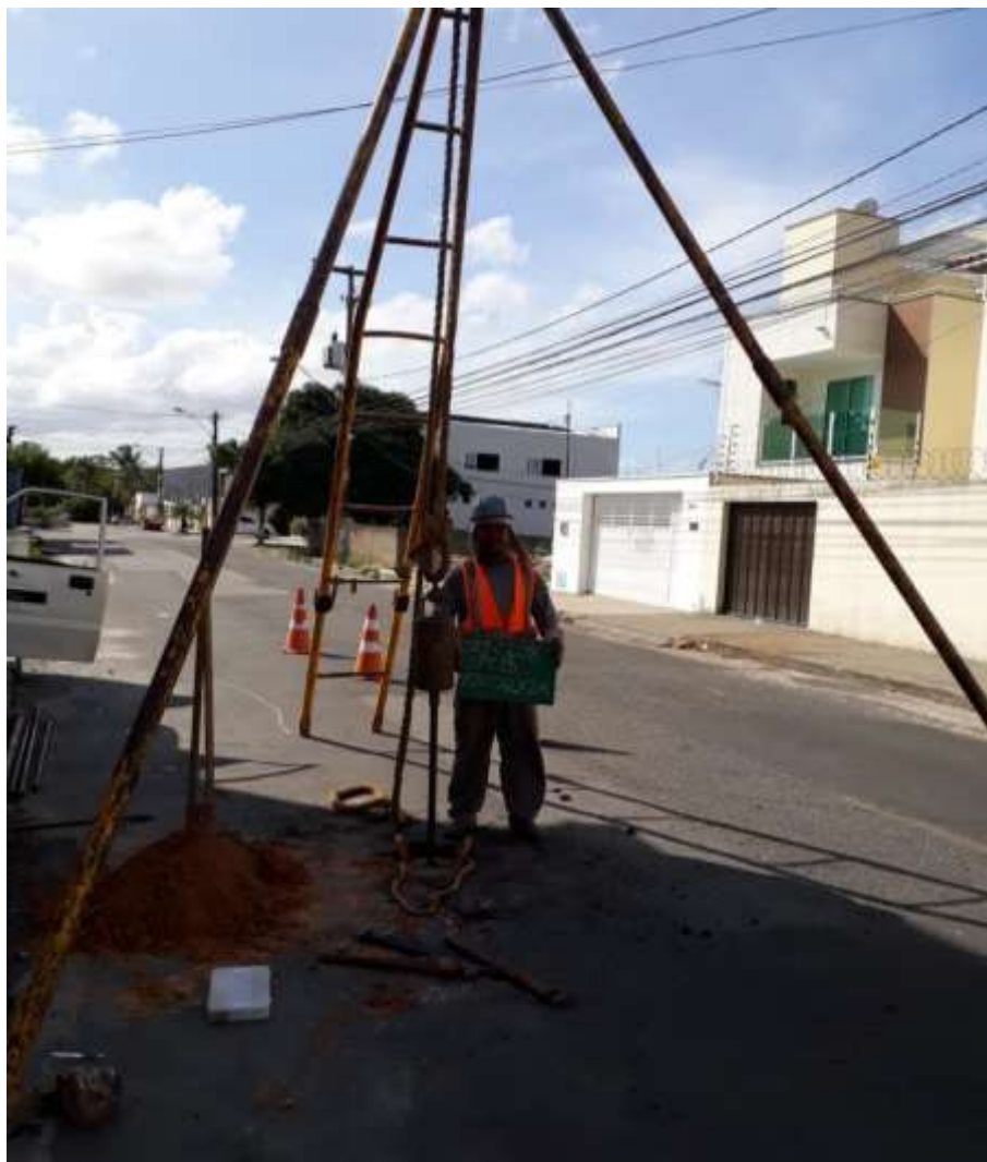
Instalação do furo SP-15
