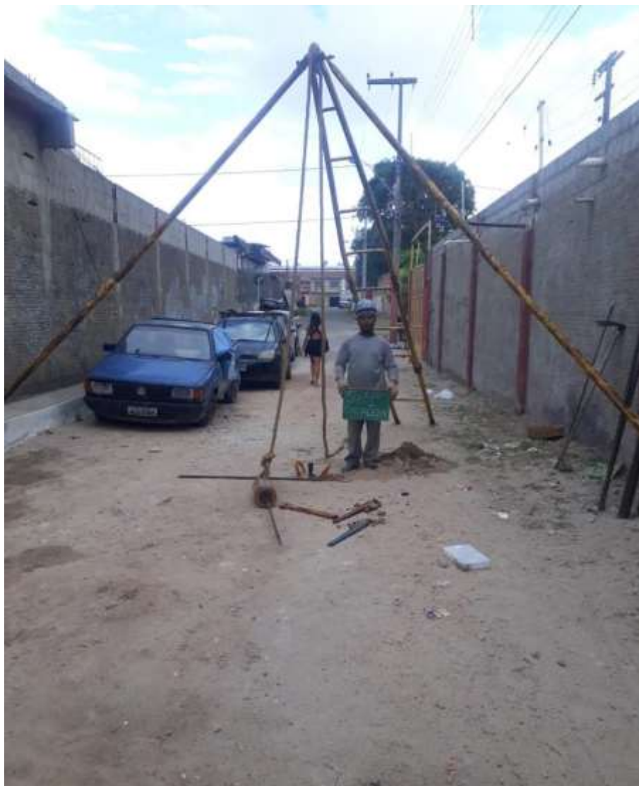
Instalação do furo SP-02
