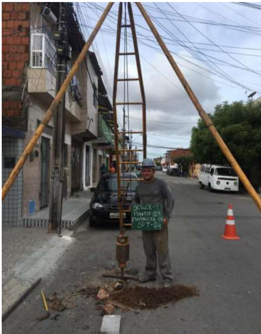
Instalação do furo SP-24
