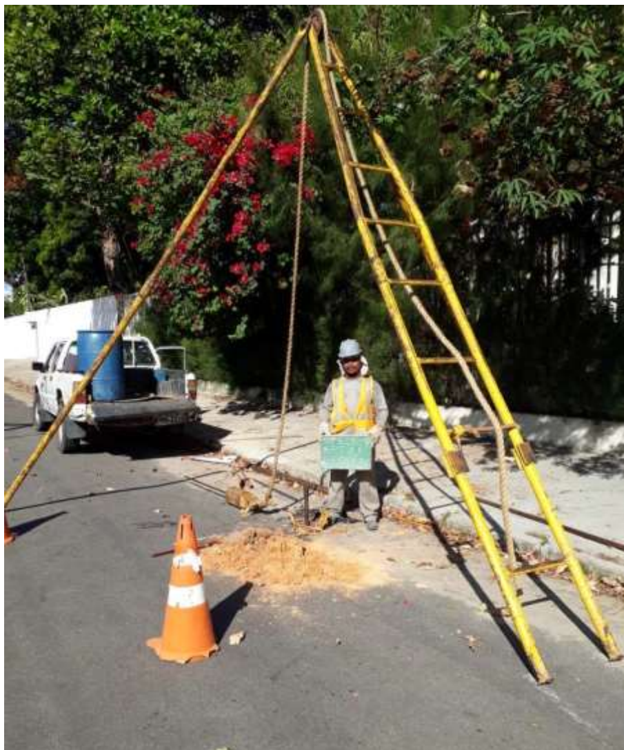
Instalação do furo SP-08
