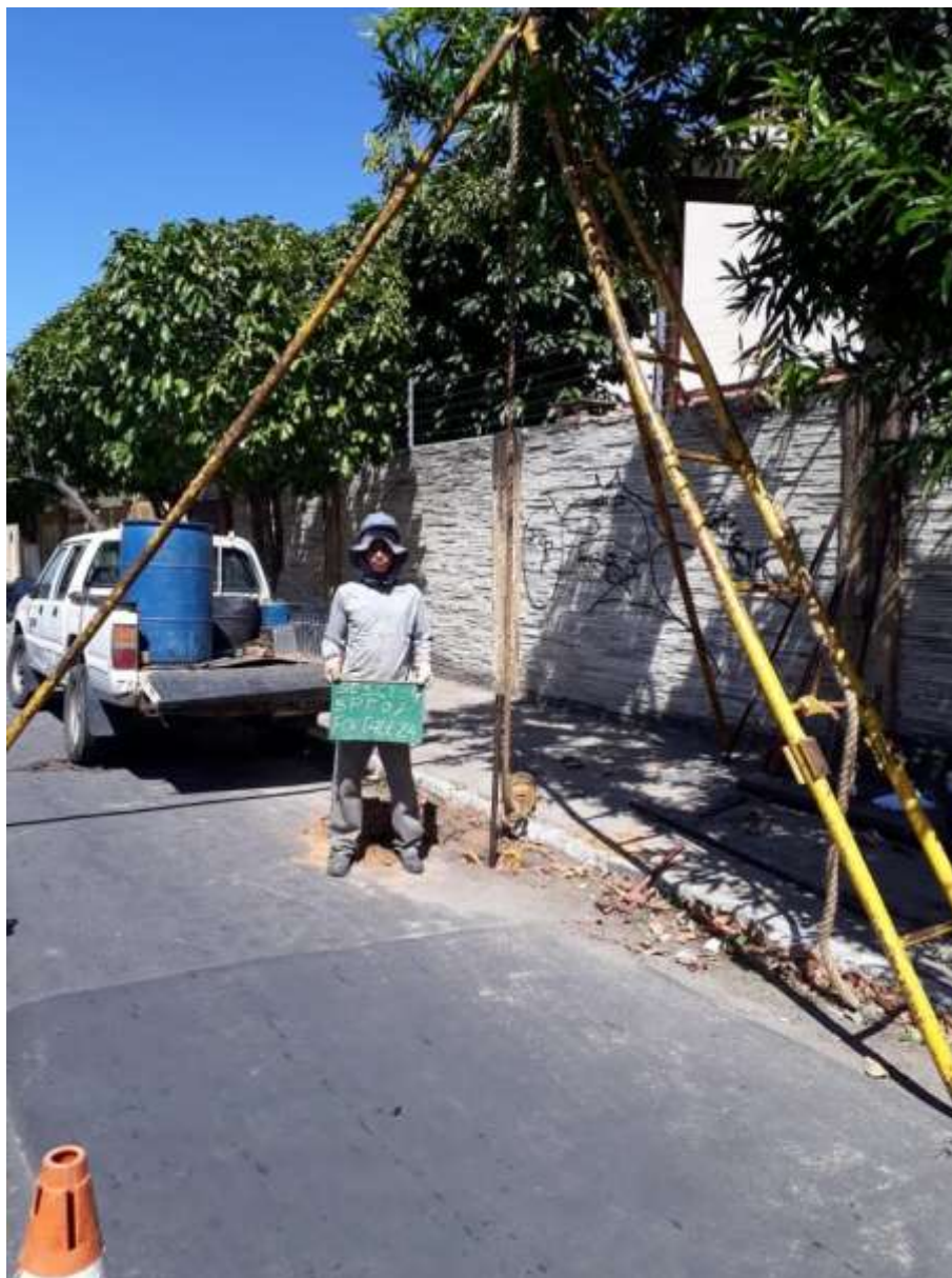
Instalação do furo SP-07
