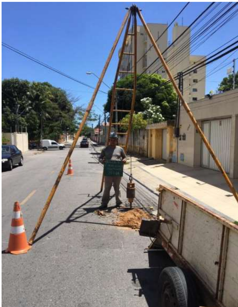
Instalação do furo SP-07
