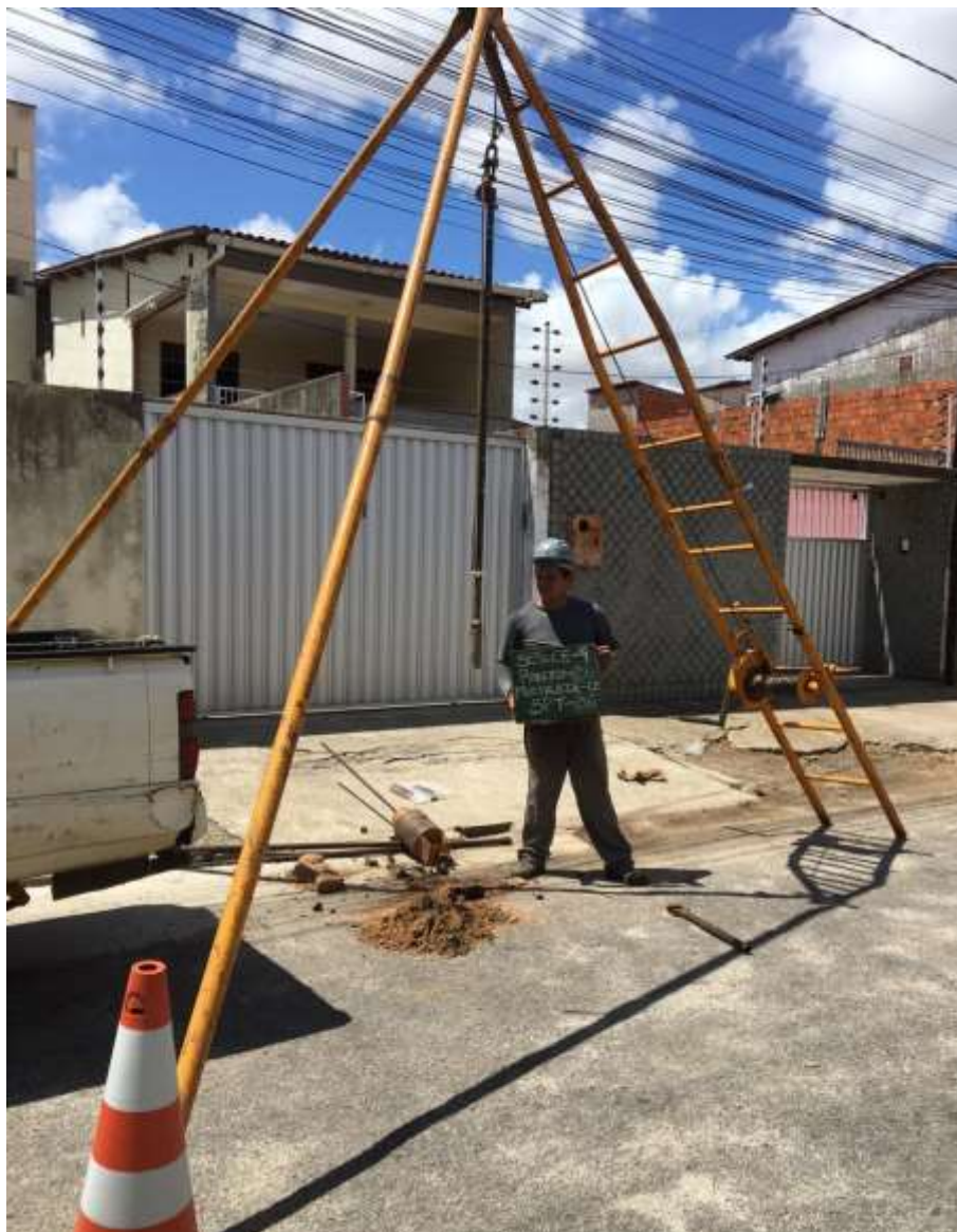
Instalação do furo SP-36
