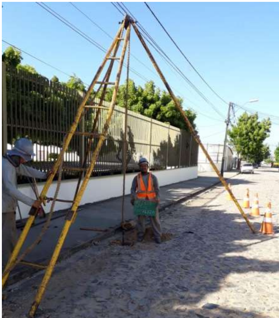
Instalação do furo SP-01
