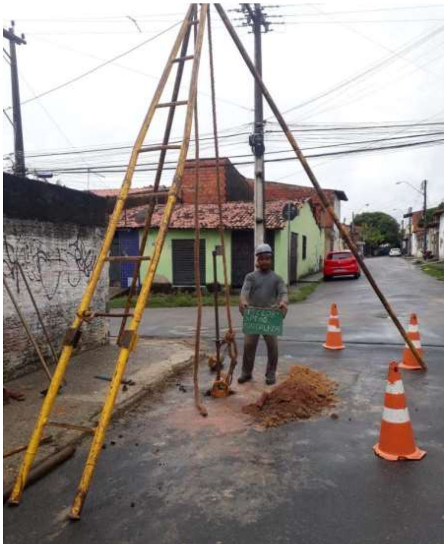
Instalação do furo SP-06
