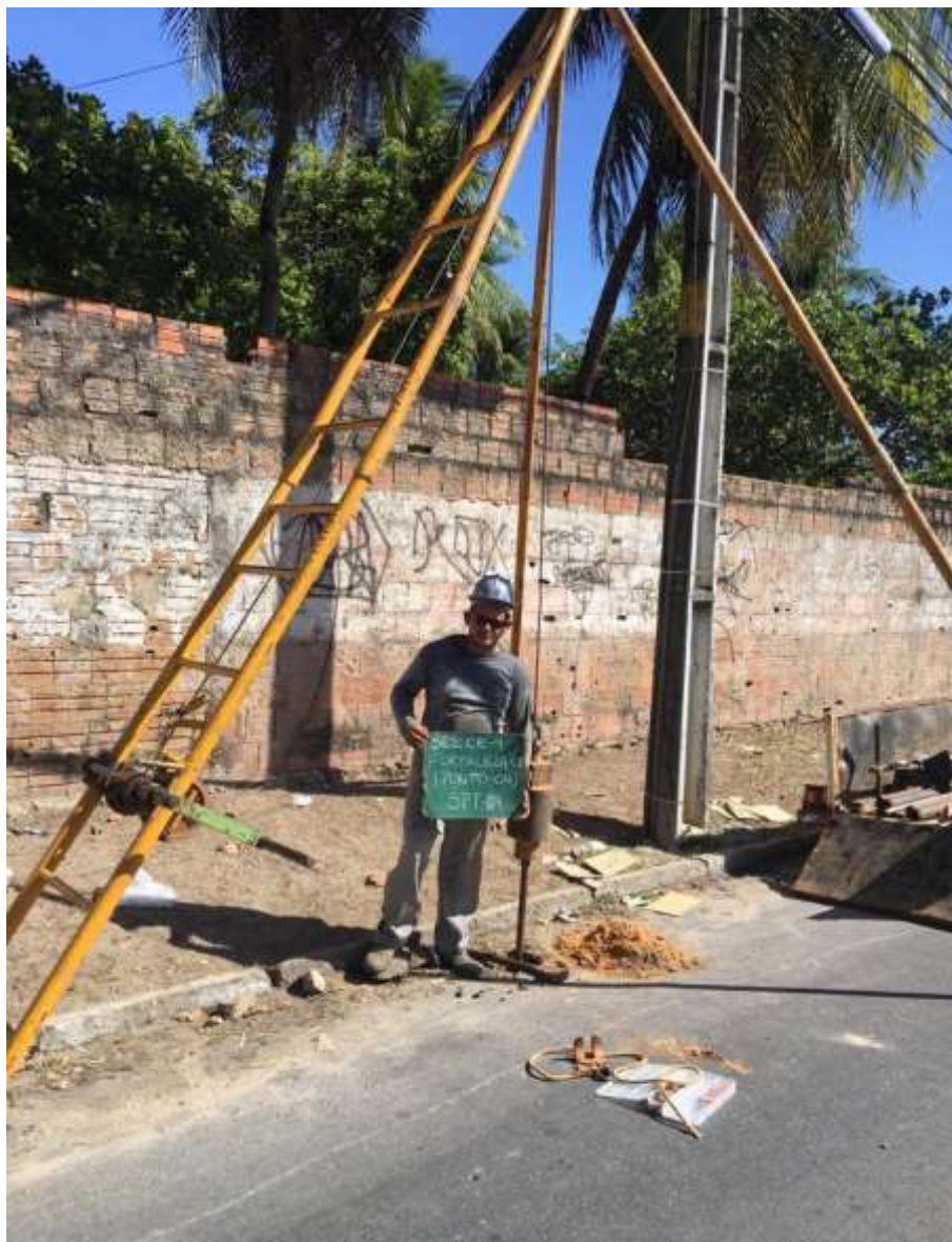
Instalação do furo SP-04
