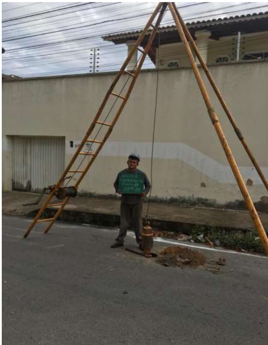
Instalação do furo SP-14
