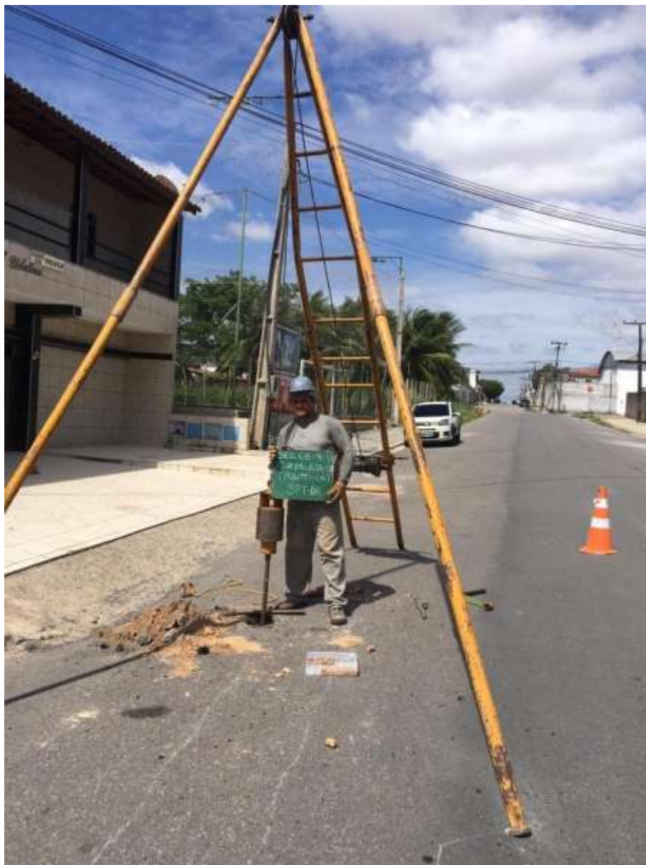
Instalação do furo SP-06
