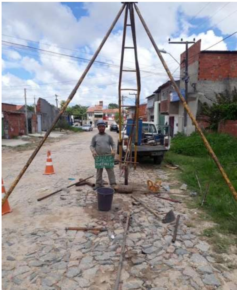
Instalação do furo SP-22
