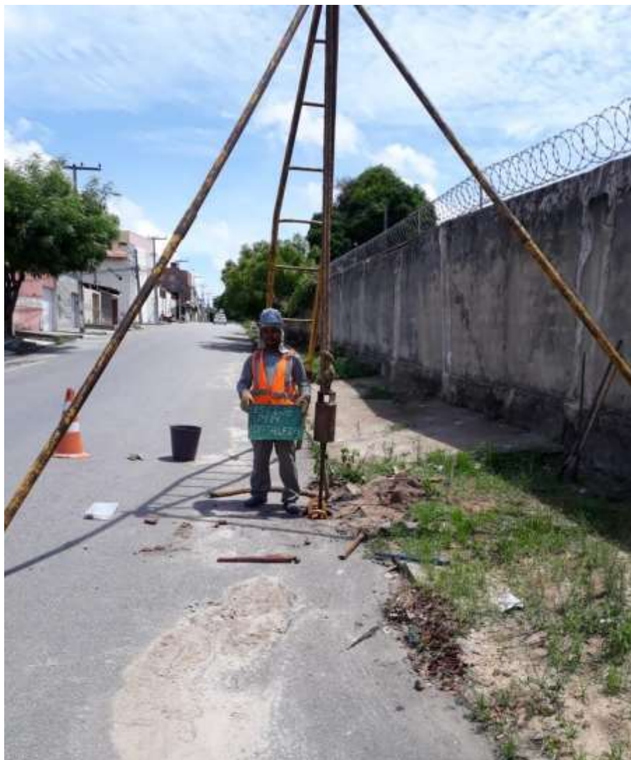
Instalação do furo SP-14
