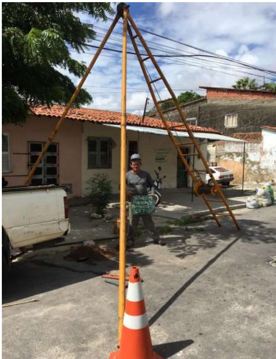
Instalação do furo SP-35
