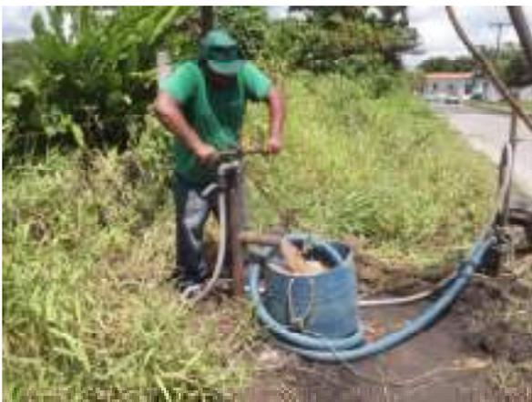
**FOTO 53:** Detalhe da operação de lavagem do furo SP-02 da Travessia do plano CE-07.
