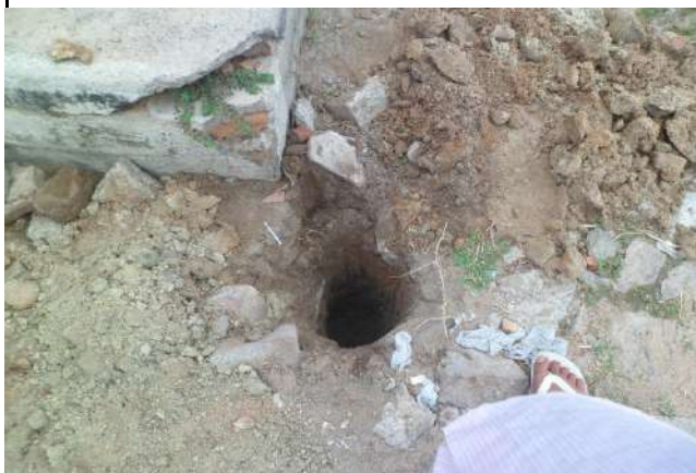
FURO 49 - SONDAGENS NAS RUAS DE CRATEÚS
