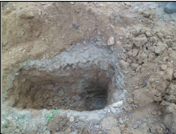
FURO 150 - SONDAGENS NAS RUAS DE CRATEÚS
