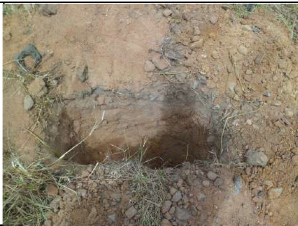
FURO 142 - SONDAGENS NAS RUAS DE CRATEÚS
