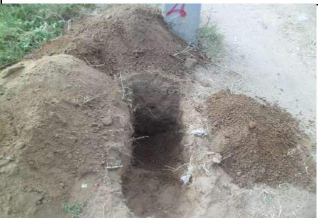
FURO 38 - SONDAGENS NAS RUAS DE CRATEÚS
