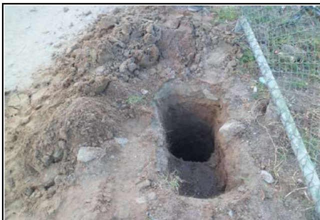
FURO 45 - SONDAGENS NAS RUAS DE CRATEÚS
