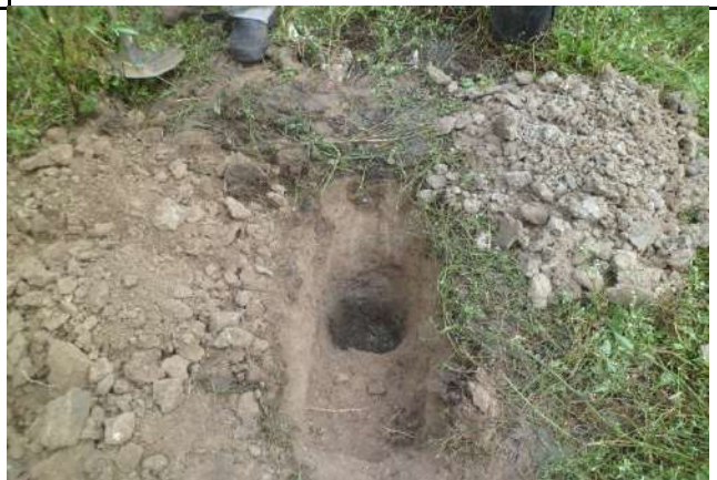
FURO 38 - SONDAGENS NA LAGOA
