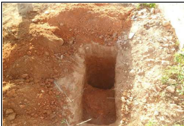
FURO 79 - SONDAGENS NAS RUAS DE CRATEÚS
