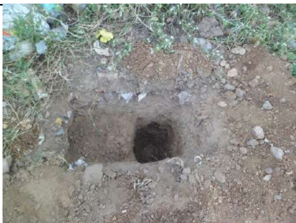
FURO 112 - SONDAGENS NAS RUAS DE CRATEÚS
