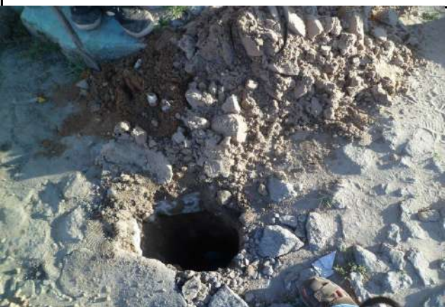
FURO 42 - SONDAGENS NAS RUAS DE CRATEÚS
