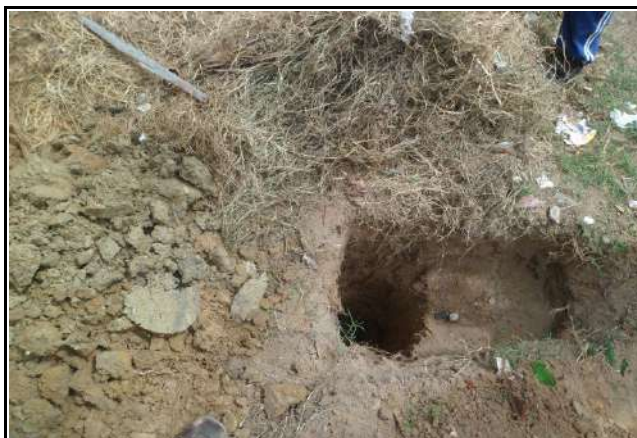
FURO 31 - SONDAGENS NAS RUAS DE CRATEÚS
