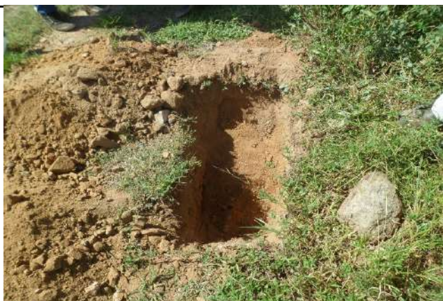
FURO 19 - SONDAGENS NAS RUAS DE CRATEÚS
