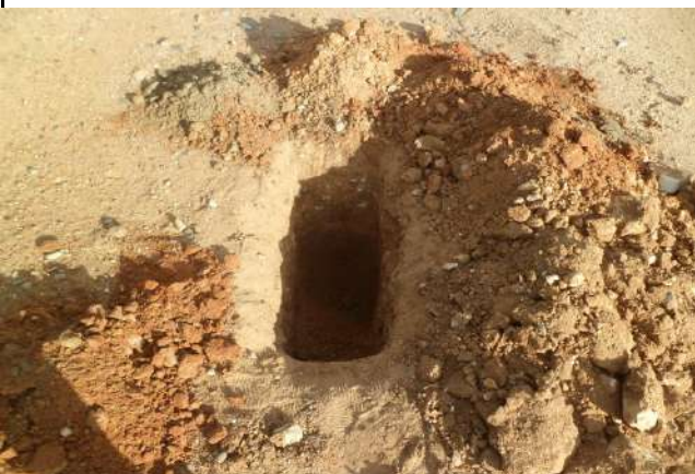
FURO 71 - SONDAGENS NAS RUAS DE CRATEÚS
