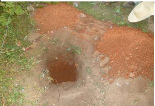
FURO 14 - SONDAGENS NAS RUAS DE CRATEÚS
