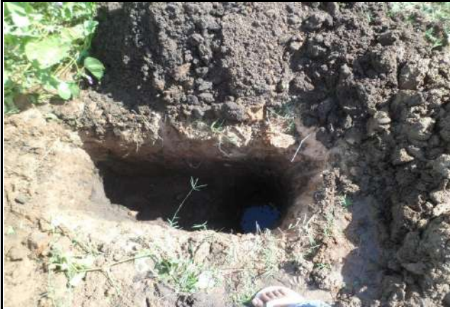
FURO 01 - SONDAGENS NA LAGOA
