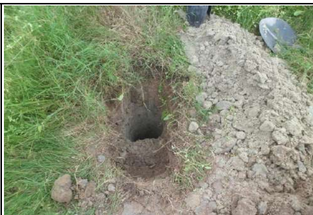
FURO 32 - SONDAGENS NAS RUAS DE CRATEÚS
