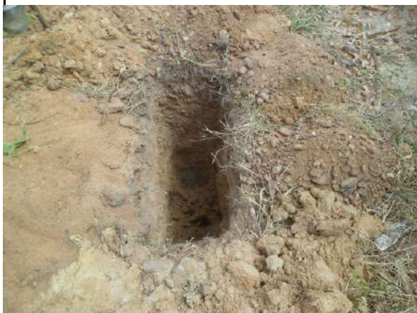
FURO 143 - SONDAGENS NAS RUAS DE CRATEÚS
