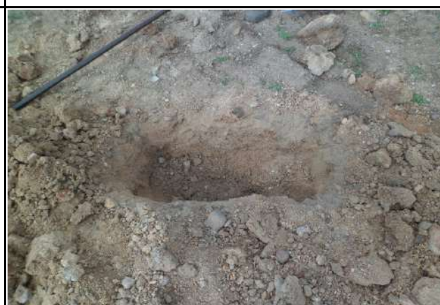
FURO 137 - SONDAGENS NAS RUAS DE CRATEÚS
