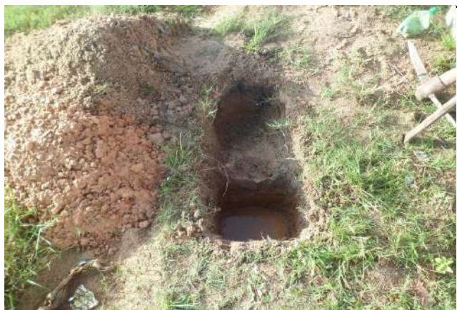
FURO 18 - SONDAGENS NAS RUAS DE CRATEÚS
