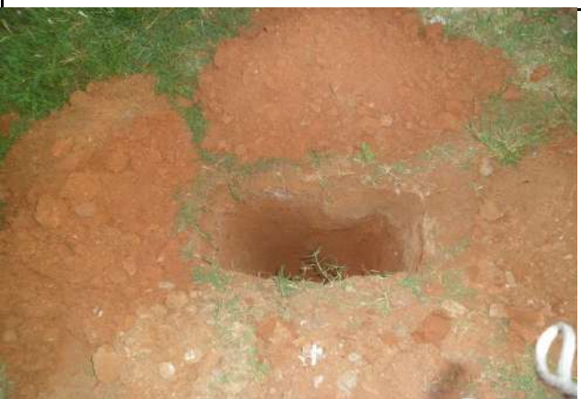
FURO 76 - SONDAGENS NAS RUAS DE CRATEÚS
