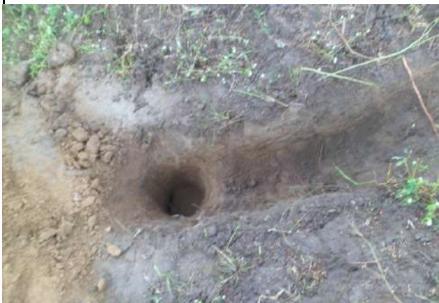
FURO 43 - SONDAGENS NA LAGOA
