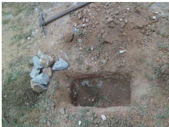
FURO 111 - SONDAGENS NAS RUAS DE CRATEÚS
