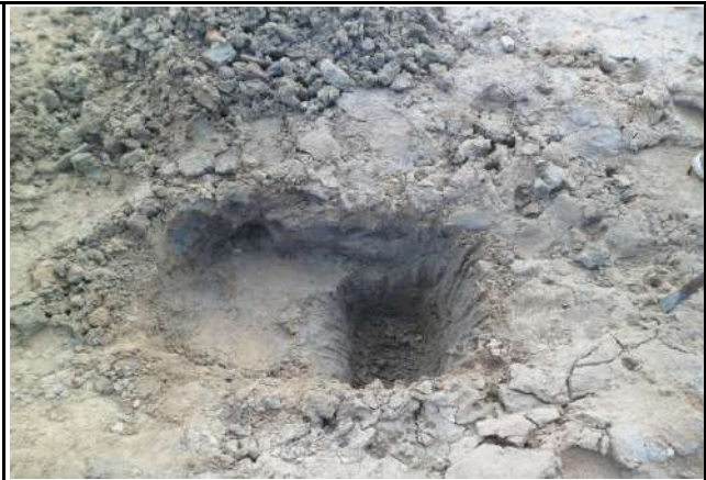
FURO 02 - SONDAGENS NAS RUAS DE CRATEÚS
