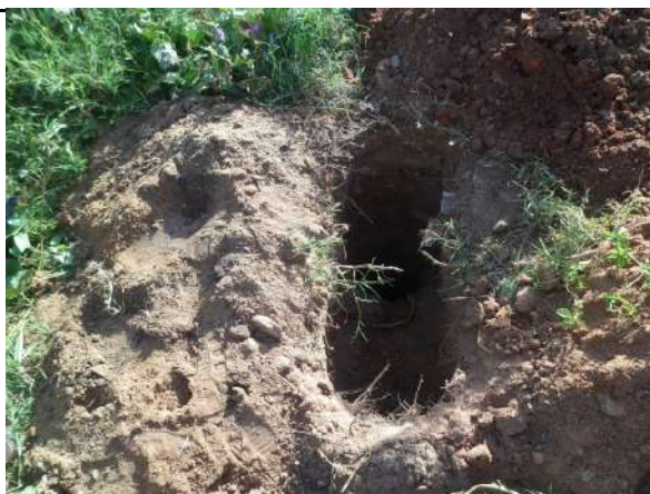
FURO 130 - SONDAGENS NAS RUAS DE CRATEÚS
