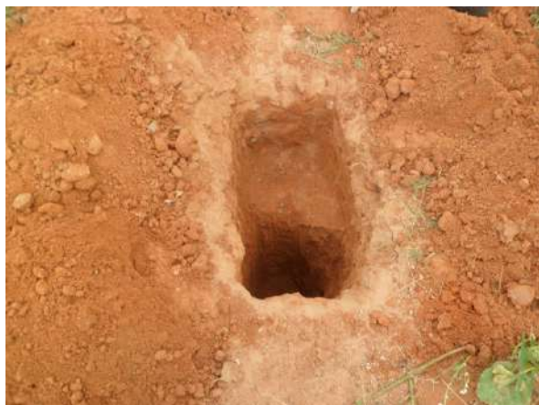
FURO 127 - SONDAGENS NAS RUAS DE CRATEÚS
