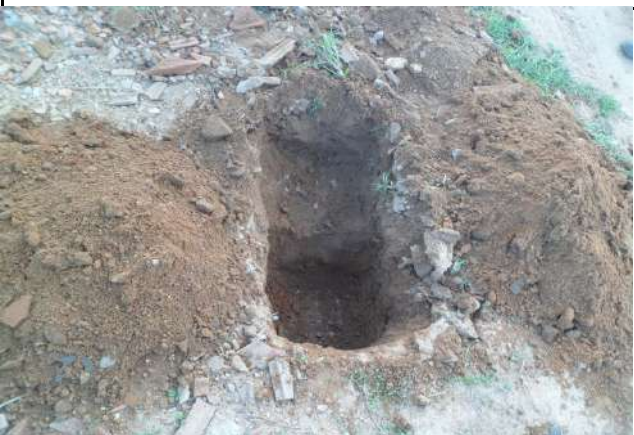
FURO 12 - SONDAGENS NAS RUAS DE CRATEÚS
