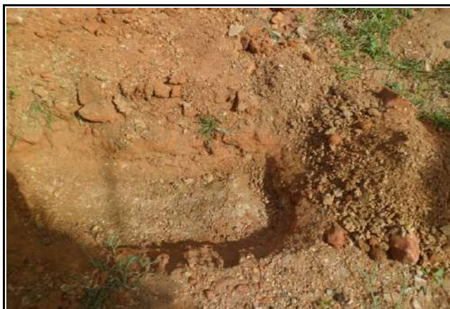
FURO 97 - SONDAGENS NAS RUAS DE CRATEÚS
