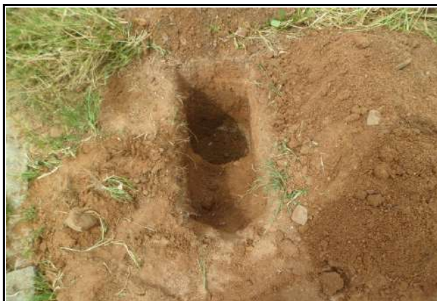
FURO 61 - SONDAGENS NAS RUAS DE CRATEÚS
