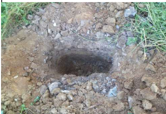
FURO 73 - SONDAGENS NAS RUAS DE CRATEÚS
