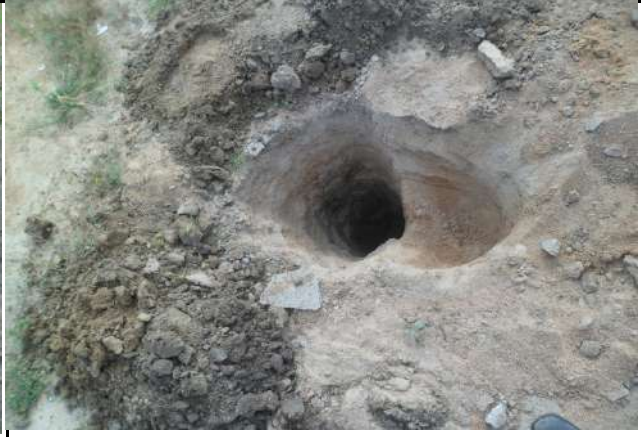
FURO 23 - SONDAGENS NA LAGOA
