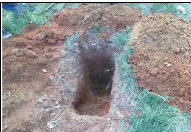
FURO 66 - SONDAGENS NAS RUAS DE CRATEÚS
