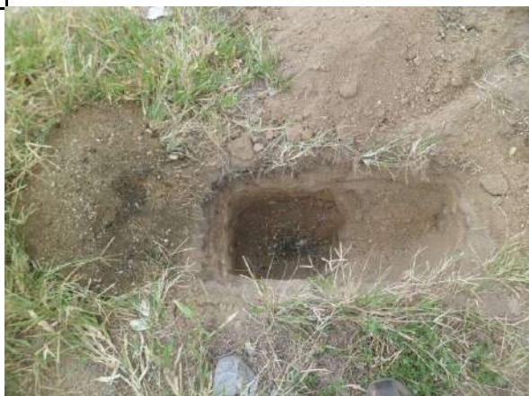
FURO 116 - SONDAGENS NAS RUAS DE CRATEÚS
