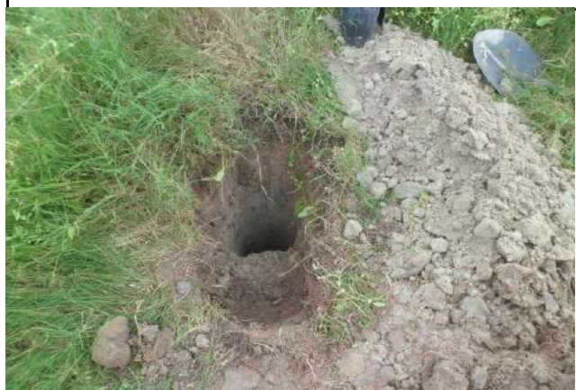
FURO 26 - SONDAGENS NAS RUAS DE CRATEÚS
