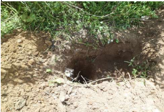
FURO 36 - SONDAGENS NA LAGOA
