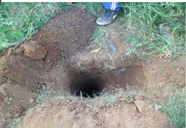
FURO 105 - SONDAGENS NAS RUAS DE CRATEÚS
