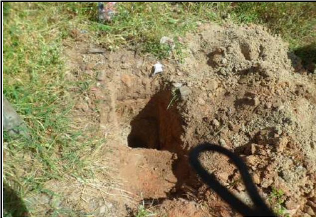
FURO 01 - SONDAGENS NAS RUAS DE CRATEÚS
