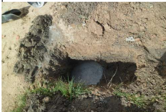
FURO 23 - SONDAGENS NAS RUAS DE CRATEÚS
