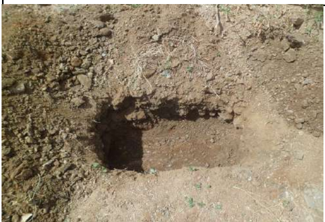
FURO 91 - SONDAGENS NAS RUAS DE CRATEÚS
