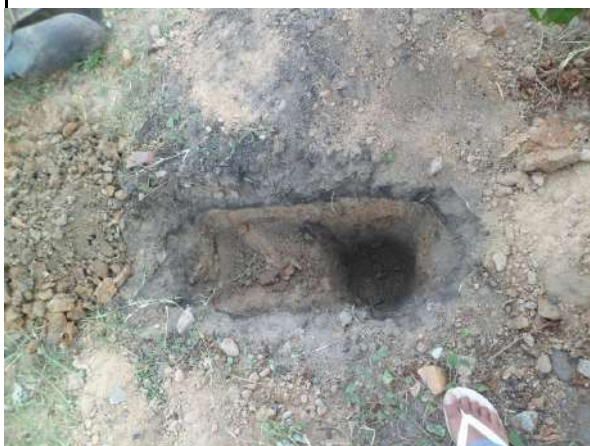
FURO 147 - SONDAGENS NAS RUAS DE CRATEÚS
