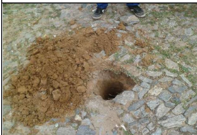
FURO 34 - SONDAGENS NAS RUAS DE CRATEÚS
