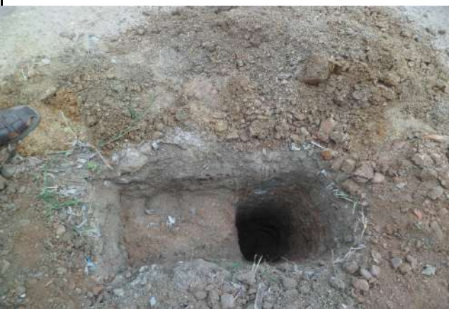
FURO 109 - SONDAGENS NAS RUAS DE CRATEÚS
