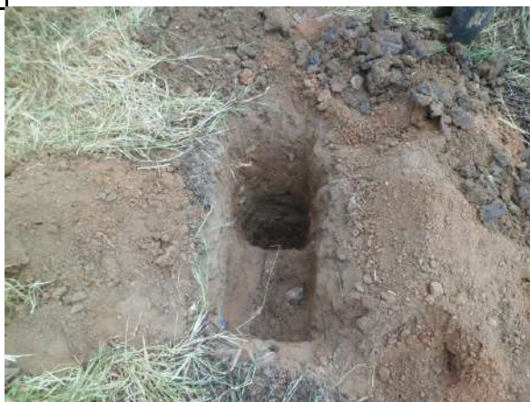
FURO 146 - SONDAGENS NAS RUAS DE CRATEÚS
