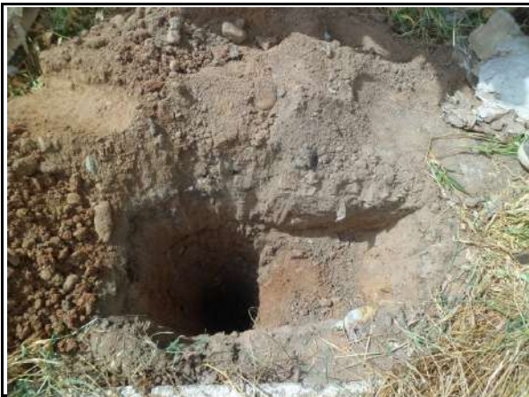
FURO 140 - SONDAGENS NAS RUAS DE CRATEÚS
