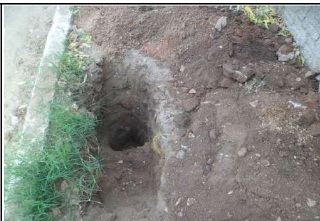
FURO 47 - SONDAGENS NAS RUAS DE CRATEÚS
