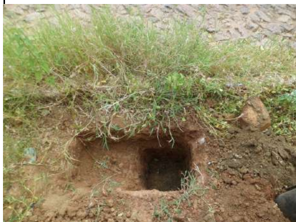
FURO 120 - SONDAGENS NAS RUAS DE CRATEÚS
