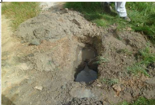
FURO 25 - SONDAGENS NAS RUAS DE CRATEÚS
