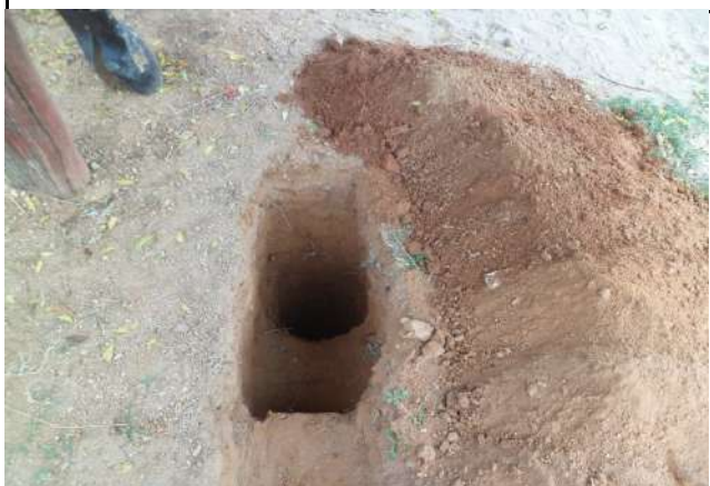
FURO 54 - SONDAGENS NAS RUAS DE CRATEÚS
