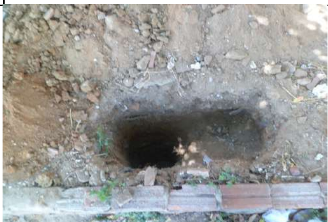
FURO 30 - SONDAGENS NAS RUAS DE CRATEÚS
