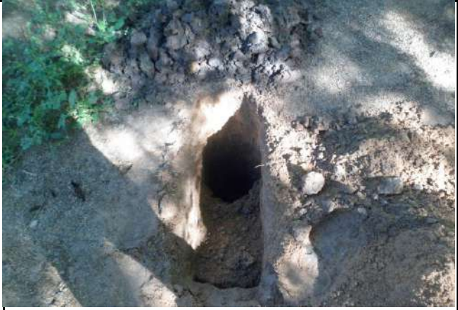
FURO 06 - SONDAGENS NA LAGOA
