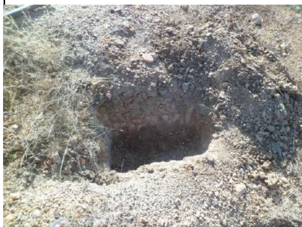
FURO 131 - SONDAGENS NAS RUAS DE CRATEÚS
