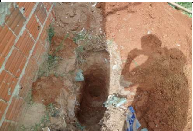
FURO 88 - SONDAGENS NAS RUAS DE CRATEÚS
