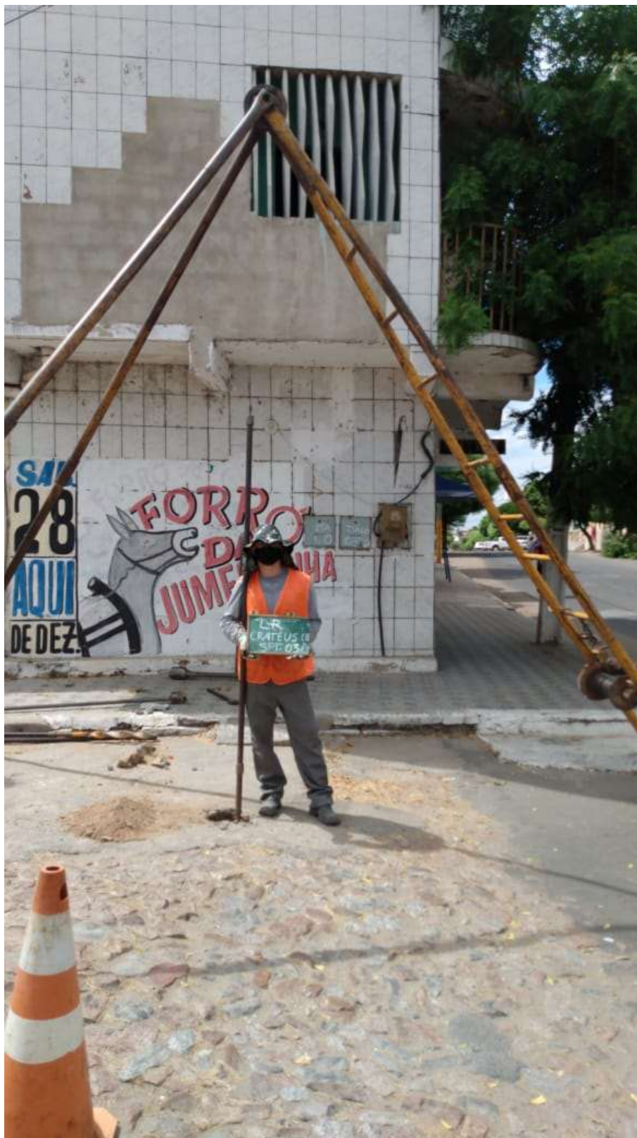
Instalação do furo SPT-03 A
