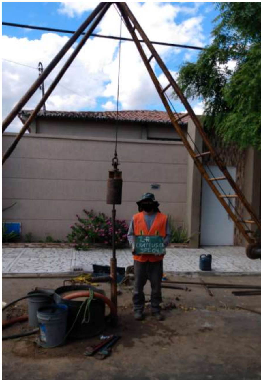
Instalação do furo SPT-04
