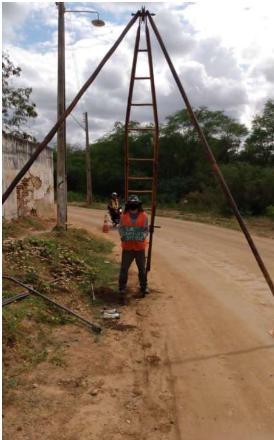
Instalação do furo SPT-02 A
