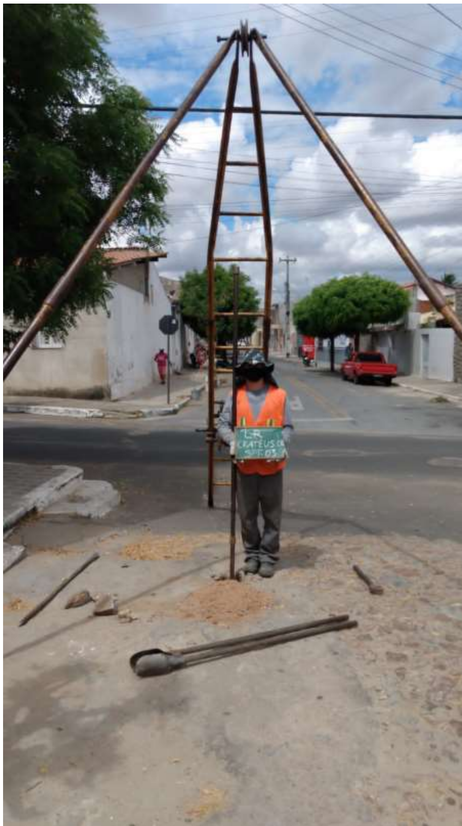
Instalação do furo SPT-03
