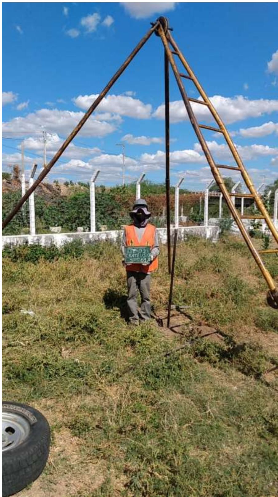
Instalação do furo SPT-01 A
