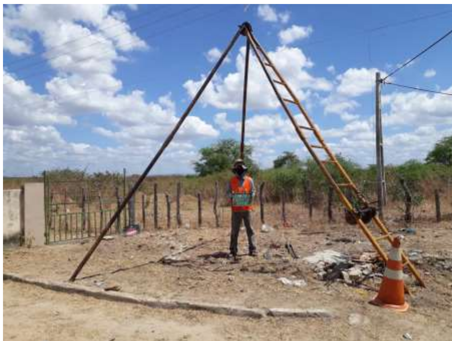
Instalação do furo SPT-02 A
