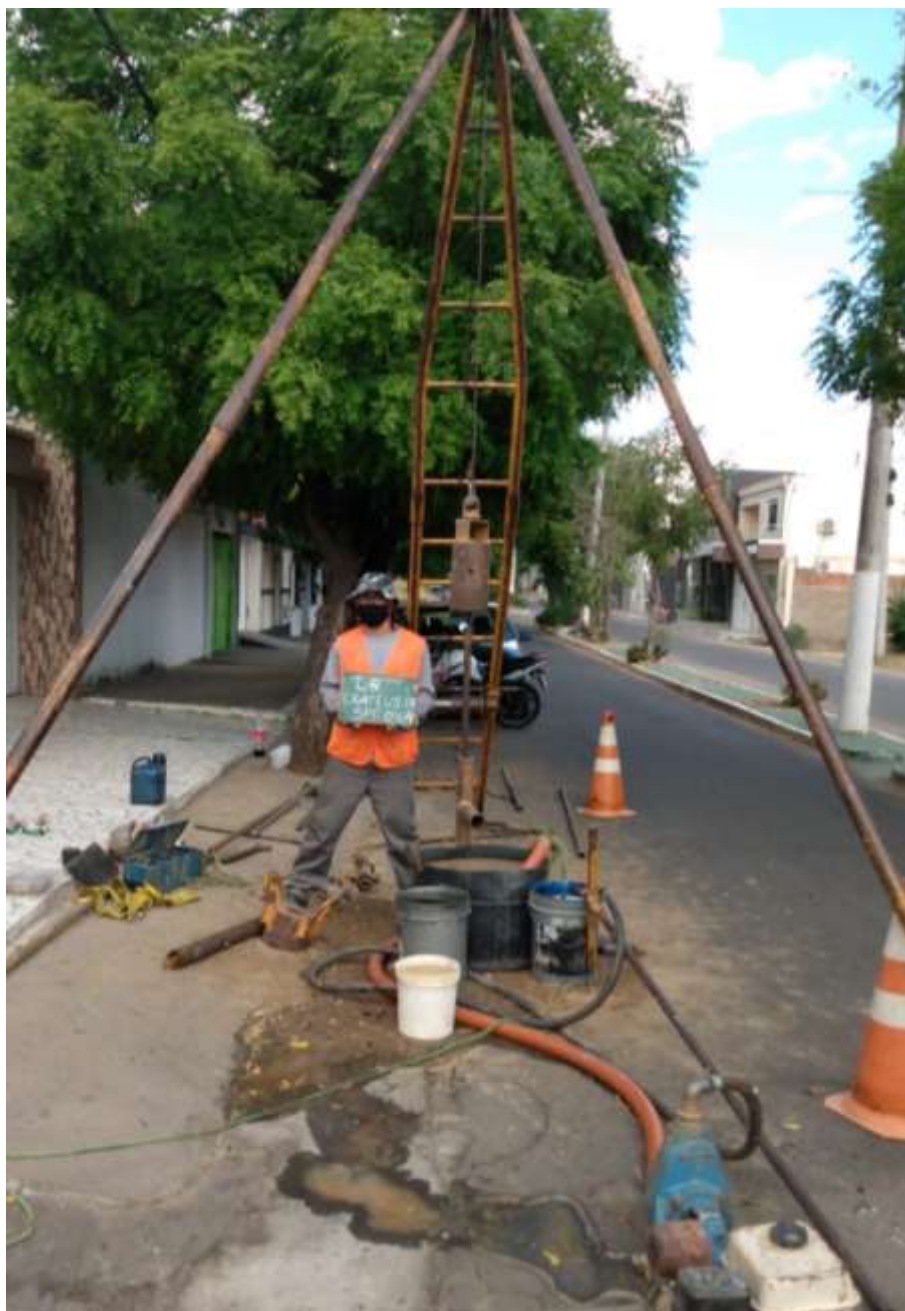
Instalação do furo SPT-04 A
