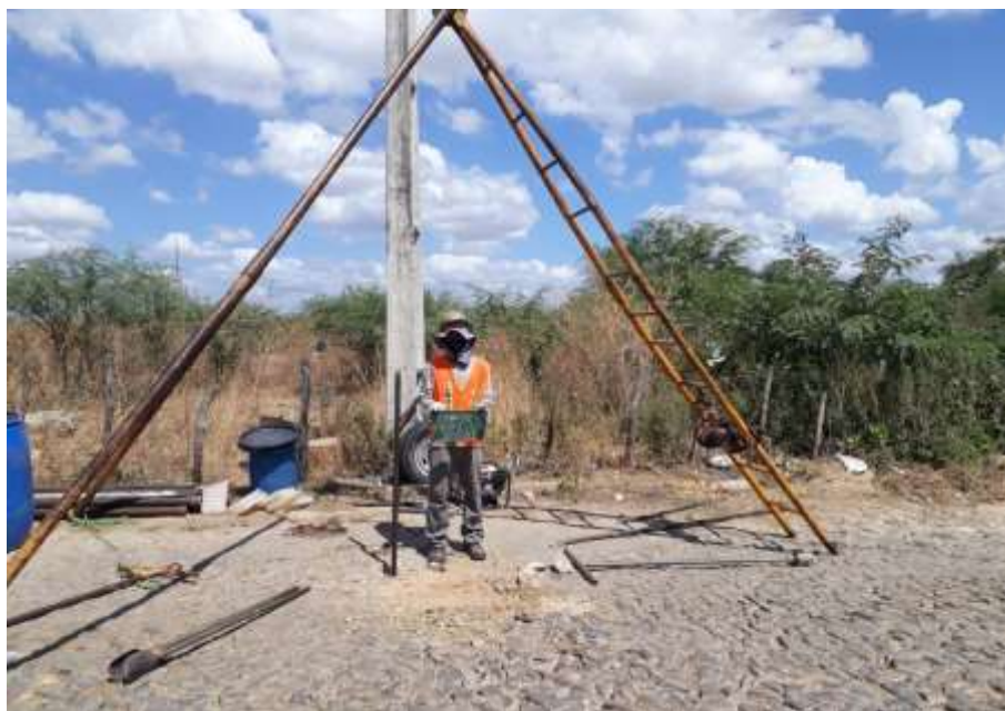
Instalação do furo SPT-01
