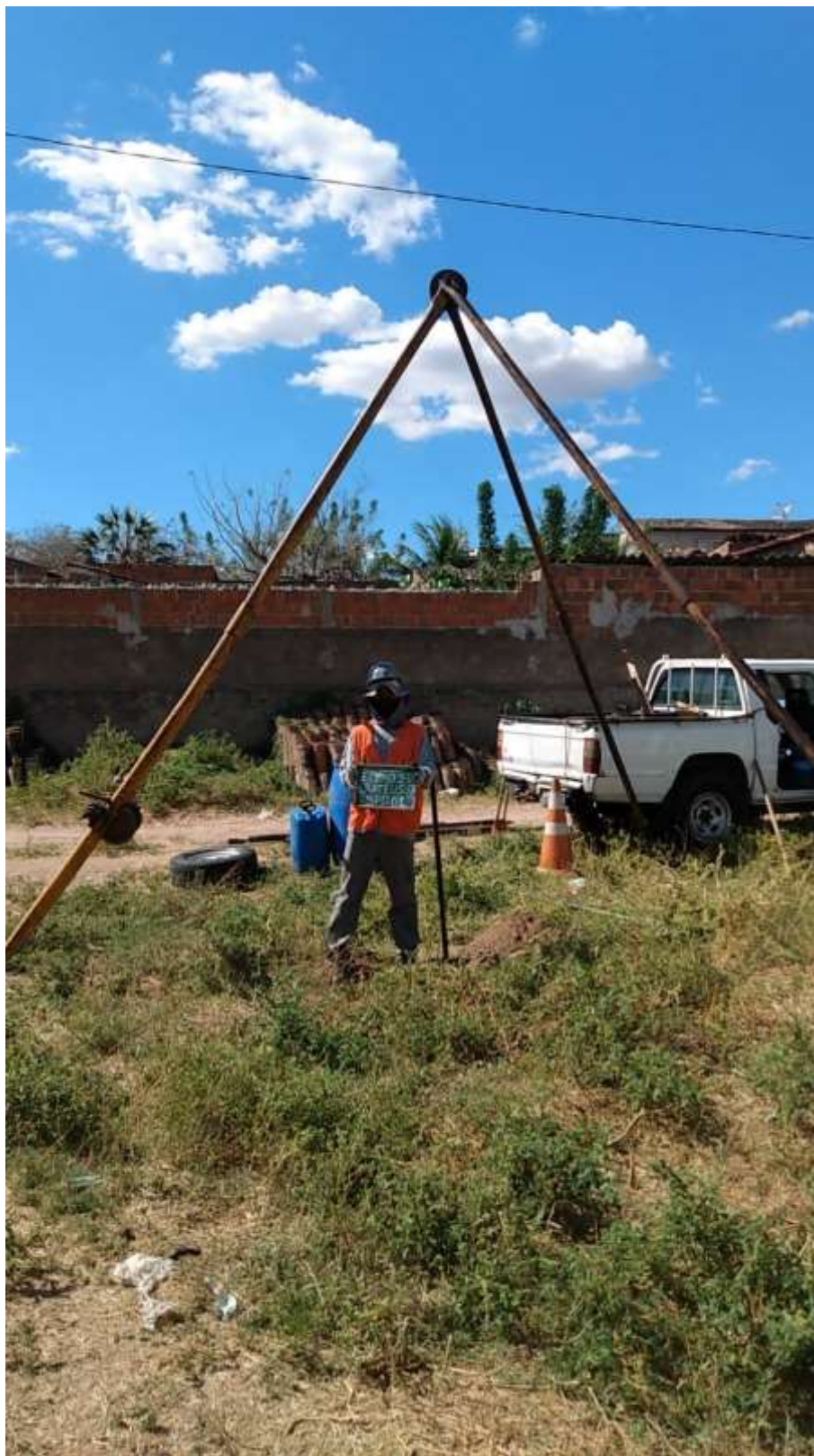
Instalação do furo SPT-01
