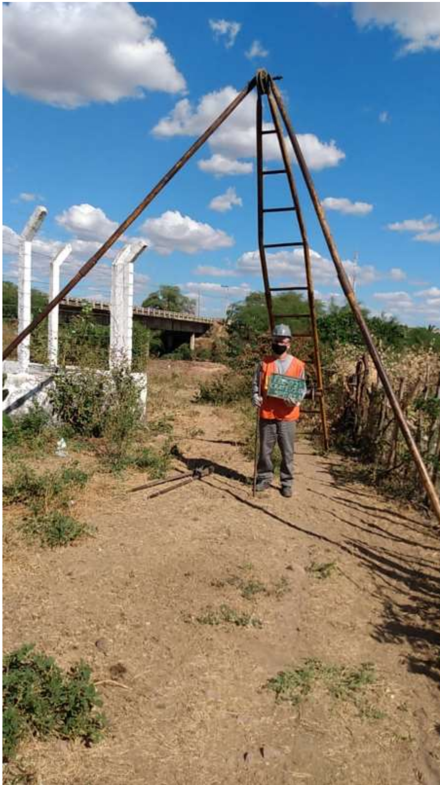
Instalação do furo SPT-02 A
