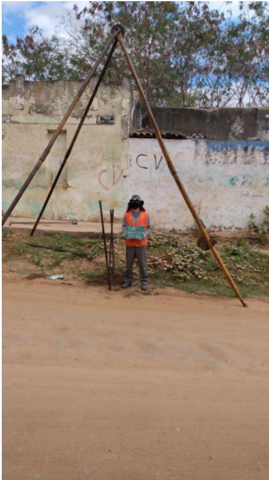
Instalação do furo SPT-02
