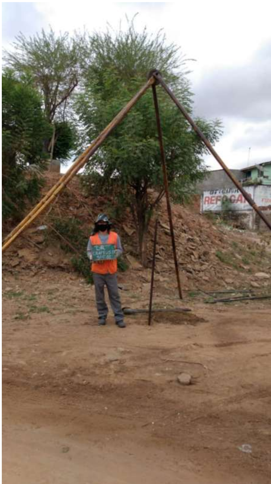
Instalação do furo SPT-01
