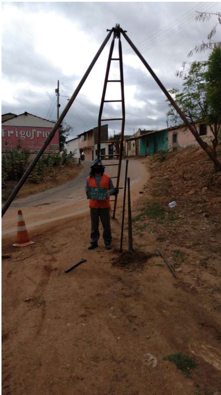
Instalação do furo SPT-01 A
