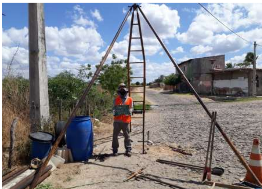
Instalação do furo SPT-01 A
