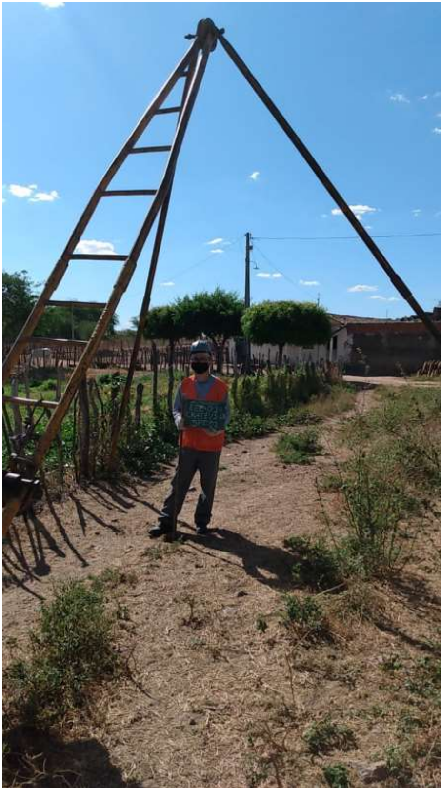
Instalação do furo SPT-02
