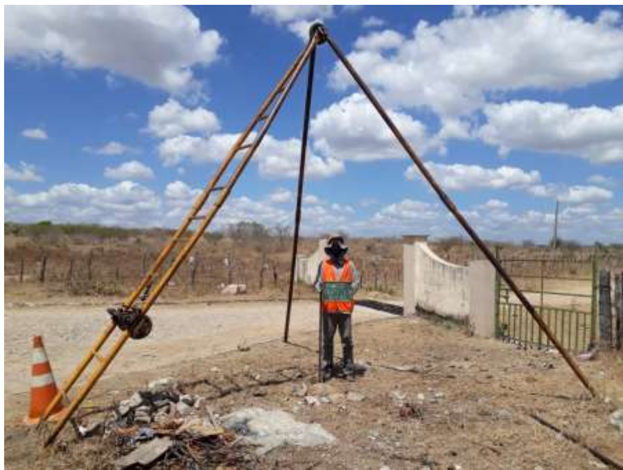
Instalação do furo SPT-02
