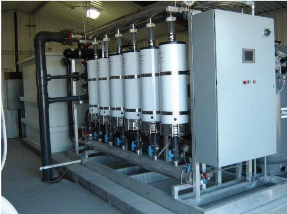
**Figura 04 - Unidade de UF com capacidade de 20 m<sup>3</sup>/h**
