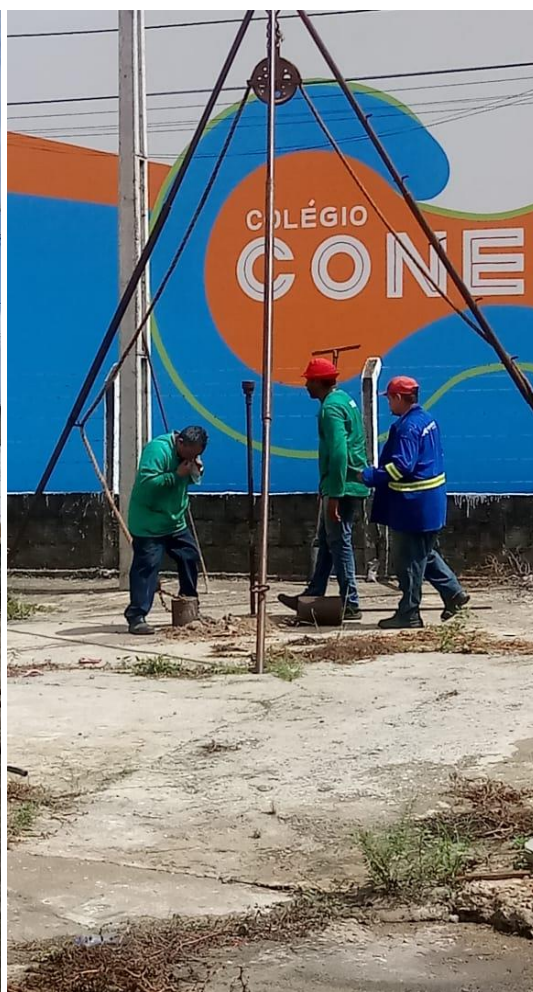
FOTO 04: Detalhe da equipe preparando-se para a realização do furo SP-02 da EEE CE 6.2.
