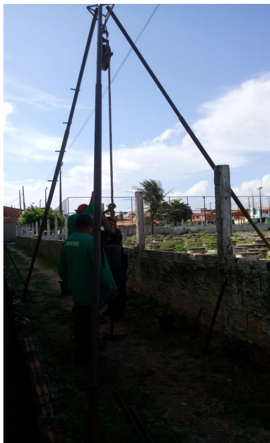
FOTO 02: Detalhe da equipe preparando-se para a realização do furo SP-01 da EEE CE 6.3.
