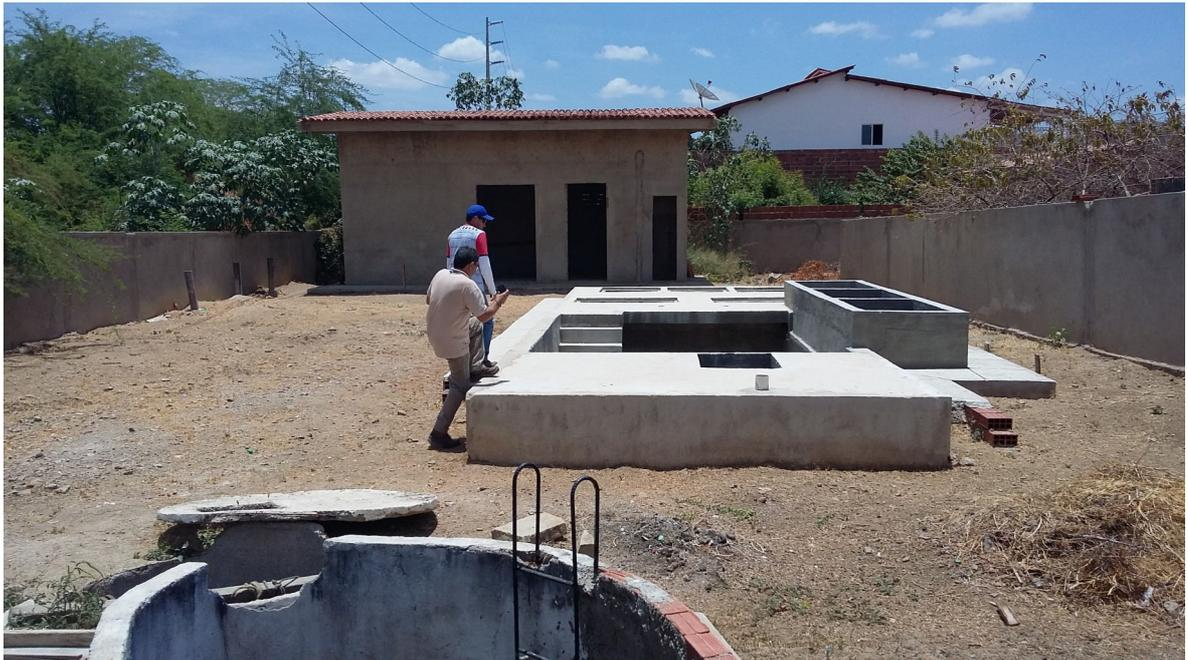
Figura 10: Visão geral da EE-SB3.1 com a parte civil executada.
