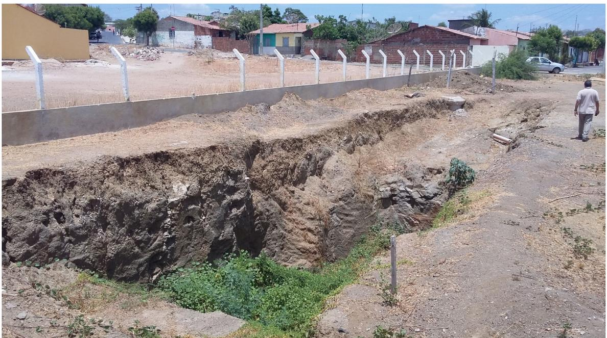
Figura 13: Escavação parcialmente executada na EE-SB4.
