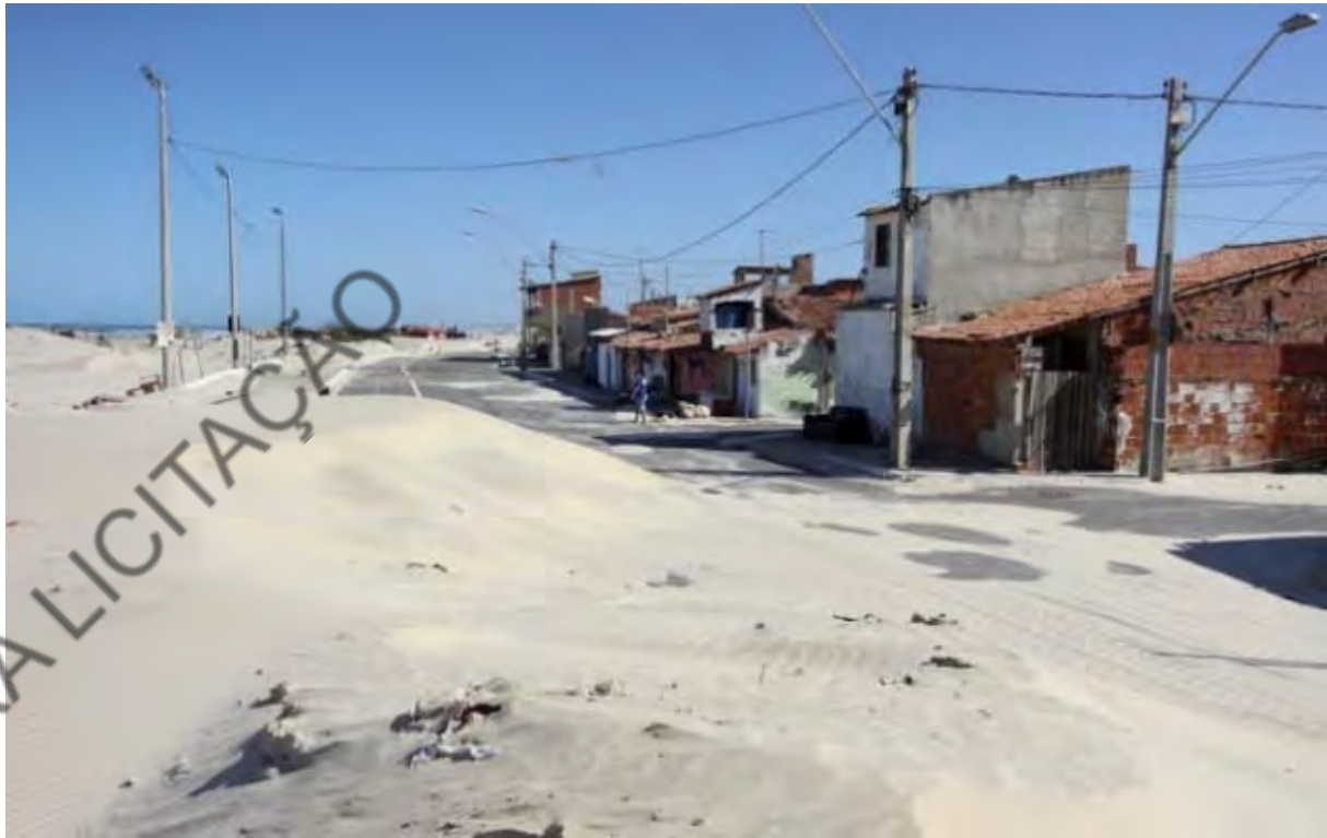
Figura 7.9 - Av. Pontamar, no Serviluz, apresentando mureta de contenção, calçadão, ciclofaixa e o leito da via soterrados por areia, denotando o intenso processo de sedimentação desta região do litoral de Fortaleza.
