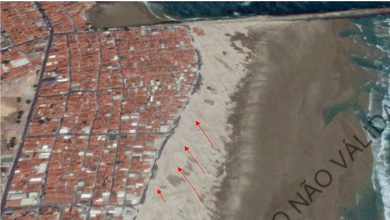
Figura 7.8 - Vista panorâmica da Praia do Serviluz, vendo-se em segundo plano o molhe Titanzinho. As flechas indicam a direção preferencial dos ventos e o transporte de sedimentos para o interior da zona urbanizada.
