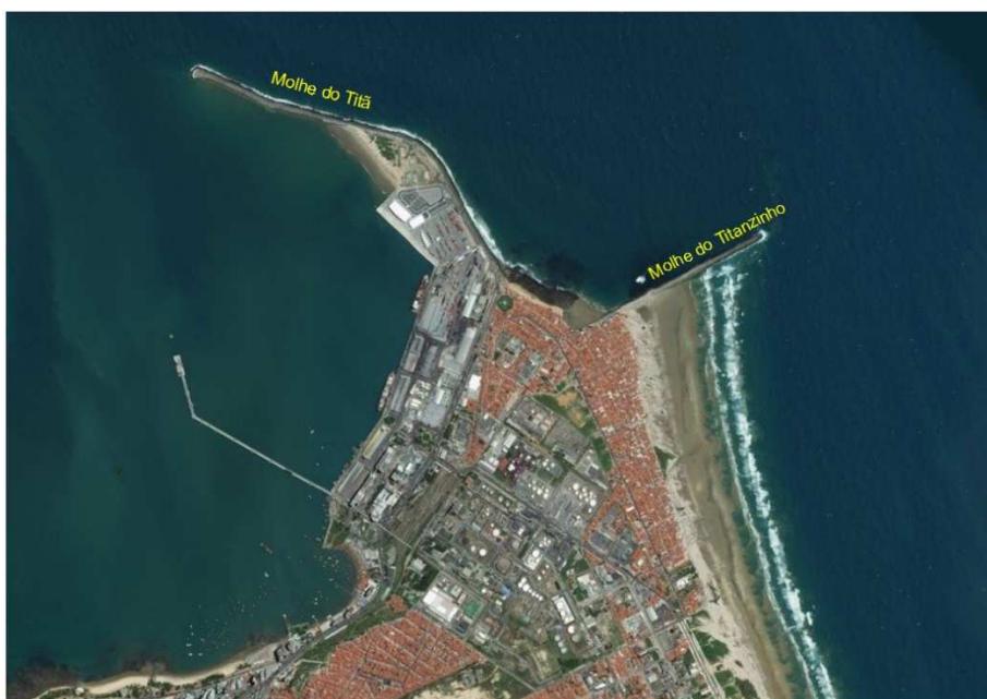
Figura 116 - Obras de proteção do Porto do Mucuripe.
