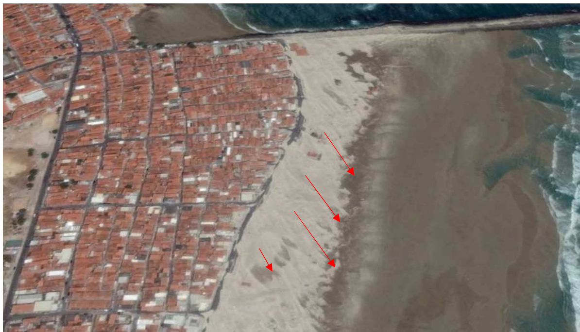
Figura 120 - Vista panorâmica da Praia do Serviluz, vendo-se em segundo plano o molhe Titanzinho. As flechas indicam a direção preferencial dos ventos e o transporte de sedimentos para o interior da zona urbanizada.
