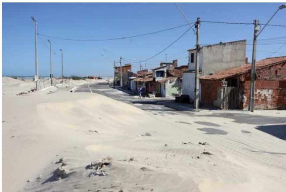
Figura 121 - Av. Pontamar, no Serviluz, apresentando mureta de contenção, calçadão, ciclofaixa e o leito da via soterrados por areia, denotando o intenso processo de sedimentação desta região do litoral de Fortaleza.
