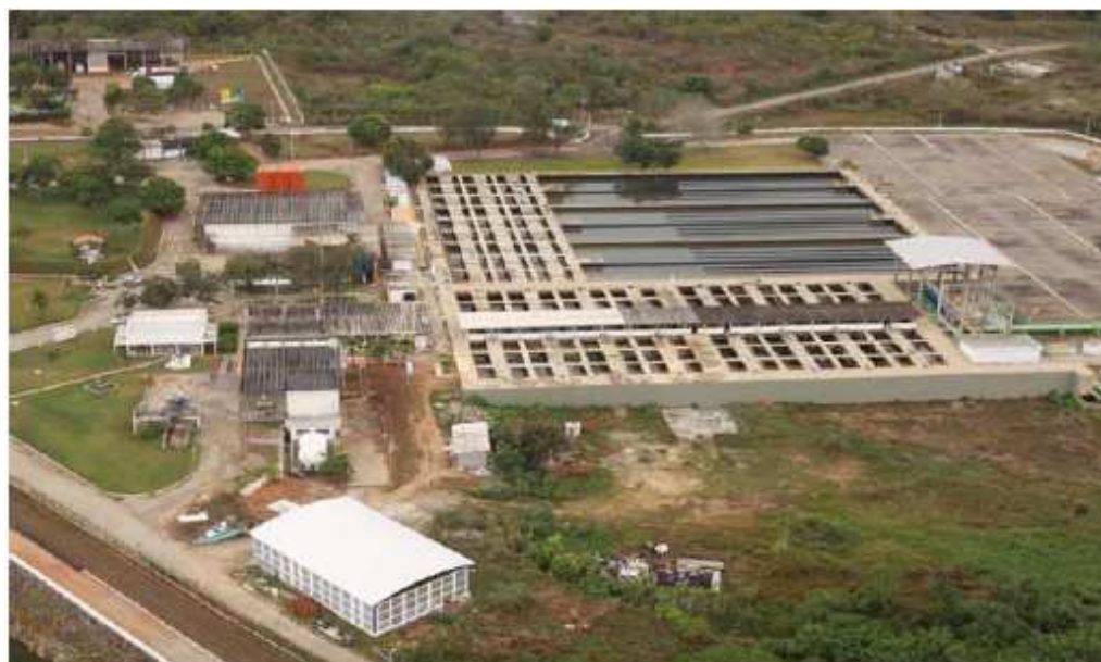
Figura 2.6 - Vista aérea da ETA Gavião
