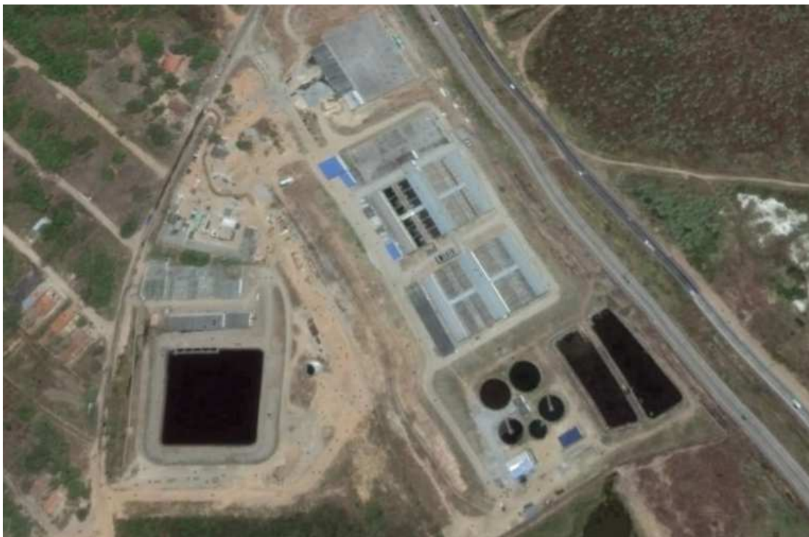
Figura 2.9 - Vista aérea da ETA Oeste
