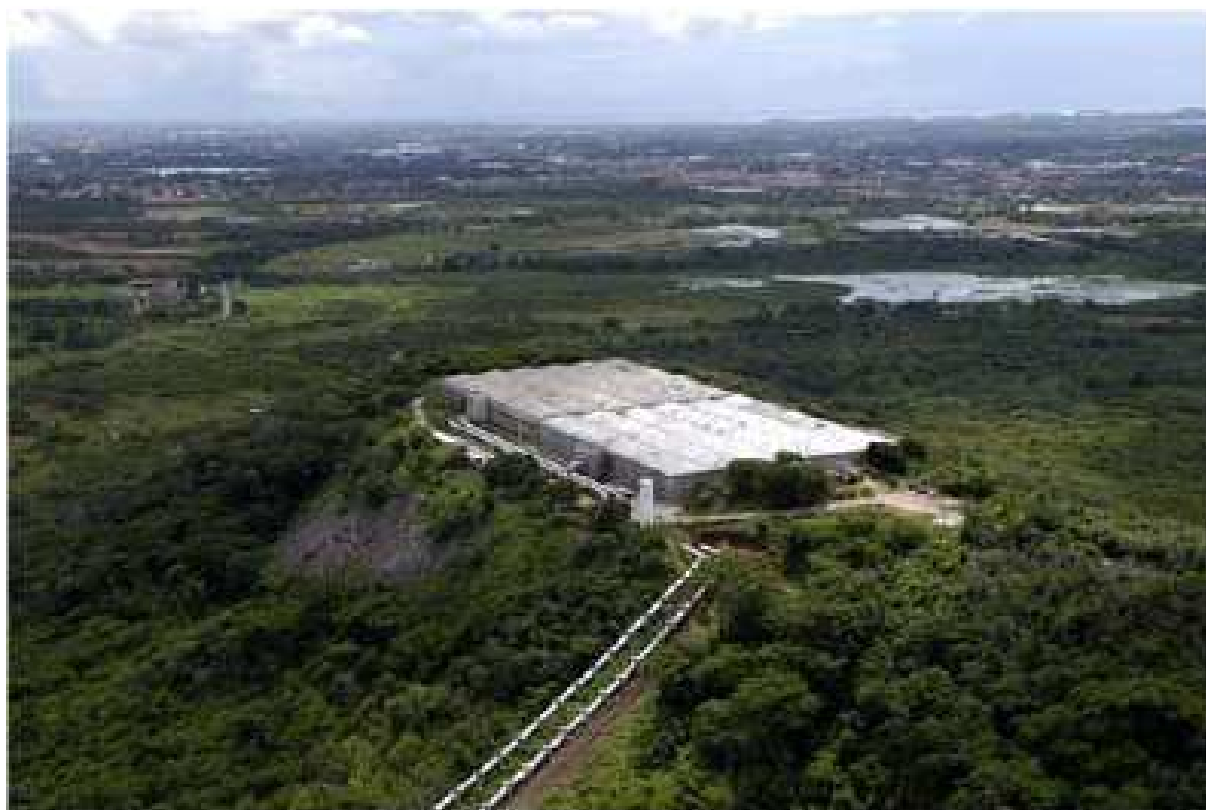
Figura 2.10 - Vista área reservatório Ancuri
