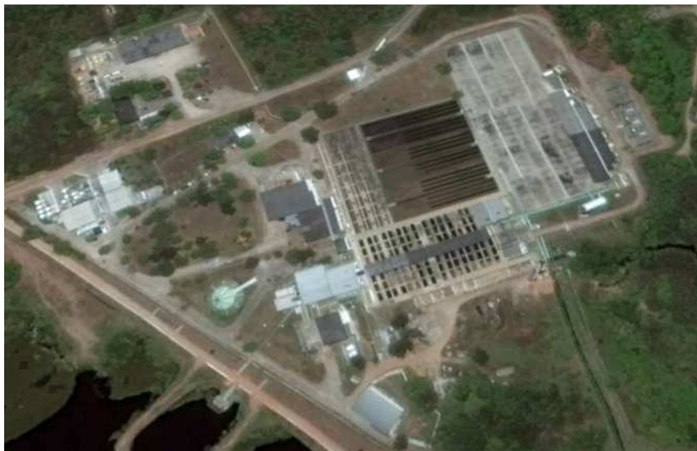
Figura 2.7 - Vista aérea da ETA Gavião
