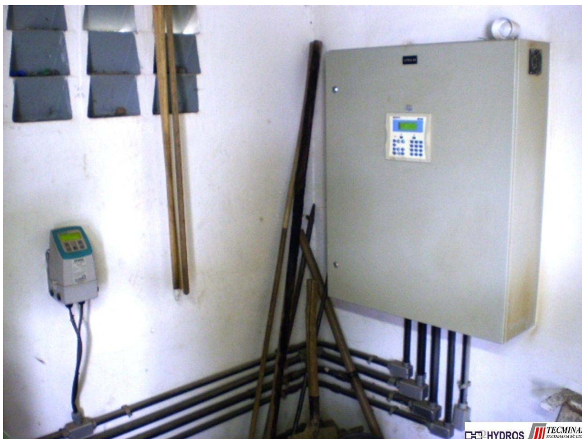
Figura 2.24 - Subsistema Horta - Painel da UTRA-06 e Visor do Medidor de Vazão
