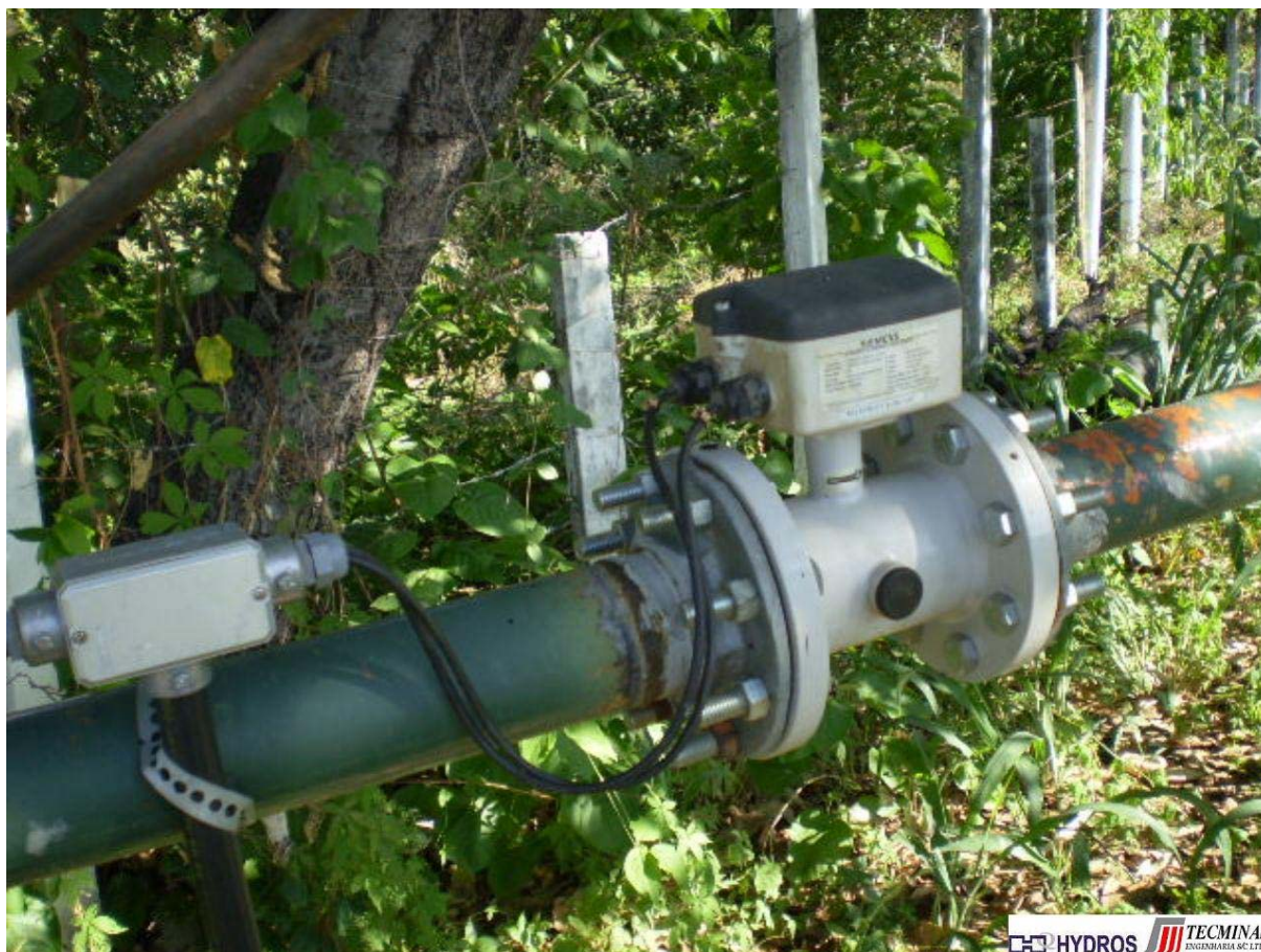
Figura 2.5 - Subsistema Principal - Detalhe das Conexões do Medidor de Vazão do PT-02A
