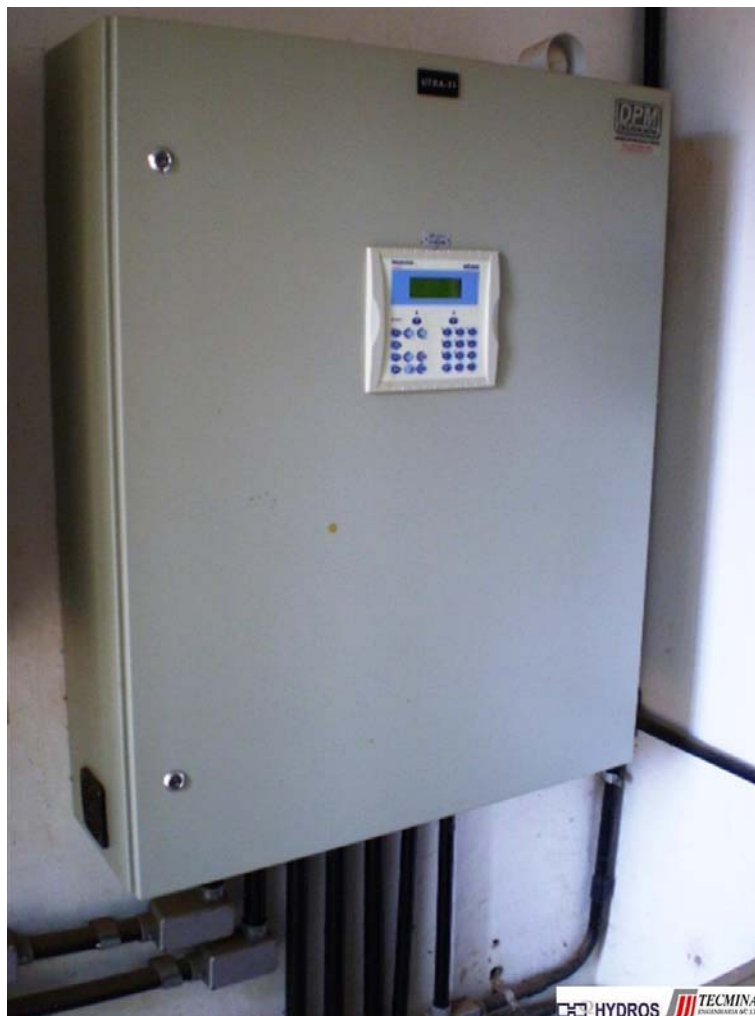
Figura 2.19 - Subsistema Aeroporto - Paineis da UTRA-11 que Monitora o Paineis do PT-18
