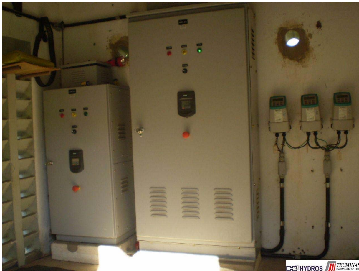
Figura 2.4 - Subsistema Principal - Painéis do PT-02 e PT-02A e Visores dos Medidores de Vazão (PT-02, PT-02A, EE-09)
