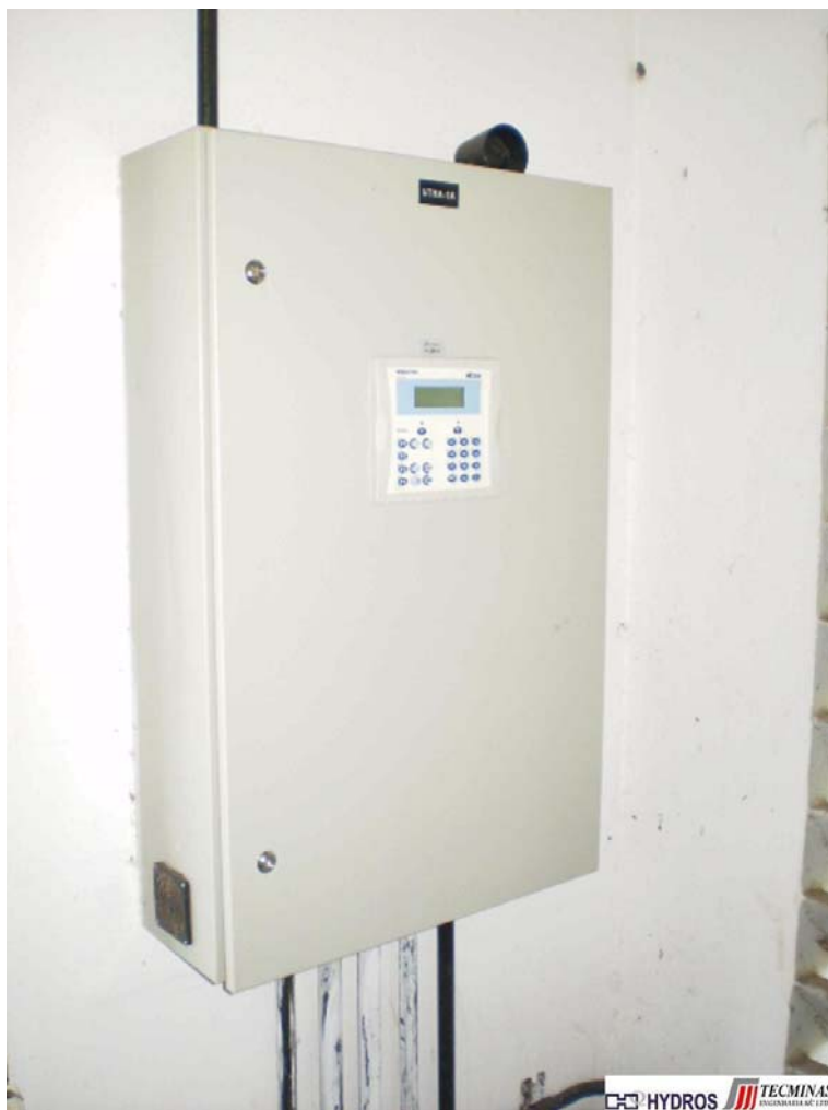
Figura 2.7 - Subsistema Principal - Pannel da UTRA-01A que Monitora o Pannel do PT-01
