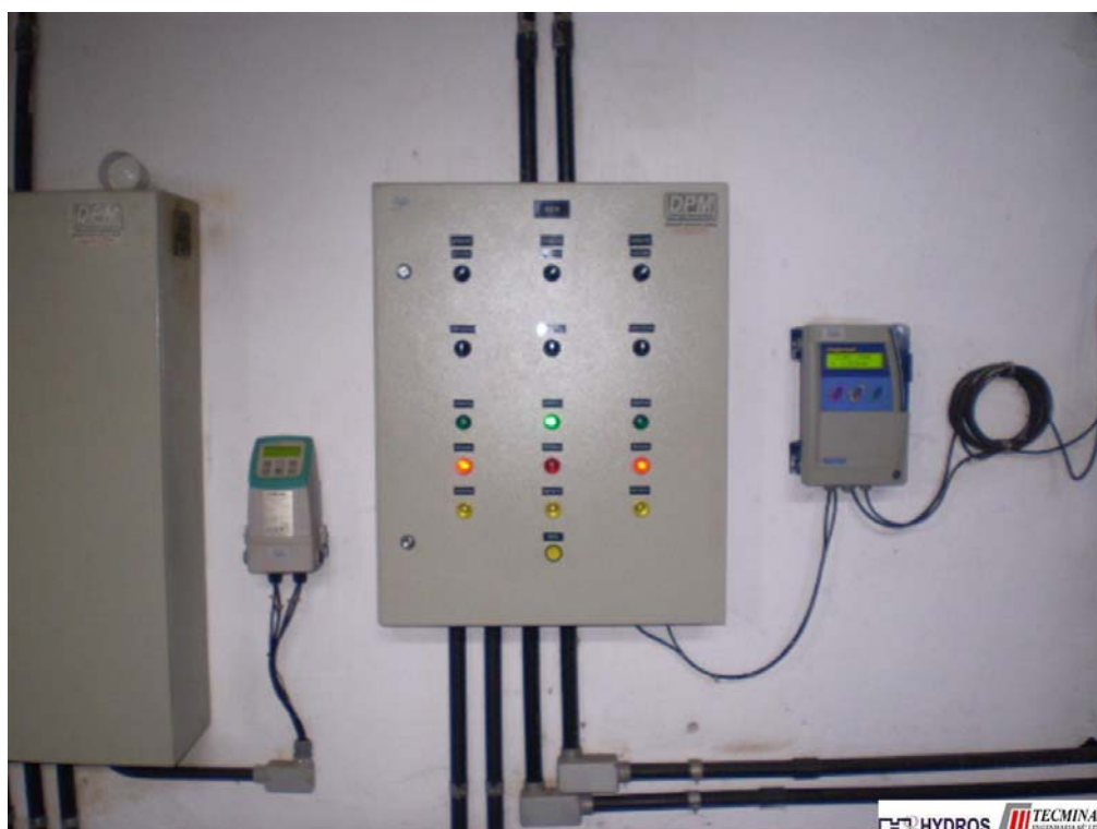
Figura 2.11 - Subsistema Principal - EE-12 - Painel de Comando das Válvulas e Visores dos Medidores de Vazão e de Dosagem de Cloro
