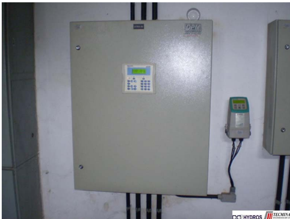
Figura 2.10 - Subsistema Principal - Painel da UTRA-02 que Monitora o Painel da EE-12 e o Visor do Medidor de Vazão EE-12
