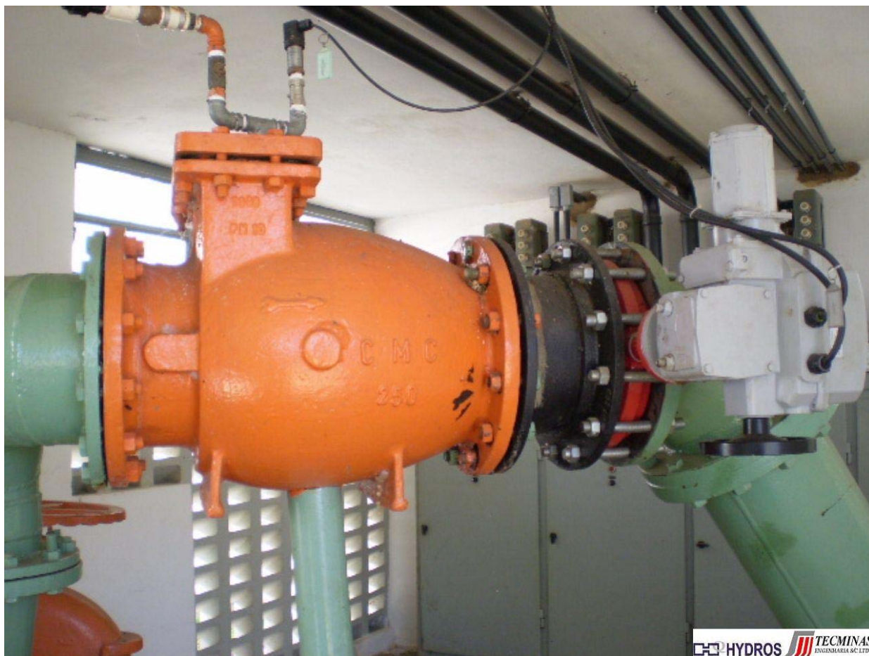
Figura 2.2 - Subsistema Principal - Painel da EE-01 (ao Fundo), Válvula (Cor Vermelha) e Atuador Elétrico (Cor Cinza)
