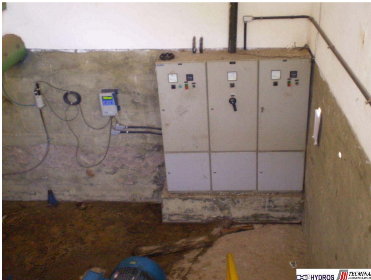
Figura 2.3 - Subsistema Principal - Painel da EE-09 e Visor de Dosagem de Cloro
