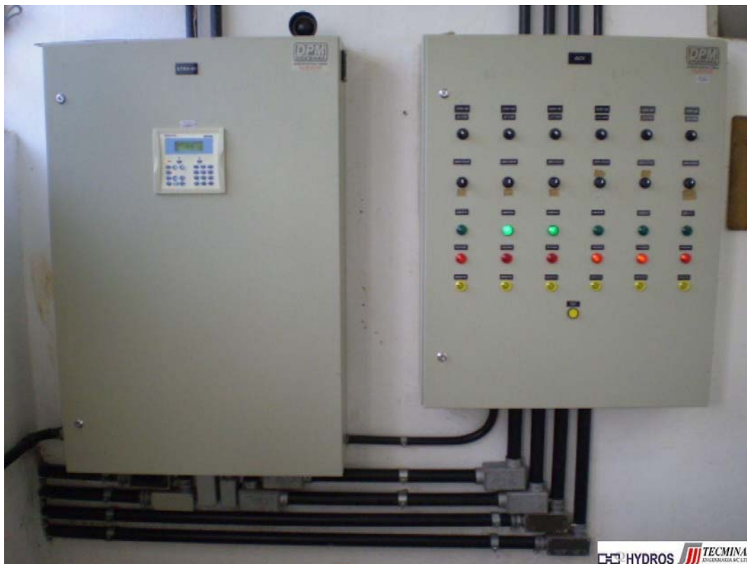
Figura 2.1 - Subsistema Principal - Painel da UTRA-01 e Paine de Comando das Válvulas
