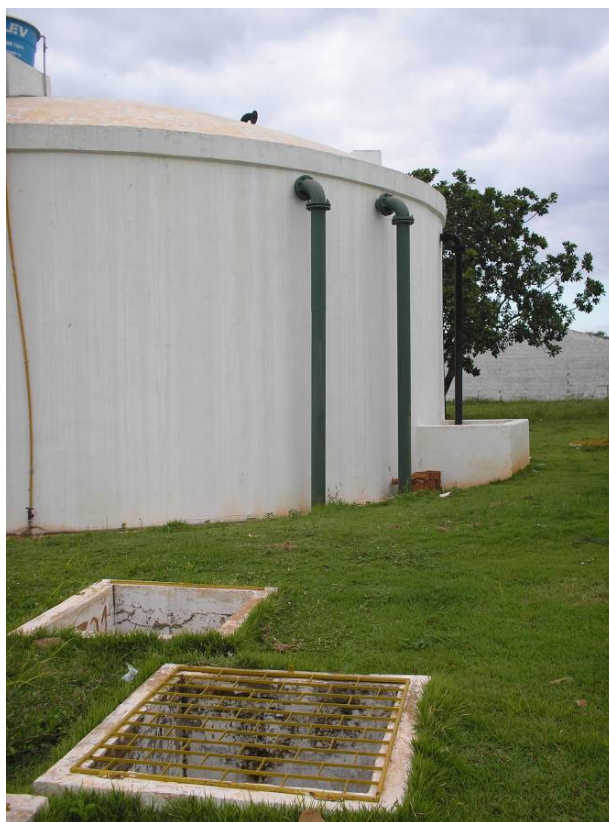
Foto 13 - Subsistema Frei Damião - RAP-18, Tubulações de Entrada dos Poços PT-21 e PT-22
