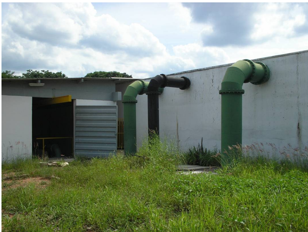
Foto 27 - Sistema Principal - RAP-02, Tubulações de Entrada e Extravaso
