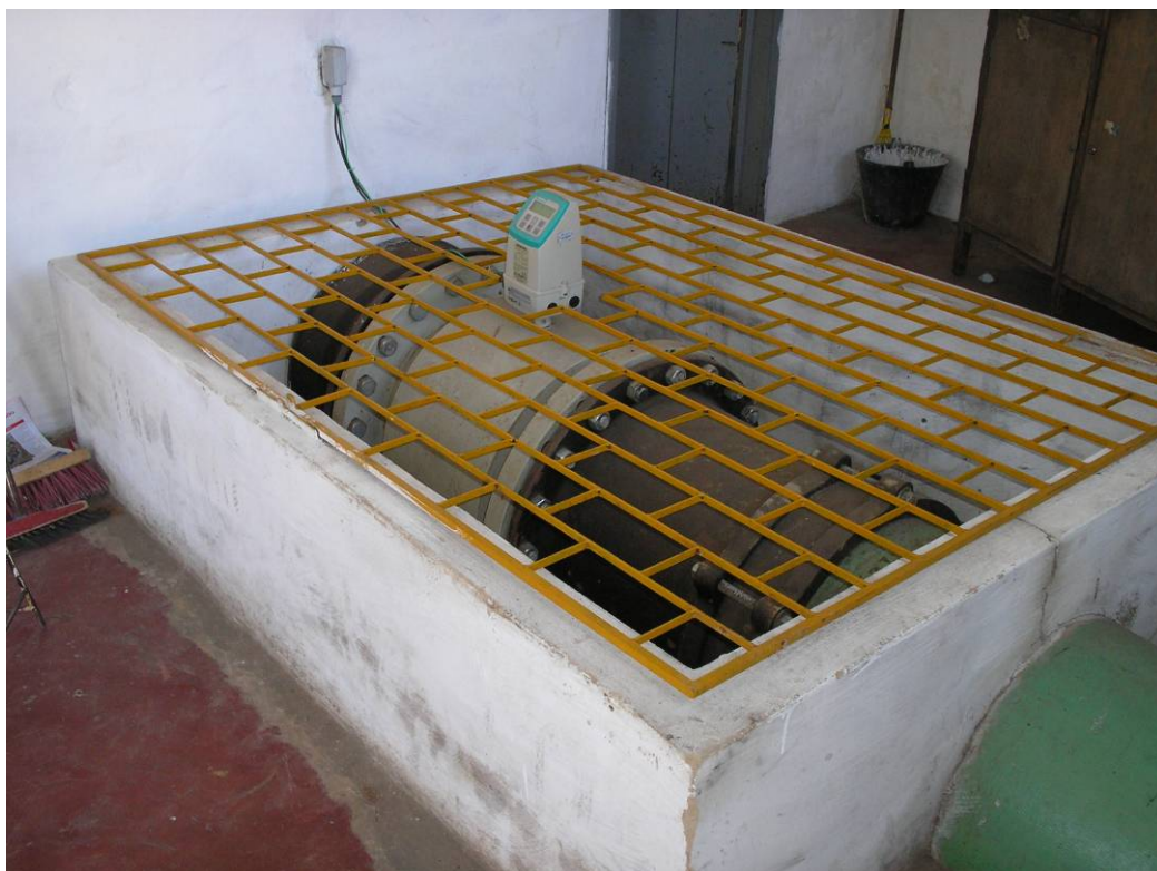
Foto 4 - Subsistema Principal - REL-01, Caixa de Entrada com Dispositivo de Controle e Medição
