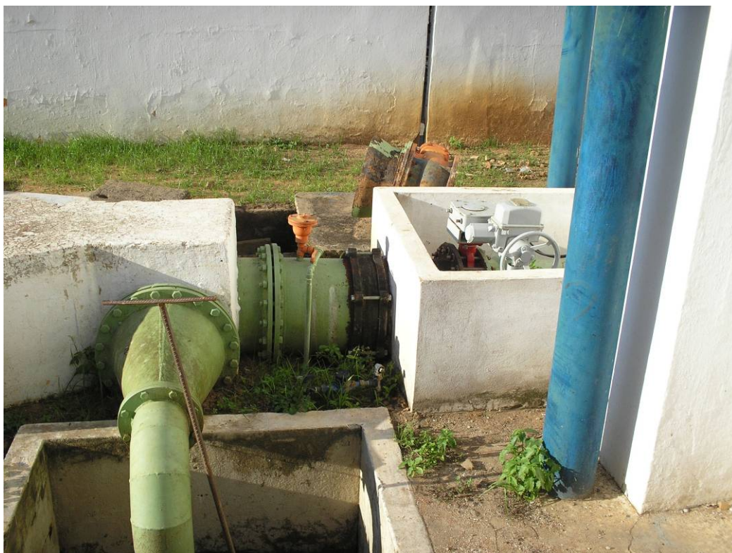
Fotos 3 - Subsistema Principal - REL-01, Tubulações de Entrada e Dispositivos de Controle
