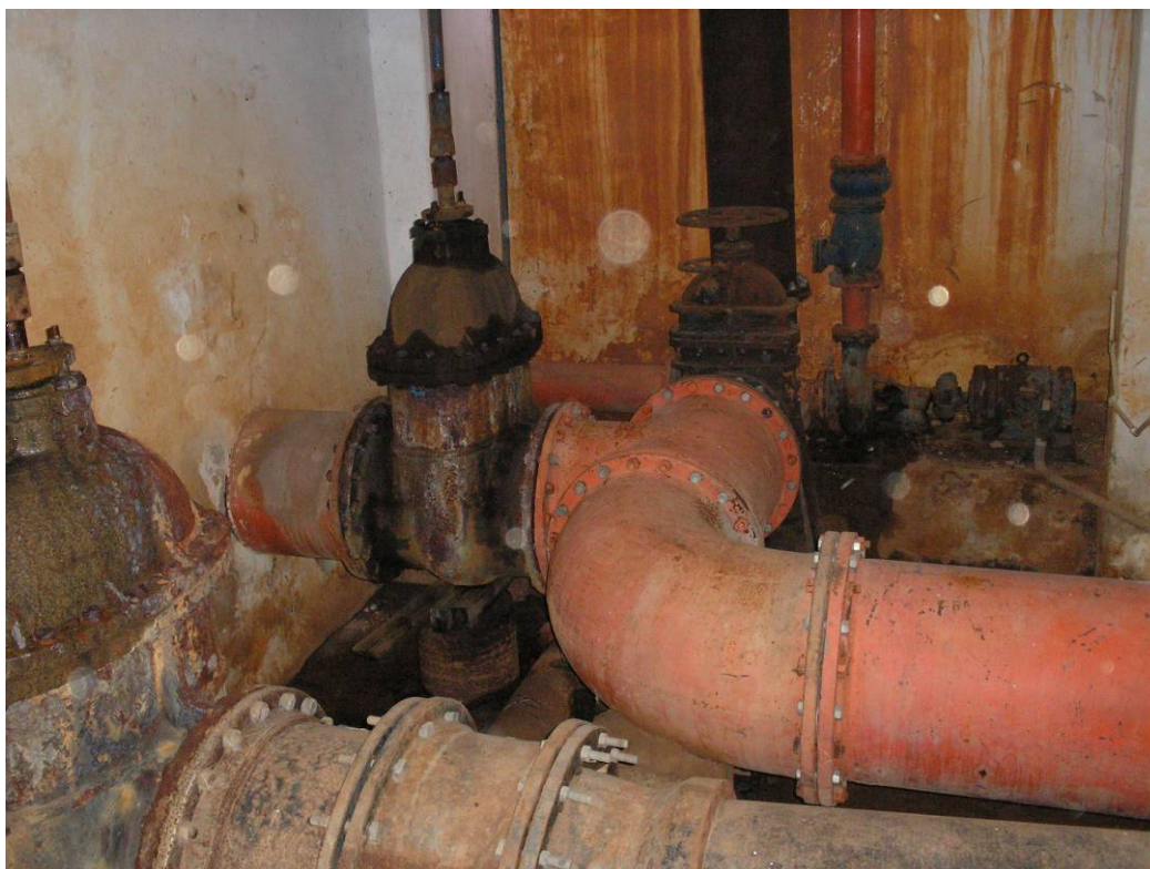
Foto 33 - Sistema Principal - Registros de Manobras do RAP-01, Tubulações de Saída para a Rede e de Interligação com o REL-01
