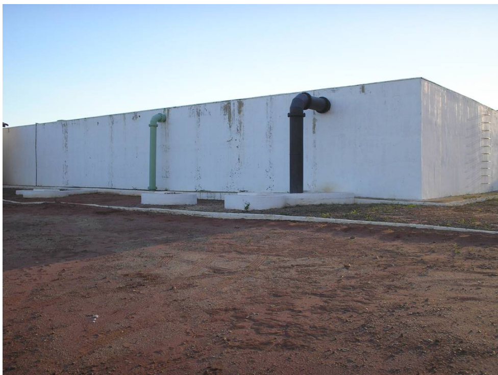
Foto 7 - Sistema Vaquejada - RAP-08, Tubulação de Entrada e Extravisor
