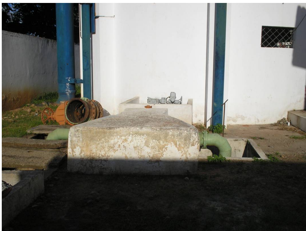
Foto 1 - Subsistema Principal - REL-01, Barrilete das Tubulações de Entrada
