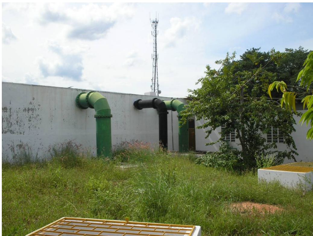
Foto 29 - Subsistema Principal - RAP-03, Tubulações de Entrada e Extravisor
