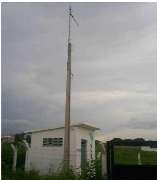
Foto 16 - Área do Poço PT-12 na Rua Arnóbio B. Caneca, Bairro Jardim Gonzaga; Poste com Antena de Rádio para Automação e Pára-raios; Isolamento e Proteção Inadequados; Vulnerabilidade à Infiltrações de Águas Superficiais (Ruas sem Drenagem)
