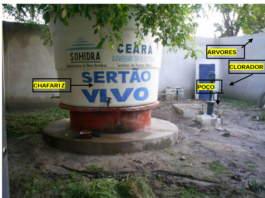
Foto 46 - Área do Poço PT-32 no Distrito de Padre Cícero (Palmeirinha). Reservatório (chafariz) sem Manutenção. Poço Vulnerável à Contaminação. Solo com Alta Concentração de Matéria Orgânica de Origem Animal. Locado no Vale do Rio Caras. Faltam Piso, Capina e Melhorias na Proteção
