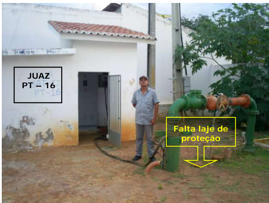
Foto 20 - Área do Poço PT-16 na Av. Ailton Gomes, Bairro Lagoa Seca. Faltam Isolamento Adequado, Piso, Laje de Proteção, Capina
