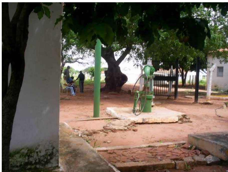
Foto 26 - Área do Poço PT-18; Faltam Piso, Adequação do Isolamento e Proteção da Área
