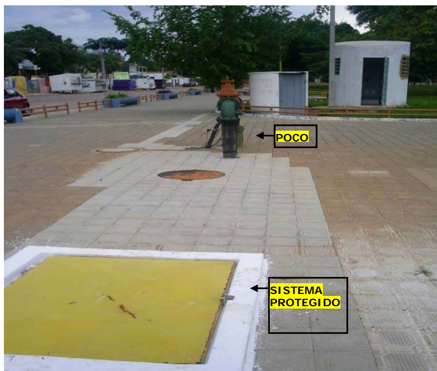
Foto 12 - Poço PT-10 em Praça Pública na Rua Arnóbio B. Caneca; Áreas Residencial e de Lazer. Abastecimento Duplo com Injeção Direta na Rede com Distribuição de Água Clorada e Recalque para RAP-Reservatório Apoiado; Faltam Isolamento e Proteção da Unidade
