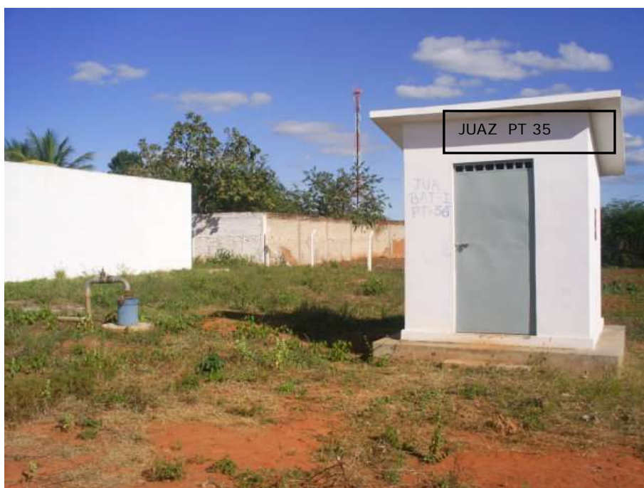
Foto 52 - Área da Unidade PT-35 na Av. Crescente e Rua S/D, Bairro Novo Juazeiro, Junto ao Reservatório Apoiado RAP-07; Área de Planície Aluvionar. Faltam Isolamento, Porteção, Piso e Capina da Área. Vulnerabilidade Alta
