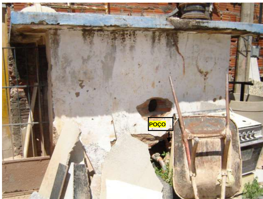
Fotos 47 e 48 - Instalações do Poço PT-33, Doado pela Prefeitura Municipal de Juazeiro do Norte à Cagece. Precárias Condições de Operação. Fiação Elétrica Exposta e Necessitando de Manutenção. Não Possui Proteção nem Isolamento Adequados. A Área do Poço esta sendo Utilizada para Depósito; Caracterizado como de Alta Vulnerabilidade, pois Encontra-se em Área Residencial
