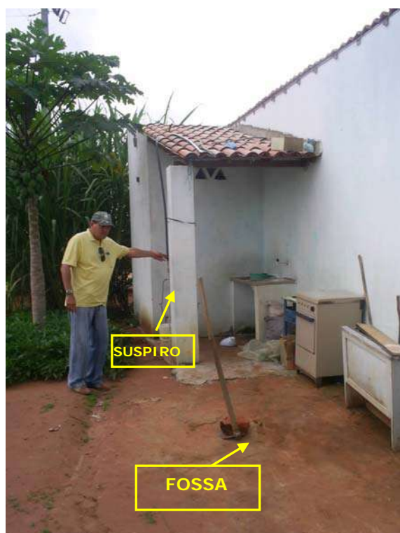
Foto 34 - Detalhe da Área do Poço PT-23; Fossa Negra na Zona de Influência do Poço, com Suspiro Adaptado por uma Mangueira. Vulnerabilidade Alta; Zona de Contaminação dos Aquíferos
