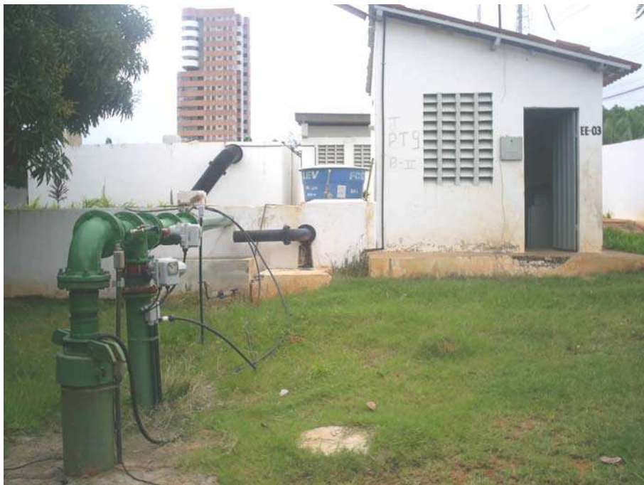
Foto 11 - Área do Poço PT-09 na Rua José Carneiro Filho, s/n, Jardim Gonzaga; Boa Infraestrutura; Sistema Duplo (vazão de 56 m 3 /hora - Regime de 24 horas), Sendo um com Água Clorada Injetada Direta na Rede de Distribuição, e Outro Bombeamento para o RAP Local, Passando para EE-3; Sistema Automatizado; Zona de Influência Vulnerável à Contaminação das Águas dos Esgotos a Céu Aberto; Faltam Capina e Piso
