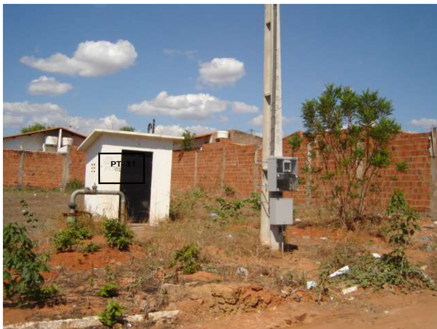
Foto 45 - Área do Poço PT-31 Localizado em Área Próxima ao Parque Ecológico, sem Esgotamento Sanitário. Sujeito à Contaminação por Fossas Negras. Área sem Qualquer Proteção e Isolamento, Facilitando a Ação Antrópica Negativa. Faltam Muro, Piso e Capina
