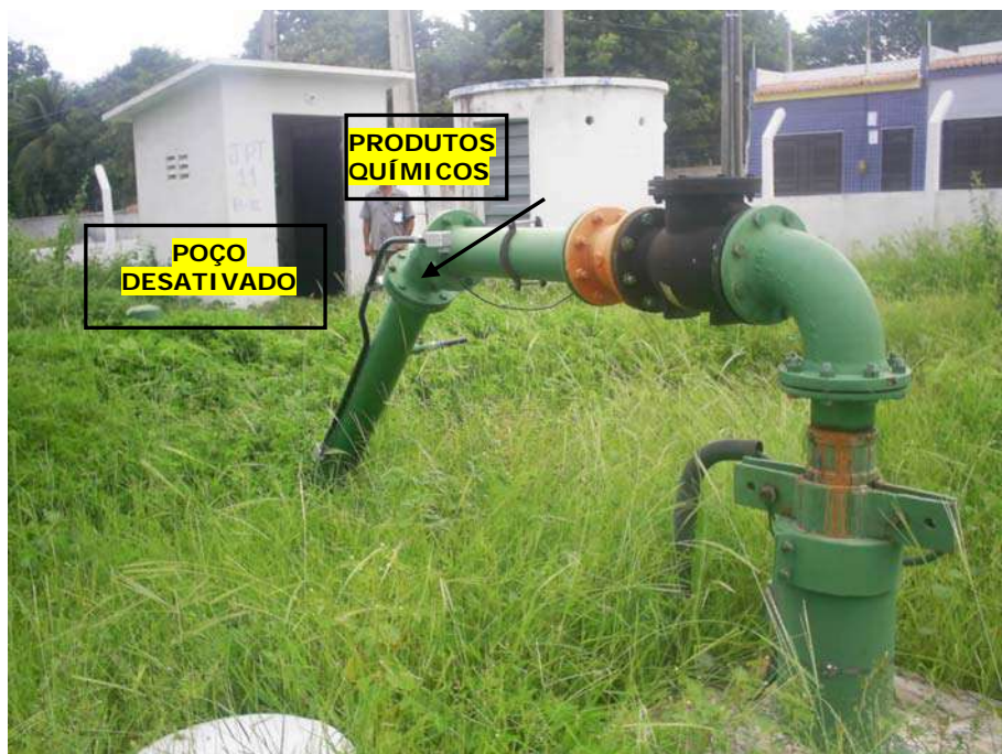
Foto 14 - Área do Poço PT-11 na Rua Antônio Barcelar Caneca, Bairro Jardim Gonzaga; Unidade com Automação. Vista das Instalações do Poço, Casa de Cloração e de Comando Elétrico. Vulnerabilidade à Contaminação por Esgotos a Céu Aberto. Faltam Piso e Capina
