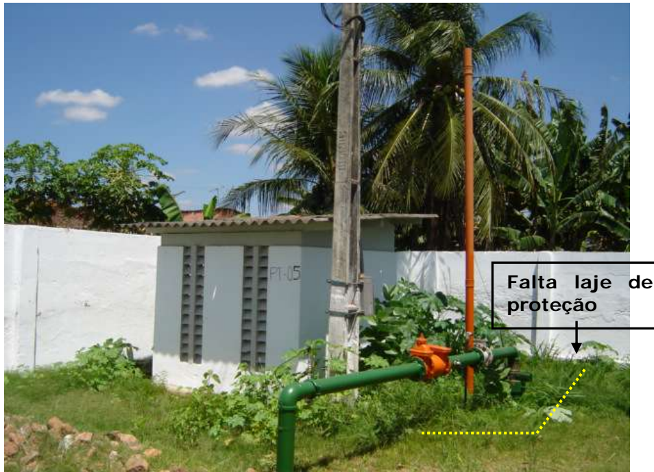
Foto 7 – Poço PT-05 na Rua Vereador Antonio Braz, Próximo ao Riacho dos Macacos, Bairro Limoeiro. Faltam Capina, Piso e Laje de Proteção
