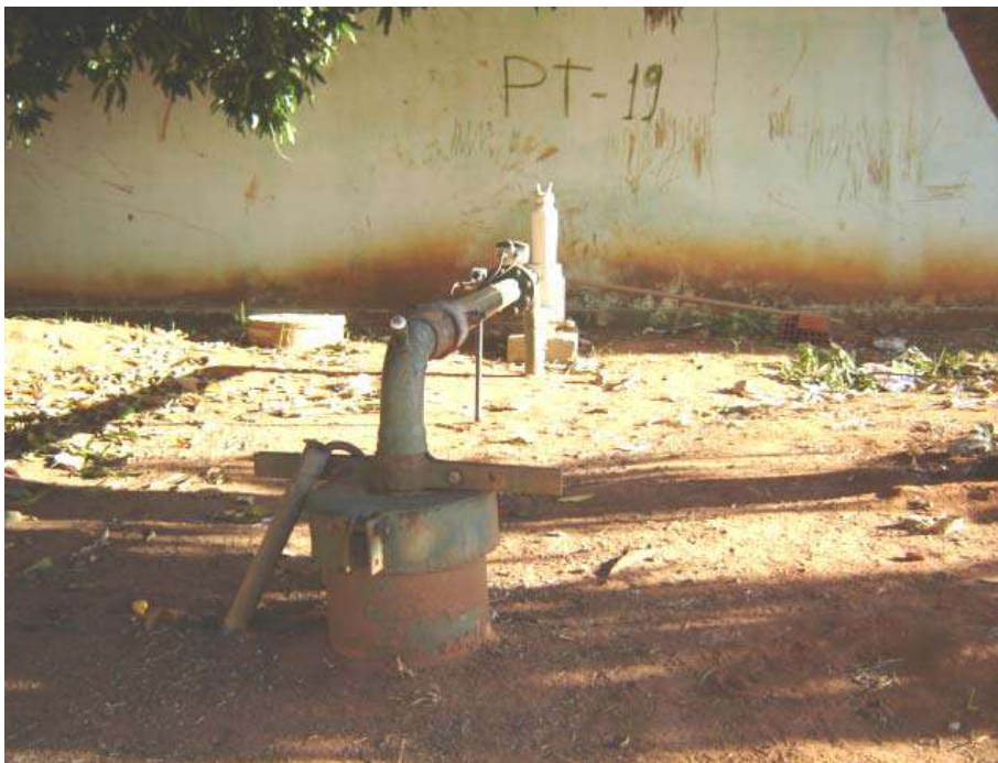
Foto 27 - Boca do Poço PT-19 Localizado Dentro do CAIC - EEFM Dom Antonio Campelo, sem o Devido Isolamento e Proteção. Sujeito à Contaminações. Presença de Árvores de Grande Porte nas Proximidades do Poço. Zona de Alta Vulnerabilidade
