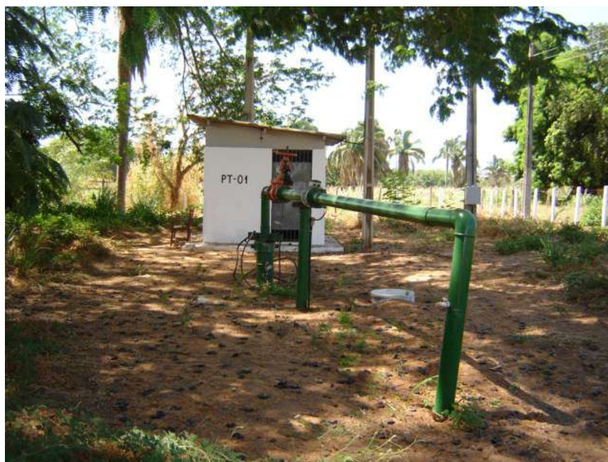
Foto 1 - Poço PT-01 no Parque Ecológico das Timbaúbas, Próximo ao Riacho dos Macacos; Sistema sem Manutenção Preventiva; Falta Torneira de Coleta de Água Bruta, Piso e Laje de Proteção; Alta Vulnerabilidade
