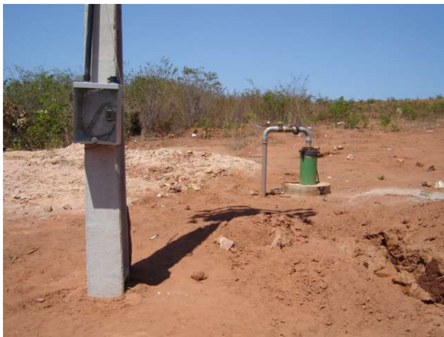
Foto 57 - Área do Poço PT-40, Construído e Instalado Recentemente, Porém em Condições Inadequadas de Funcionamento. Faltam Muro de Isolamento, Piso, Casinha de Quadro Elétrico
