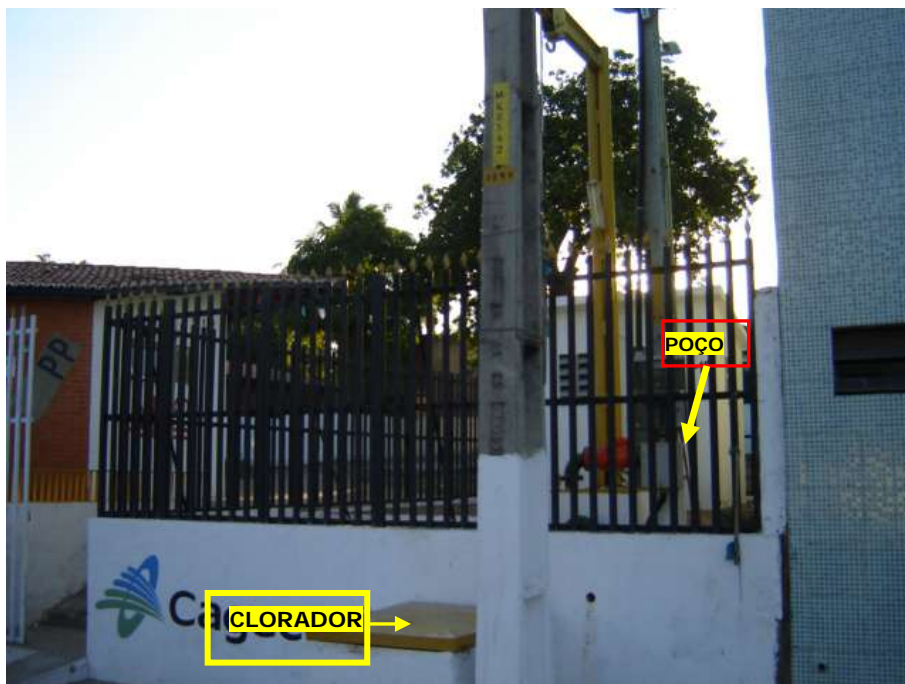
Foto 19 - Unidade de captação PT-15, Situado em Área Residencial, Junto ao Posto PSF-58, na av. Leão Sampaio; Sistema de Tratamento da Água em Local Inadequado (Fora da Área de Isolamento); Boa Infraestrutura; Zona de Vulnerabilidade Alta
