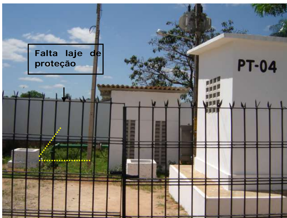
Foto 6 – Poço PT-04 na Rua Madre Nelly, Bairro Limoeiro. Faltam Capina, Piso e Laje de Proteção; Fluxo de Esgoto Doméstico na Frente da Área da Captação
