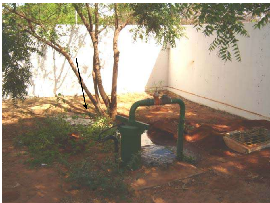
Foto 40 - Área do poço PT-27 no Parque das Timbaúbas. Vegetação Dentro da Área de Proteção. Faltam Piso e Capina
