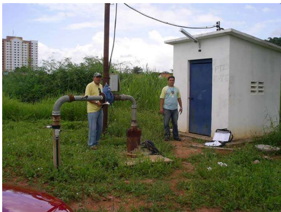
Foto 42 - Área do Poço PT-29 na Área da Cagece, Bairro Romeirão. Não Há Isolamento nem Proteção. Vulnerabilidade às Ações Antrópicas. Zona Comercial e Industrial com Postos de Combustíveis e Indústria de Folheados nos Arredores
