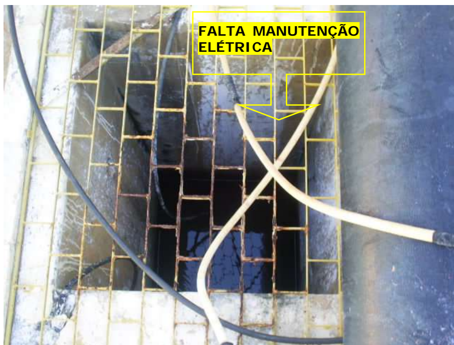
Foto 21 - Área do Poço PT-17 no Parque Ecológico, Bairro José Geraldo da Cruz. Tubulação com Vazamento e Necessitando Manutenção na Instalação Elétrica
