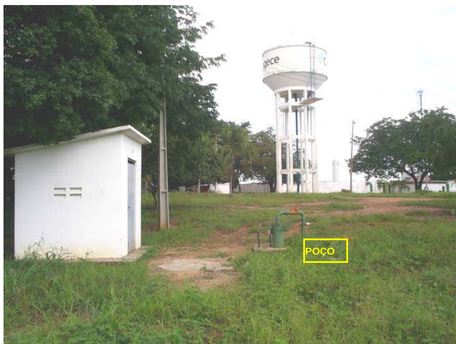
Foto 44 - Área do Poço PT-30 no Pátio da Cagece, Bairro Romeirão. Vista do Poço, Casa de Comando Elétrico e Reservatório Elevado (REL-02); Faltam Isolamento, Proteção, Piso e Capina na Área
