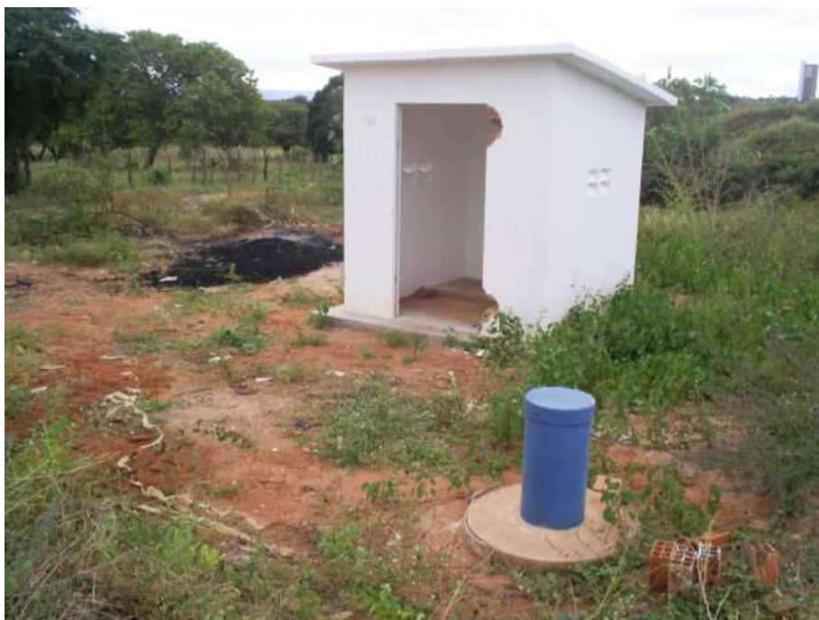
Foto 54 - Área do Poço PT-37 na Av. José Ilanio com Av. Ailton Gomes, Bairro Lagoa Seca. Poço Desativado, Necessitando da Construção do Isolamento Adequado. Área Exposta, Estando Sujeita à Ação Antrópica
