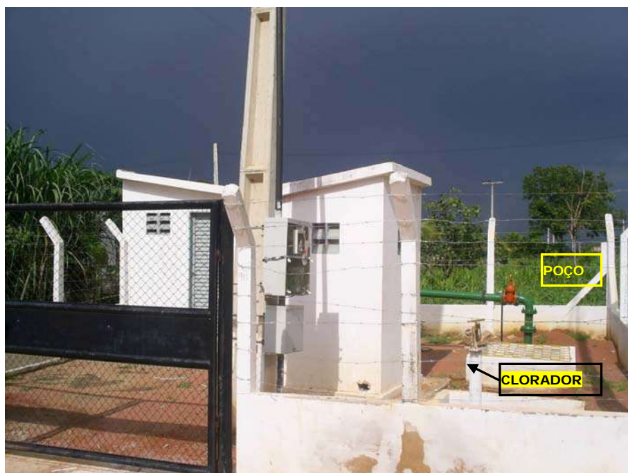
Foto 32 - Área do Poço PT-23 na Rua Joaquim Leandro de Sousa com Sebastião Palmeira, Bairro Aeroporto. Vista Geral das Instalações do Poço, do Clorador e da Casa de Comando. A Área de Proteção Encontra-se em Boas Condições de Operação e Manutenção; Falta Piso
