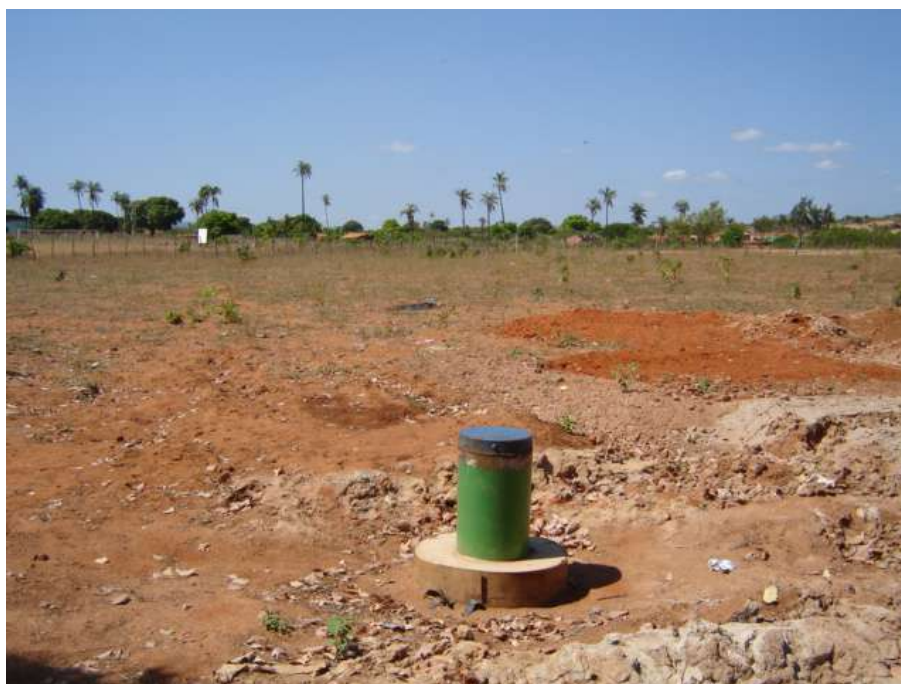
Foto 58 - Área do Poço PT-41, Construído Recentemente e Ainda sem Estrutura de Funcionamento. Zona Residencial sem Rede de Esgoto. Vulnerabilidade Alta
