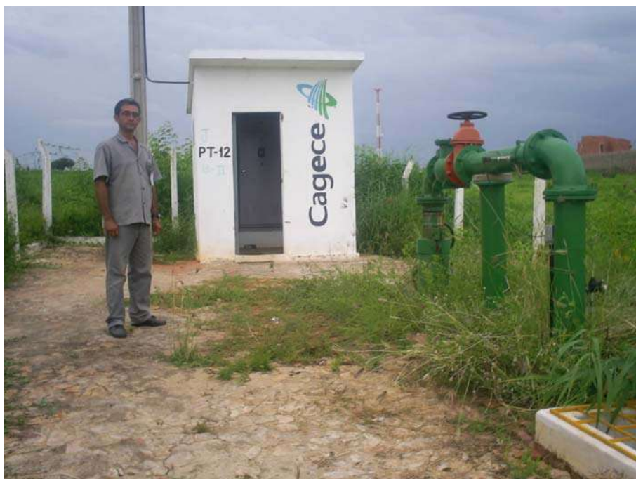
Foto 15 - Área do Poço PT-12 na Rua Arnóbio B. Caneca, Jardim Gonzaga; Boa Casinha de Quadro de Comando; Faltam Piso, Capina e Isolamento Adequado
