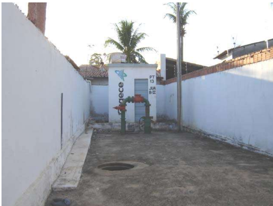
Foto 17 - Área da unidade de Captação PT-13 na Rua Arnóbio Barcelar Caneca, Jardim Gonzaga; Unidade em Operação com Sistema de Automação; Poço Vulnerável a Infiltrações de Águas de Esgotos a Céu Aberto; Pequeno Espaço Disponível às Operações de Manutenção
