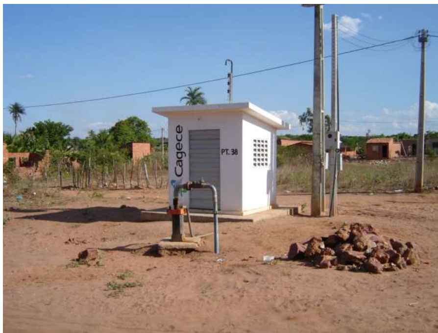
Foto 55 - Área do Poço PT-38 no Bairro Campo Alegre. Não Há Isolamento, Proteção e Piso Adequados. Zona Residencial sem Rede de Esgoto, Facilitando a Contaminação por Fossas Negras. Deposição de Resíduos Sólidos nas Proximidades do Poço
