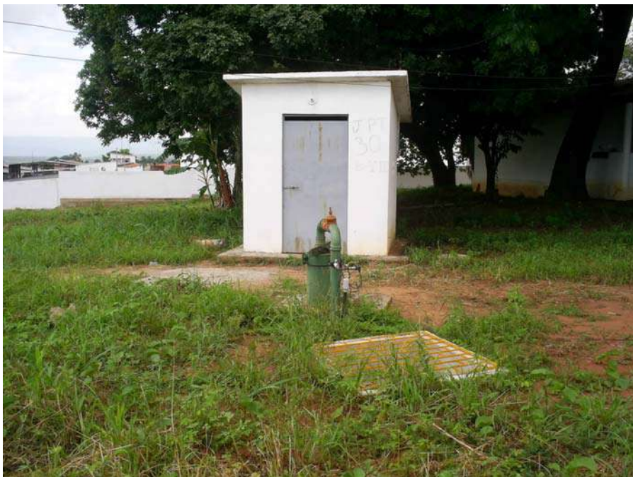
Foto 43 - Área do Poço PT-30 no Pátio da Cagece, Bairro Romeirão. Faltam Isolamento, Proteção, Piso e Capina na Área
