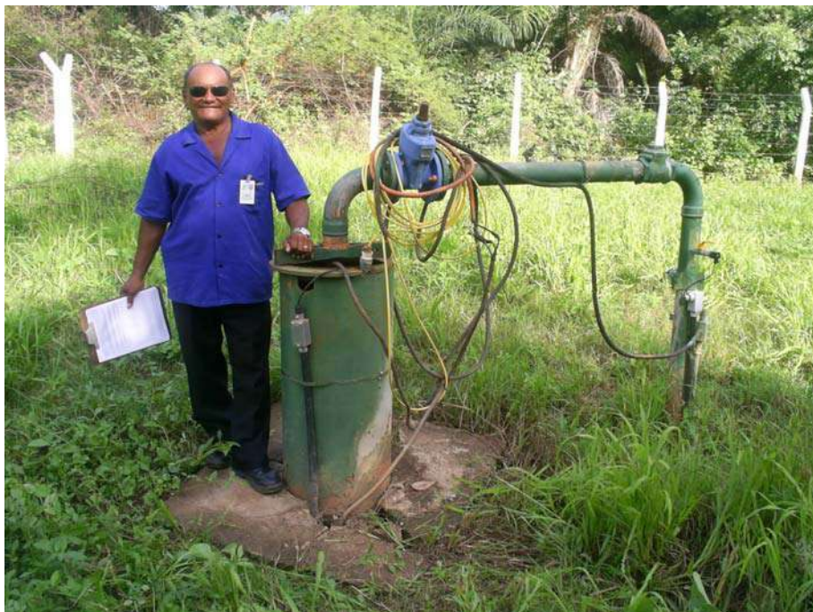
Foto 29 - Boca do Poço PT-20 na Av. José de Melo, Próximo á Ponte do Rio Salgadinho. Entorno Vulnerável a Inundações e Ações Antrópicas. Poço com a Laje de Proteção (Cimentação) Sofrendo Infiltração Pontual. Faltam Capina, Piso, Recuperação da Laje de Proteção, Melhorias na Proteção e Isolamento da Área
