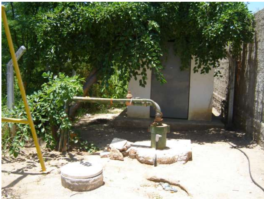
Foto 37 - Área do Poço PT-25. Zona Residencial; Área sem Adequado Isolamento e sem Piso. Localizado na Planície Aluvial do Rio Salgadinho e Sujeito a Contaminação Durante Períodos de Inundação. Presença de Árvores de Médio Porte Muito Próximas ao Poço
