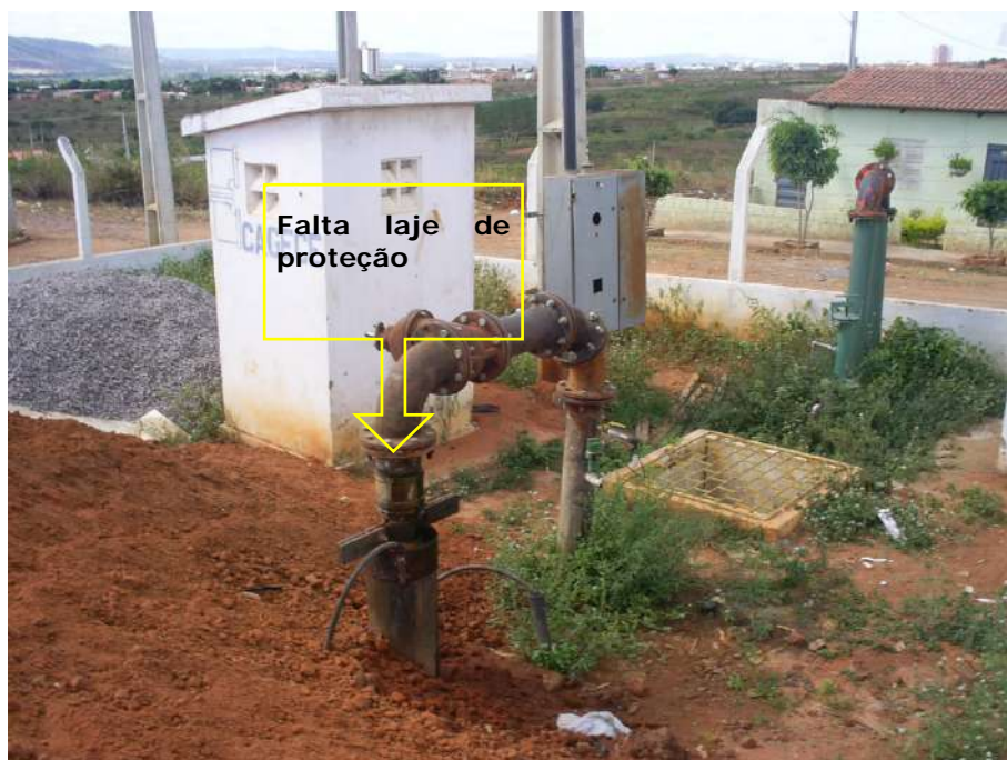
Foto 35 - Área do Poço PT-24 na Rua Maria Otilia, Bairro São José; Isolamento e Proteção Inadequados; Área em Obras e Desorganizada. Faltam Piso, Laje de Proteção e Capina. Alta Vulnerabilidade
