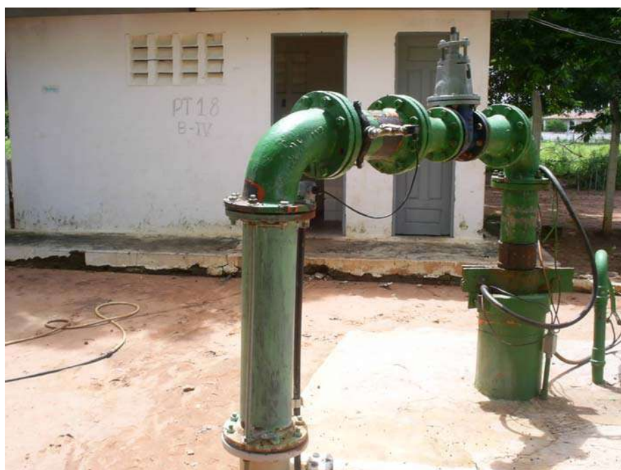
Foto 24 - Boca do Poço PT-18 na Av. Virgílio Távora, bairro Aeroporto; Área de Proteção Vulnerável à Presença de Animais e Ações Antrópicas; Residências no Local e Existência de Fossas Sépticas; Faltam Isolamento, Proteção, Piso e Manutenção Adequados
