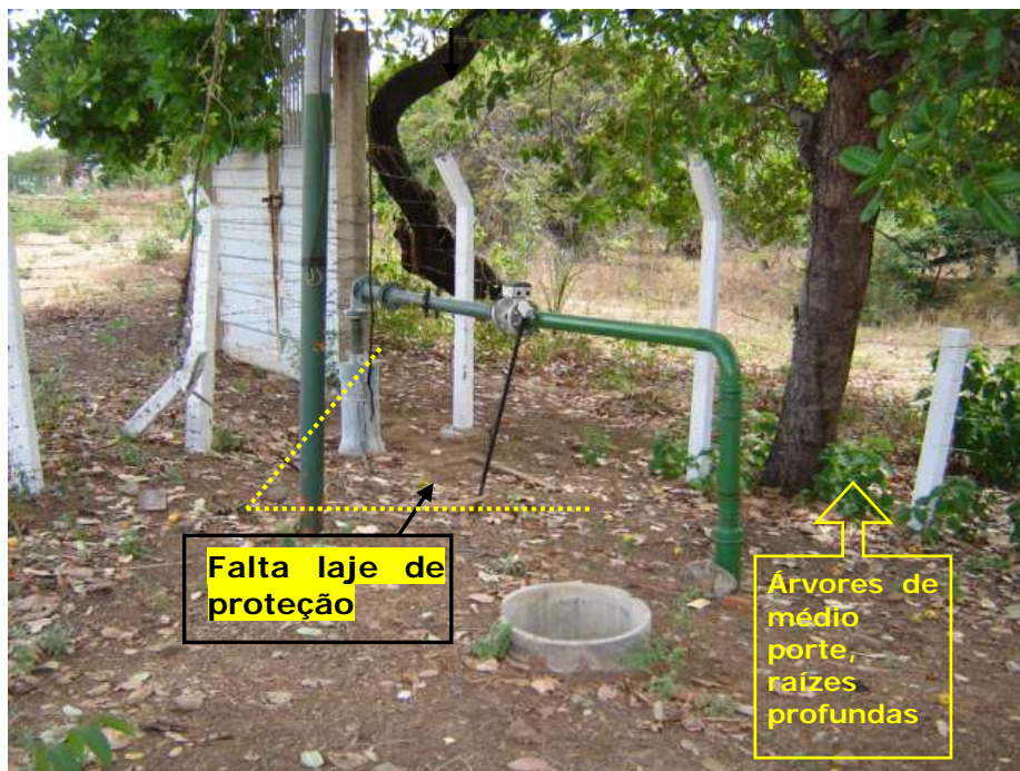
Foto 3 – Poço PT-02A no Parque das Timbaúbas; Faltam piso, Laje de Proteção e Capina; Vegetação de Média Porte Muito Próximo ao Poço. Alta Vulnerabilidade
