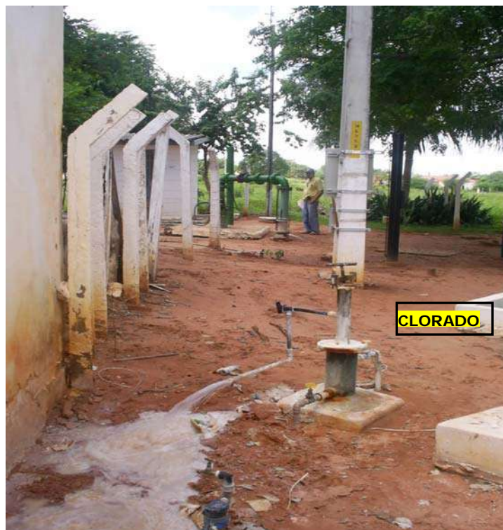
Foto 25 - Área do Poço PT-18 na Av. Virgílio Távora s/n, Bairro Aeroporto. Instalação da Cloração na Rede de Distribuição. As Instalações de Coleta de Amostras de Água não Estão Dentro das Normas. Faltam Melhorias na Proteção da Área, Piso e Retirada da Vegetação do Interior da Área de Captação
