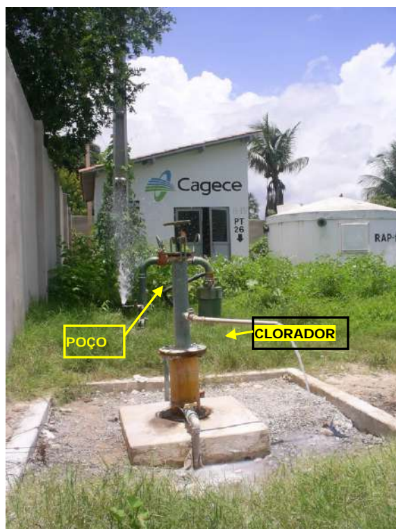
Foto 38 - Área do Poço PT-26 na Rua Cícero Militão, Bairro Novo Juazeiro. Poço com Cloração e Bombeamento Direto para a Rede de Distribuição; Faltam Piso e Capina na Área; Zona Residencial Vulnerável à Infiltrações de Efluentes de Fossas Negras
