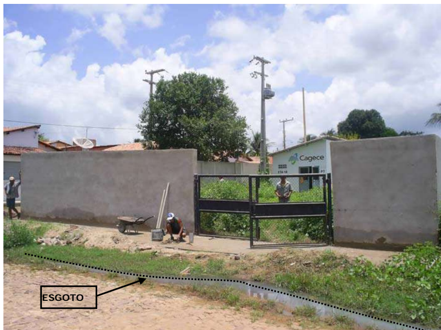
Foto 39 - Vista Geral da Área do Poço PT-26. Esgoto a Céu Aberto na Frente da Área, Contaminação de Aquíferos. Faltam Piso, Capina e Adequação do Entorno da Área de Captação
