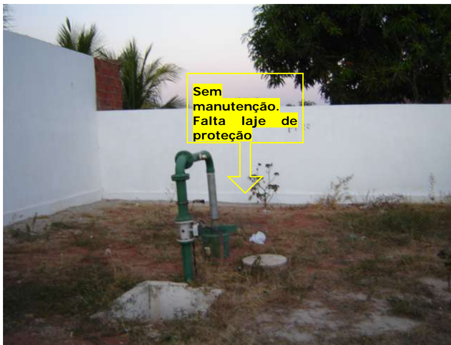
Foto 31 - Área do Poço PT-22 no Bairro Mutirão; Sujeito a Contaminação por Fossas. Em Frente à Área do Poço, há Um Terreno Baldio Onde Esta Sendo Despejado Lixo Doméstico; Faltam Piso, Capina e Melhorias no Isolamento e Proteção da Área; Zona de Alta Vulnerabilidade
