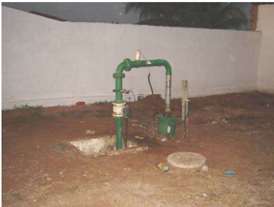
Foto 30 - Boca do Poço PT-21 Sem Laje de Proteção e Fiação Elétrica Necessitando de Manutenção. Faltam Identificação do Poço, Piso e Capina. Área Residencial, sem Rede de Esgotamento Sanitário; Zona de Alta Vulnerabilidade dos Aquíferos
