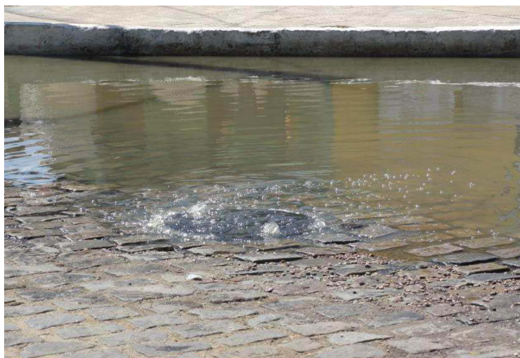
Figura 7.19. Extravasamento na Av. Clóvis Arrais Maia – ICE 1
