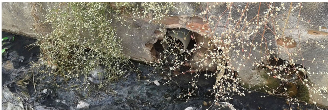
Figura 9: Sistema de Drenagem de Águas Pluviais
