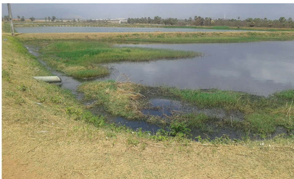
Figura 11: Sistema de Drenagem de Águas Pluviais.
