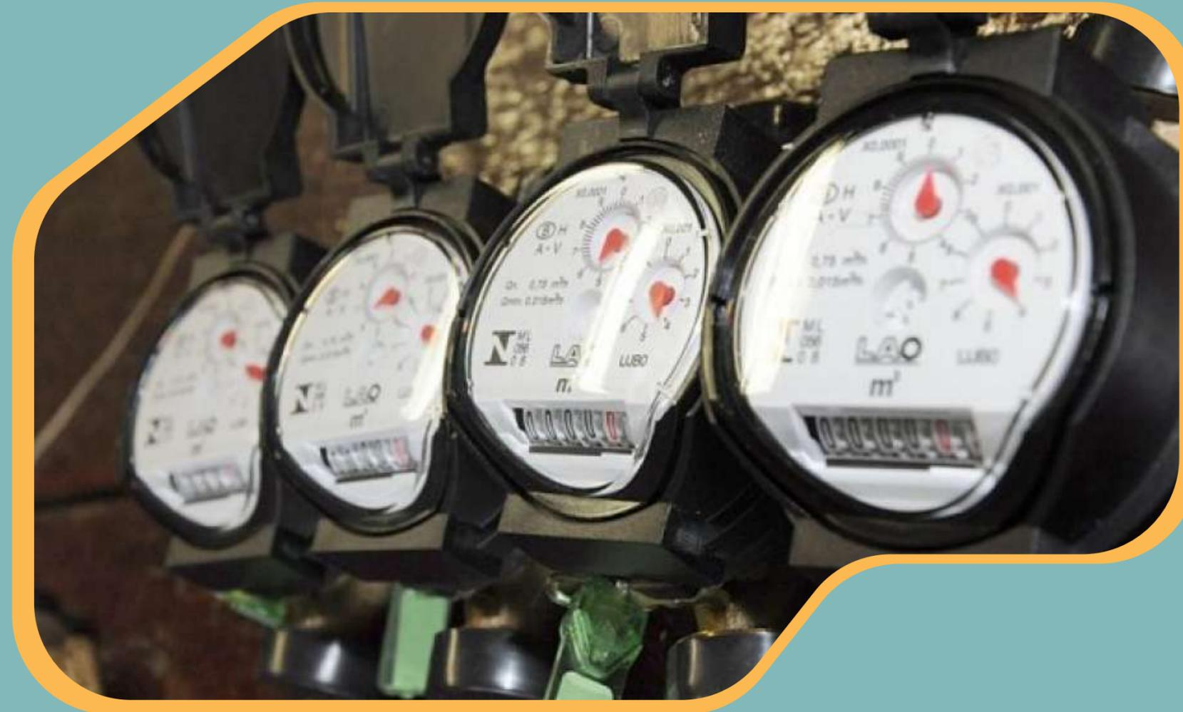
Quando comparados aos medidores convencionais, os hidrômetros volumétricos e ultrassônicos se mostram mais eficientes e se destacam por possuir maior sensibilidade na medição, promovendo uma redução significativa dos erros de medição (submedição).
