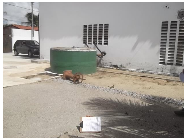
FOTO 08: Detalhe onde foi realizado o furo SP-04.
