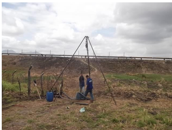
FOTO 13: Sondagem em execução, SP-07, dentro do terreno da EEE-7.
