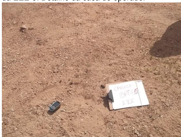
FOTO 11: Sondagem executada SP-06, dentro da área da EEE-6.
