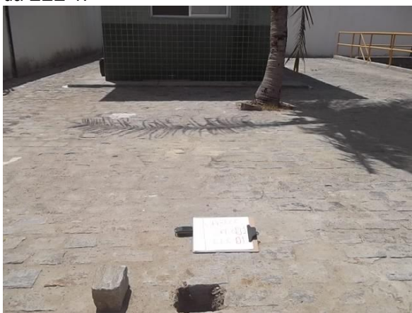
FOTO 03: Detalhe da abertura do SP-01 remanescente.
