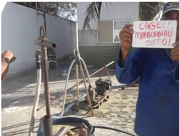
FOTO 01: Sondagem em execução SP-01, dentro da EEE-1.
