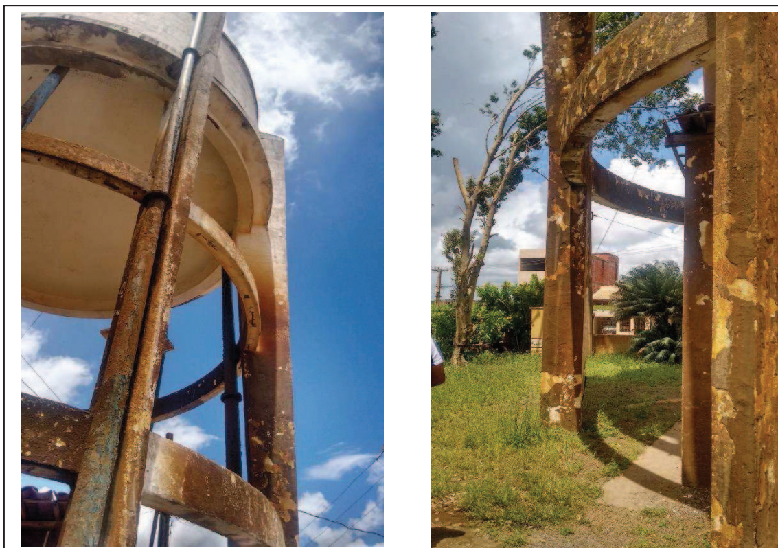
Figura 3. Superfície do concreto manchada e impregnada por substâncias diversas
