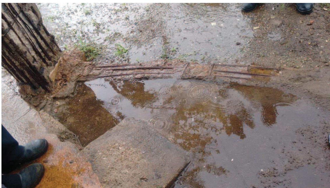
Foto 3. Pilar e cinta inferior com armaduras expostas.
