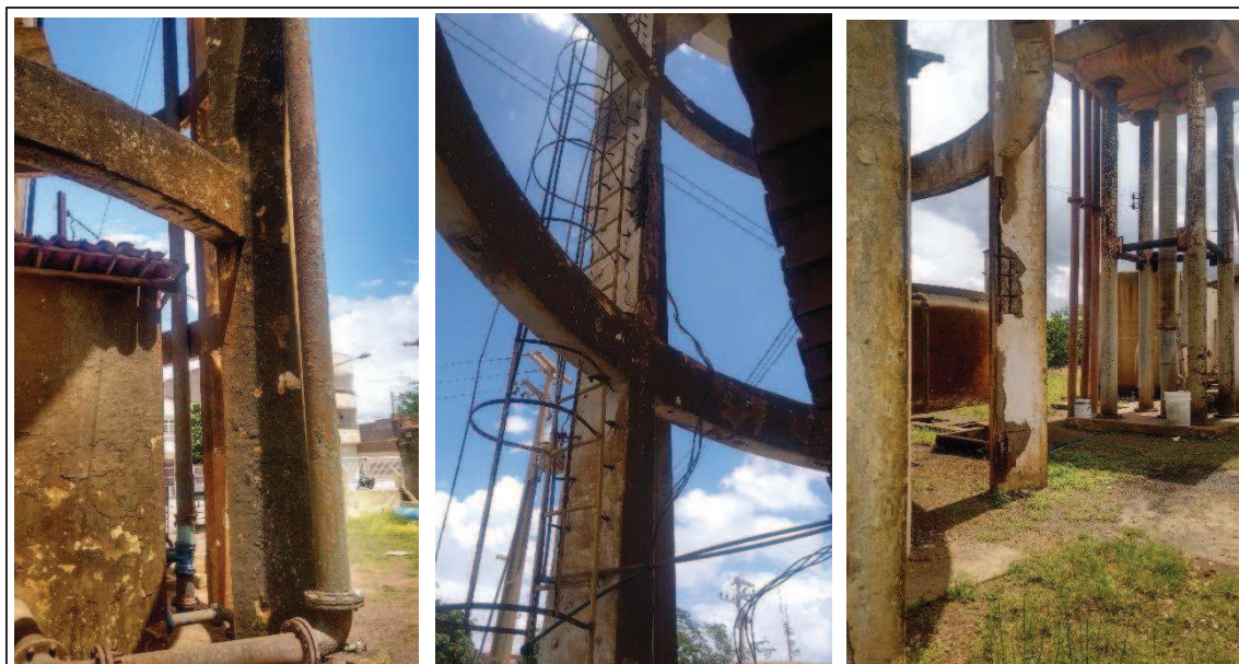
Figura 4. Outros pilares e estado da superfície do concreto
